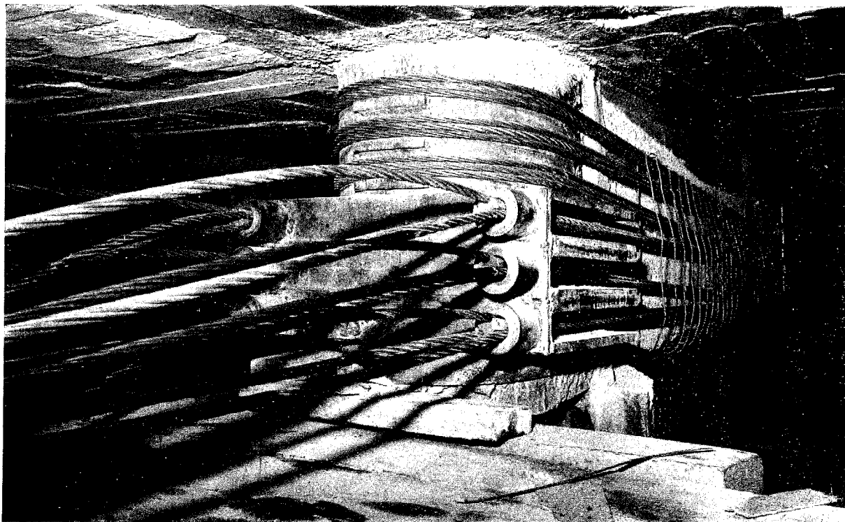
REFUERZO DE ESTRUCTURA. Esfuerzo introducido: 600 Tn.
