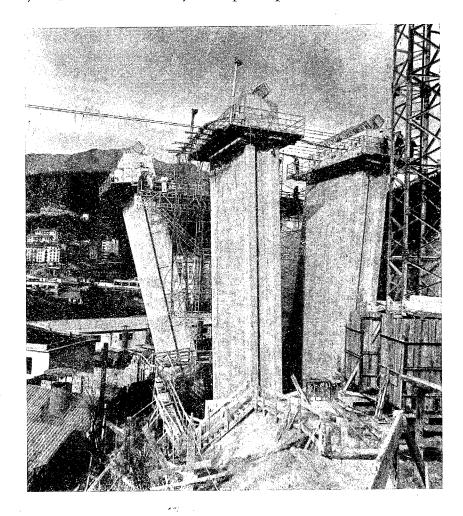
Respecto a la construcción de las pilas en su posición definitiva inclinada, no resulta sencillo hacerlo con cimbra sin apoyarnos en la fábrica ni en la calle Chonta, teniendo además que absorber la componente horizontal del peso de las mismas de manera que el empotramiento en cimientos no resulte dañado. Por otro lado hormigonar las pilas en posición inclinada elimina la posibilidad del empleo de encofrados deslizantes, procedimiento éste rápido y económico.
