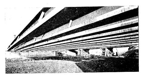
Fig. 8. — Las diez vigas Preflex del tablero colocadas en obra.
