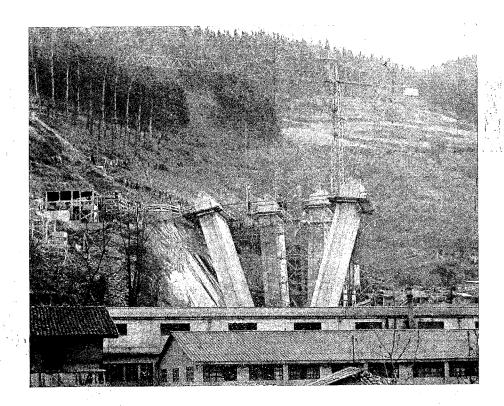
Escalón 3.—Los gatos reversibles sueltan 56 cm de cable, con lo cual la pila lado Bilbao que estaba vertical pasa a inclinarse 56 cm y la del lado Behobia permanece inclinada 28 cm.
