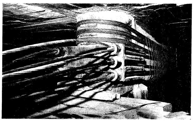
REFUERZO DE ESTRUCTURÁ. Esfuerzo introducido: 600 Tn.
