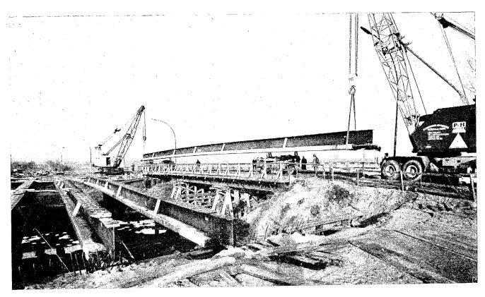
Fig. 7. — Descarga de una viga Preflex.
