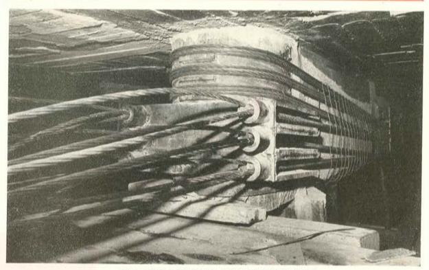
REFUERZO DE ESTRUCTURA. Esfuerzo introducido: 600 Tn.
