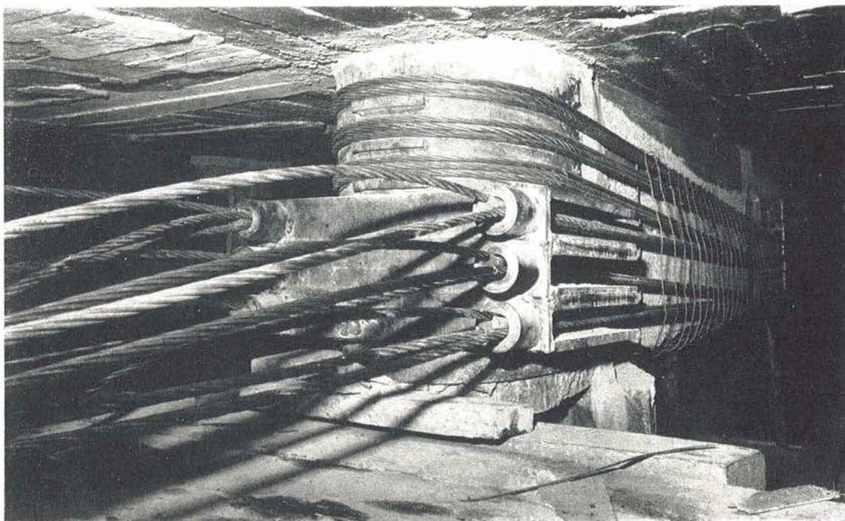
REFUERZO DE ESTRUCTURA. Esfuerzo introducido: 600 Tn.
