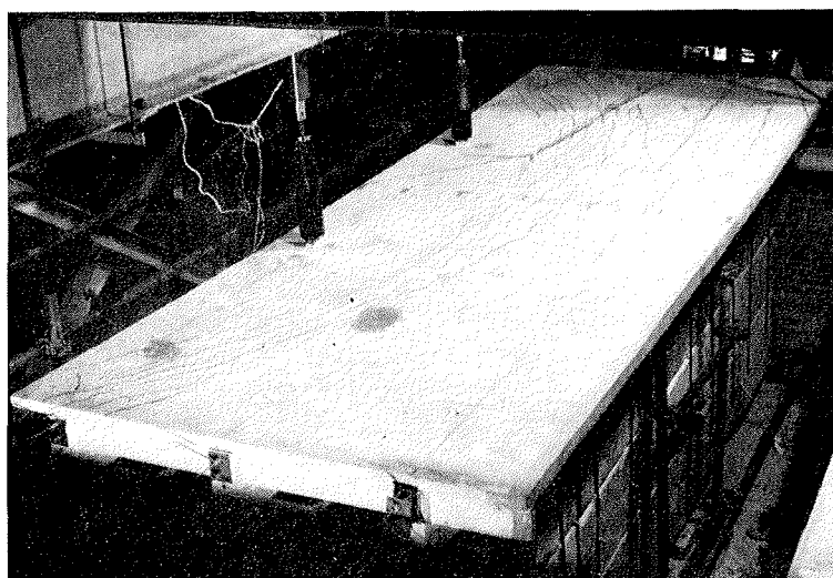
Fig. 50. — Fisuración del tablero en las proximidades de rotura.
