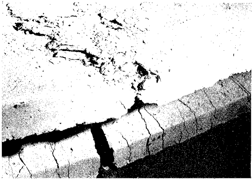
Fotografía 10.—Detalle de la losa. Viga tipo A, en rotura.
