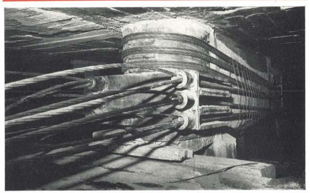
REFUERZO DE ESTRUCTURÁ. Esfuerzo introducido: 600 Tn.
