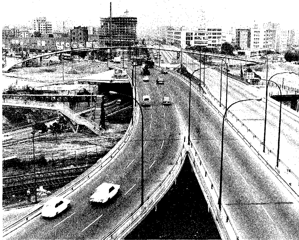
Pasarela en la plaza de Las Glorias (Barcelona).
