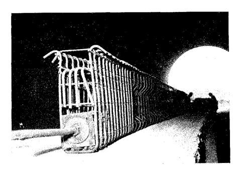
Fotografía 1. -- Armadura de las vigas tipo D.
