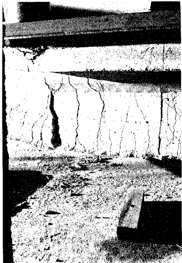
Fotografía 11.— Viga tipo A en rotura.
