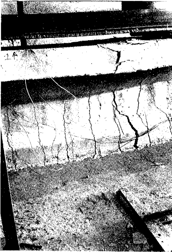
Fotografía 8. — Viga tipo C rota.
