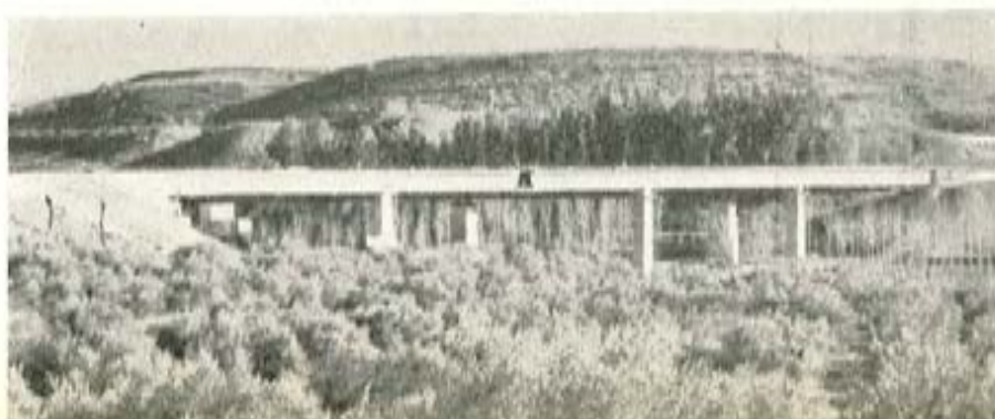
Vista general del puente durante el cierre de la obra.
