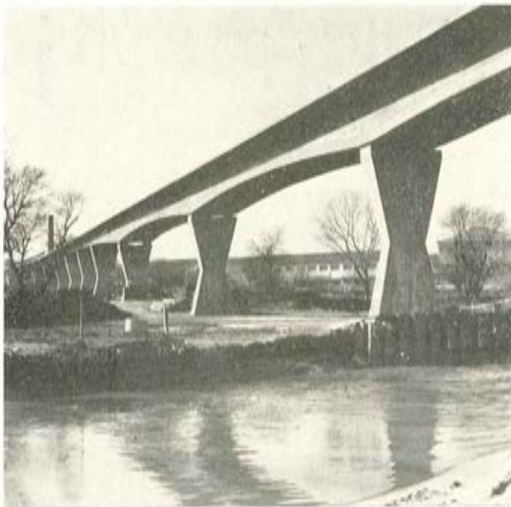
Vista del doble dintel y pila en la zona de canto constante.
