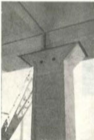
Fig. 15. — Nudo del pilar intermedio con las vigas de entreplanta y la artesa.
