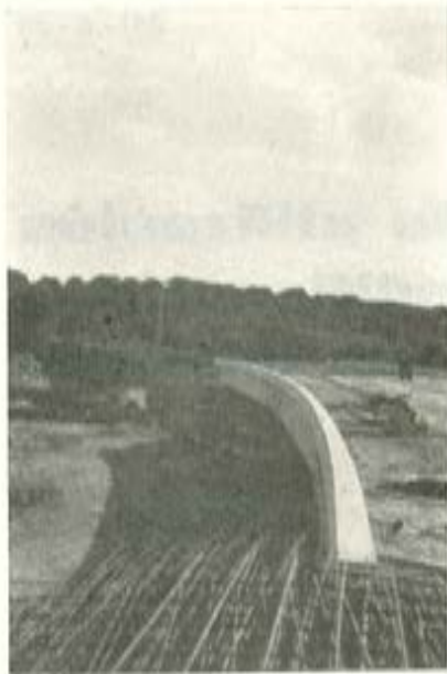
Fig. 3. — Vista del puente por su lado cóncavo. Se puede apreciar la curva de la cabeza superior y la línea recta de la arista de la fibra inferior.
