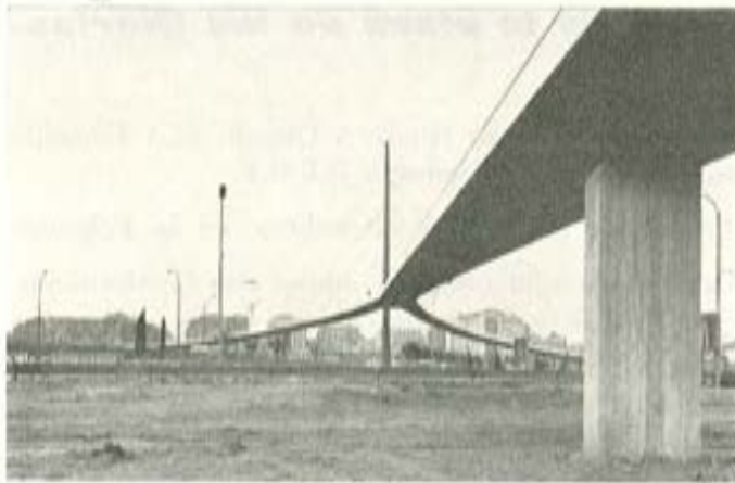
Vista de la zona principal.
