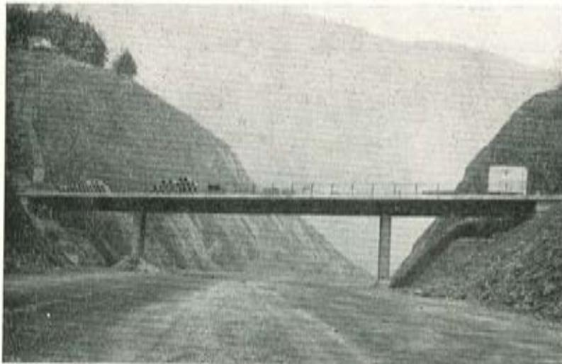
Fig. 4. — Paso superior en losa continua de canto constante (E.III-6, autopista bajo Camino Urki).
