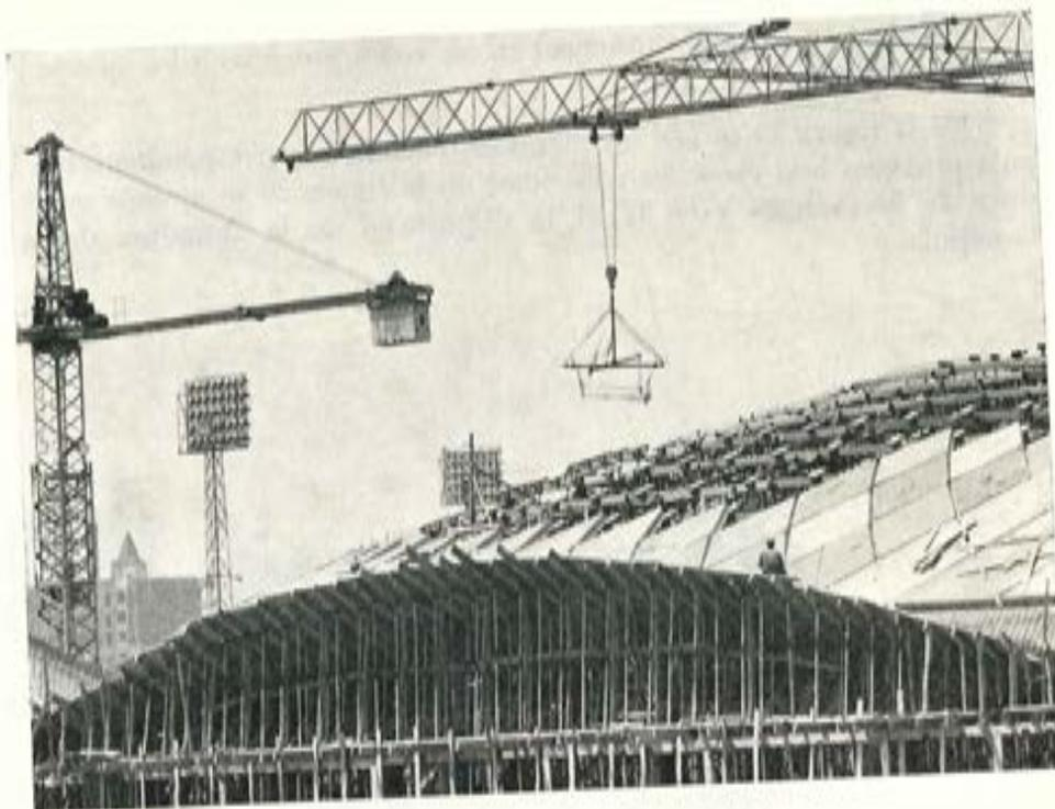
Para la construcción de las viseras y la estructura perimetral se utilizó un encofrado convencional. En la figura 17 se aprecia el encofrado del anillo octogonal, con las vainas de la armadura postesa. Esta armadura estaba formada por tres torones de 44 alambres  $\phi$  7, que se tesaron a una carga inicial de 190 t cada uno, mediante el sistema B.B.R.
