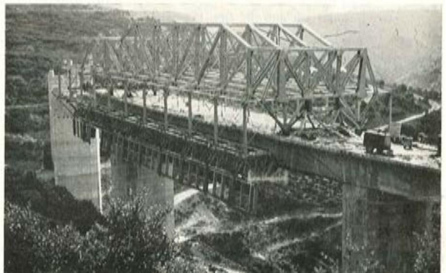
Los tramos llevan sus extremos dispuestos "a media madera", apoyando sobre cabezales de sección en T invertida, empotrados cada uno de los pilares de sección rectangular, todo ello de hormigón armado, lo mismo que las zapatas de cimentación.
