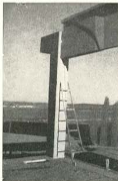
Fig. 12.— Una visita de cómo queda listo para hormigonar con mortero en su parte superior con una cuña, que lo que hace es mantenerlo vertical. En esa ranura se colocaba luego una tira de moltopreno que servía de junta estanca.
