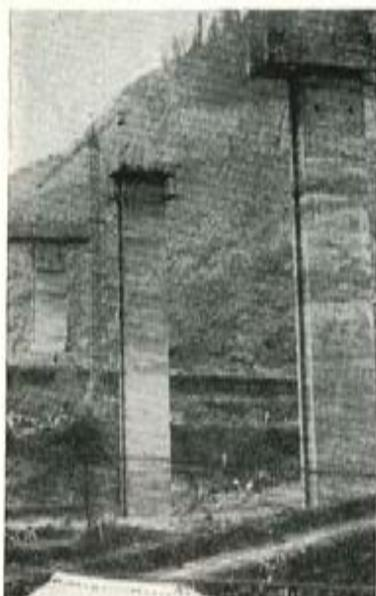
Fig. 14. — Pilas formadas por fuste único rectangular hueco y dintel en ménsula (A-114, viaducto Subiberri autopista sobre CN-634, F.C. y río Deva).
