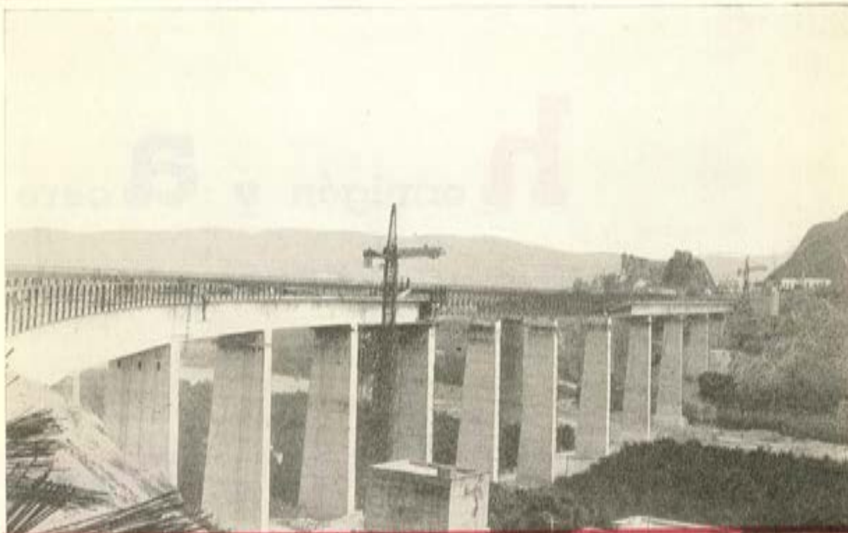
Puente de ANDARAX, construido para RENFE, por Fernández Constructor, con postesado Barredo.
