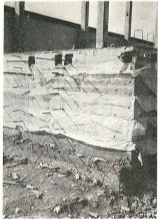
La figura 7 muestra el aspecto que ofrecían las losas ya hormigonadas en su nivel de construcción, listas para ser tesadas.
