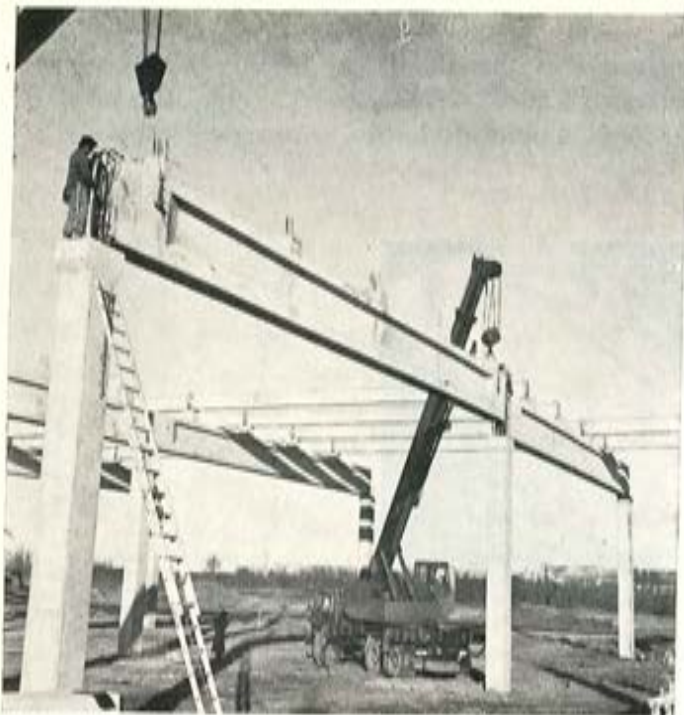
Detalle de colocación de vigas de 25 m sobre pilares prefabricados.
