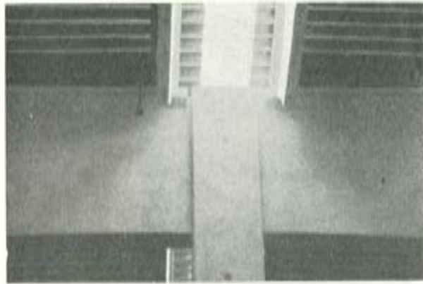
Fig. 18. — Detalle de la junta central de edificio conseguida a base de repetir correas.
