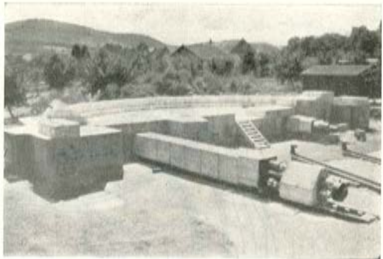
Fig. 11. — Prolongación recta de un tendón y gato de 800 t en el extremo opuesto.
