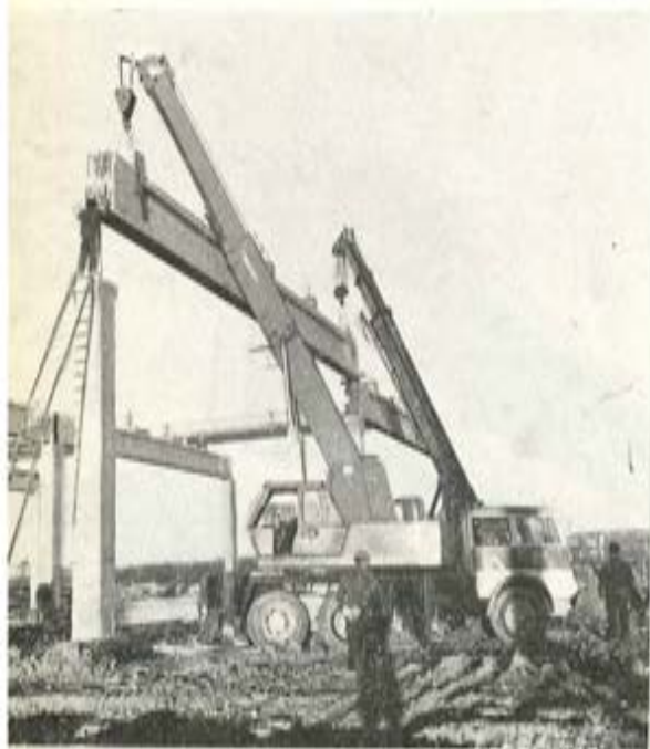
Colocación de la viga encima de la cabeza de apoyo de los pilares.
