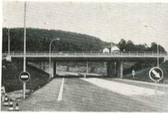
Fig. 5. — Ramal de enlace bajo autopista, en losa continua de canto constante (E.IB-6, enlace de Amorebieta).
