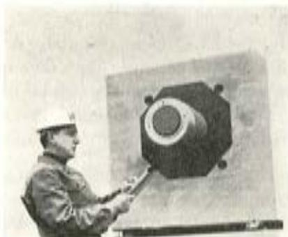
Fig. 5. — Anclaje A-800 hormigonado y tesado.
