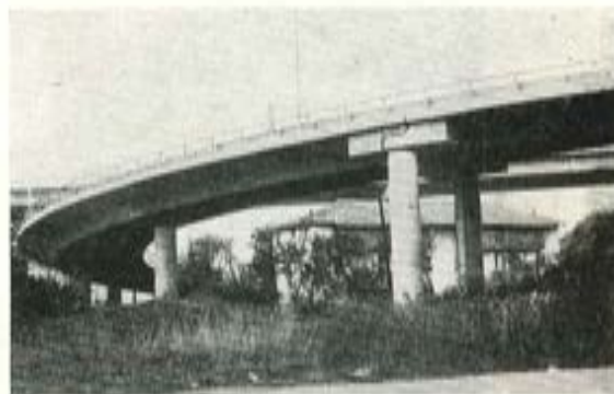
Fig. 6. — Ramal de acceso a la autopista, en losa continua de canto constante y fuerte curvatura en planta (ramal Irubide sur).
