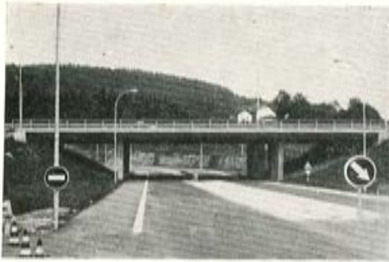
Fig. 5. — Ramal de enlace bajo autopista, en losa continua de canto constante (E.IB-6, enlace de Amorebieta).
