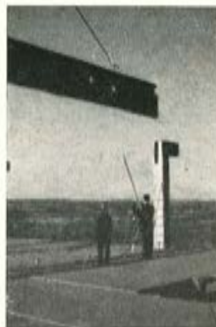
Fig. 9.—Una vista del pilar de fachada.
