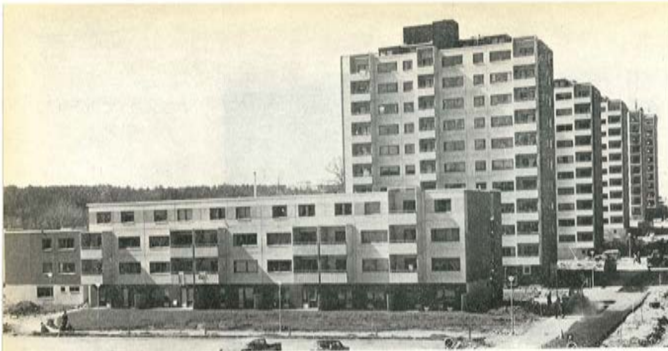
Fig. 13. — Bloques de viviendas, con un total de 2.200 apartamentos, en los cuales se han utilizado forjados de 8,40 a 12 m de luz, constituidos por placas aligeradas apoyadas sobre muros portantes de fachada. El número de plantas en los distintos edificios varía entre 3 y 13.
