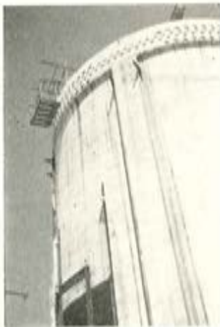
Fig. 16.—Zión, Edificio de contención.
