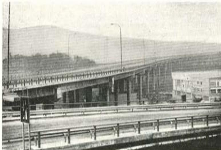
Fig. 9.— Pilas formadas por fustes circulares de  $\phi$  1,30 m (E.IIb-5, viaducto de Olacueta).
