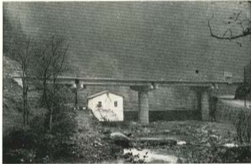
Fig. 11. — Pilas formadas por fuste único hueco de \phi 3 m para cruces oblicuos (E.III-11, autopista sobre CN-634 y río Deva).
