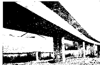
Vista del dintel y una de las bifurcaciones.
