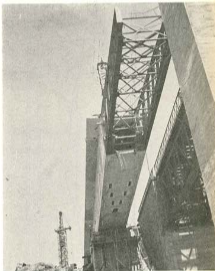
Vista del dintel durante el lanzamiento.
