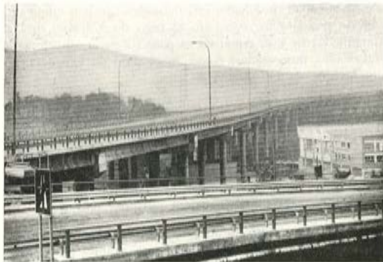
Fig. 8.— Viaducto de vigas prefabricadas pretensadas y tablero (E.Ia-1R, viaducto de Pradera, en Basauri).
