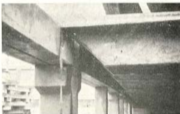
Fig. 7 — Placas TT p utilizadas en la estructura de un edificio destinado a almacenes. Obsérvense los extremos inclinados de los nervios de la placa y el espacio que así queda para poder colocar conducciones transversales.
