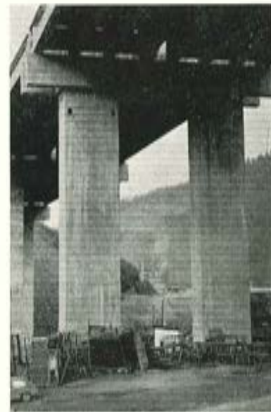
Fig. 13. — Pilas formadas por dos fustes rectangulares huecos y dintel común a ambas calzadas (A-104, viaducto San Antolín, sobre FC, CN-634 y río Deva).
