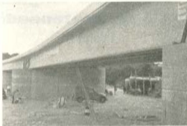
Fig. 4. — Vista inferior de' puente. También aquí se ve la forma convexa del ala.
