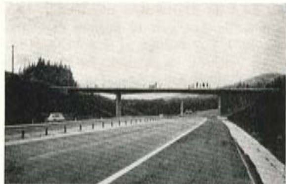
Fig. 3. — Paso superior en losa continua de canto variable (E.IIb-2, autopista bajo Camino Garaizar).
