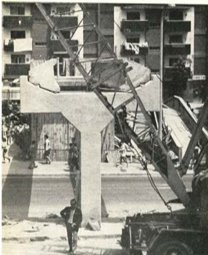
PASARELA PREFABRICADA BARCELONA
