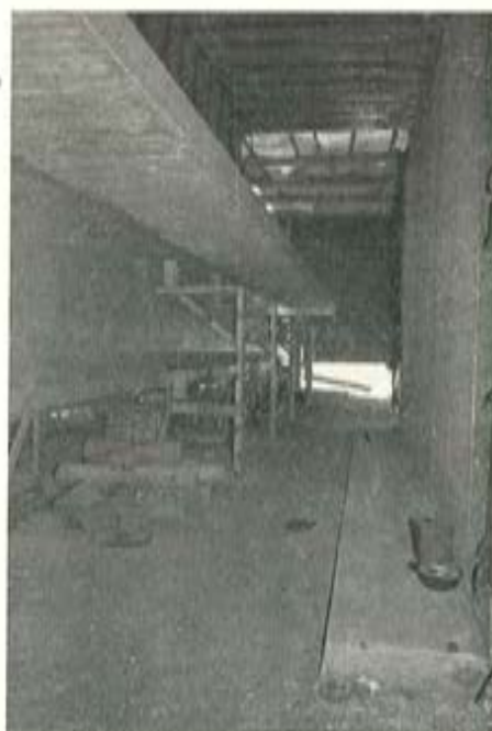
Fig. 8.—Vista general del montaje lado río.
