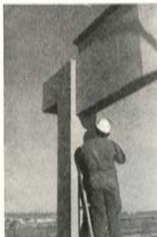
Fig. 11.— En toda la operación de montaje se venía a tardar del orden de un cuarto de hora. Aquí se está comprobando que el neopreno no quede saliente.
