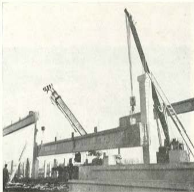
Proceso de elevación de una viga de 21 m de luz, 25 t de peso, sobre pilares de 8 m de altura, con dos grúas de 20 t.
