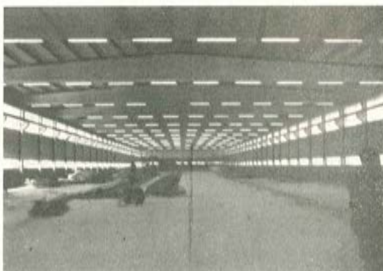
Fig. 3. — Interior de la nave de fabricación.
