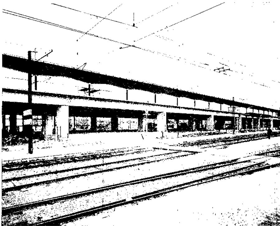
Vista de la zona de estación y la marquesina superior.
