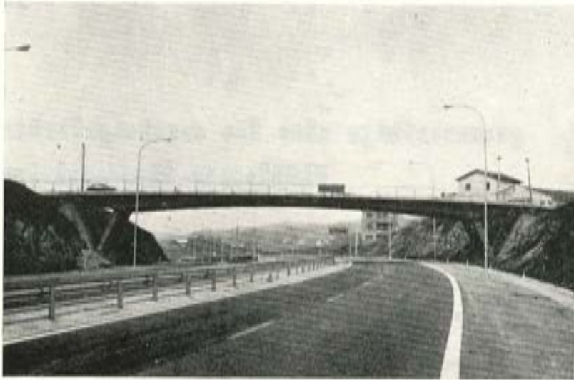
Fig. 2. — Paso superior en pórtico de células triangulares (E.Ib-7, autopista bajo carretera a Echano).
