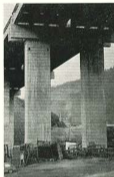
Fig. 13. — Pilas formadas por dos fustes rectangulares huecos y dintel común a ambas calzadas (A-104, viaducto San Antolín, sobre FC, CN-634 y río Deva).
