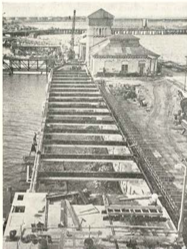
Muelle de carga construido con vigas Preflex en ambos sentidos, longitudinal y transversal.
