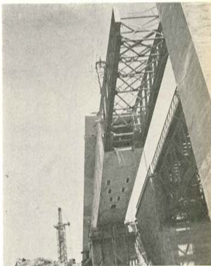
Vista del dintel durante el lanzamiento.
