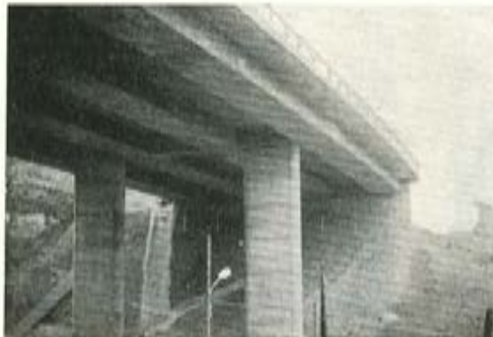
Fig. 7. — Viaducto a base de losas continuas nervadas de canto constante (E.III-4, viaducto Ipurúa, en Eibar).
