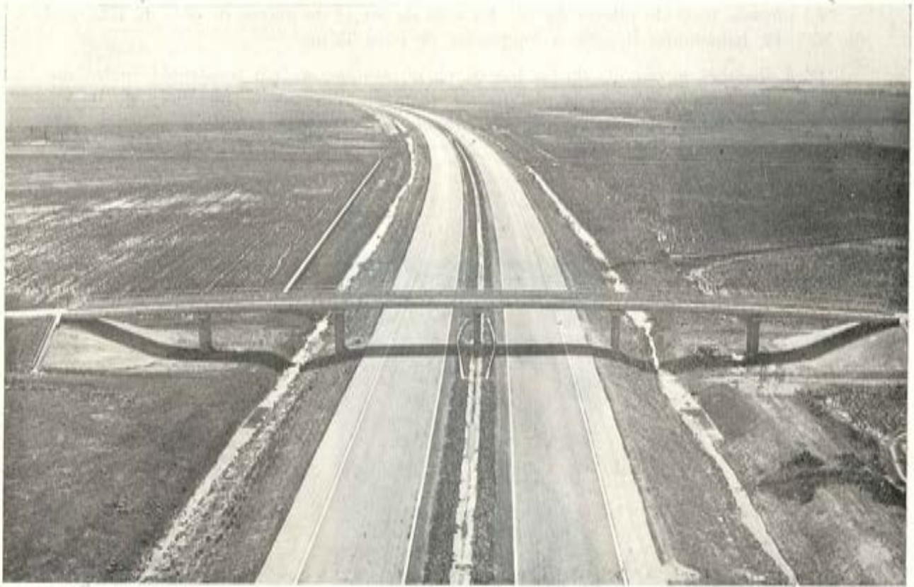
AUTOPISTA DE PEAJE SEVILLA-CADIZ
