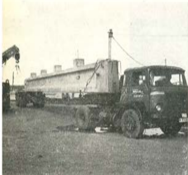
Transporte de vigas grandes sobre plataforma especial.
