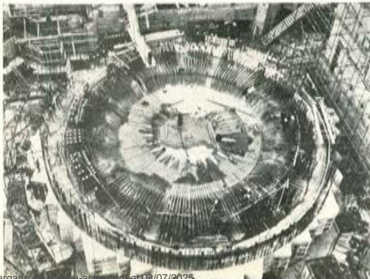
Fig. 21. — Edificio de presión de Bugey I.
