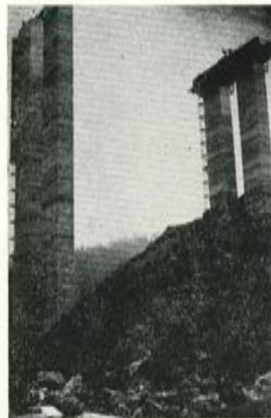
Fig. 16. — Viaducto de Istiña. Pila 2 terminada, formada por dos fustes rectangulares de 6 \times 3 m y 72 m de altura.
