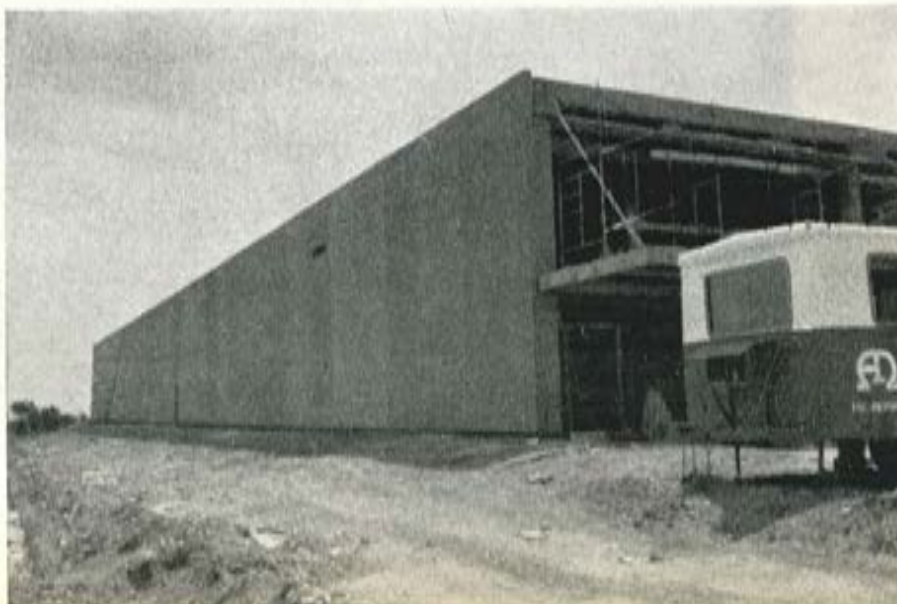
Fig. 20. — Esta es una vista de la fachada norte.
