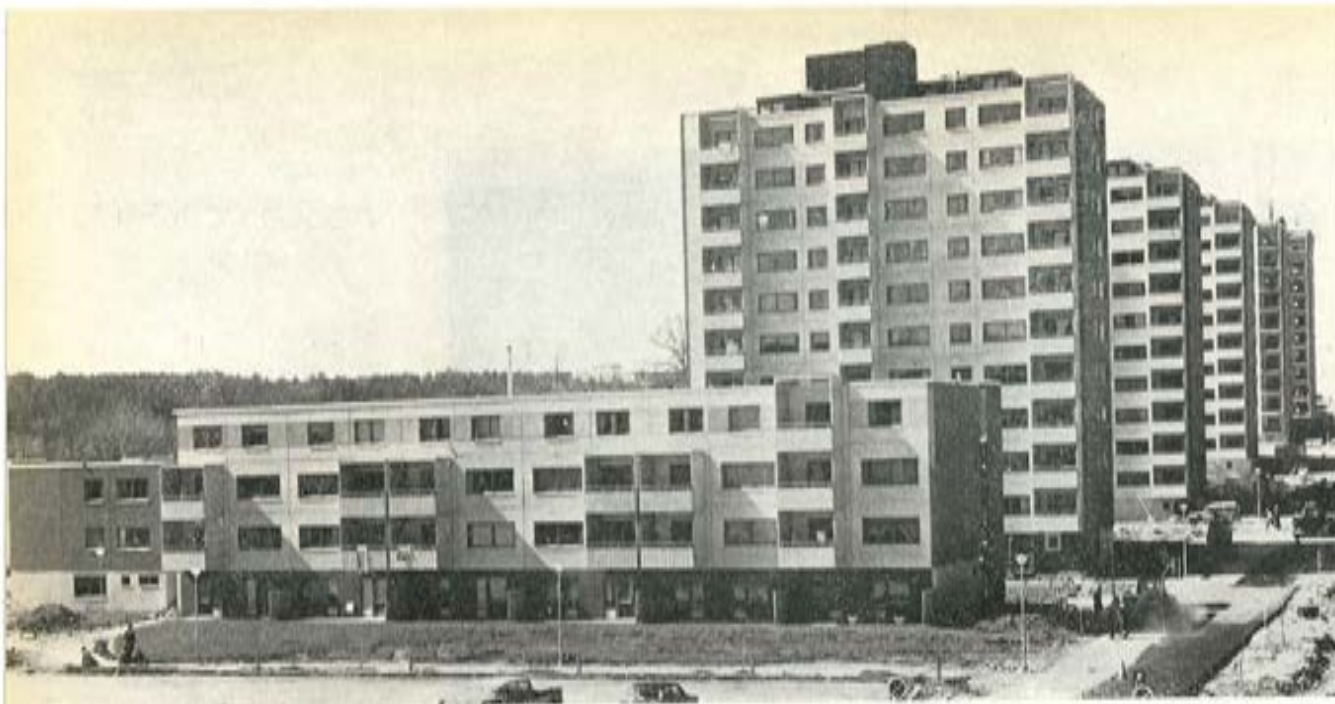
Fig. 13. — Bloques de viviendas, con un total de 2.200 apartamentos, en los cuales se han utilizado forjados de 8,40 a 12 m de luz, constituidos por placas aligeradas apoyadas sobre muros portantes de fachada. El número de plantas en los distintos edificios varía entre 3 y 13.
