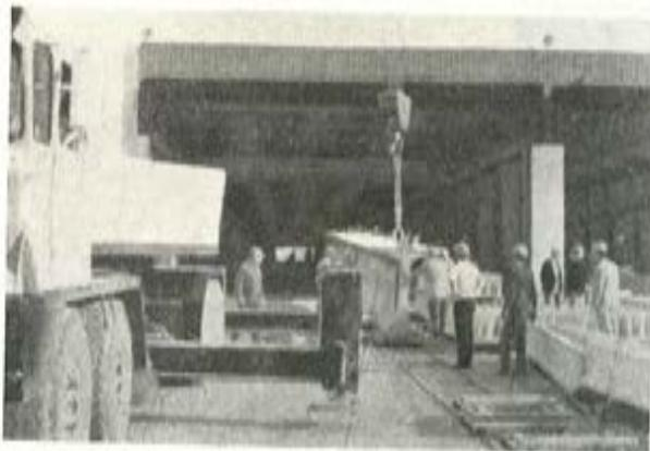
Fig. 2.— Una perspectiva de la viga con la grúa al fondo, cogiéndola ya para ponerla en el Dolly.
