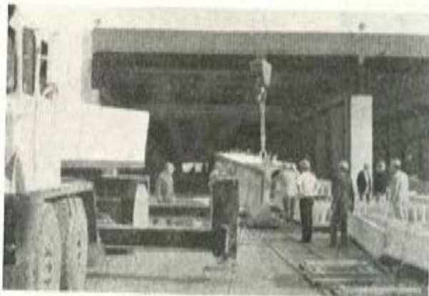
Fig. 1.— La viga saliendo de la nave, suspendida por la parte posterior por los puentes grúas y la anterior por una grúa que la está depositando en una vagoneta. La sección es de 1,50 m de ancho por 1,50 de canto.
