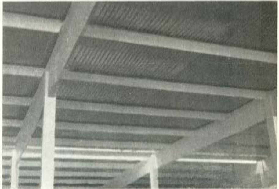
Fig. 16.—Vista de la cubierta ya terminada, con las correas a 3,5 m. La cubierta es de chapa galvanizada conformada en frío, encima una basa aislante de caucho y, por último, una impermeabilización.
