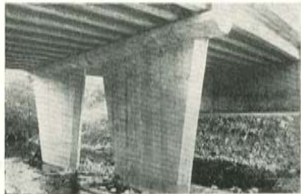
Fig. 10.— Pilas formadas por pantallas trapeciales para el paso de ríos (E.IIq-1, autopista sobre el río Ibaizábal).
