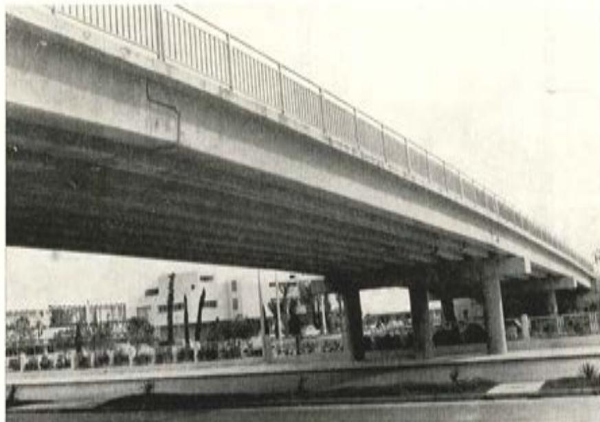
el tercero, de forma que la luz entre extremos de ménsulas se cubran con un tramo de 23,50 m de luz, con apoyos "a media madera".
