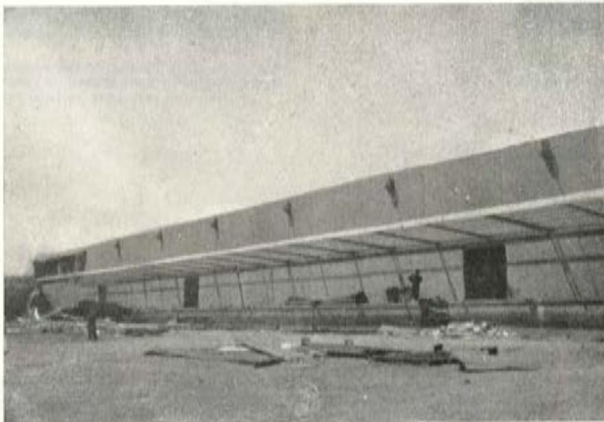
Fig. 19. — Vista general de la fachada a saliente para entrada de mercancías con un muelle de descarga y una marquesina.
