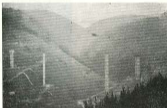
Fig. 15. — Viaducto de Istiña. Construcción de pilas mediante encofrado deslizable. Vista general.
