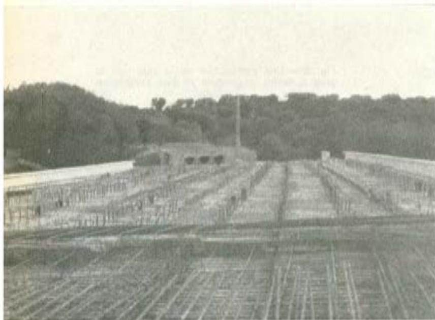
Fig. 5. — Una vista del segundo tramo empezándose a ferrallar. Aquí es donde se aprecia muy claramente las piezas prefabricadas en hormigón blanco en forma de U que servían de encofrado y al mismo tiempo daban una vista exterior muy agradable.
