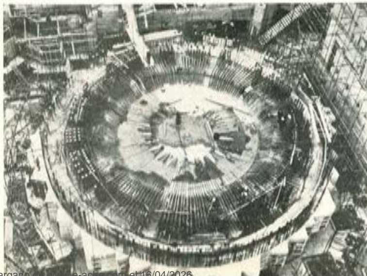
Fig. 20. — Construcción de la parte inferior del edificio de presión de Dungeness B. Obsérvense los salientes para los anclajes.
