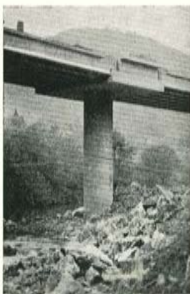
Fig. 12. — Dinteles en ménsula sobre fustes de \phi 3 m para adaptarse a distintas luces (A-112, autopista sobre CN-634, río Deva y FC, Bilbao-San Sebastián).
