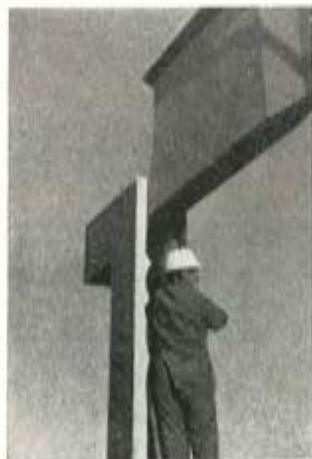
Fig. 10.— Puede apreciarse la ho'gura con que se encajaba la viga en el pilar (que era de 1 cm).
