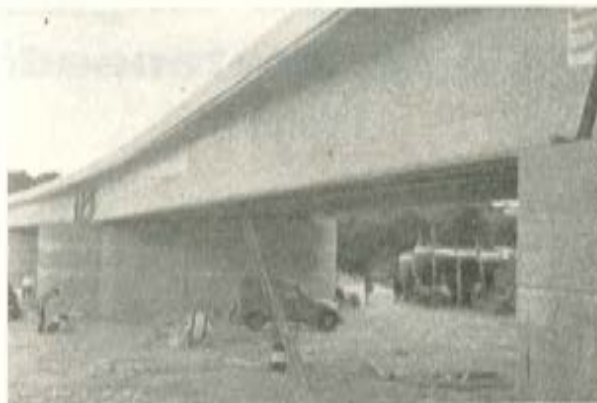
Fig. 4. — Vista inferior de' puente. También aquí se ve la forma convexa del ala.
