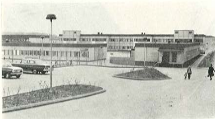
Fig. 14. — Ejemplo de forjados constituidos por placas aligeradas, apoyados sobre muros portantes de fachada. En la fotografía se muestra un conjunto formado por 14 escuelas diferentes, construidas en Estocolmo.
