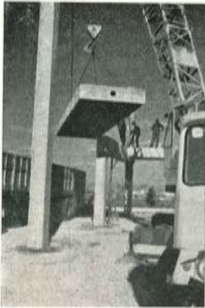
Fig. 13.—Esta es una vista del montaje de las artesas de planta intermedia.
