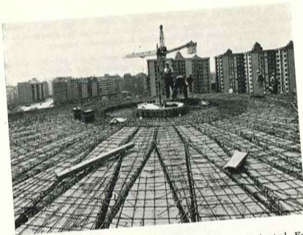
La figura 22 corresponde a una fase del hormigonado de la zona perimetral. En ella se puede apreciar cómo se realizó el hormigonado de la unión de la parte maciza con la parte nervada. Entre la zona maciza y la primera pieza prefabricada se dejaban unos 20 cm, que se hormigonaban después de que el hormigón anteriormente vertido había fraguado lo suficiente para poder actuar como contención del nuevo hormigón.
