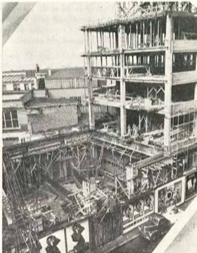
El pilar central de este edificio, que transmite 160 t, está puentado por una viga Preflex de 14 m.
