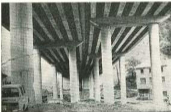
Fig. 10.— Pilas formadas por pantallas trapeciales para el paso de ríos (E.IIq-1, autopista sobre el río Ibaizábal).
