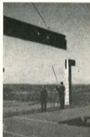
Fig. 9.—Una vista del pilar de fachada.
