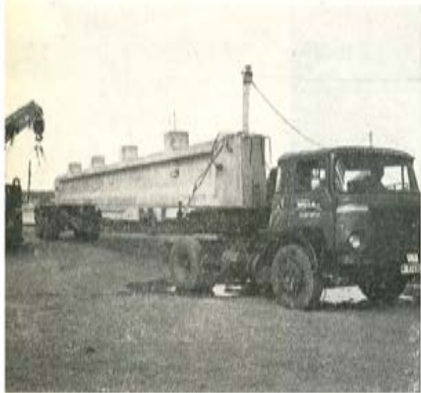
Transporte de vigas grandes sobre plataforma especial.
