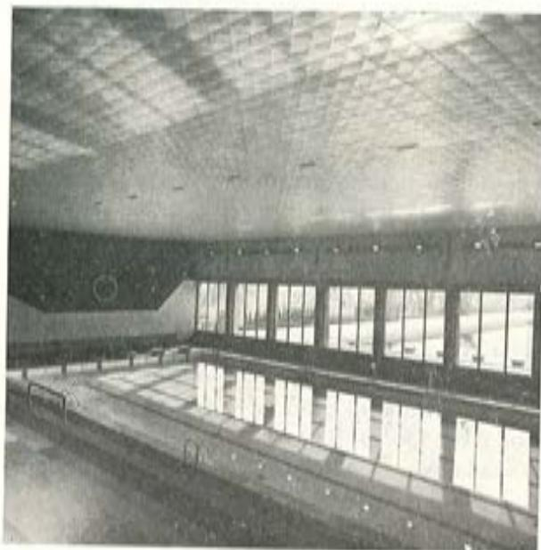
Los elementos transversales son paneles cerámicos Rubiera prefabricados y autoportantes, con lo que se consiguió prefabricar totalmente la cubierta, cuyos 1.000 m<sup>2</sup> se montaron en tres días.
