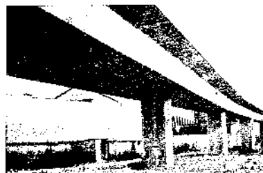
Vista del dintel y una de las bifurcaciones.
