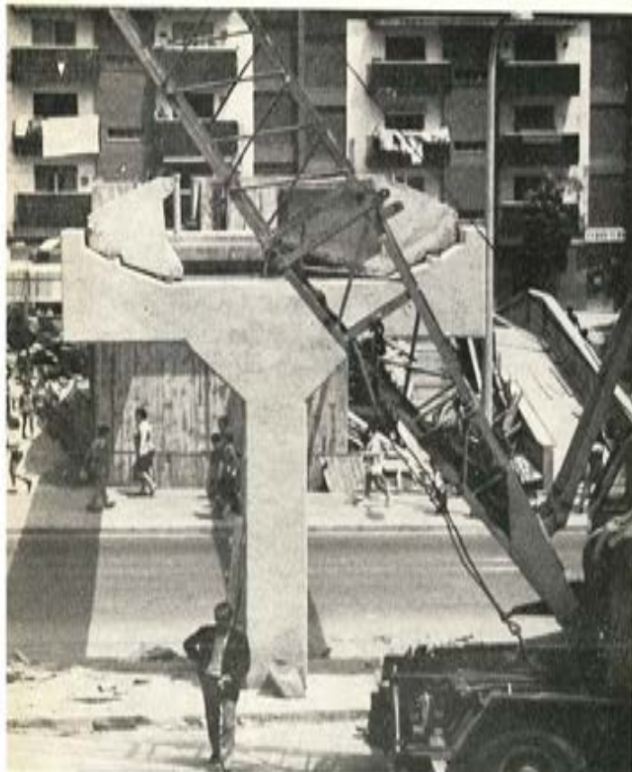
PASARELA PREFABRICADA BARCELONA
