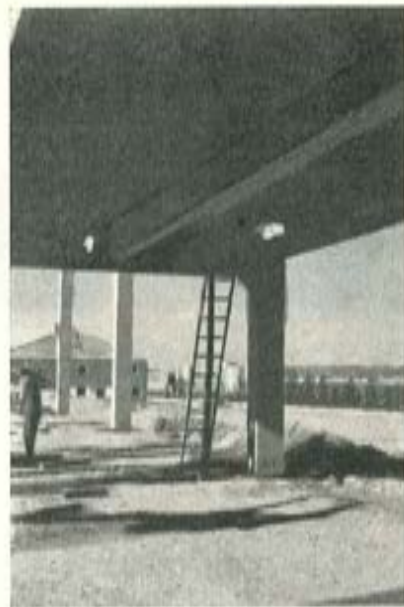
Fig. 14. — Vista inferior de las artesas con sus agujeros para el paso de canalizaciones ya realizadas en taller.
