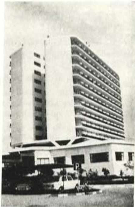
En la figura 21 podemos ver un hotel, en el que existe una planta con pilares en V en los que se quiso reforzar la fijación de las ramas superiores de las V a las vigas de esa zona.
