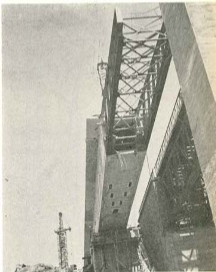
Vista del dintel durante el lanzamiento.
