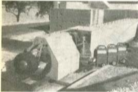
Fig. 10. — Dispositivo de tesado con tres gatos de 500 t.
