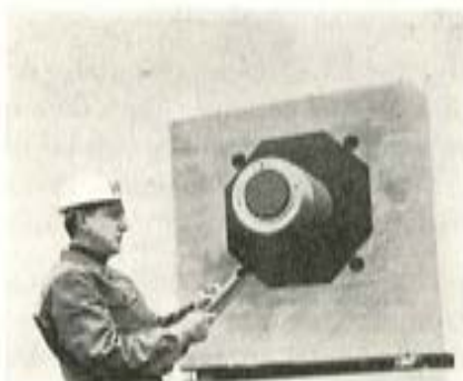
Fig. 5. — Anclaje A-800 hormigonado y tesado.
