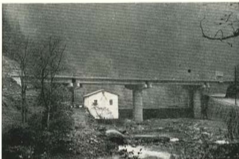
Fig. 11. — Pilas formadas por fuste único hueco de \phi 3 m para cruces oblicuos (E.III-11, autopista sobre CN-634 y río Deva).
