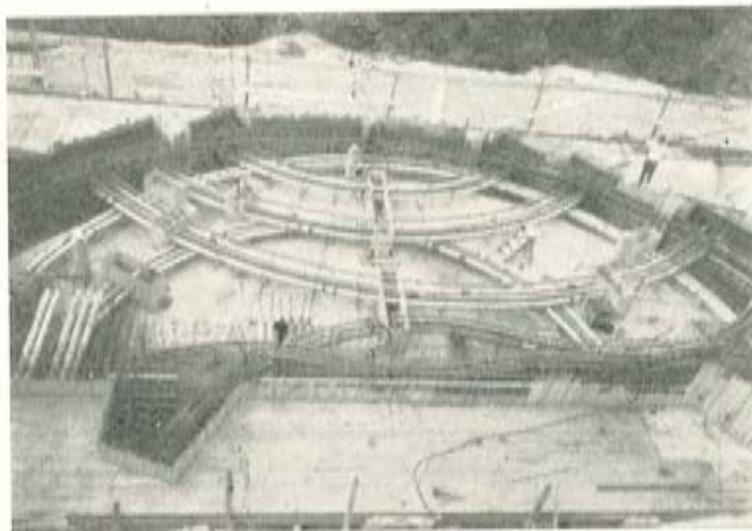
Fig. 9. — Disposición de vainas antes de hormigonar.
