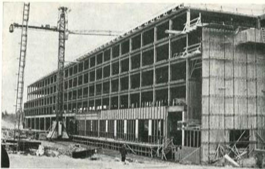
Fig 11.—Placas aligeradas apoyadas sobre una estructura reticular prefabricada, de hormigón.
