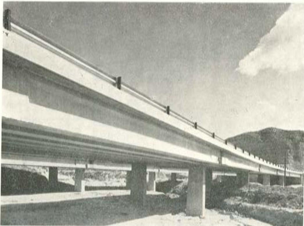
migón armado, van cimentados en zapatas corridas enlazadas entre sí con tirantes de hormigón postensado. Los estribos van sobre pilares y zapatas también de hormigón armado.
