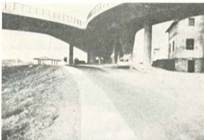
Fig. 27. — Paso de La Avanzada. Bifurcación de los ramales
