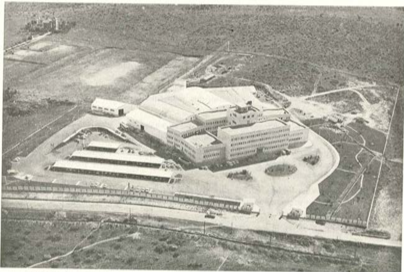
ESTUDIOS CENTRALES DE TV.E., EN PRADO DEL REY (MADRID), CON FORJADO TIPO "BORONDO"
