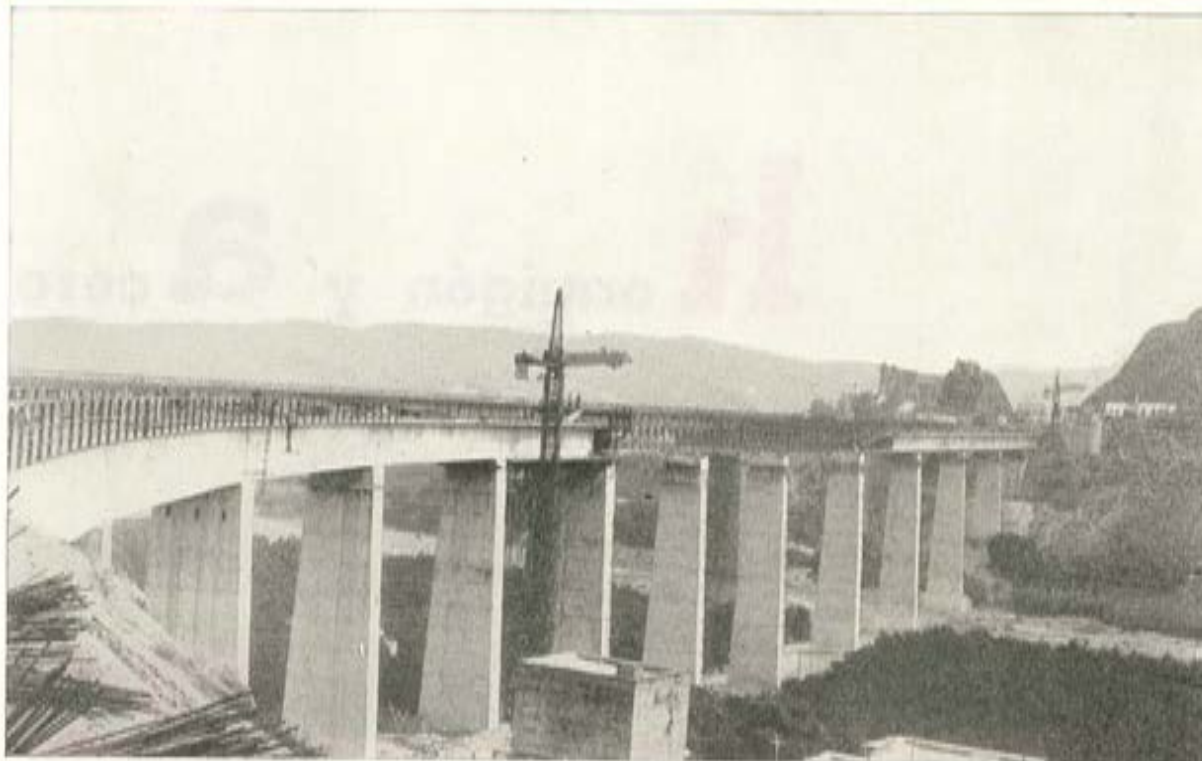
Puente de ANDARAX, construido para RENFE, por Fernández Constructor, con postesado Barredo.
