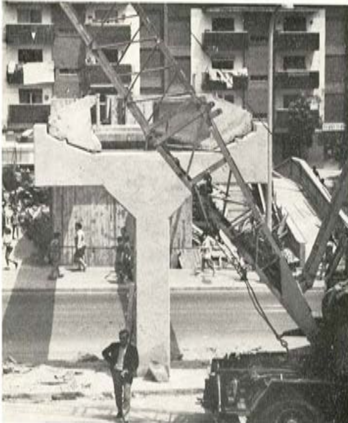
PASARELA PREFABRICADA BARCELONA
