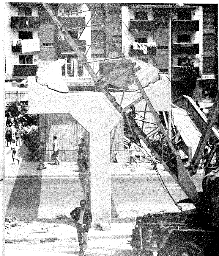
PASARELA PREFABRICADA BARCELONA
