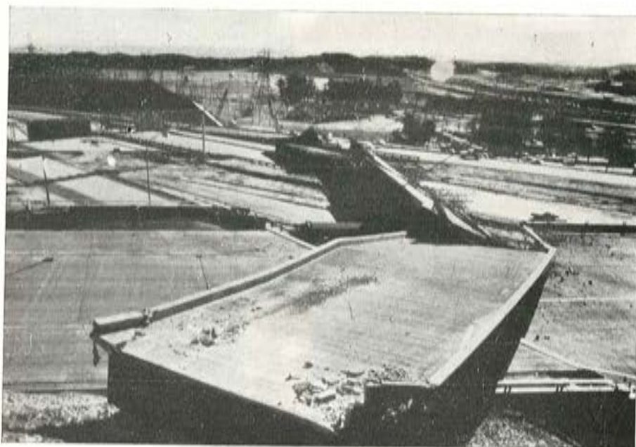
Fig. 12. — Algunos aspectos de puente de autopista después del terremoto. Para reparar muchos de los daños causados se utilizaron las resinas del PREH.
