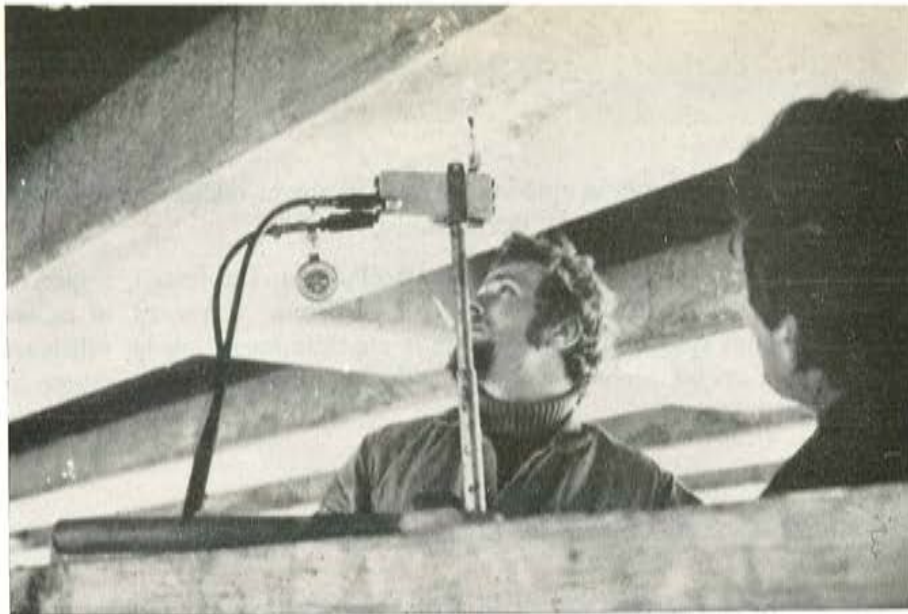
Fig. 15.—Inyección del patín a una viga fisurada. Nótese el dispositivo utilizado para mantener en posición la pistola inyectora.
