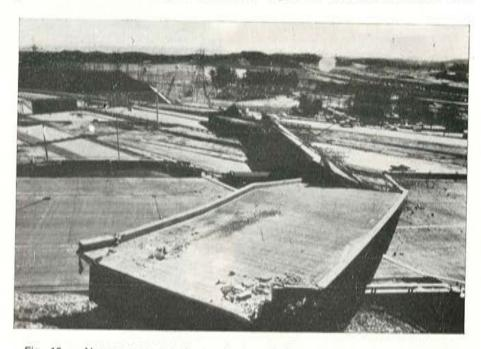
Fig. 12. — Algunos aspectos de puente de autopista después del terremoto. Para reparar muchos de los daños causados se utilizaron las resinas del PREH.
