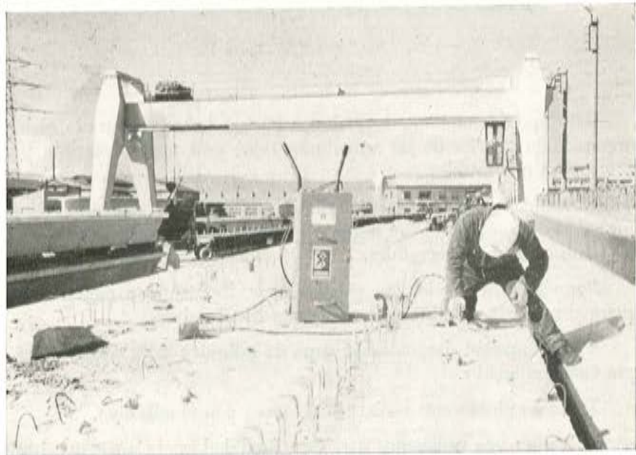
Fig. 17.—Inyección con resina del ala de una viga rota en una fábrica de prefabricación de Barcelona.
