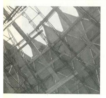
tral pretensado y lunetos en voladizo de refuerzo de borde, hormigonados in situ. El sistema de prefabricación es similar a la solución empleada por Nervi en el Palazzetto de deportes de Roma. En la cúpula de Barcelona, Florencio del Pozo usa, pues, el esquema estructural de Torroja y los métodos de prefabricación de Nervi, pero superando en mucho las dimensiones de las soluciones anteriores.
