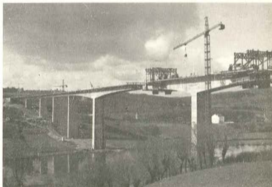
Puente sobre el río Miño, en Lugo. Luces: 36 + 3 \times 45 + 54 + + 108 + 54 + 45 + 36 m. Construye: Entrecanales y Tá- vora, S. A.
