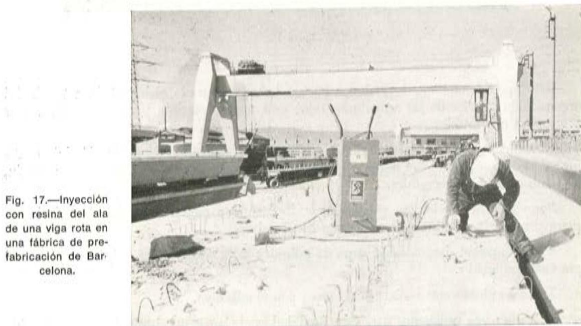
Fig. 17.—Inyección con resina del ala de una viga rota en una fábrica de prefabricación de Barcelona.
