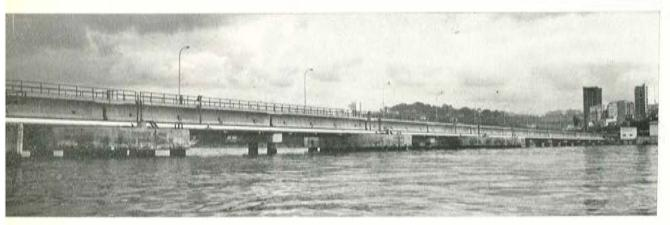
los duques de alba suelen ser de acero, en esta ocasión, se han construido a base de pilotes pretensados huecos, de 66" (1,67 m) de diámetro, hincados en el terreno hasta profundidades de 35 m. Estos pilotes se prefabricaron, por elementos, en las instalaciones de Dragados y Construcciones, S. A., en Huelva, en el sur de España, y se transportaron por mar hasta La Coruña, en donde se ensamblaron y pretensaron conjuntamente todos los elementos constitutivos de cada pilote.
