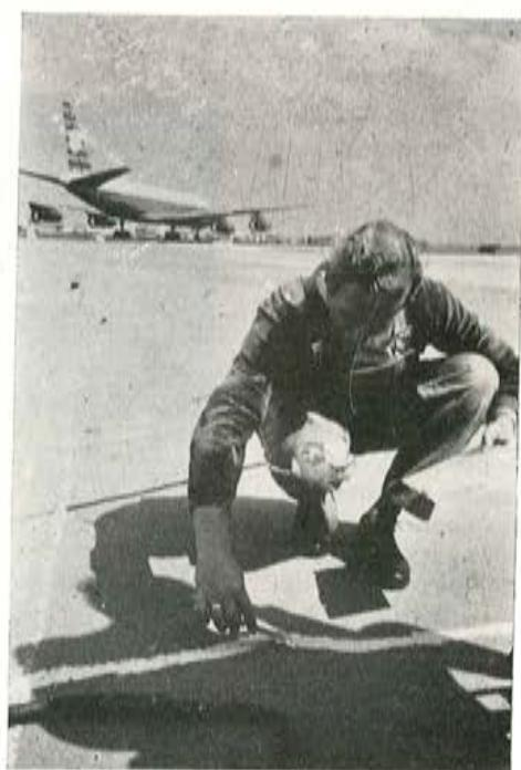
Figs. 13 y 14.—Aplicación del PREH a la reparación de una pista de aeropuerto. Véase el sellado de la grieta y la aparición de la resina en los puntos de inyección.
