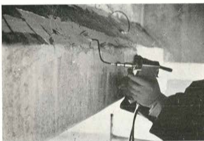
Fig. 16.— Otro detalle de la inyección de la misma viga.
