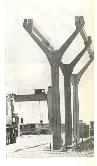
Toda la estructura es prefabricada. Las pilas, en forma de Y (fig. 11), se apoyan sobre losas de cimentación, también prefabricadas, colocadas cada 10 metros. Los raíles están constituidos por vigas pretensadas, de sección rectangular, de 30 cm de anchura y 40 cm de canto, que descansan sobre apoyos de neopreno. Lateralmente se anclan a los brazos de la Y del pilar.
