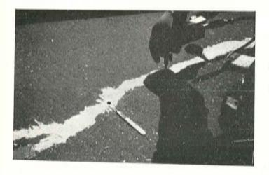
Figs. 13 y 14. — Aplicación del PREH a la reparación de una pista de aeropuerto. Véase el sellado de la grieta y la aparición de la resina en los puntos de inyección,
