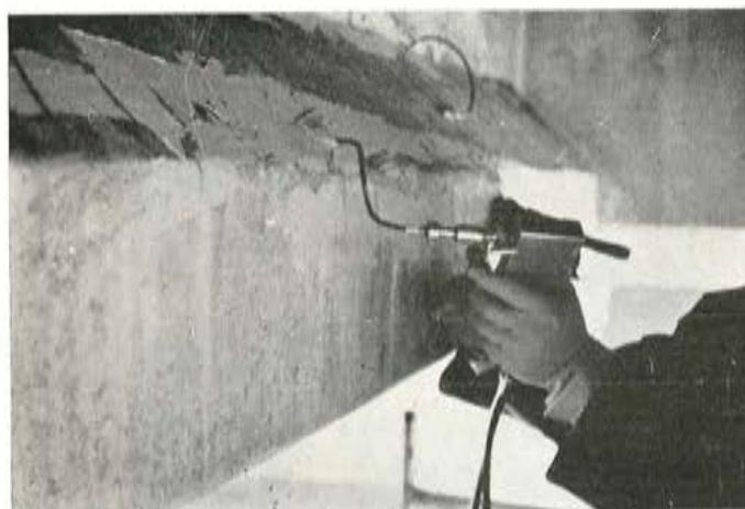
Fig. 16.—Otro detalle de la inyección de la misma viga.
