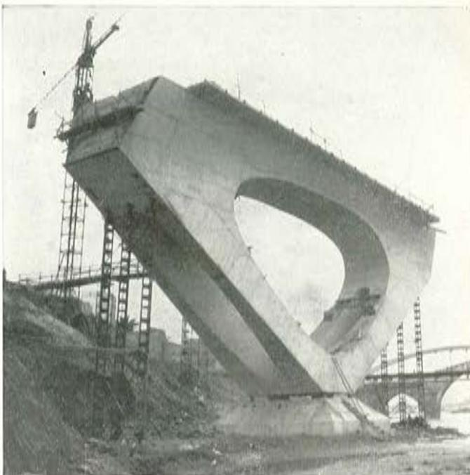
Dentro del grupo de puentes ferroviarios, señalaremos el viaducto de Villaverde-Vicalvaro, con 500 m de longitud y para doble vía. Está dividido en cuatro secciones continuas, formadas por tramos de 20 y 38,50 m, de canto muy variable (fig. 10).
