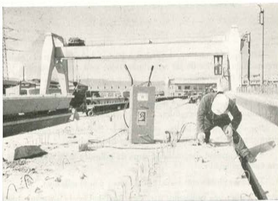
Fig. 17.—Inyección con resina del ala de una viga rota en una fábrica de prefabricación de Barcelona.
