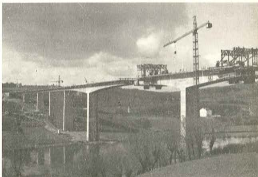
Puente sobre el río Miño, en Lugo. Luces: 36 + 3 \times 45 + 54 + + 108 + 54 + 45 + 36 m. Construye: Entrecanales y Tá- vora, S. A.
