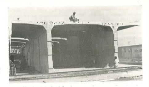
Fig. 7. — Una dovela prefabricada en taller.
