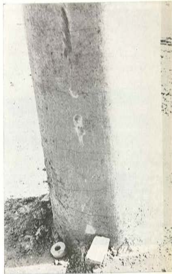
Fig. 8. — Articulación plástica. Zona traccionada.
