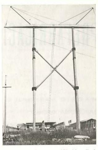
Fig. 6. — Pórtico bajo carga con visible deformación de sus pies derechos.
