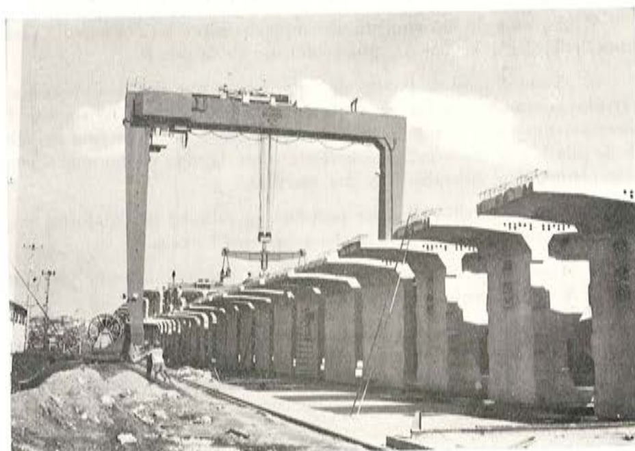
Fig. 8. — Zona de almacenamiento de las dovelas prefabricadas.
