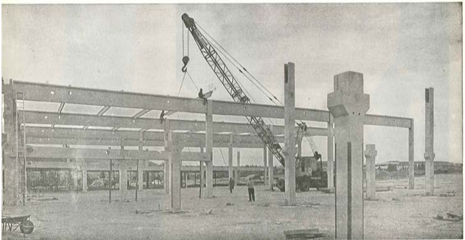
NAVE PREFABRICADA POR CADE
