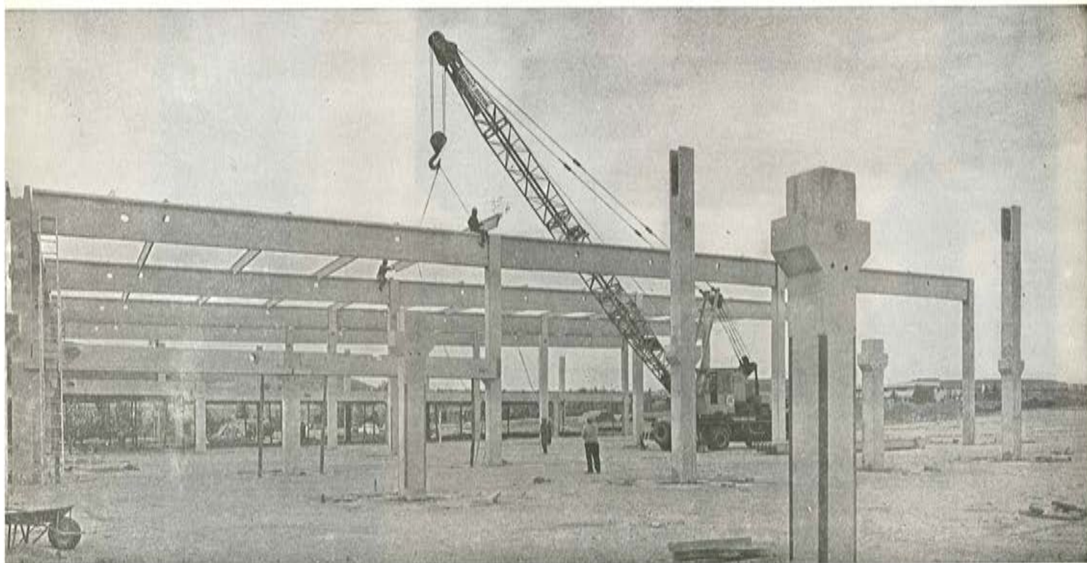
NAVE PREFABRICADA POR CADE
