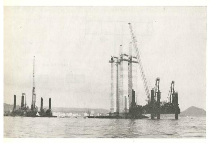
Fig. 19. - Plataformas flotantes y pila P103.
