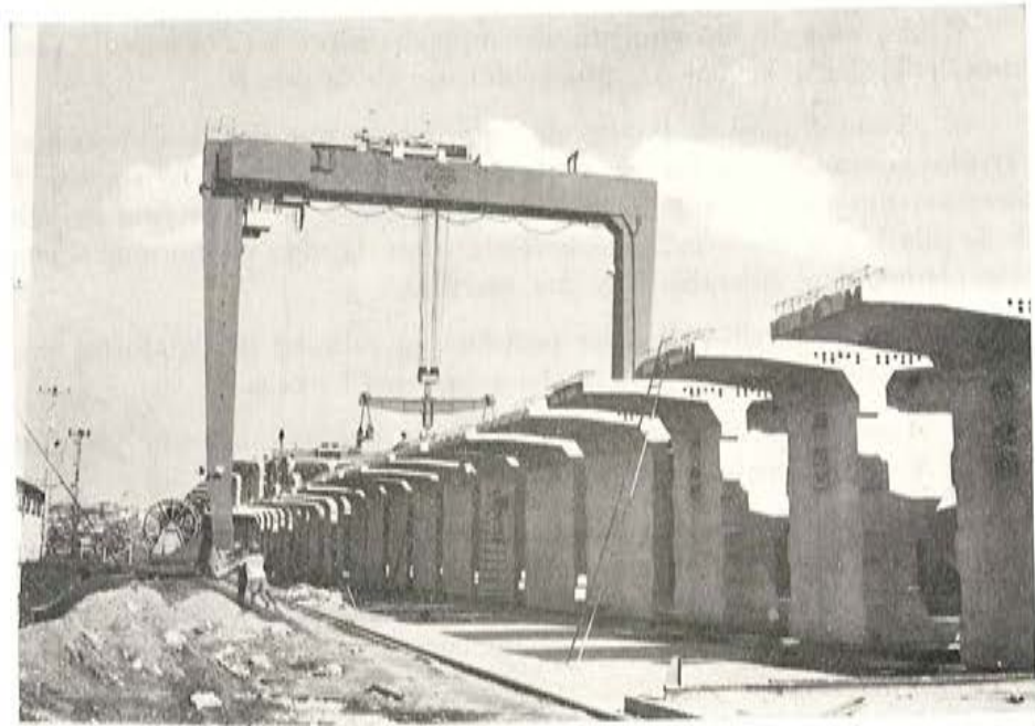
Fig. 8. — Zona de almacenamiento de las dovelas prefabricadas.
