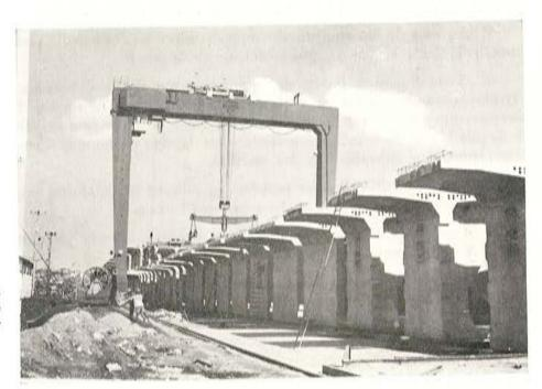
Fig. 8. — Zona de almacenamiento de las dovelas prefabricadas.
