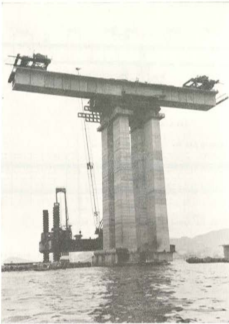
Fig. 17. — Montaje de las dovelas mediante dos pequeñas vigas auxiliares metálicas sobre la pila P98.
