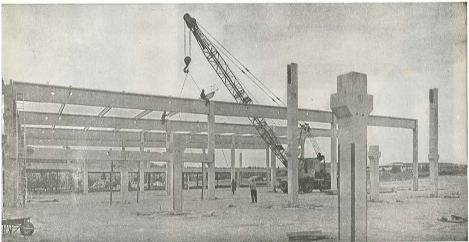
NAVE PREFABRICADA POR CADE
