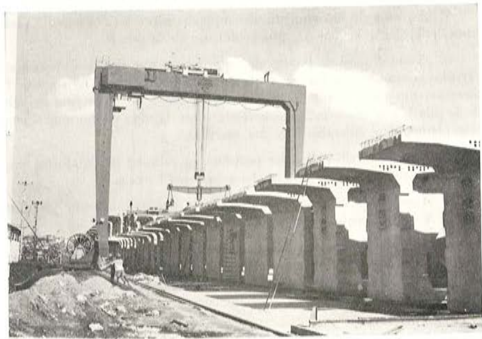
Fig. 8. — Zona de almacenamiento de las dovelas prefabricadas.
