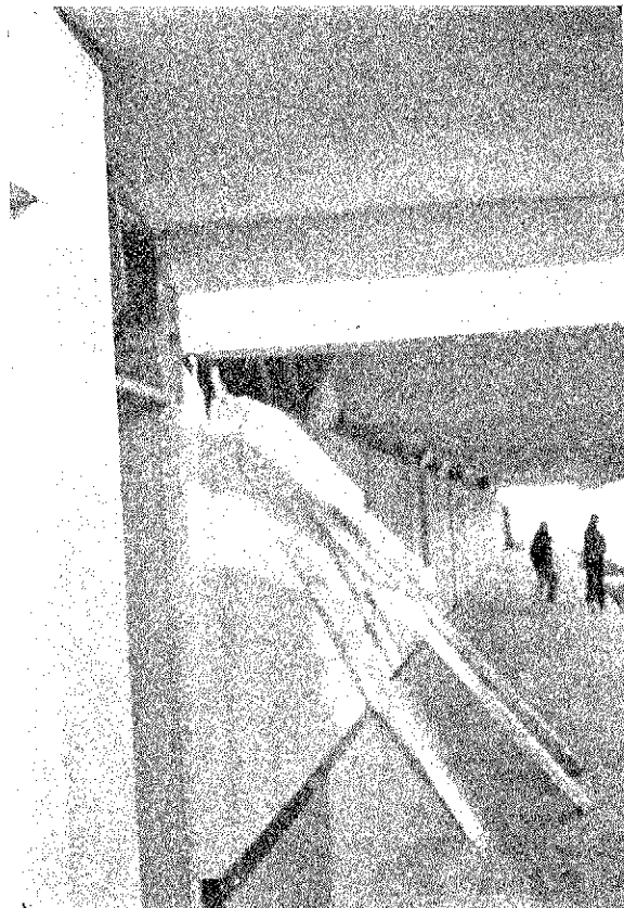
Foto 2. — Vaceamiento de tabique no estructural, por falta de una viga sclera de amarre en el borde superior que lo sujete a la estructura. Chimbote (Perú), sismo 1970.
