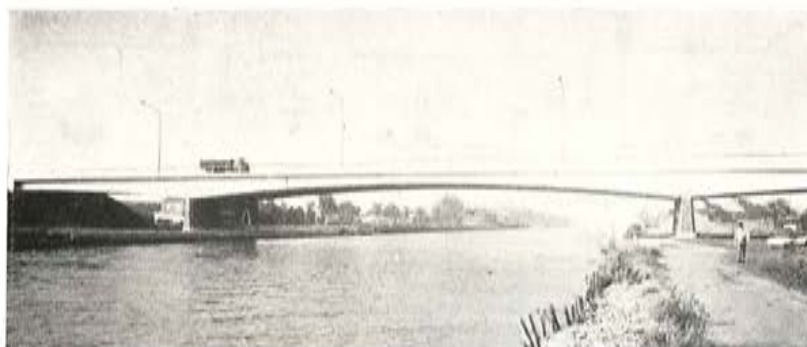
Fig. 7. — Puente de Massenhoven.
