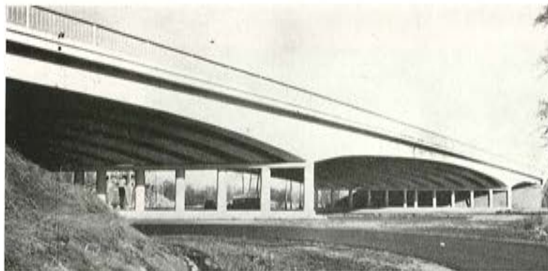
Fig. 12. — Puente de Bree.
