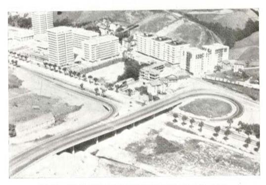
Fig. 13. — Enlace de Igara, Incorporación del ramal dentro del puente.
