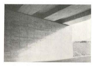
Fig. 3. - Paso bajo autopista. Losa nervada.
