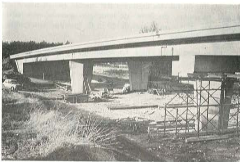
Fig. 15. — Puente de Mol-Gompel. Tramos de acceso.
