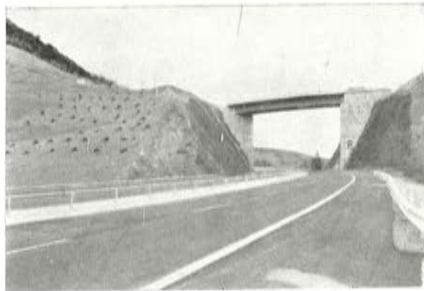
Fig. 9. — Paso sobre autopista. Estribos anclados al desmante.
