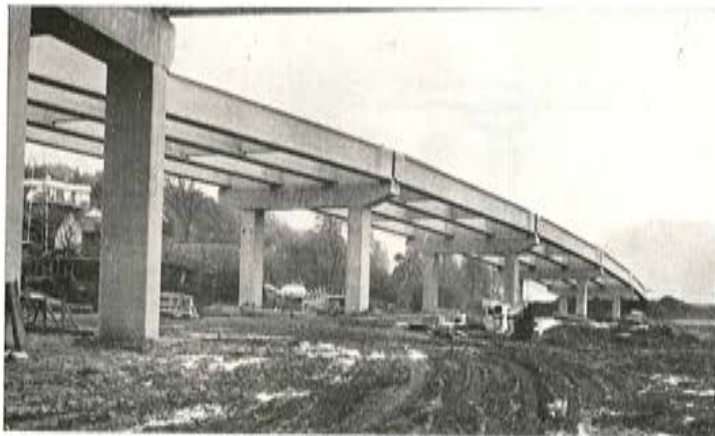
Fig. 53. — Viaducto S2. Rampa de acceso
