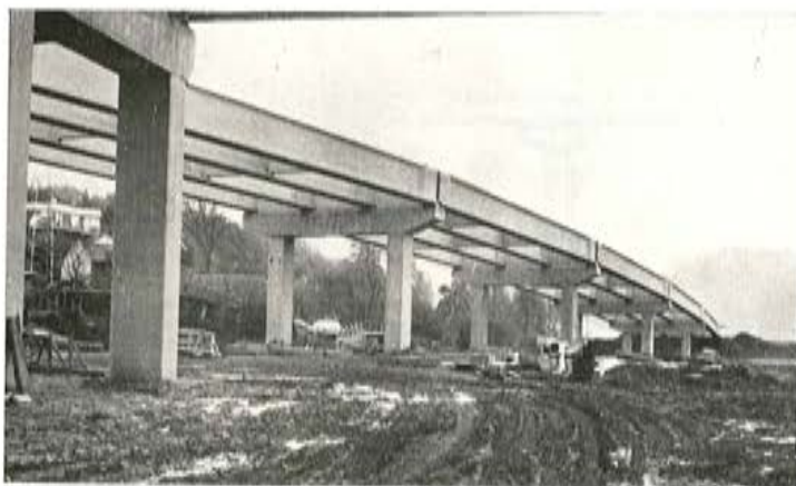
Fig. 53. — Viaducto S2. Rampa de acceso
