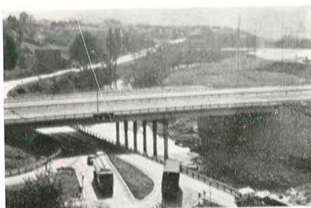
Fig. 15. — Viaducto de El Gallo. Pilas de fustes circulares.
