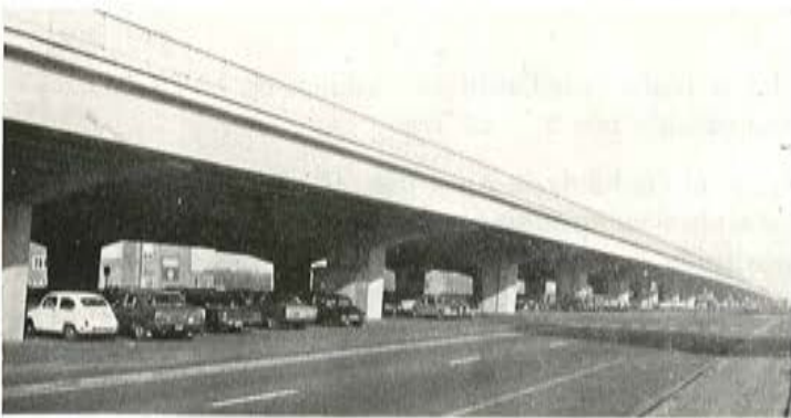
Fig. 40. — Viaducto de Wilrijk
