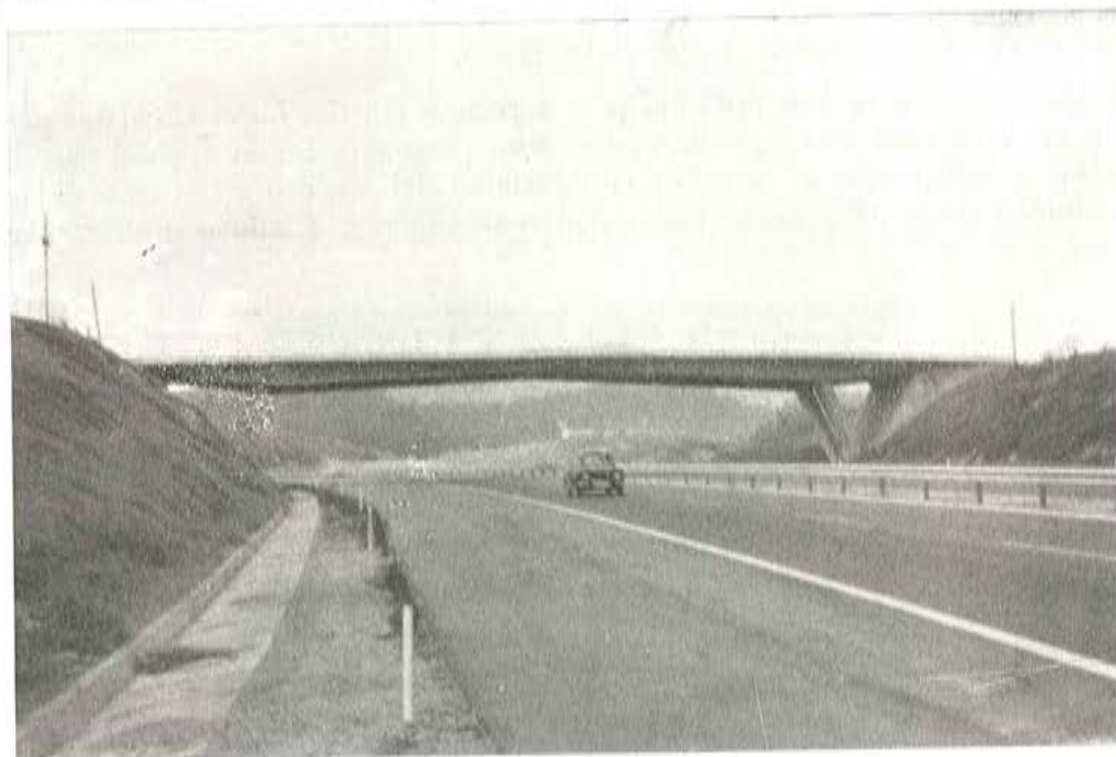
Fig. 5. — Paso sobre autopista, Pórtico de células triangulares.
