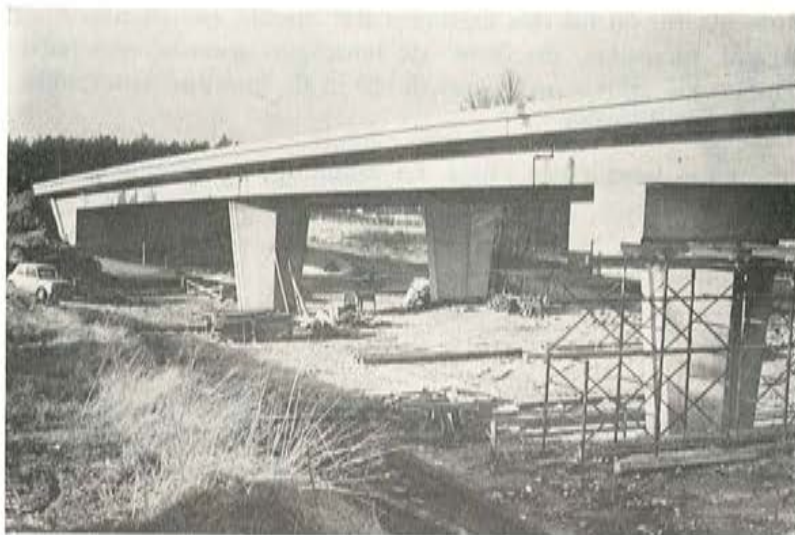
Fig. 15. — Puente de Mol-Gompel. Tramos de acceso.
