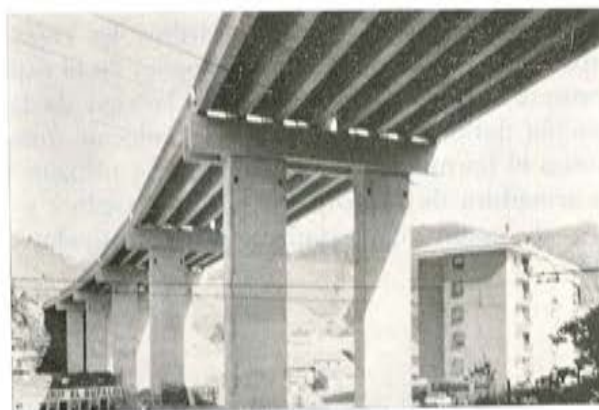
Fig. 17. — Viaducto San Antolín. Pórticos con fustes rectangulares.
