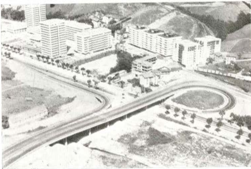
Fig. 13. — Enlace de Igara. Incorporación del ramal dentro del puente.
