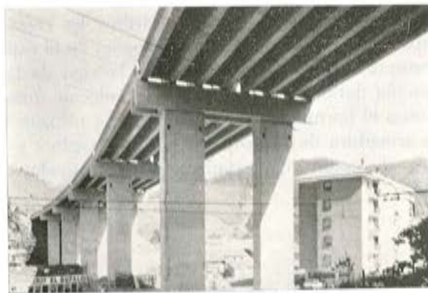
Fig. 17. — Viaducto San Antolín. Pórticos con fustes rectangulares.
