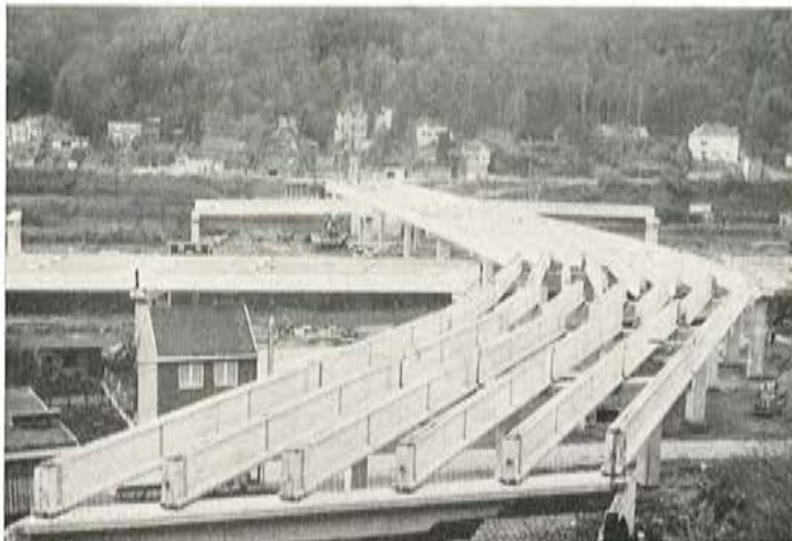
Fig. 51. — Viaducto S2 y rampas de acceso.
