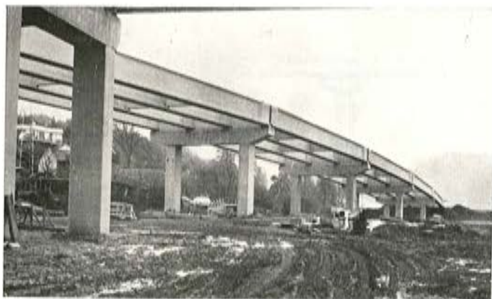
Fig. 53. — Viaducto S2. Rampa de acceso
