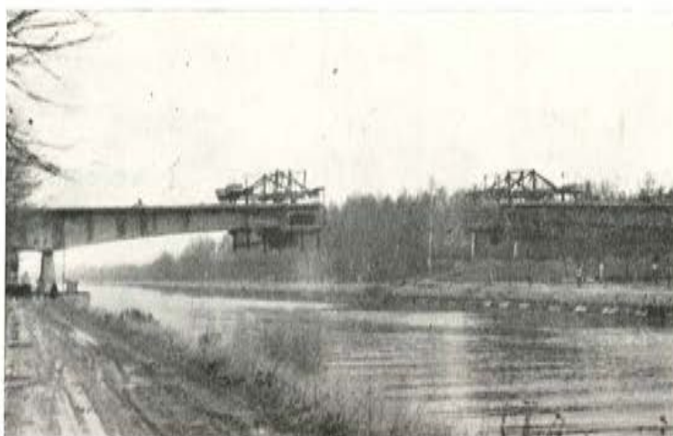
Fig. 19. — Puente de Eigenbilzen. Vista durante la construcción.
