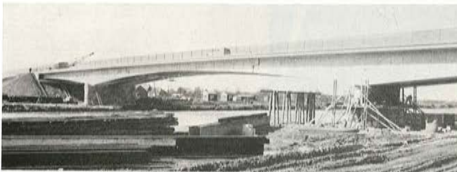
Fig. 35. — Puente de Meerhout.
