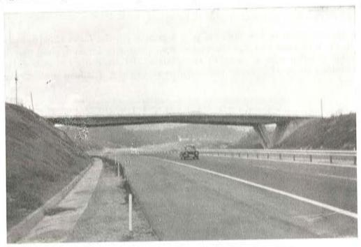
Fig. 5. — Paso sobre autopista, Pórtico de células triangulares.
