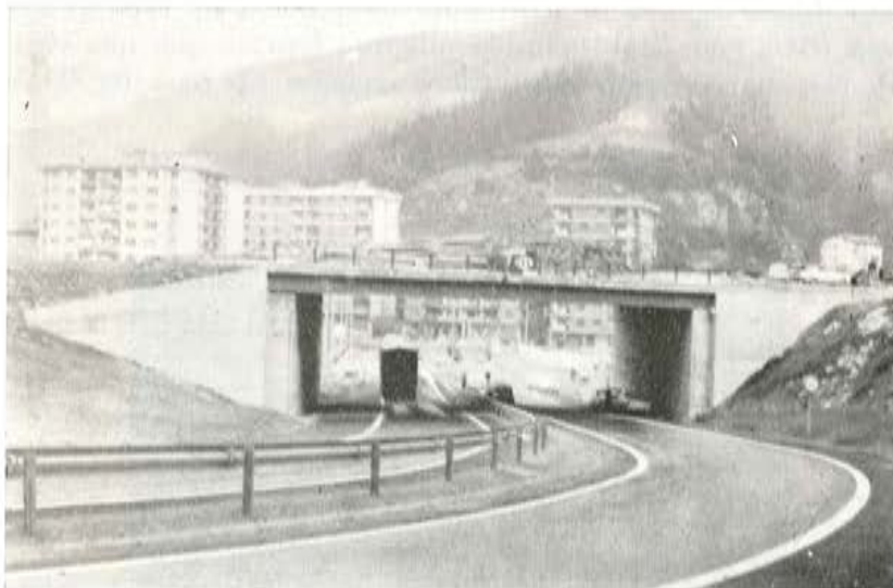
Fig. 11. — Enlace de Ermúa. Losa sobre estribos cerrados.
