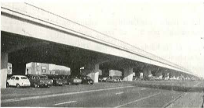
Fig. 40. — Viaducto de Wilrijk
