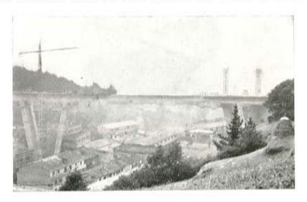
Fig. 19. - Viaducto de Chonta (luz máxima: 95 m).
