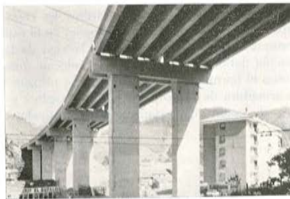
Fig. 17. — Viaducto San Antolín. Pórticos con fustes rectangulares.
