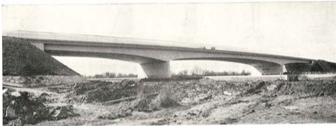
Fig. 23. — Puente de Gervort.
