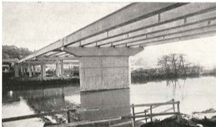
Fig. 52. — Viaducto S2. Tramos sobre el río Ourthe.
