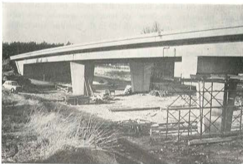
Fig. 15. — Puente de Mol-Gompel. Tramos de acceso.
