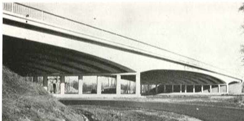
Fig. 12. — Puente de Bree.
