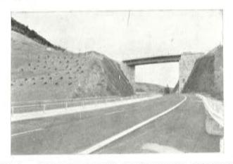
Fig. 9. - Paso sobre autopista. Estribos anclados al desmonte.
