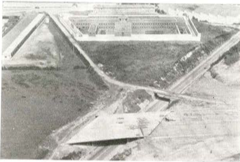
Fig. 10. — Enlace de Basauri. Losa continua oblicua.
