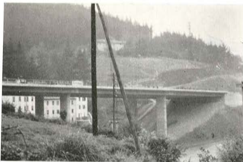
Fig. 14. — Viaducto Ipurúa. Losa nervada hormigonada in situ.
