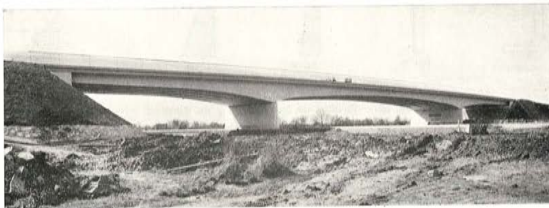
Fig. 23. — Puente de Gervort.
