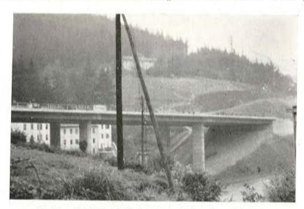
Fig. 14. — Viaducto Ipurúa. Losa nervada hormigonada in situ.
