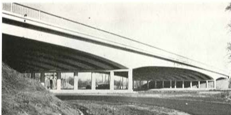
Fig. 12. — Puente de Bree.
