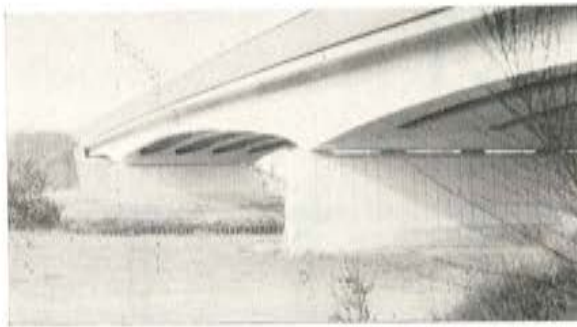
Fig. 4. — Puente de Balen-Neet.
