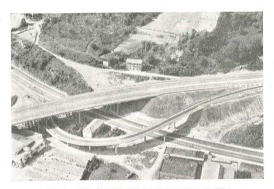
Fig. 12. — Ramal de Irubide, Losa continua sobre apoyos puntuales,
