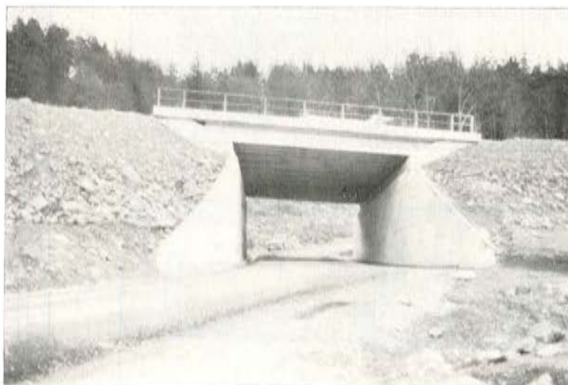
Fig. 4. — Paso bajo autopista. Vigas prefabricadas sobre macizos de tierra armada.
