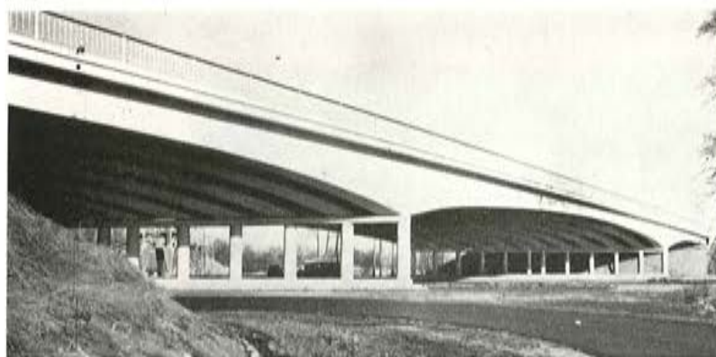
Fig. 12. — Puente de Bree.
