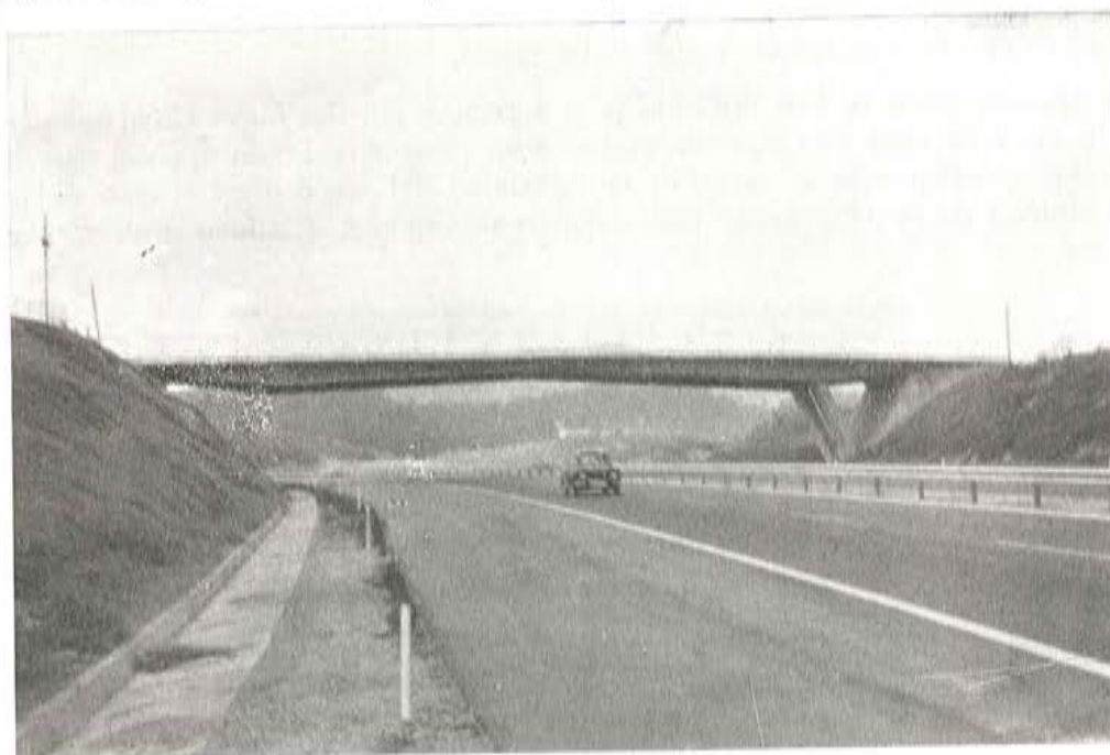
Fig. 5. — Paso sobre autopista, Pórtico de células triangulares.
