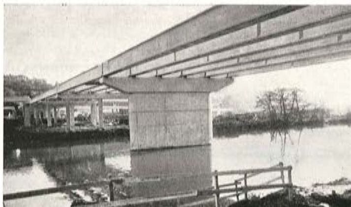
Fig. 52. — Viaducto S2. Tramos sobre el río Ourthe.
