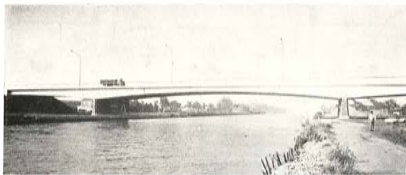
Fig. 7. — Puente de Massenhoven.
