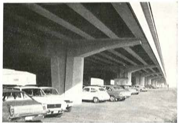
Fig. 41. — Viaducto de Wilrijk.
