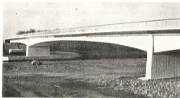
Fig. 20. — Puente de Eigenbilzen.
