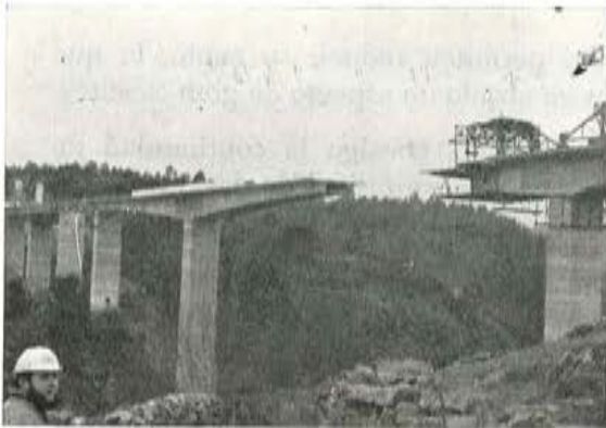
Viaducto sobre el río Deza, en Silleda (Pontevedra). Luces: 3 \times 23 + 23,50 + 45,50 + 90 + 45,50 + + 23,50 + 23 m.
