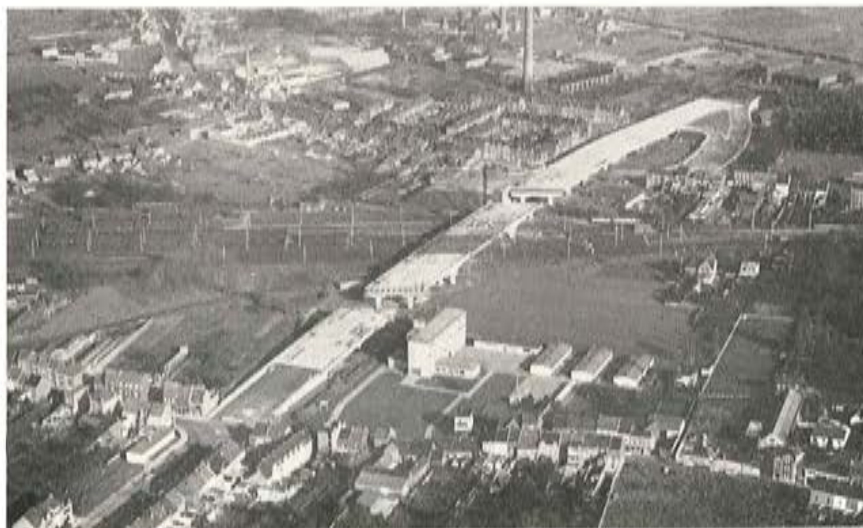
Fig. 47. — Viaducto de Alost. Vista aérea.
