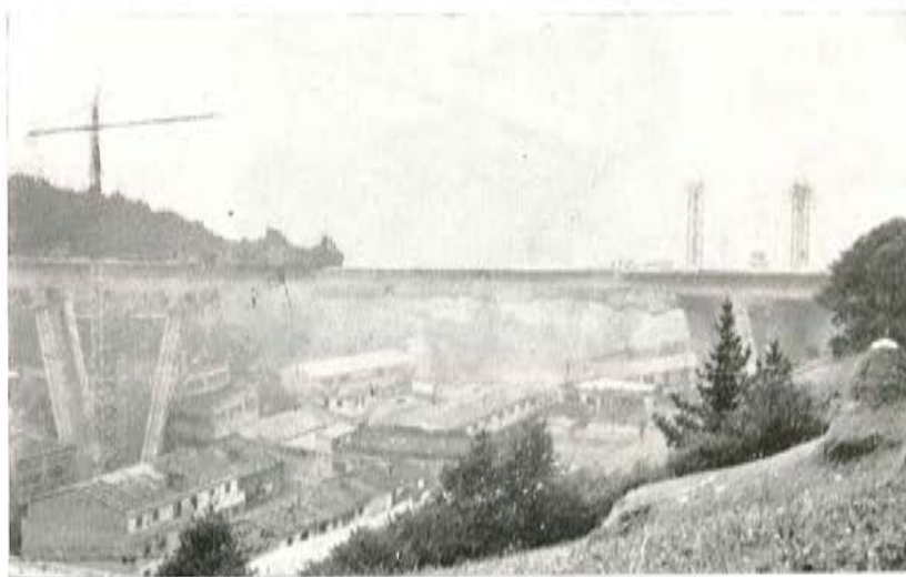
Fig. 19. — Viaducto de Chonta (luz máxima: 95 m).
