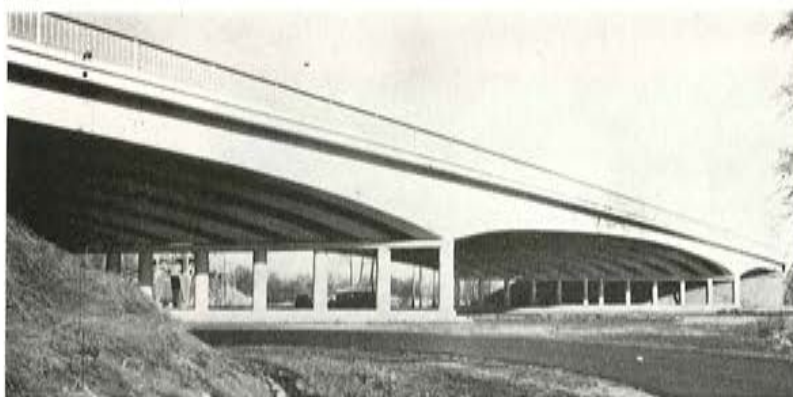
Fig. 12. — Puente de Bree.
