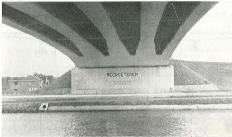
Fig. 23. — Puente de Neeroeteren.
