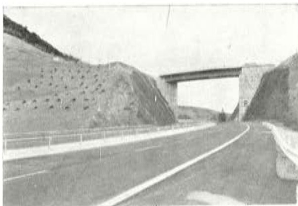
Fig. 9. — Paso sobre autopista. Estribos anclados al desmonte.
