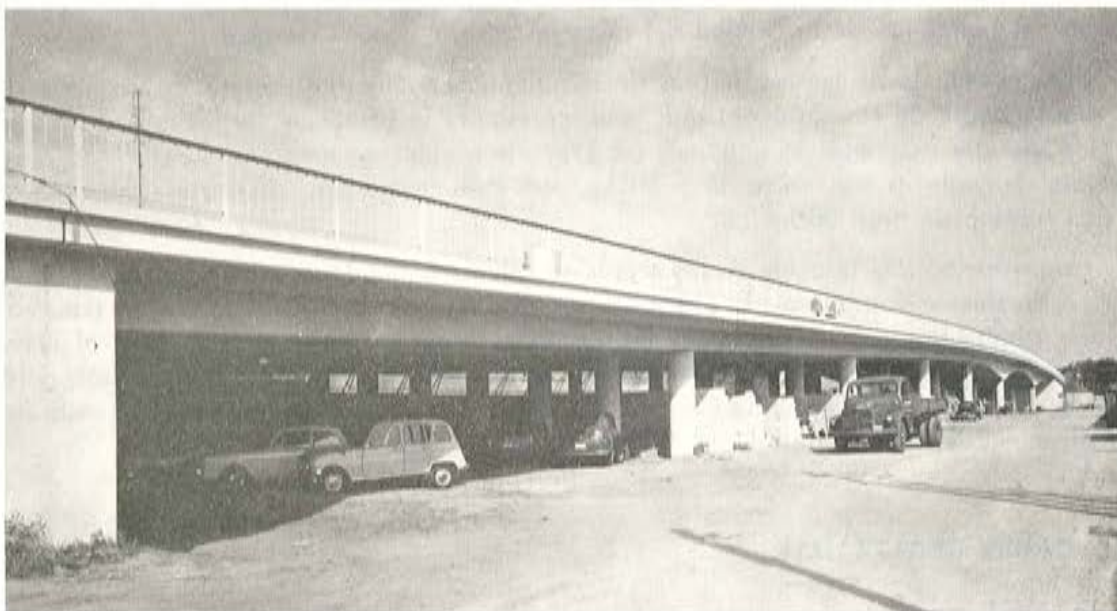
Fig. 2. — Puente de Ravels. Viaducto de acceso.
