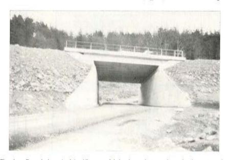
Fig. 4. — Paso bajo autopista. Vigas prefabricadas sobre macizos de tierra armada.
