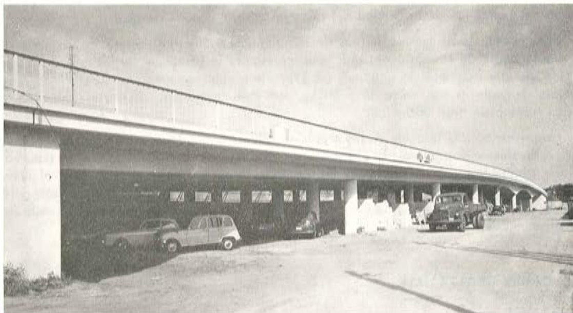
Fig. 2. — Puente de Ravels. Viaducto de acceso.
