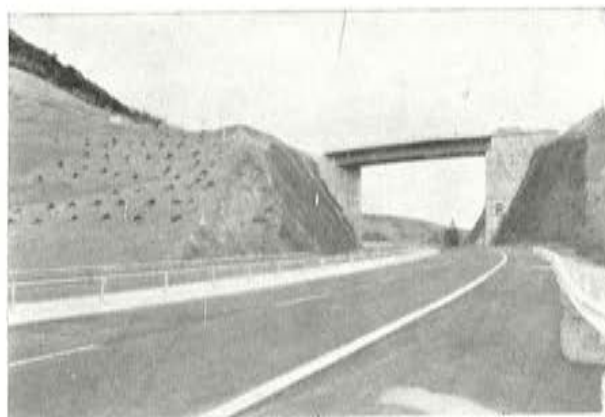
Fig. 9. — Paso sobre autopista. Estribos anclados al desmante.
