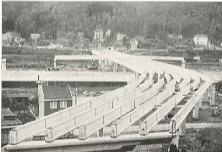
Fig. 51. — Viaducto S2 y rampas de acceso.
