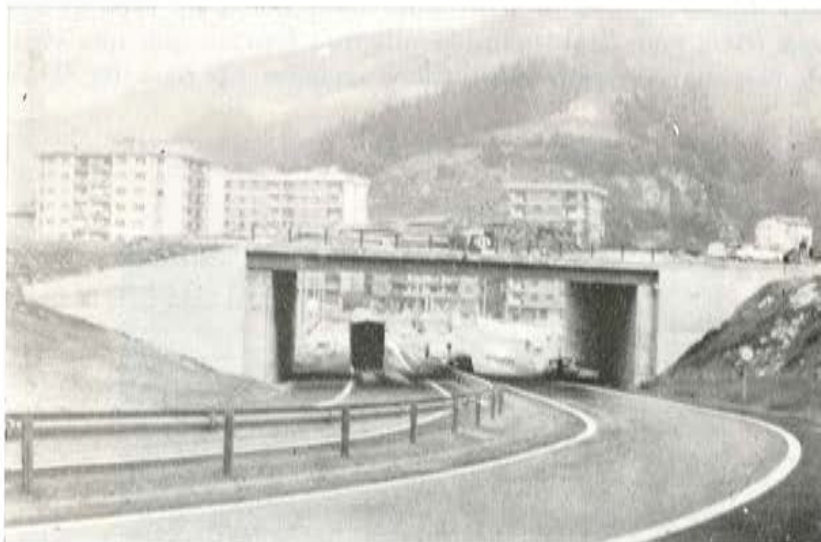
Fig. 11. — Enlace de Ermúa. Losa sobre estribos cerrados.
