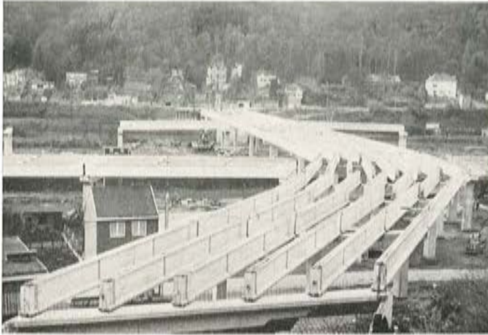
Fig. 51. — Viaducto S2 y rampas de acceso.
