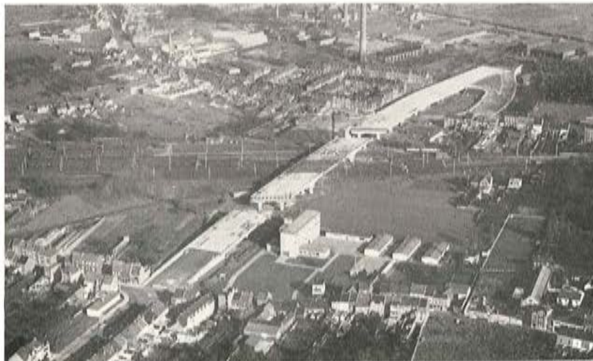
Fig. 47. — Viaducto de Alost. Vista aérea.
