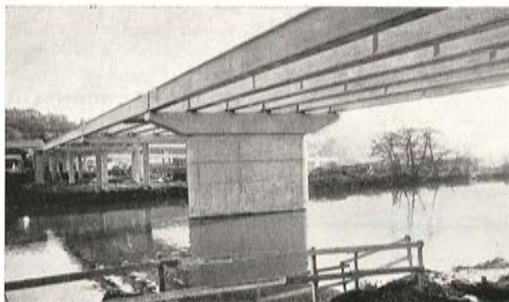
Fig. 52. — Viaducto S2. Tramos sobre el río Ourthe.
