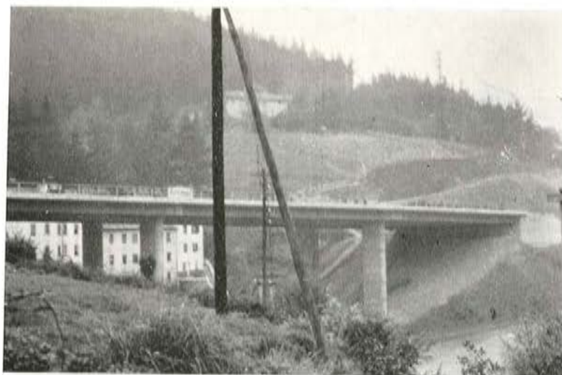
Fig. 14. — Viaducto Ipurúa. Losa nervada hormigonada in situ.
