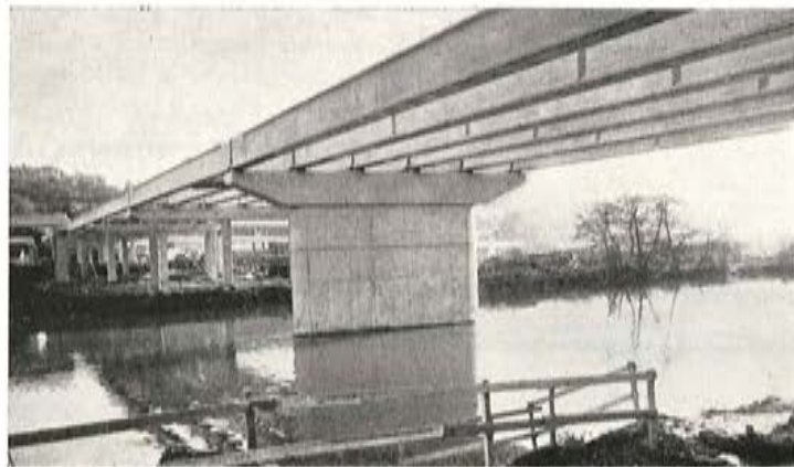
Fig. 52. — Viaducto S2. Tramos sobre el río Ourthe.
