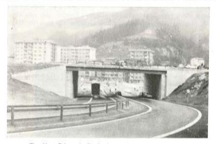
Fig. 11. — Enlace de Ermúa. Losa sobre estribos cerrados.
