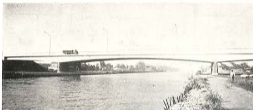
Fig. 7. — Puente de Massenhoven.
