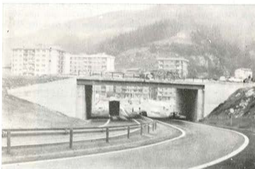
Fig. 11. — Enlace de Ermúa. Losa sobre estribos cerrados.
