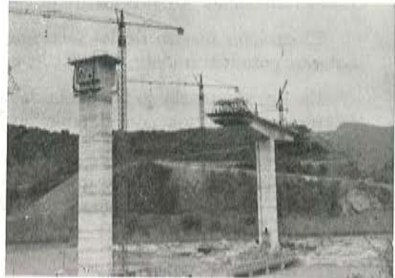
Puente del Carril, en Toral de los Vados (León). Luces: 45 + 54 + 3 \times 108 + 54 + 45 m. Construye: E.F.Y.C.S.A.
