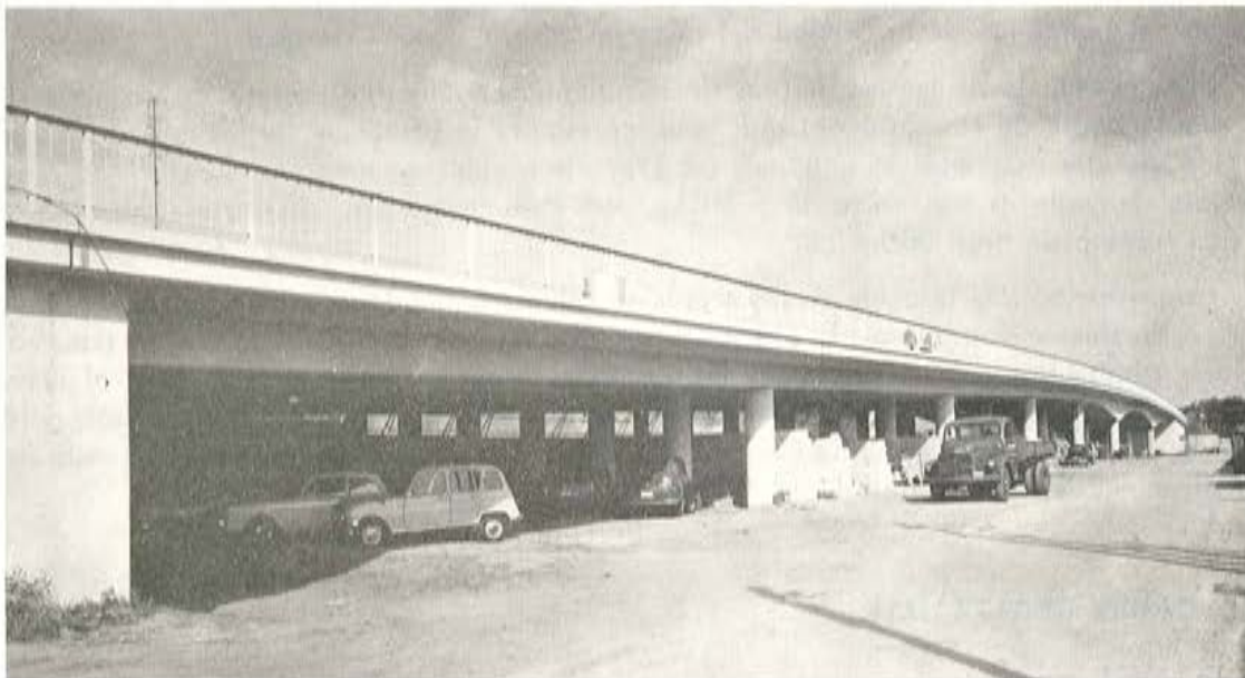
Fig. 2. — Puente de Ravels. Viaducto de acceso.
