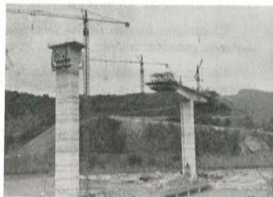
Puente del Carril, en Toral de los Vados (León). Luces: 45 + 54 + 3 \times 108 + 54 + 45 m. Construye: E.F.Y.C.S.A.
