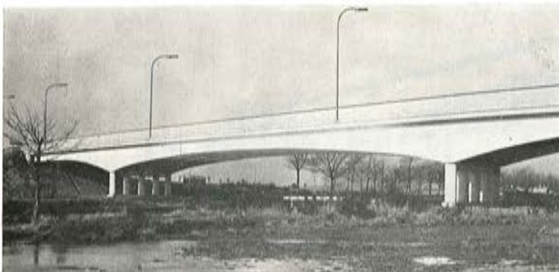
Fig. 10. — Puente de Geisteren.
