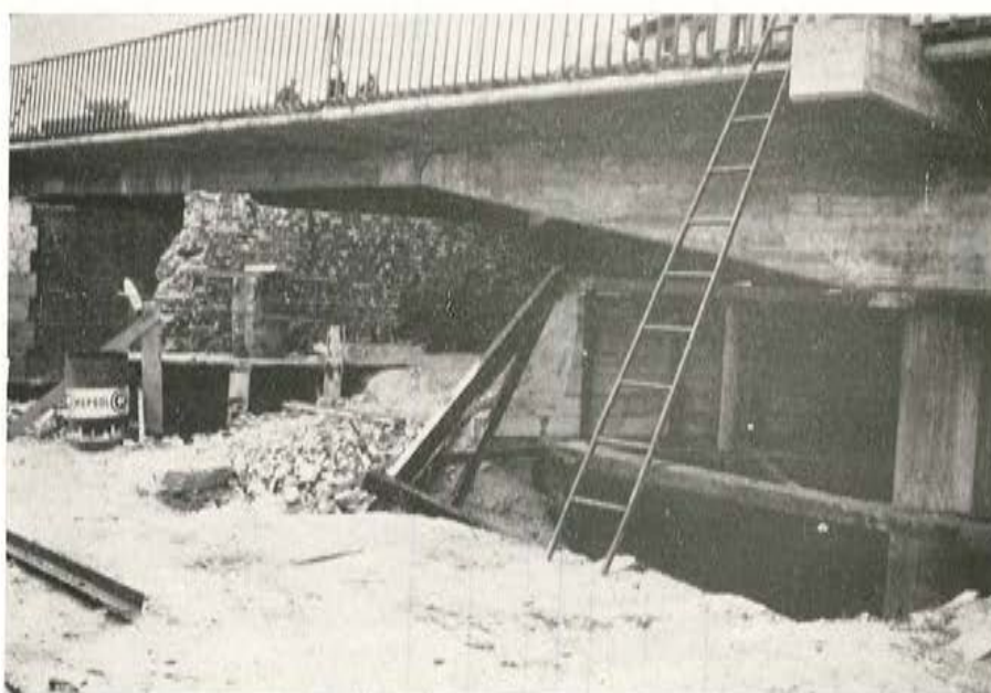
Fig. 12. — Puente de Medina. Vista de una pila.
