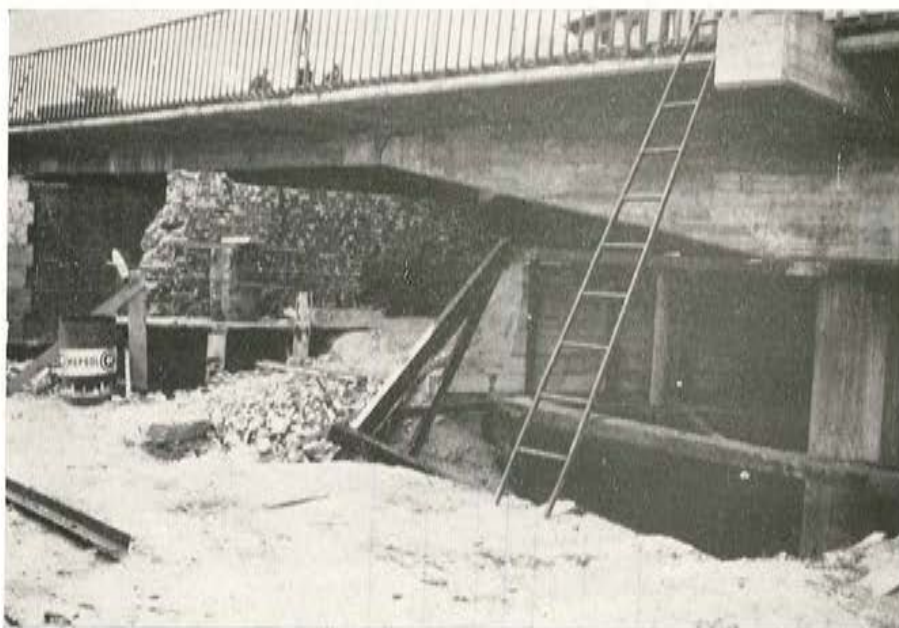
Fig. 12. — Puente de Medina. Vista de una pila.
