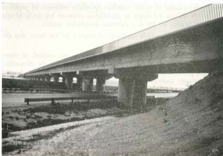
Fig. 7. — Pilas tipificadas del puente de Liria.
