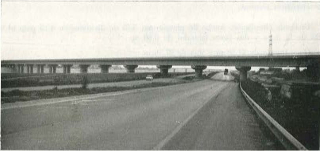
Fig. 4. — Puente del ferrocarril Liria-Utiel.
