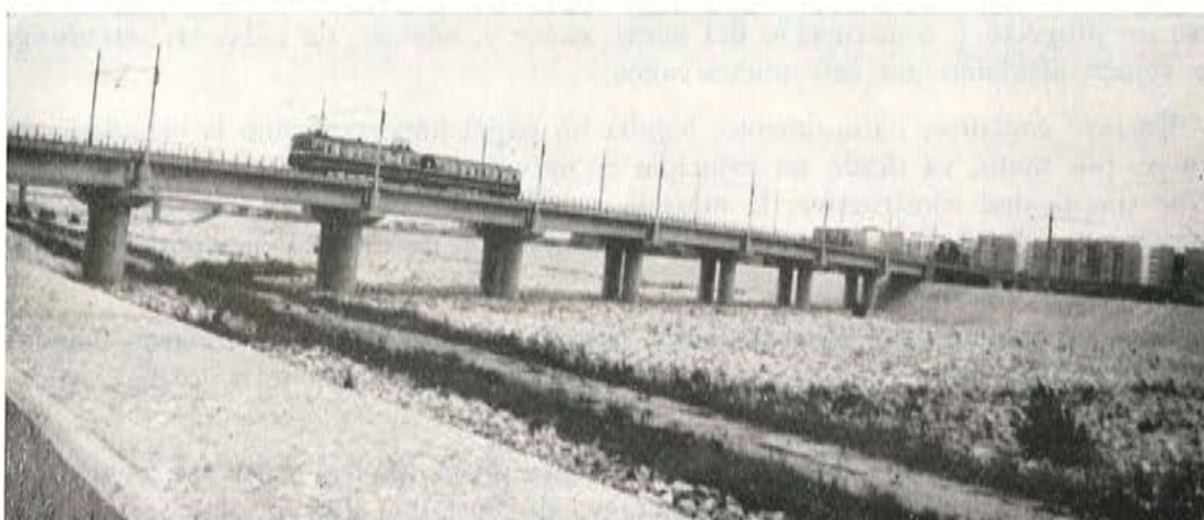
Fig. 5. — Puente de Villanueva de Castellón.
