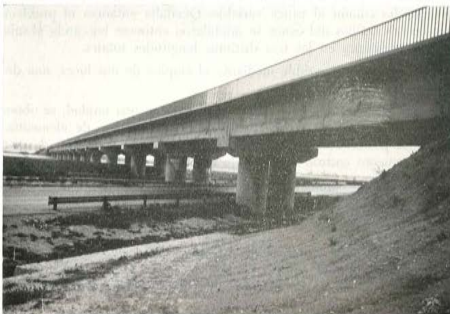
Fig. 7. — Pilas tipificadas del puente de Liria.
