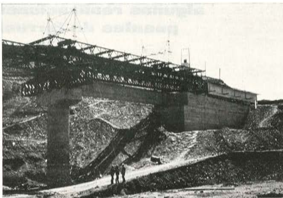
Fig. 2. — Lanzamiento de un tramo.
