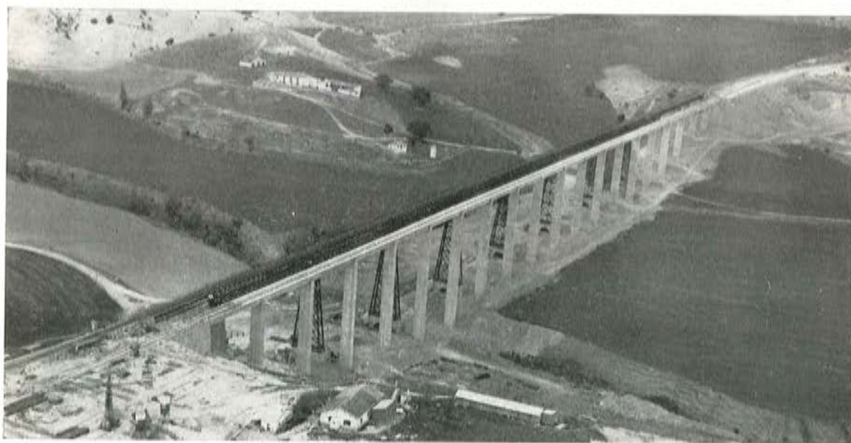
Fig. 7. — Puente del Hacho.
