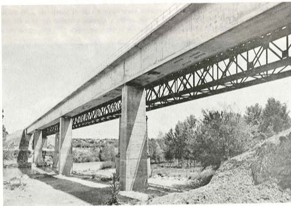
Fig. 6. — Puente de Guadalimar.
