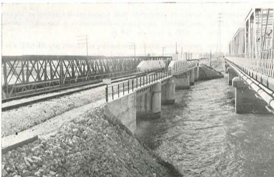
Fig. 2. — Puente de Sancti Petri.
