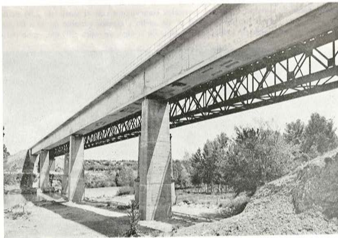
Fig. 6. — Puente de Guadalimar.
