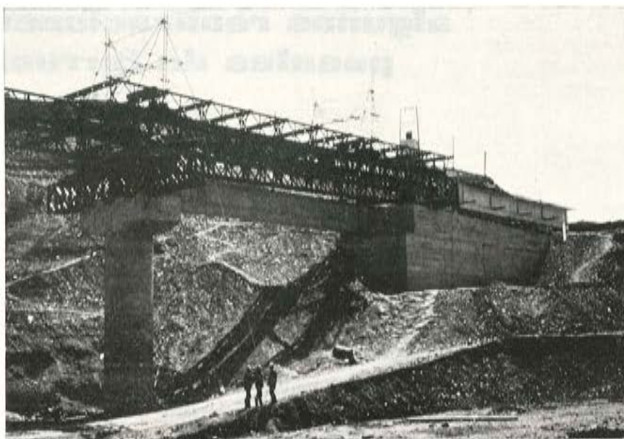
Fig. 2. — Lanzamiento de un tramo.
