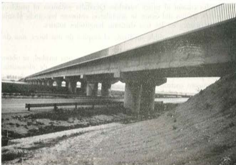
Fig. 7. — Pilas tipificadas del puente de Liria.
