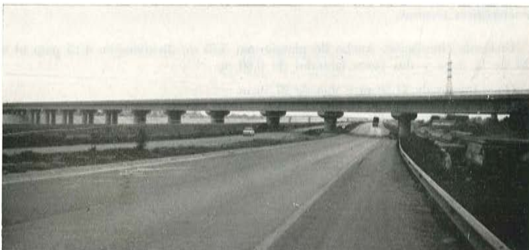
Fig. 4. — Puente del ferrocarril Liria-Utiel.
