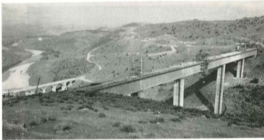
Fig. 4. — Puente de La Plata.
