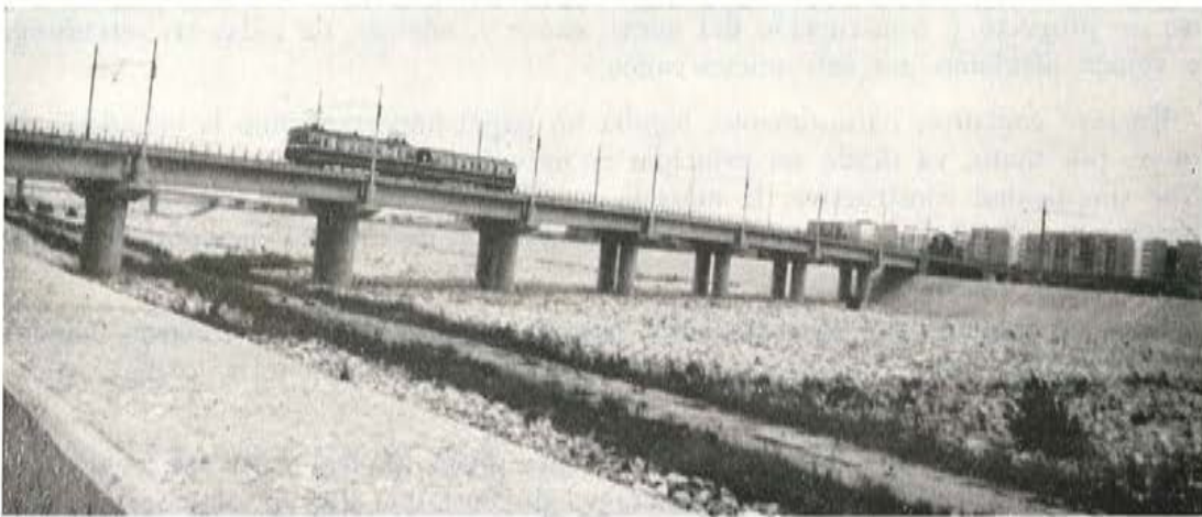
Fig. 5. — Puente de Villanueva de Castellón.
