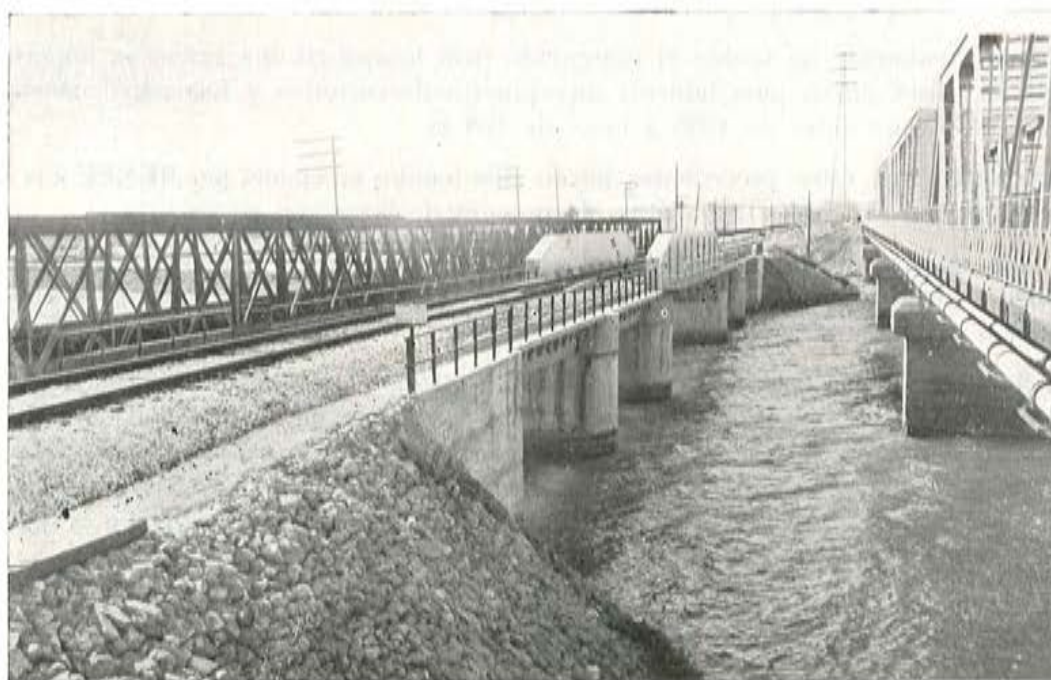
Fig. 2. — Puente de Sancti Petri.
