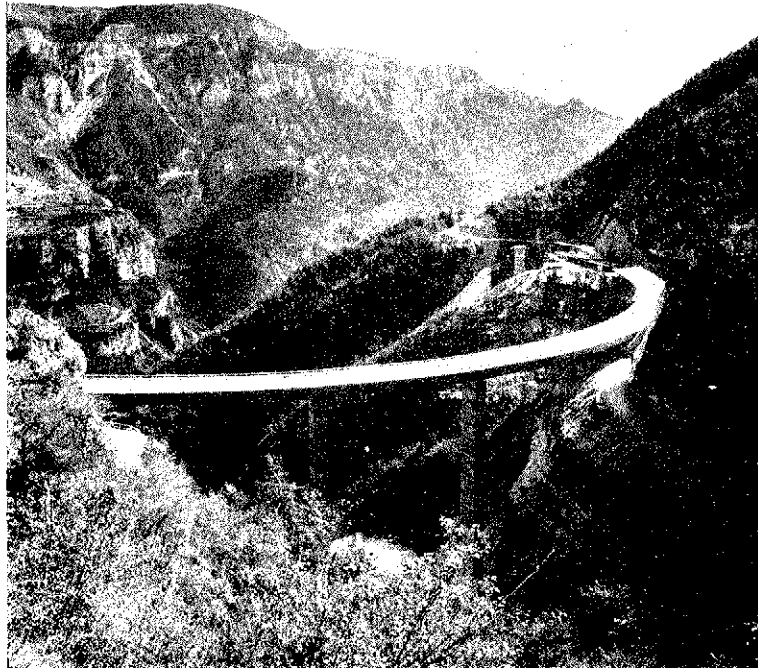
Figura 1. — Viaducto de Val Restel. Vista del tablero.
