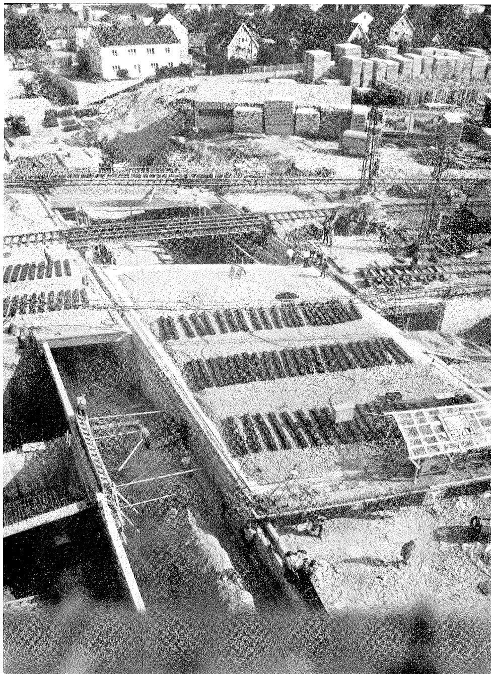
Fig. 19. — Vista superior del puente durante su lanzamiento.
