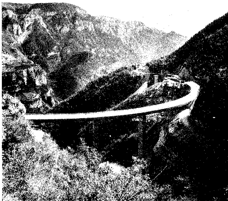
Figura 1. — Viaducto de Val Restel. Vista del tablero.
