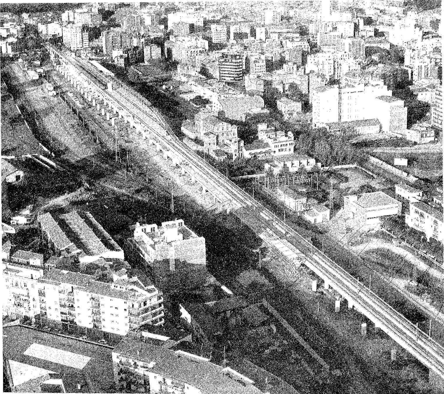
Fig. 1. — Vista aérea del viaducto de Gerona.
