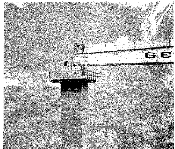
Fig. 5. — Encuentro del pescante metálico con una de las pilas del puente.
