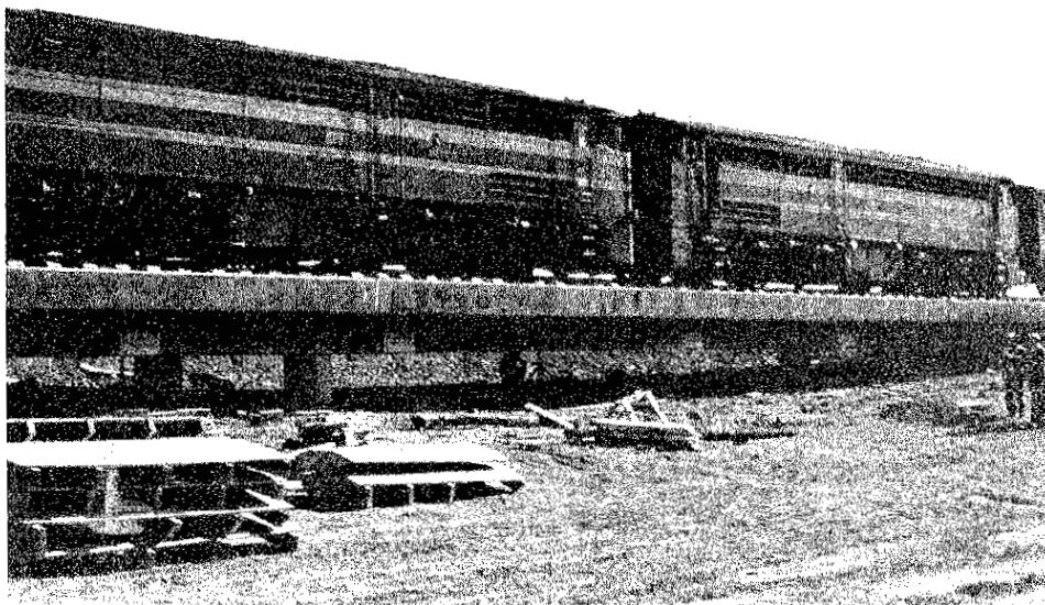
Fig. 20. — Puente en la nueva línea Sevilla-Aznalcóllar, Prueba de carga.
