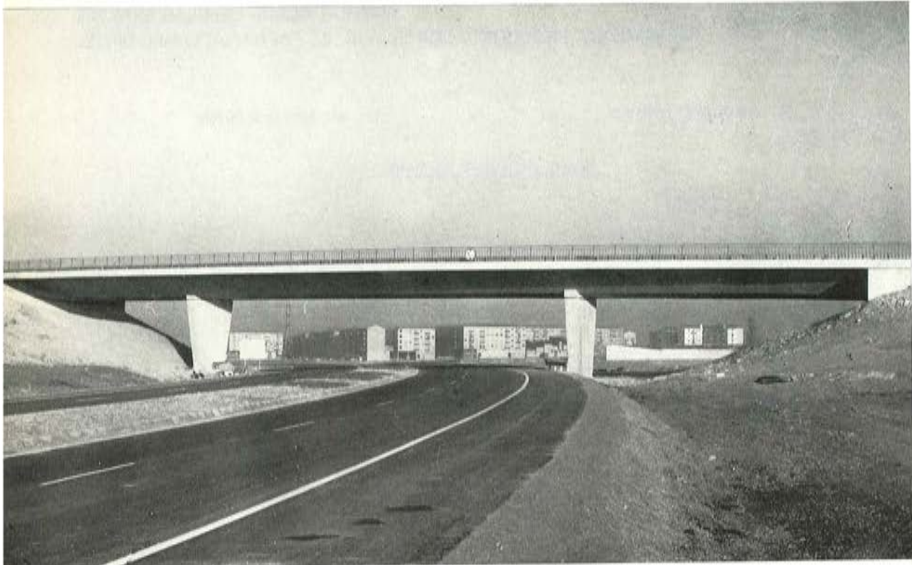
Fig. 12. Paso superior de Santa Lucia, Variante Oeste de Pamplona. Vista general
