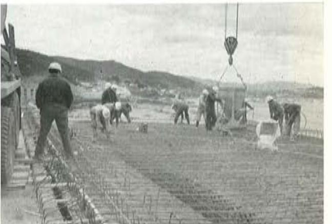
Fig. 14.—Hormigonado del tablero.
