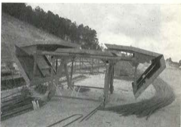
Fig. 12.—Elemento del encofrado interior del tablero.
