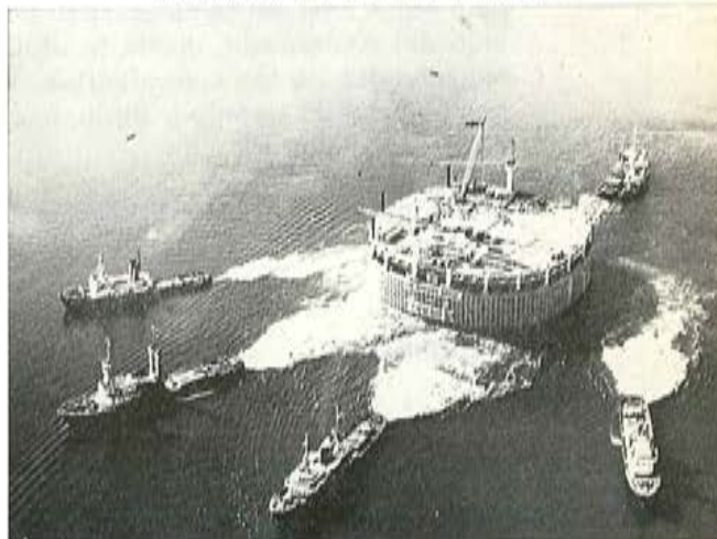
Remolcado del depósito de Ekofisk
