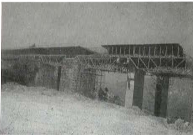
Fig. 11.—Traslado del encofrado lateral del tablero.
