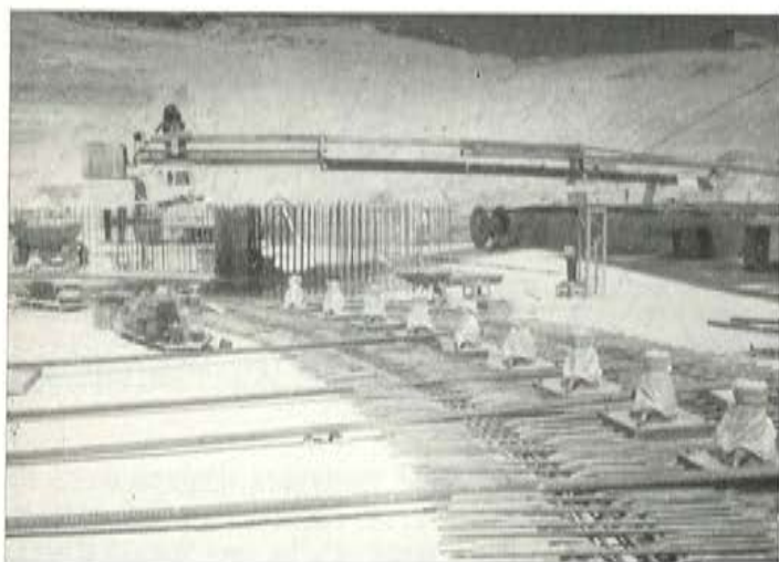
Foto 19. Placas de anclaje y trompetas ya colocadas
