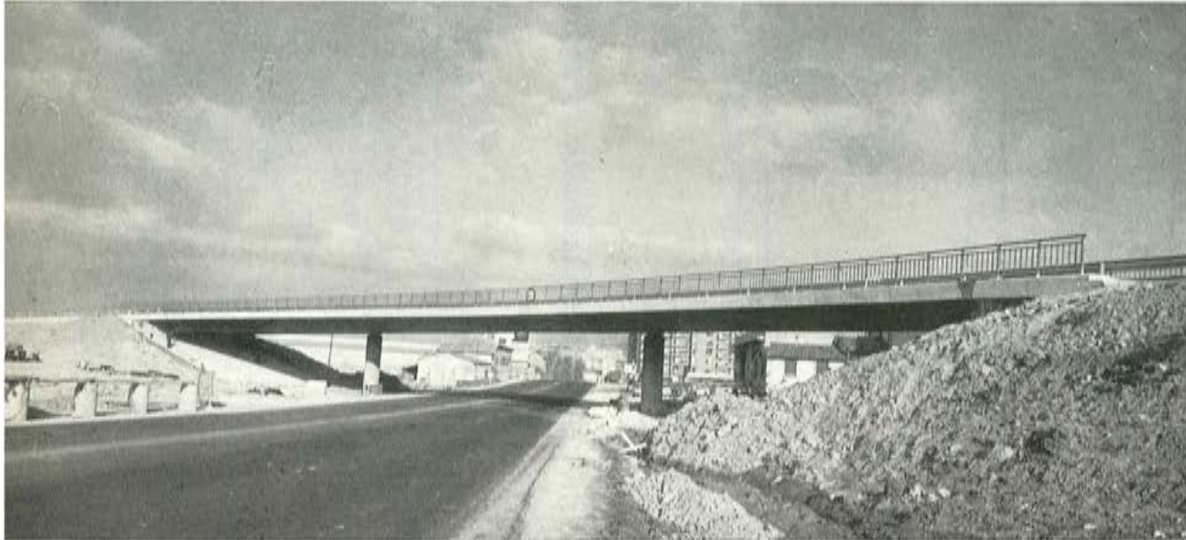
Fig. 36. Paso sobre la carretera de Zaragoza, Variante Oeste de Pamplona.
