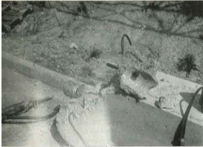
Foto 36. Pequeña fuga en el vendaje de unión entre la vaina y el tubo de drenaje.
