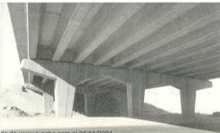
Fig. 42. Puente de Hortaleza. Vista Interior.
