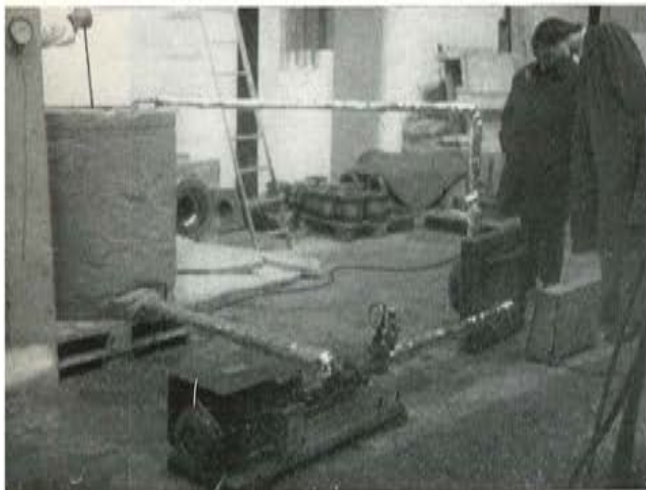
Foto 38. Ensayos de estanqueidad a la grasa entre la placa de apoyo y la caperuza
