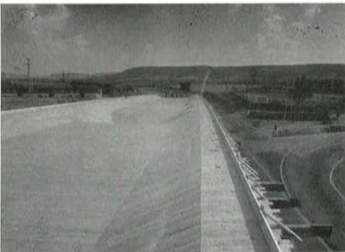
Fig. 40. Paso elevado CN-II en Guadalajara. Vista del encofrado exterior terminado.
