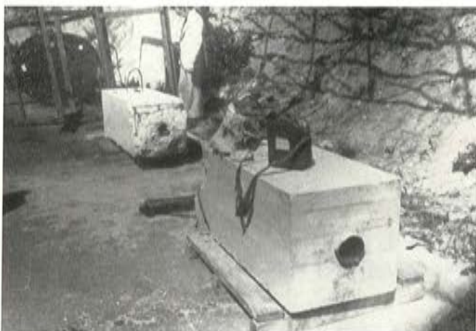
Foto 33. Bloque de hormigón después de roto para ver la existencia de fugas de grasa
