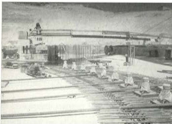
Foto 19. Placas de anclaje y trompetas ya colocadas
