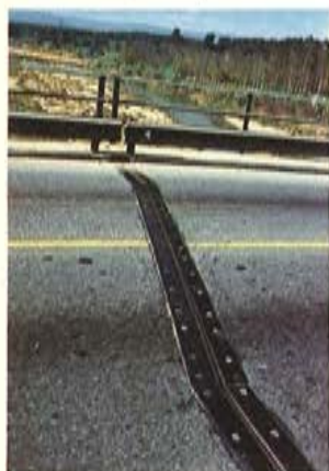
La junta del puente del Tordera en servicio
