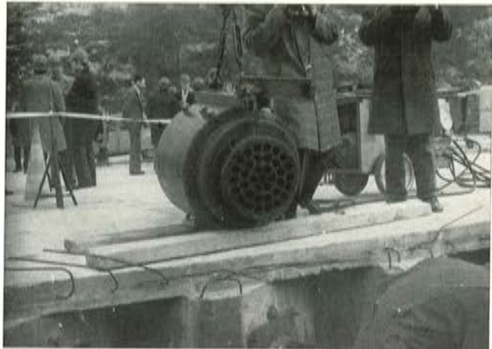
Foto 40. Tesado de tendones 37 T 15 en el puente de la autopista Marsella-Niza (Francia). Sistema Freyssinet. Los anclajes y gatos son los mismos que se usan en la Central Nuclear de Ascó. Gato dispuesto para colocarse
