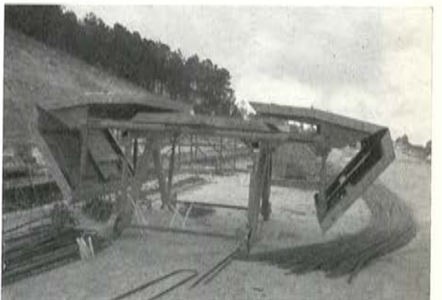
Fig. 12.—Elemento del encofrado interior del tablero.
