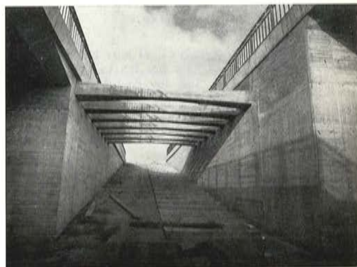
Fig. 29. Variante Oeste de Pamplona. Rampa de descenso de peatones en el paso sobre el Camino de Ovejeros.
