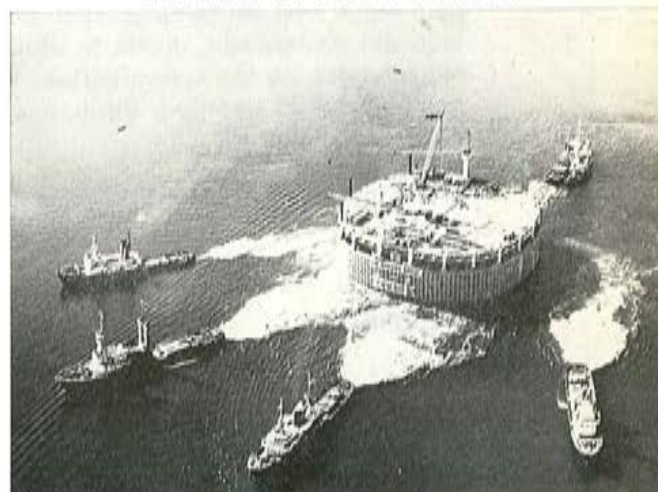
Remolcado del depósito de Ekofisk
