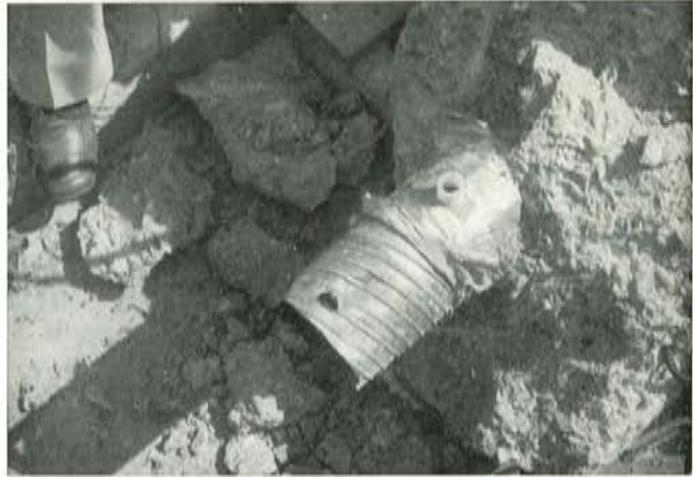
Foto 37. Unión entre la vaina y el tubo de drenaje.
