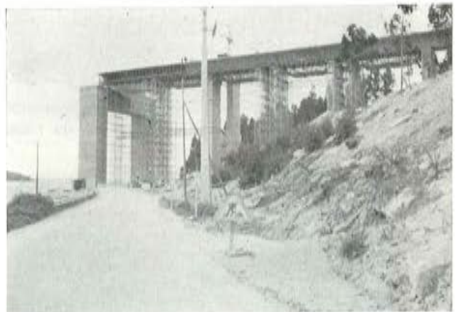
Fig. 19.—Vista de las obras en el acceso norte.
