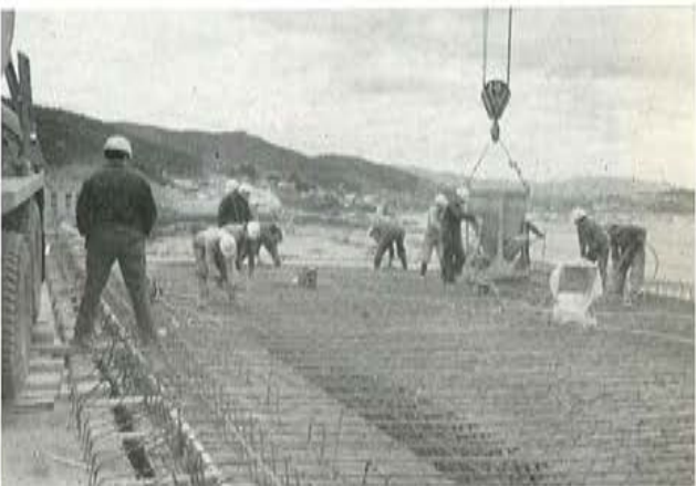
Fig. 14.—Hormigonado del tablero.
