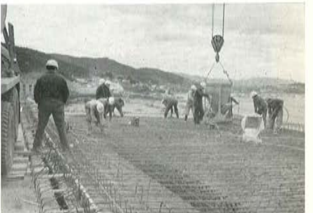
Fig. 14.—Hormigonado del tablero.
