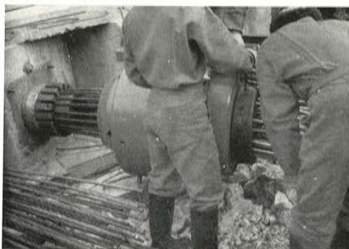
Foto 41. Terminación de enfilado de los cordones en el gato
