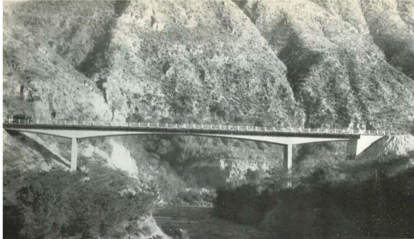
Fig. 13. Puente sobre el río Guayllabamba, Ecuador
