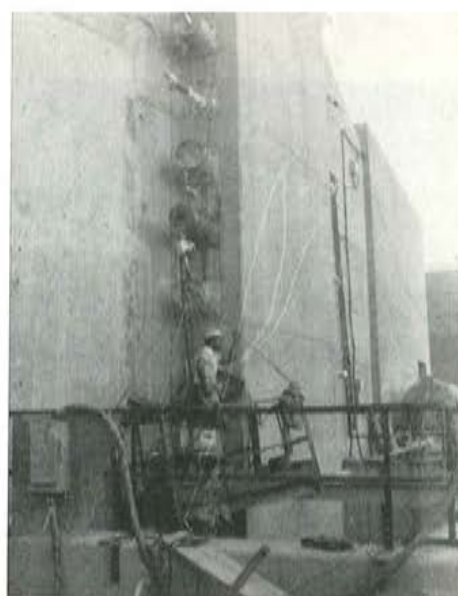
Foto 11. Cables y caperuzas en el contrafuerte.
