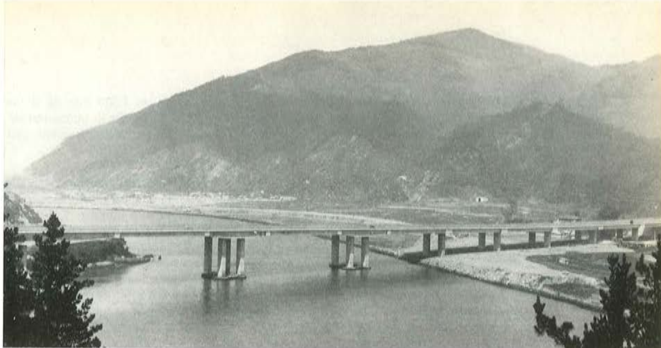
Fig. 1. Viaducto de Orio
