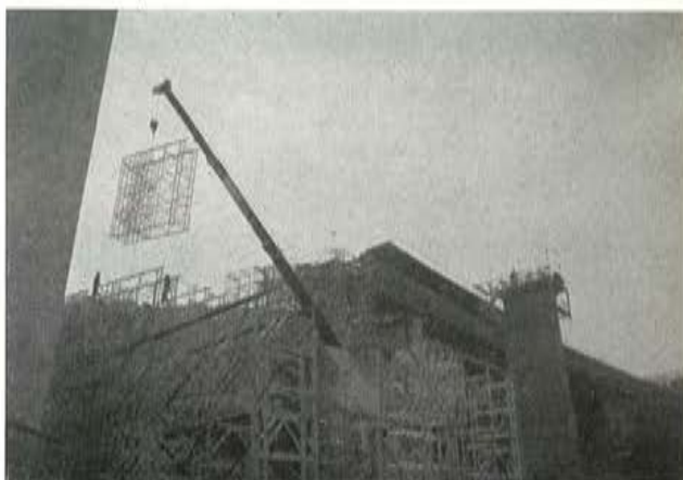
Fig. 10.—Traslado y montaje en nueva posición de elementos de las torres tubulares provisionales.
