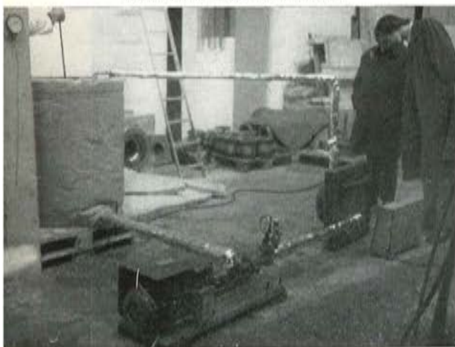
Foto 38. Ensayos de estanqueidad a la grasa entre la placa de apoyo y la caperuza
