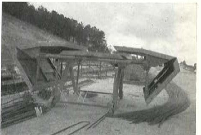
Fig. 12.—Elemento del encofrado interior del tablero.
