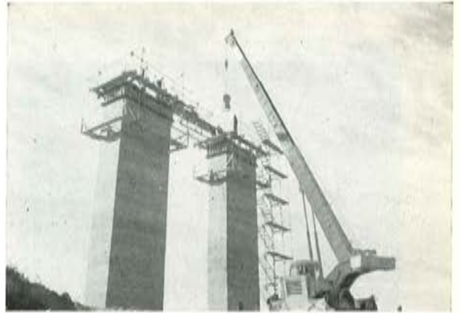
Fig. 8.—Hormigonado mediante encofrados deslizantes de las pilas.
