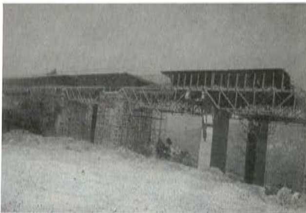
Fig. 11.—Traslado del encofrado lateral del tablero.
