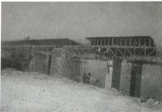
Fig. 11.—Traslado del encofrado lateral del tablero.
