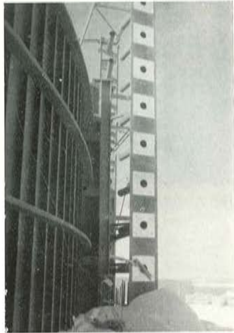
Foto 13. Montaje de las placas de anclaje en los contrafuertes.
