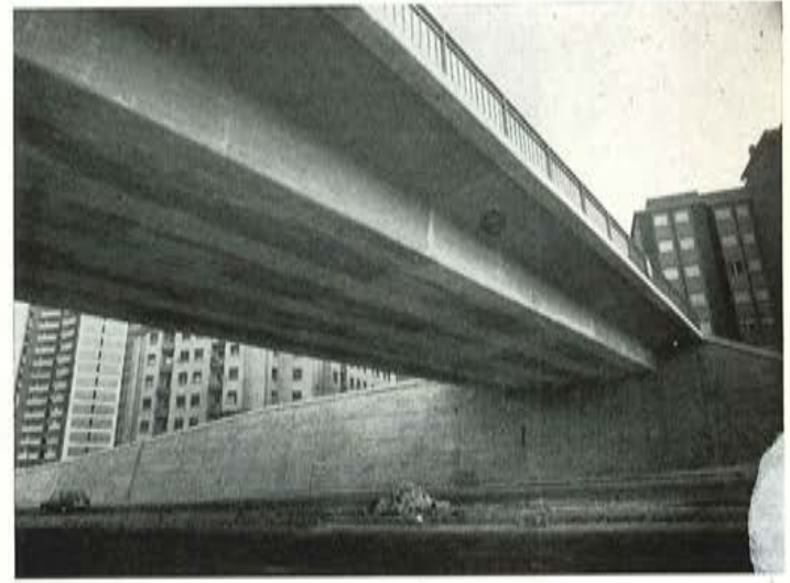
Fig. 23. Puente de San Juan, Detalle.
