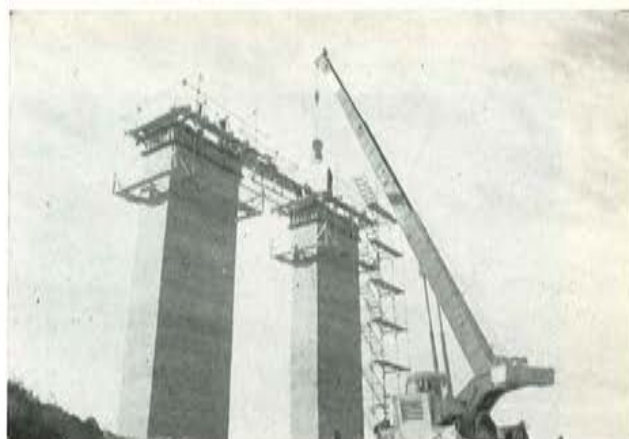
Fig. 8.—Hormigonado mediante encofrados deslizantes de las pilas.
