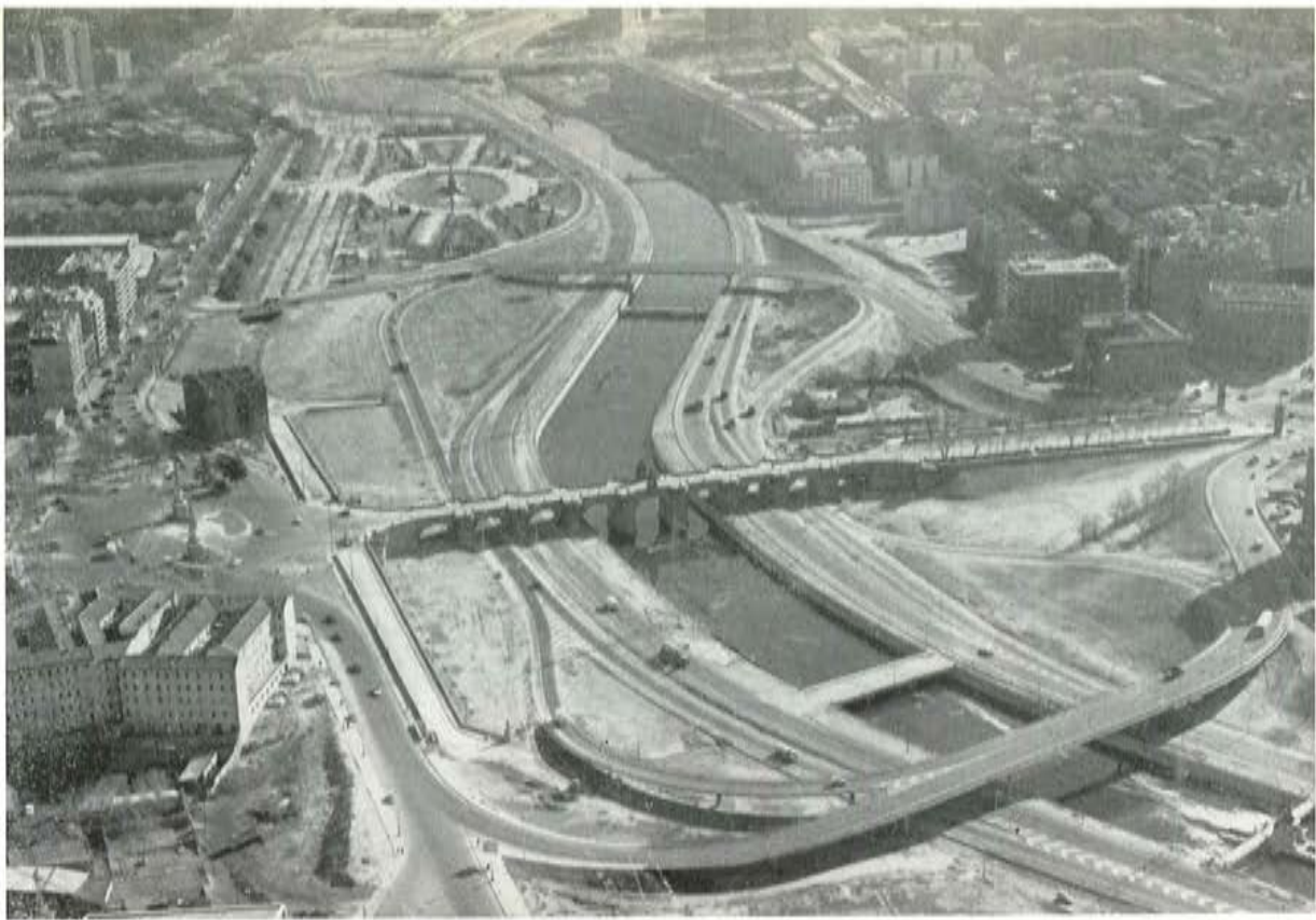
Fig. 4. Puente de Toledo y puentes del tercer cinturón
