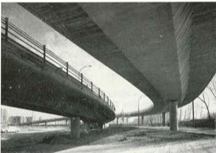
Fig. 3. Accesos a la estación de Chamartín. Yedra Norte y Sur
