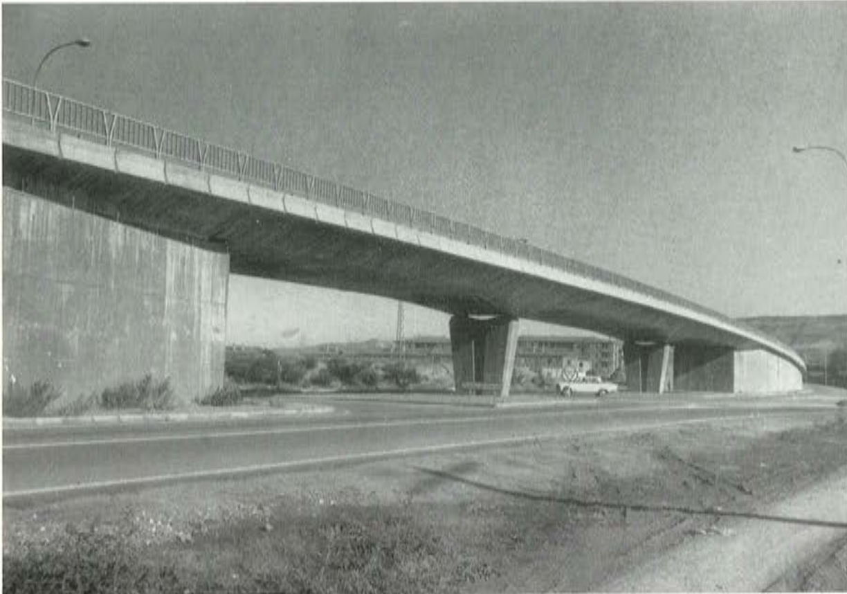
Fig. 39. Paso elevado de la CN-II en Guadalajara.
