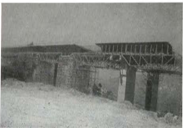
Fig. 11.—Traslado del encofrado lateral del tablero.
