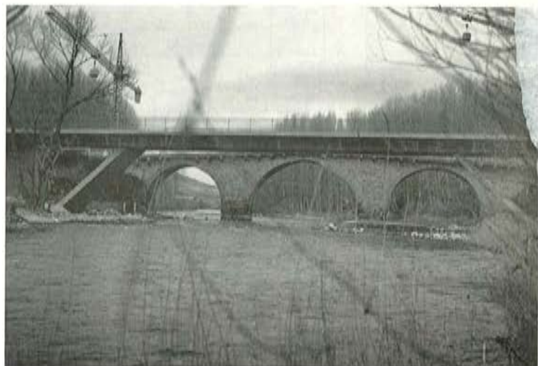
Fig. 9. Puente de Lumbier, Vista general.
