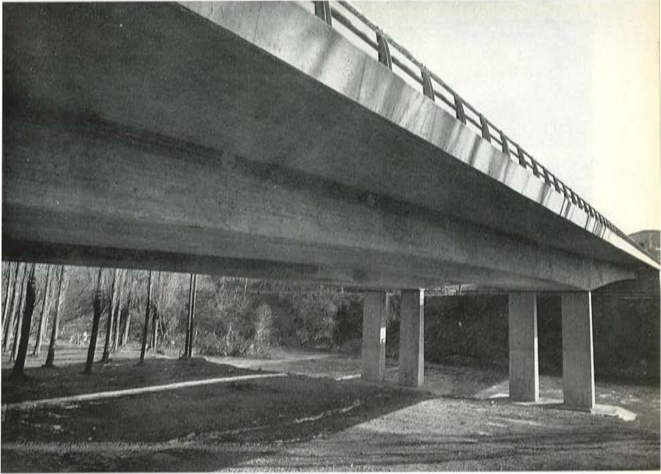
Fig. 20. Puente de San Jorge sobre el río Arga, en la Variante de Pamplona.
