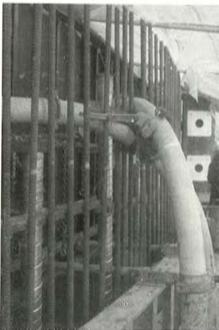
Foto 5. Disposición de las tuberías de las bombas para hormigonado de las paredes. Se pueden ver las vainas verticales.
