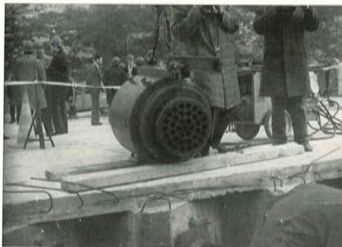
Foto 40. Tesado de tendones 37 T 15 en el puente de la autopista Marsella-Niza (Francia). Sistema Freyssinet. Los anclajes y gatos son los mismos que se usan en la Central Nuclear de Ascó. Gato dispuesto para colocarse
