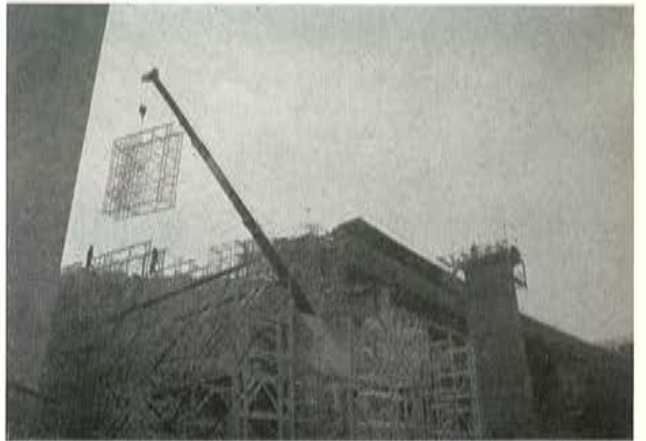
Fig. 10.—Traslado y montaje en nueva posición de elementos de las torres tubulares provisionales.
