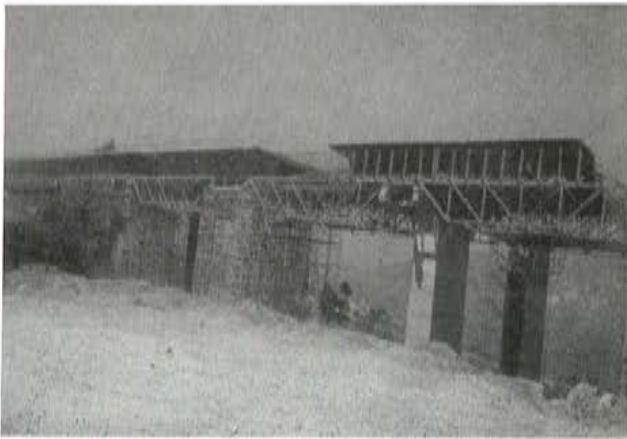
Fig. 11.—Traslado del encofrado lateral del tablero.
