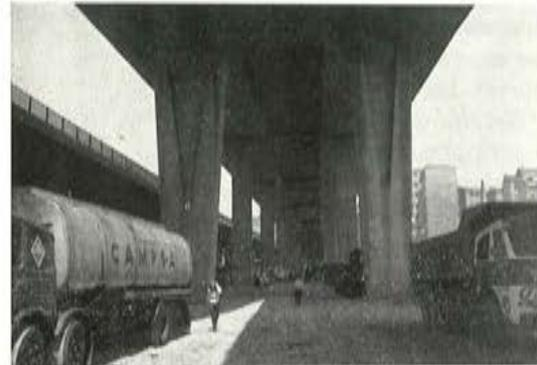
Para el caso de junta en los ramales con doble apoyo, la solución es la misma, pero con tratamiento singular desde el arranque de la pila (figs. 11, 12 y 13).
