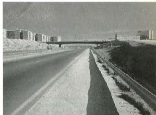
La solución que se adoptó en el proyecto fue la de una estructura de 3 vanos compensados con una luz central impuesta por la autopista inferior de 47 m y 2 laterales de 17 m cada uno.
