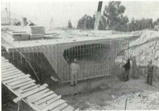
Fig. 16.—Tablero terminado en la zona de un estribo.
