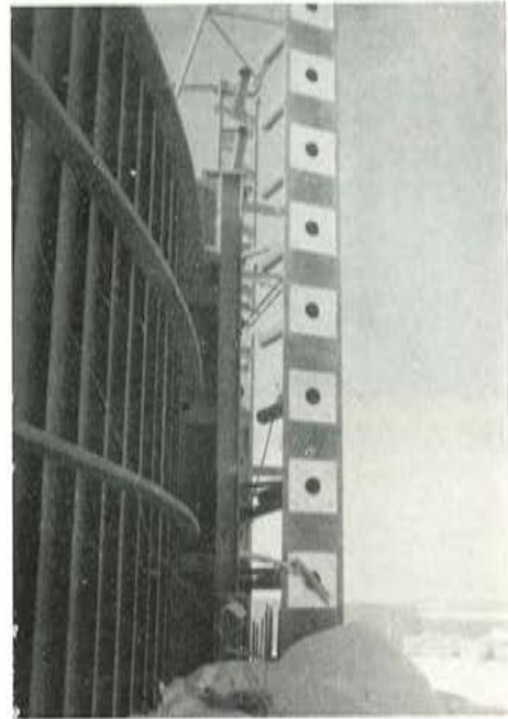
Foto 13. Montaje de las placas de anclaje en los contrafuerzas.
