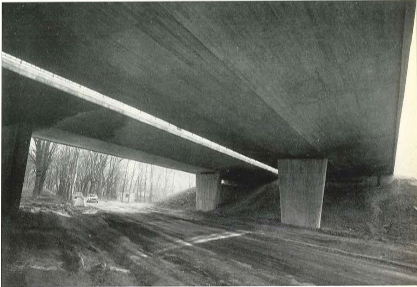
Fig. 33. Viaducto del Sadar, Detalle del intradós. (Variante Oeste de Pamplona).
