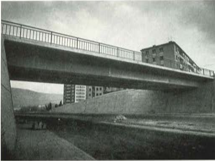
Fig. 22. Puente de San Juan. Variante Oeste de Pamplona.
