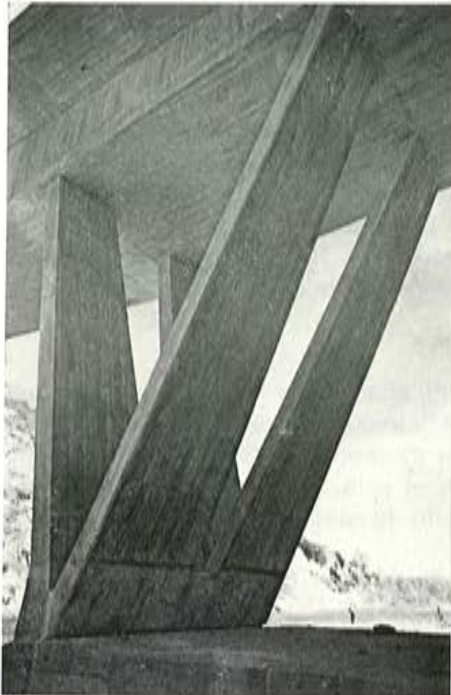
Fig. 3. Puente de Boltaña. Detalle de la célula triangular del pórtico.
