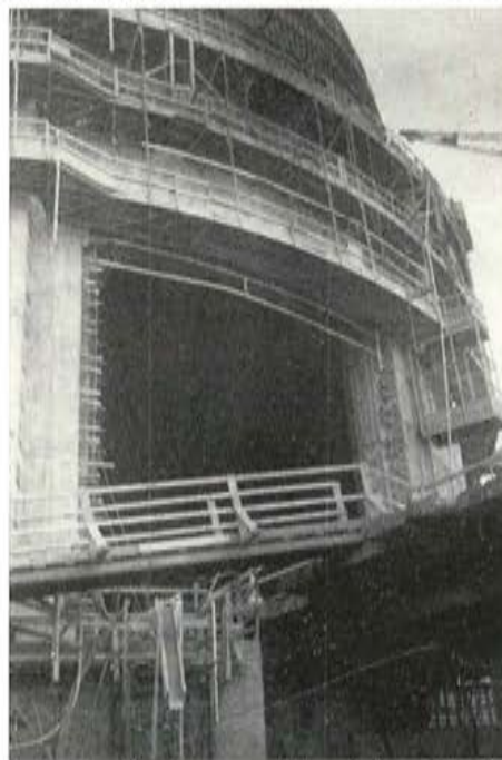
Foto 2. Abertura provisional de entrada de equipo.
