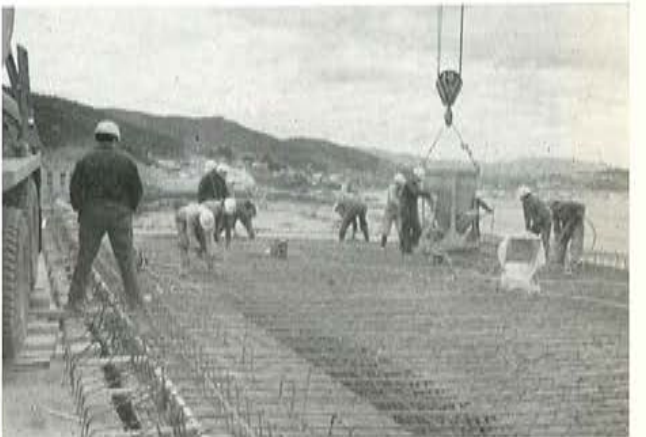
Fig. 14.—Hormigonado del tablero.
