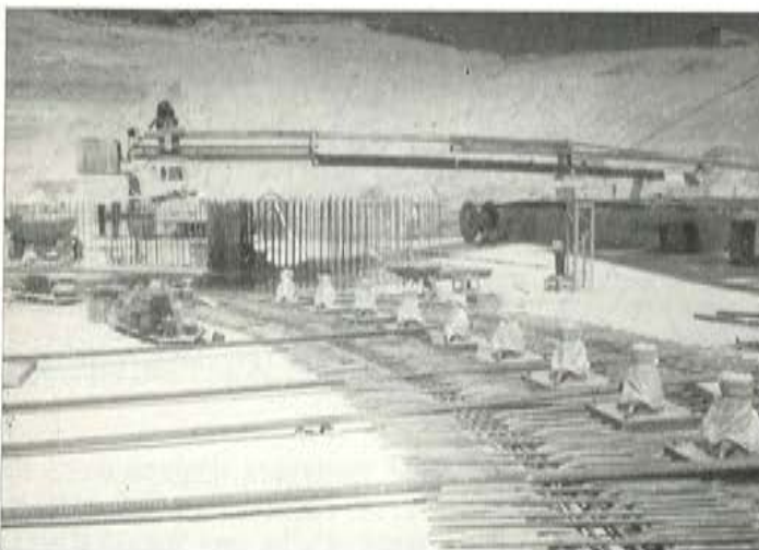
Foto 19. Placas de anclaje y trompetas ya colocadas
