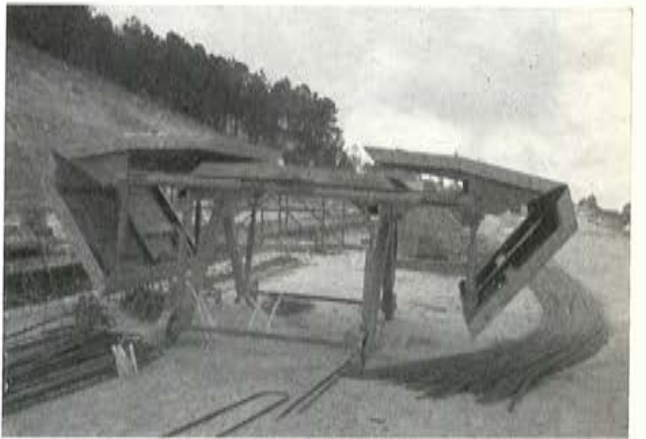
Fig. 12.—Elemento del encofrado interior del tablero.
