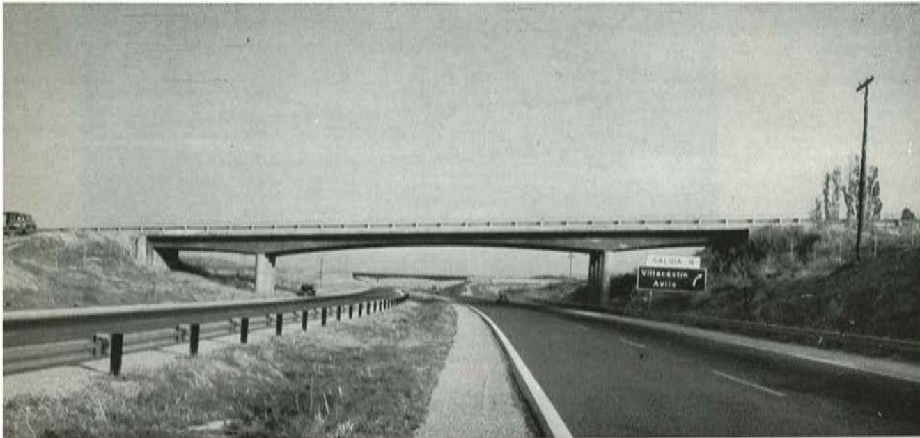
Para evitar el incremento en carga permanente que supondría el hormigón de bombeo el propio tablero lleva la inclinación necesaria para formar el peralte.
