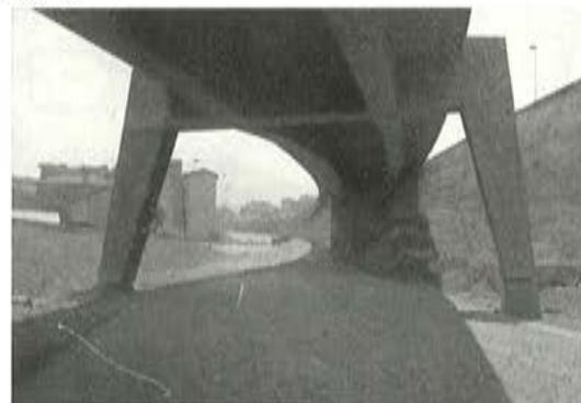
Completa la obra la estructura T52, de luces superiores a las anteriores, con tramos centrales de 41 m y laterales de 28 m con pila pórtico en el centro. En este caso la sección transversal es doble nervio en  $\pi$  más que losa nervada y con sección variable de 2,40 en apoyos de 1,40 en centro de vano (fig. 15).
