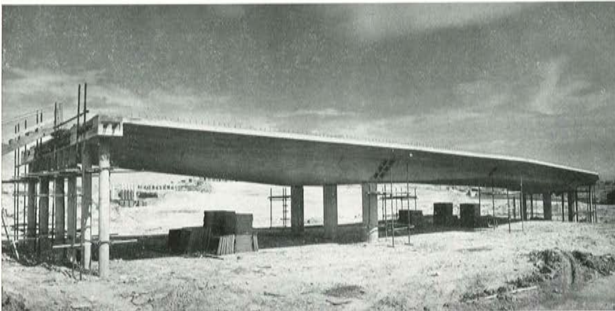
Fig. 6. Nudo de Manoteras. Aspecto de la obra
