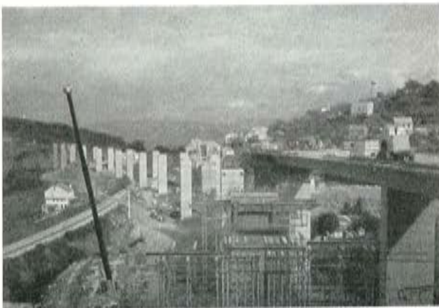
Fig. 17.—Vista de las obras en el acceso sur.
