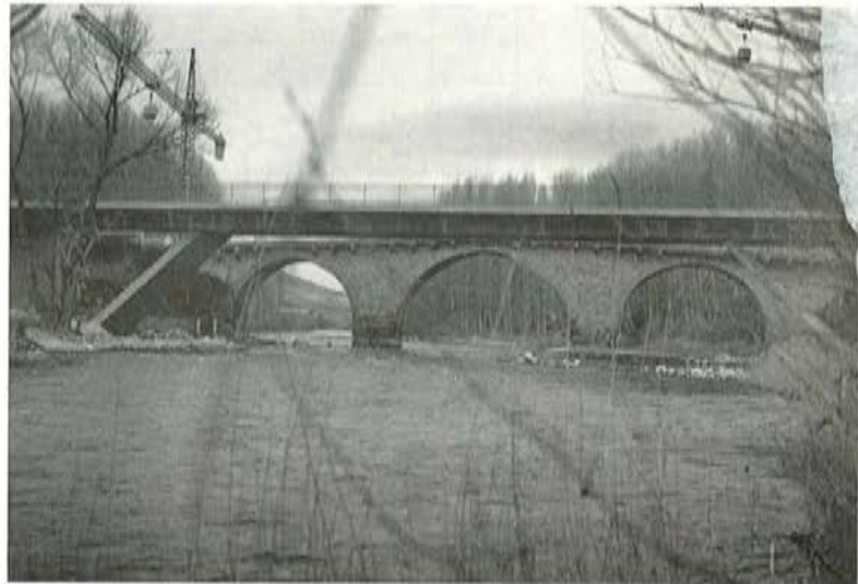
Fig. 9. Puente de Lumbier, Vista general.
