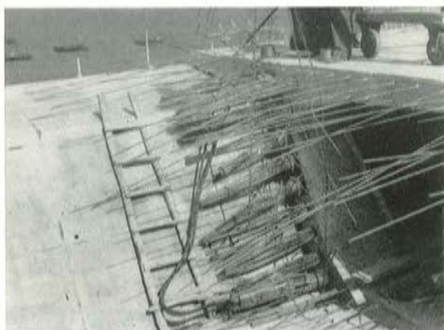
Fig. 15.—Pretensado del tablero.
