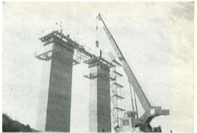
Fig. 8.—Hormigonado mediante encofrados deslizantes de las pilas.
