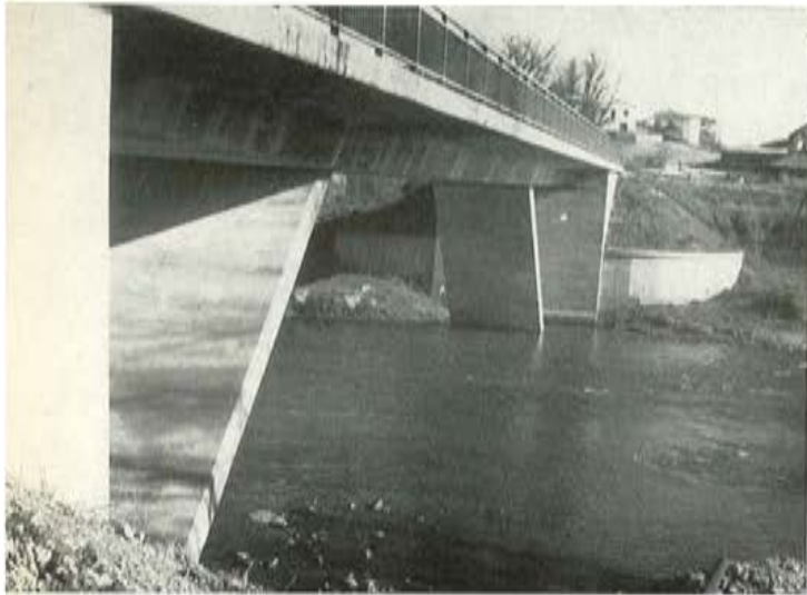
Fig. 8. Puente de Lumbier, Detalle.
