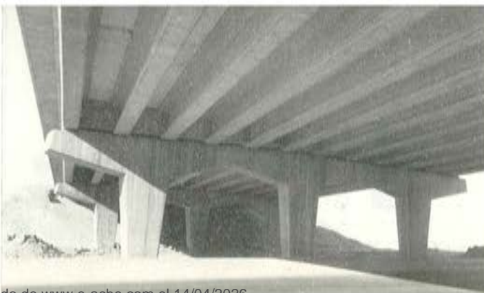
Fig. 42. Puente de Hortaleza. Vista Interior.
