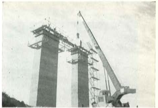
Fig. 8.—Hormigonado mediante encofrados deslizantes de las pilas.
