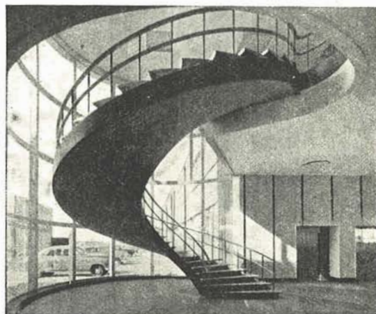
Fig. 4.—Escalera helicoidal, en hormigón pretensado, construida en Antwerp (Bélgica) por la General Motors Continental. Tiene 5,23 m. de altura y se apoya únicamente en sus extremos superior e inferior.
