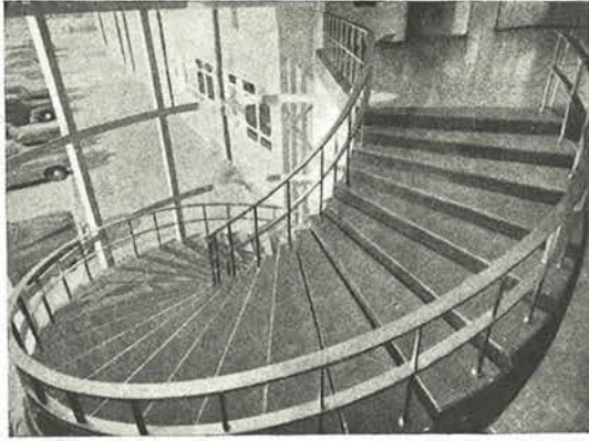
Fig. 10.—Las huellas de los escalones, de acero inoxidable y el pasamanos de bronce apoyado sobre barras verticales también de acero inoxidable, contribuyen a realzar el bello aspecto de esta audaz estructura.
