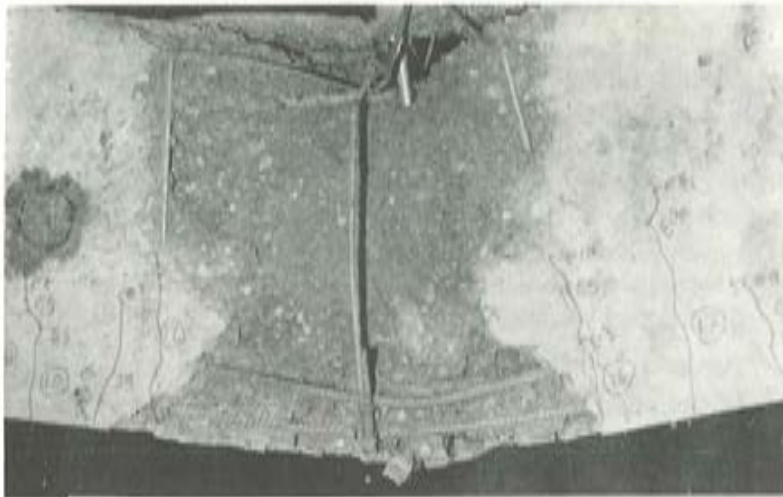
FOT. 2.-V2-NA. Rotura
