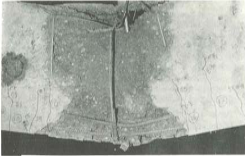
FOT. 2.-V2-NA. Rotura
