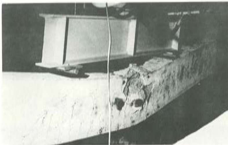
FOT. 8.-V1-NM, Rotura
