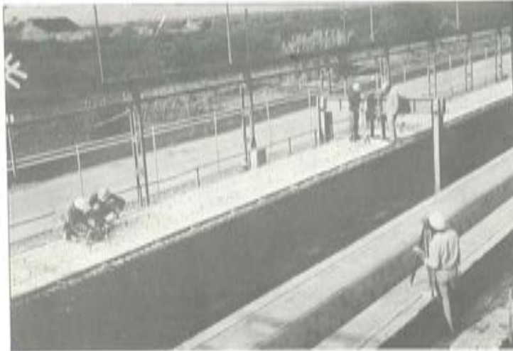
Control en taller de vigas pretensadas
