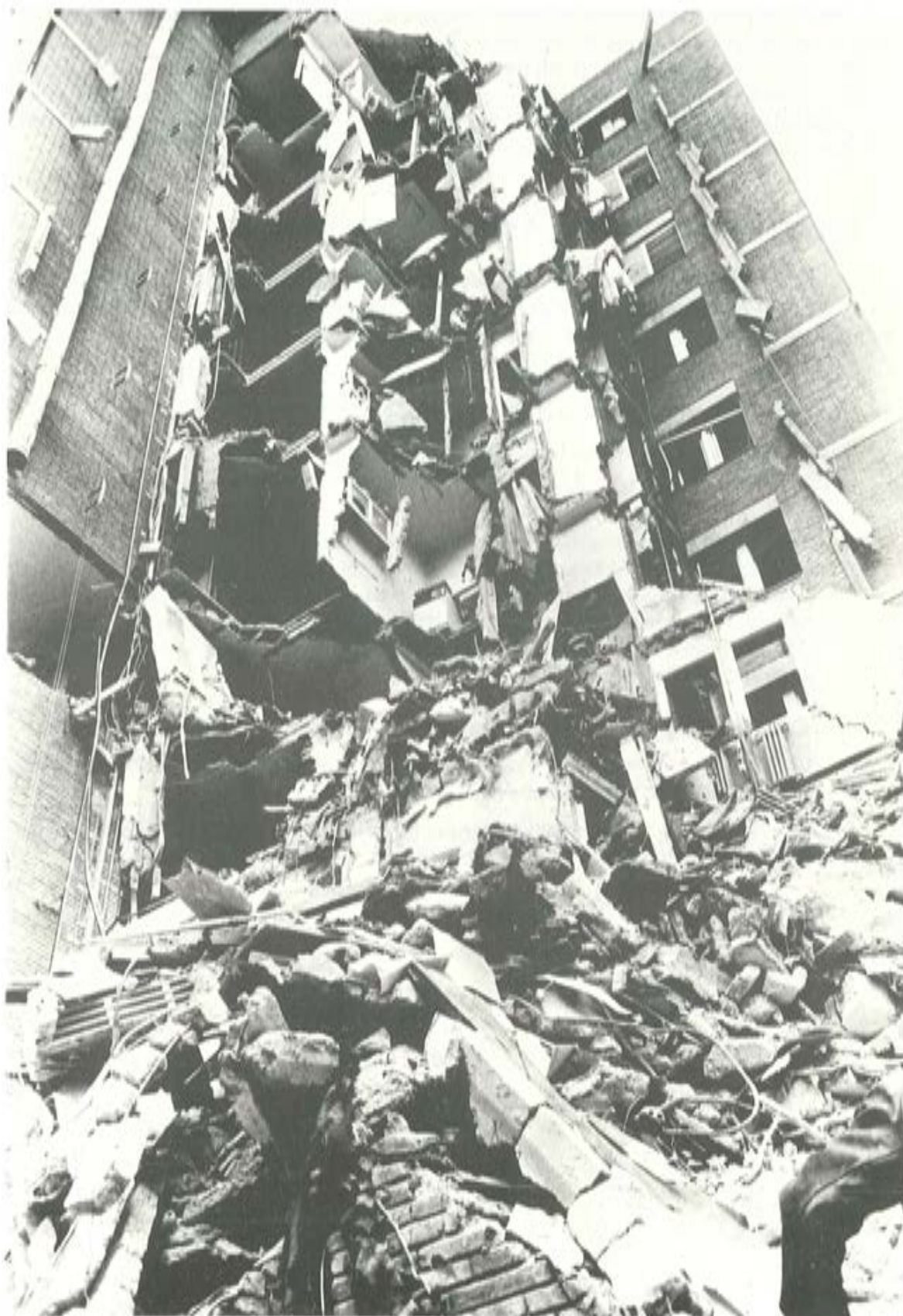
Fotografía núm. 1.—Colapso de esquina, edificio calle Capitán Arenas en Barcelona (marzo, 1972). Fotografía de archivo del diario "La Vanguardia" cedida al I.E.T. para su publicación en Hormigón y Acero.
