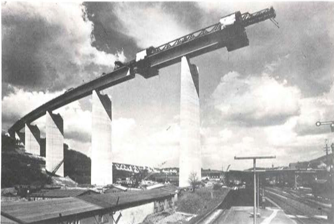
FIG. 16. Viaducto del Valle del Sieg. Detalle del proceso constructivo.
