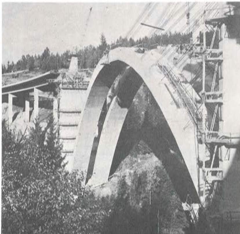
FIG. 6. Puente Niesenbach. Arcos terminados
