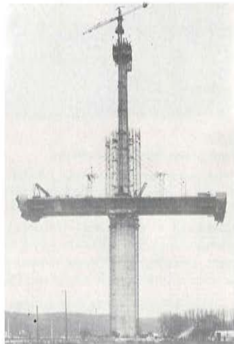
FIG. 5 Puente de Brotonne. Detalle del proceso constructivo.
