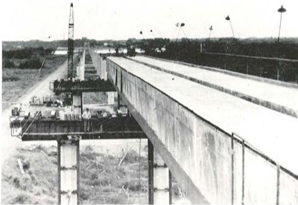
FOTO 4 Traslado de la cimbra corrediza durante la construcción del viaducto argentino.
