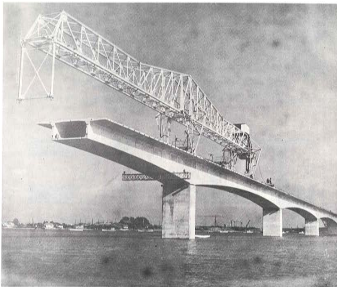
FIG. 24. Puente de Olerón. Viga auxiliar de montaje de dovelas.
