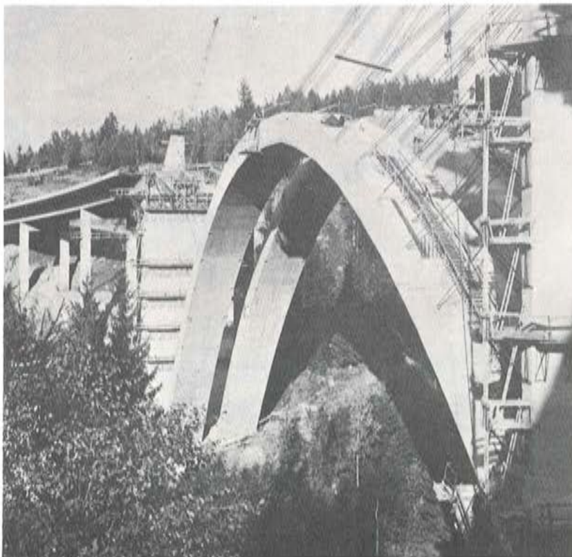
FIG. 6. Puente Niesenbach. Arcos terminados
