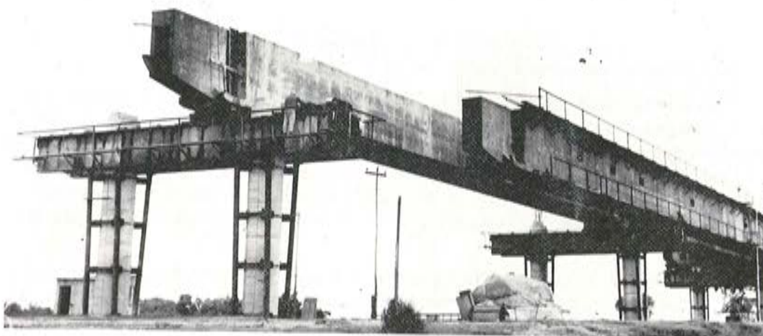
FOTO 2 Traslado de la cimbra corrediza. Una de las vigas cajón ha alcanzado ya la pila siguiente; la otra está avanzando en voladizo.
