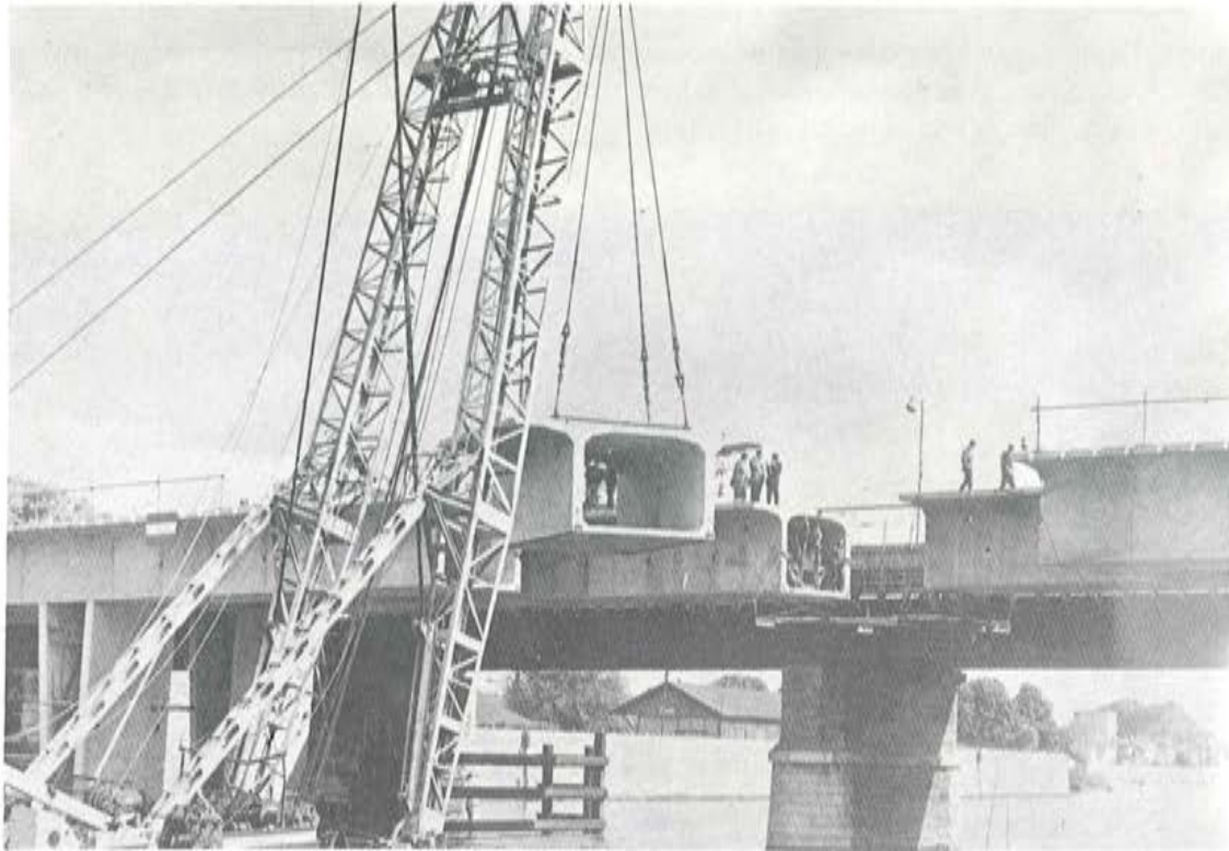
FIG. 19. Puente de Choisy Le Roi sobre el Sena. Primer empleo de dovelas encoladas con juntas conjugadas.
