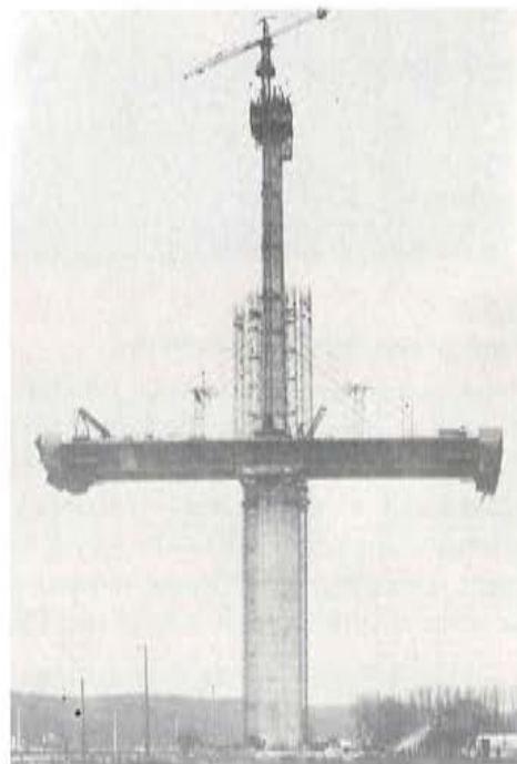
FIG. 5 Puente de Brotonne. Detalle del proceso constructivo.
