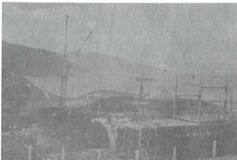
Central Nuclear de Lemóniz. Vista general de la obra en Noviembre 1976
