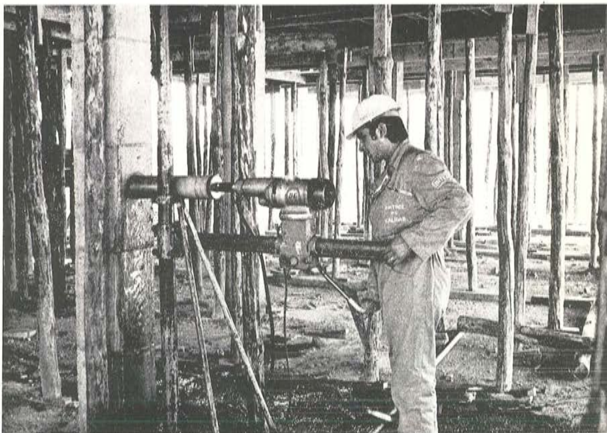
Extracción de probetas testigo de hormigón endurecido
