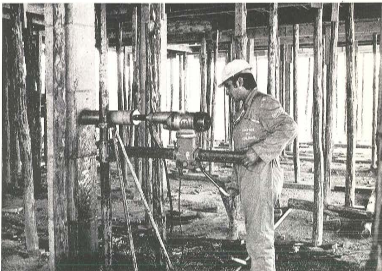
Extracción de probetas testigo de hormigón endurecido
