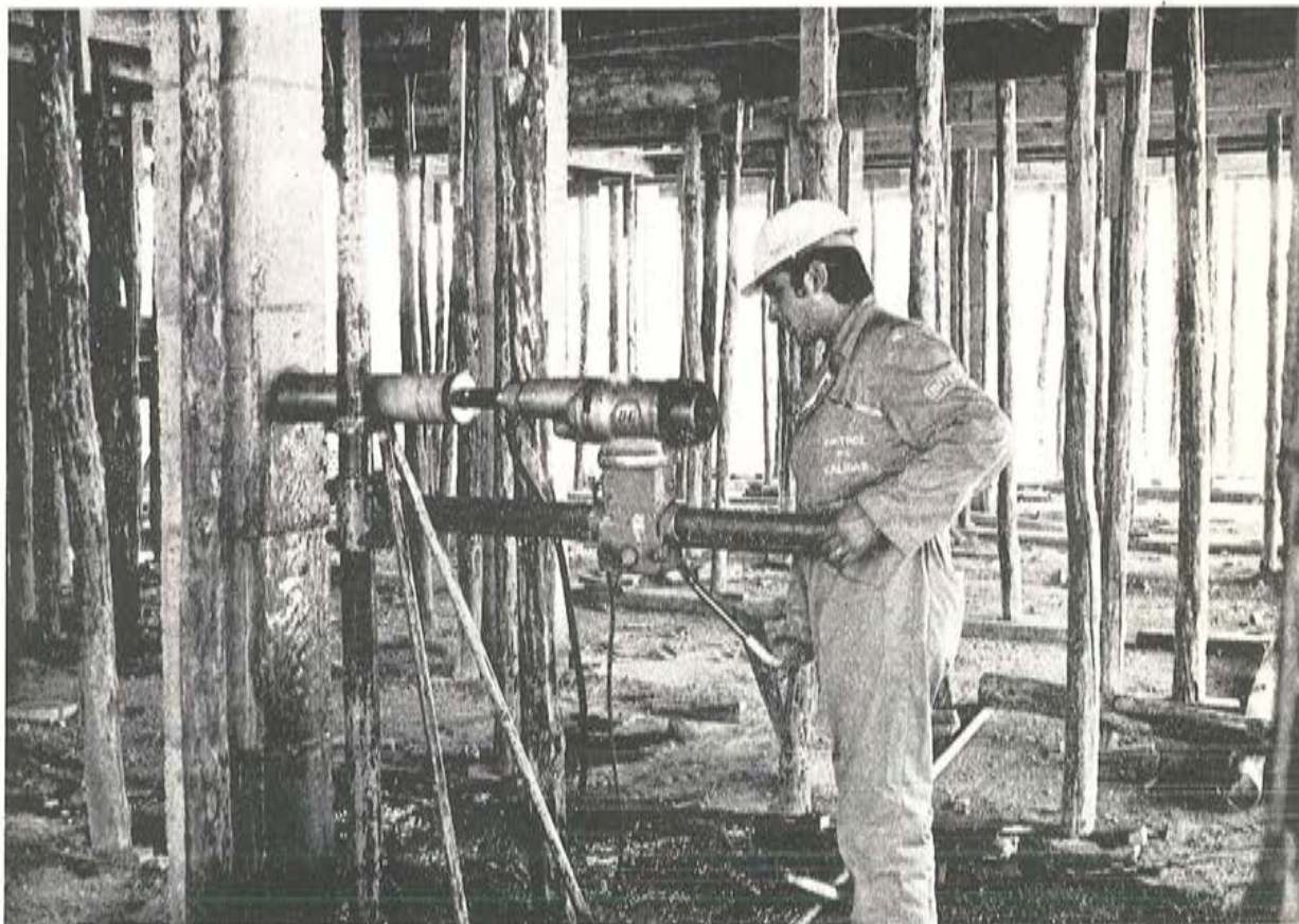
Extracción de probetas testigo de hormigón endurecido
