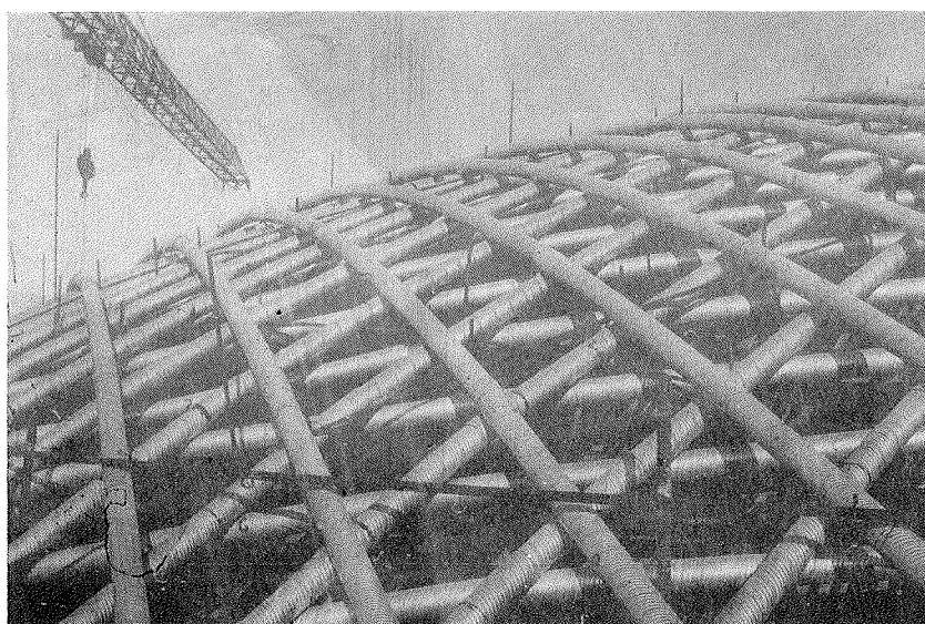
Central Nuclear de Lemóniz. Detalle vainas en cúpula
