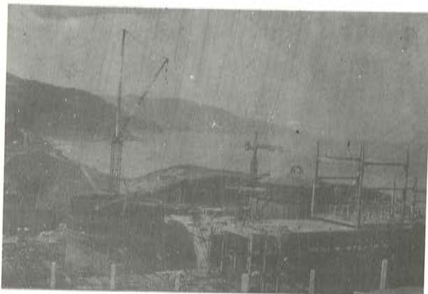
Central Nuclear de Lemóniz. Vista general de la obra en Noviembre 1976
