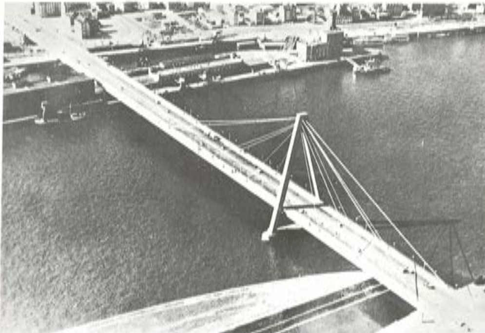
Fig. 2.—Puente de St. Severin.
