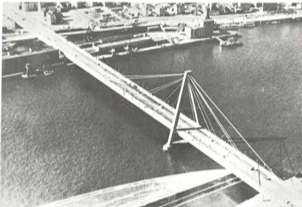
Fig. 2.—Puente de St. Severin.
