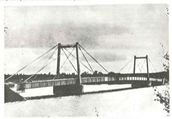
Fig. 1.—STROMSUND: 1er puente atirantado moderno.
