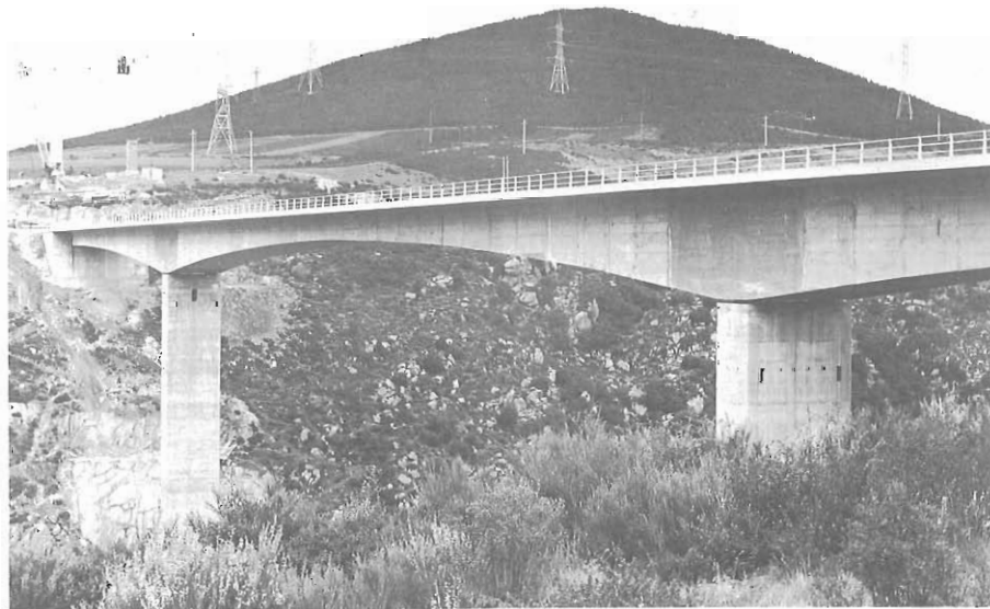
Fig. 18.8 Puente del Azufre. Vista del puente terminado.
