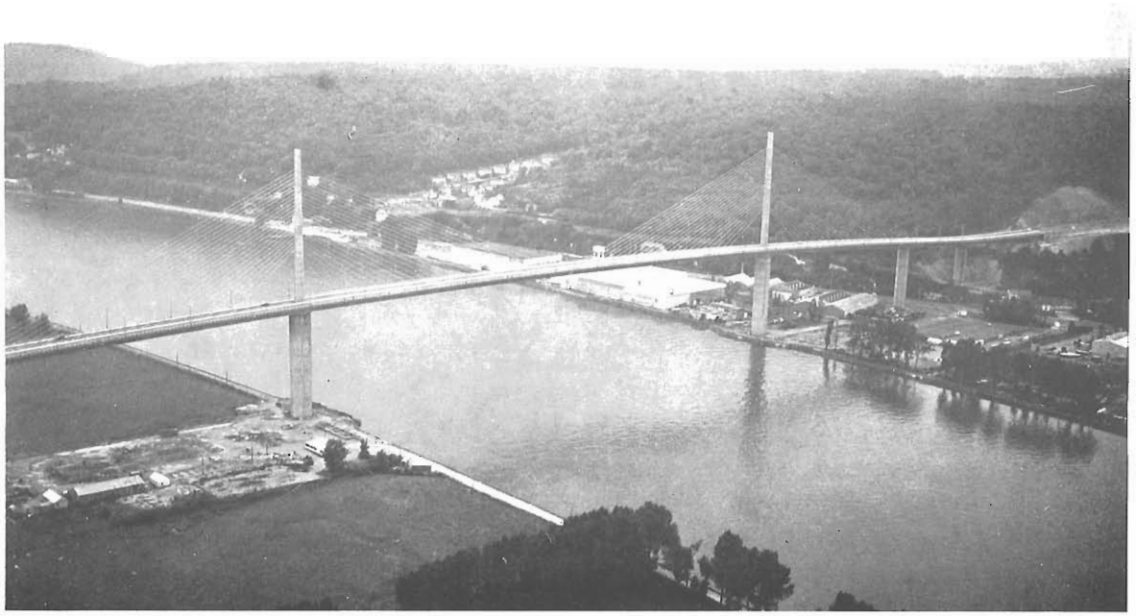
Fig. 1.2 Puente de Brotonne. Vista general.
