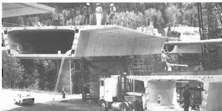
Fig. 5.3 Construcción de un puente con dovelas prefabricadas de 200 tons.
