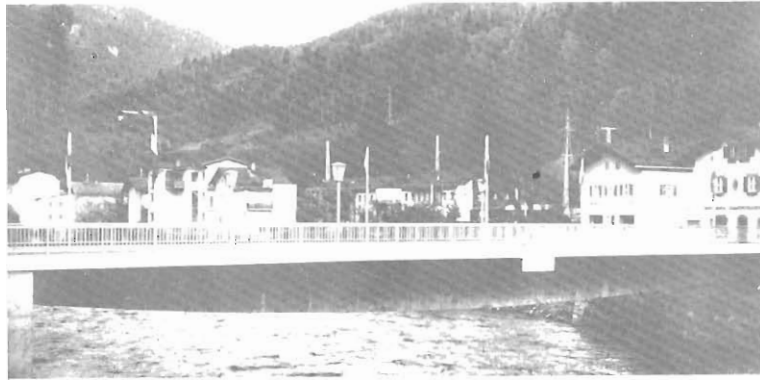
Fig. 12.4 Puente de Lech del sistema Mayreder, Krans & Co.
