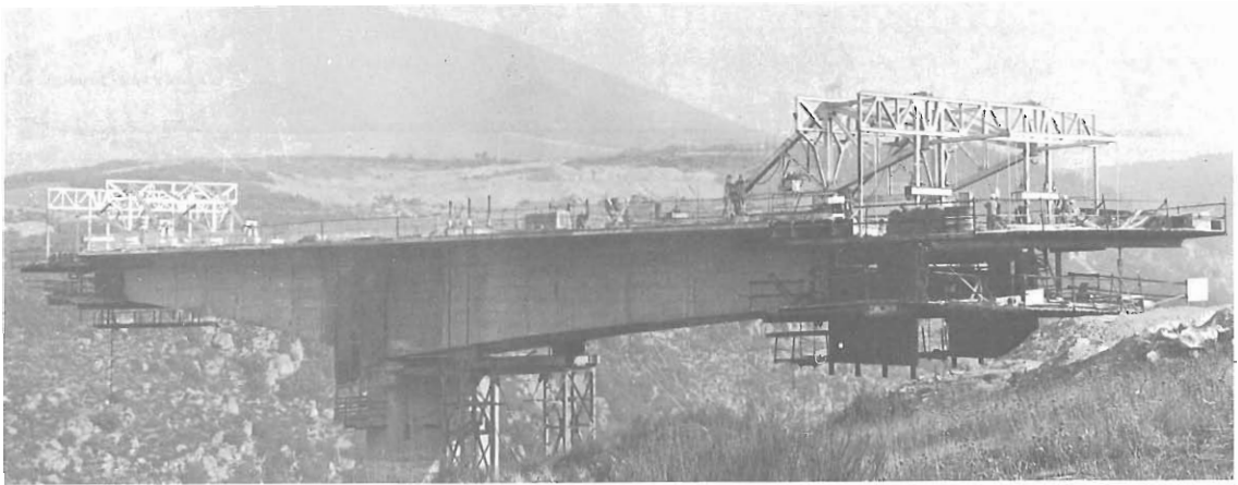
Fig. 18.7 Puente del azufre. Vista del puente durante la construcción.
