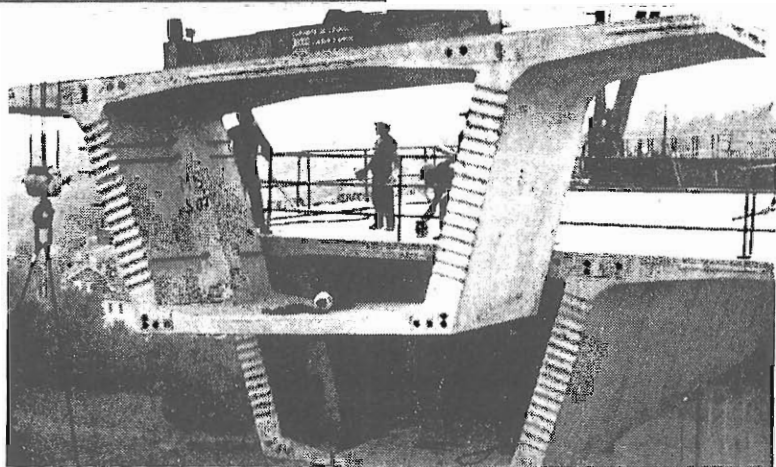
Fig. 1.12 Colocación de una dovela de sección trapecial.
