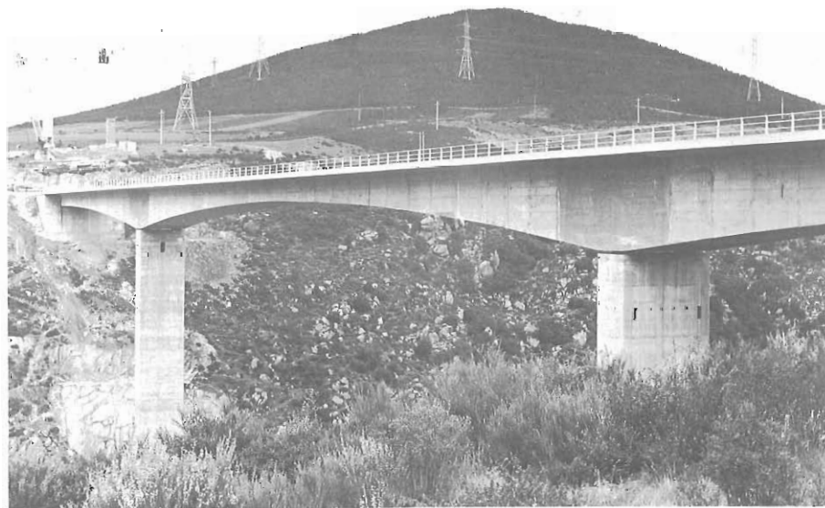
Fig. 18.8 Puente del Azufre. Vista del puente terminado.
