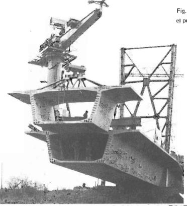
Fig. 1.11 Colocación de dovelas en el puente de Fonteno y sobre el Mosela.
