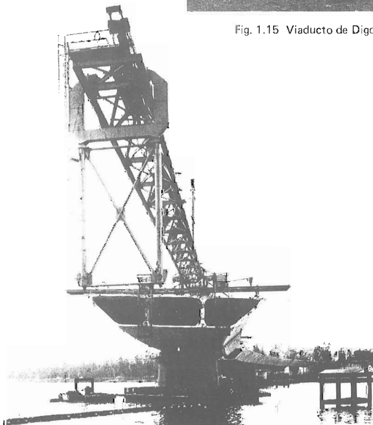
Fig. 1.16 Puente de Genevilliers. Colocación de una dovela.
