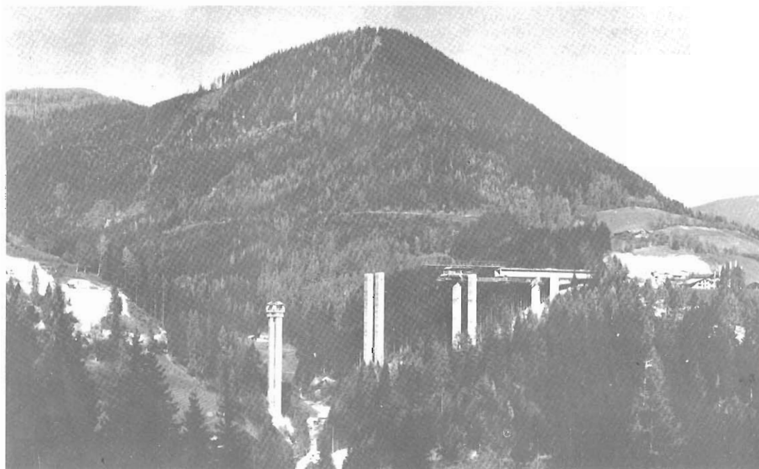
Fig. 12.5 Construcción del viaducto de Larzenbach.
