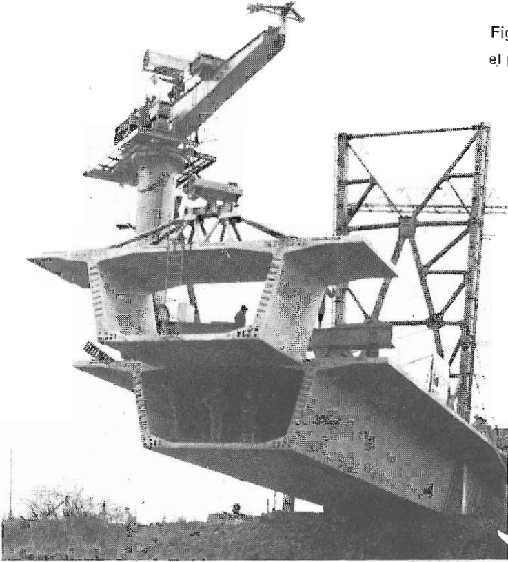
Fig. 1.12 Colocación de una dovela de sección trapecial.
