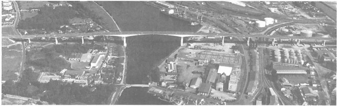
Fig. 1.14 Viaducto de Calix sobre el canal marítimo de Caen.
