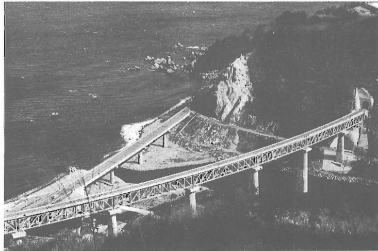
Fig. 15.5 Puente ferroviario en Akkagawa.
