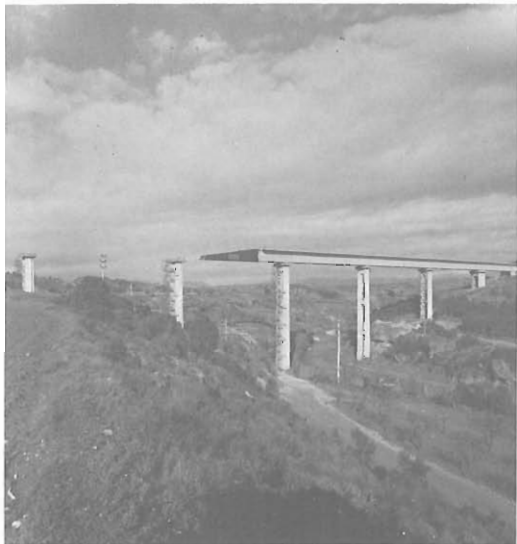
Fig. 18.11 Puente de Alcanadre. Vista del puente durante la construcción.
