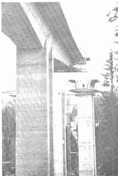
Fig. 12.6 Viaducto de Bernbach.
