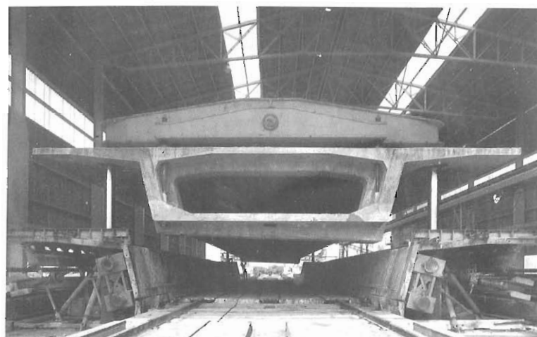
Fig. 3.14 Puente de San Severino en la autopista Caserta-Nola-Salerno. Tramo prefabricado dispuesto para colocarlo sobre los carretones de transporte.
