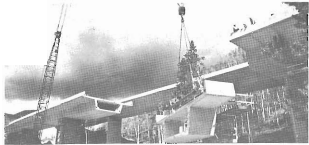
Fig. 5.2 Construcción por dovelas prefabricadas en el puente Vail Pass (Colorado).
