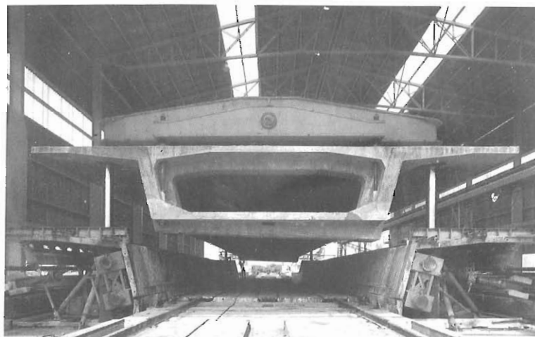
Fig. 3.14 Puente de San Severino en la autopista Caserta-Nola-Salerno. Tramo prefabricado dispuesto para colocarlo sobre los carretes de transporte.
