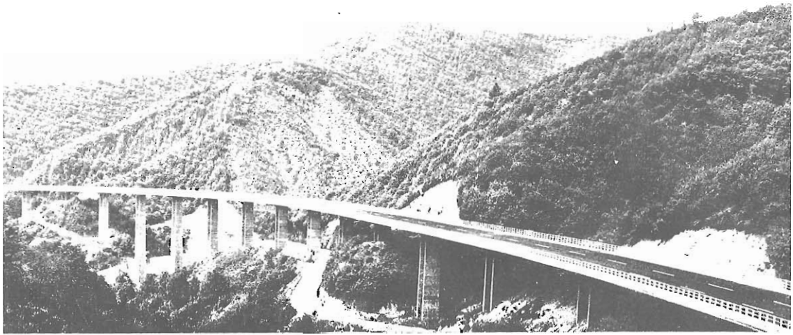
Fig. 3.7 Viaducto en la autostrada Torino Savona. Vista general.
