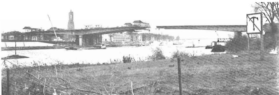
Fig. 11.2 Puente de la plaza Roermond en Arnhem.
