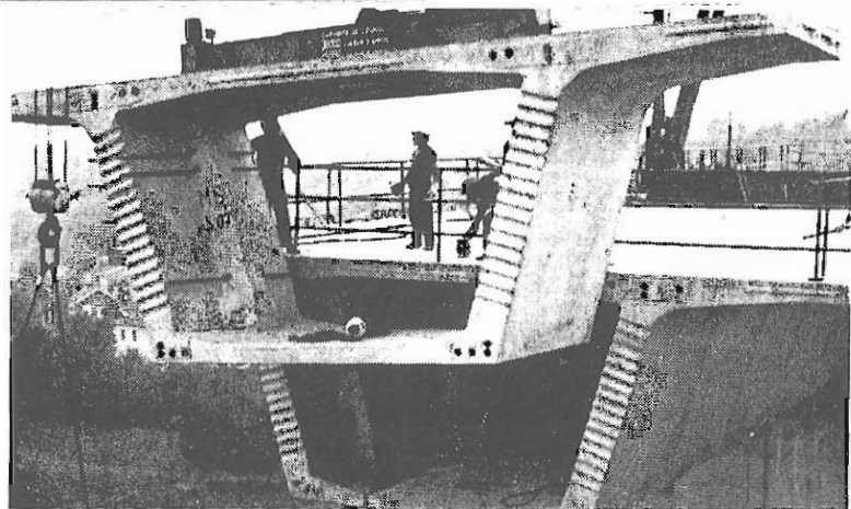
Fig. 1.12 Colocación de una dovela de sección trapecial.
