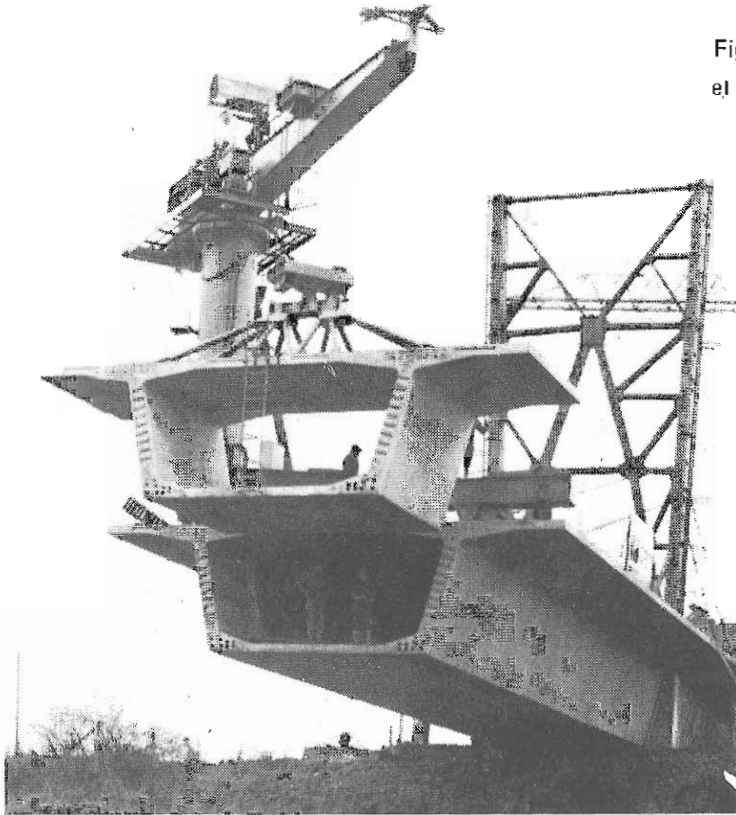
Fig. 1.12 Colocación de una dovela de sección trapecial.
