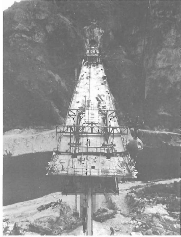
Fig. 18.10 Puente del Estrecho. Vista del tablero durante la construcción.
