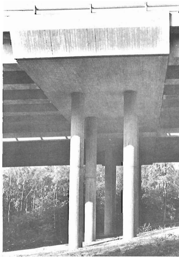
Fig. 4.2 Detalle de un apoyo del viaducto Berry Lane.
