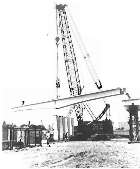
Fig. 11.5 Construcción del puente del canal Wilhelmina en Tilburg.
