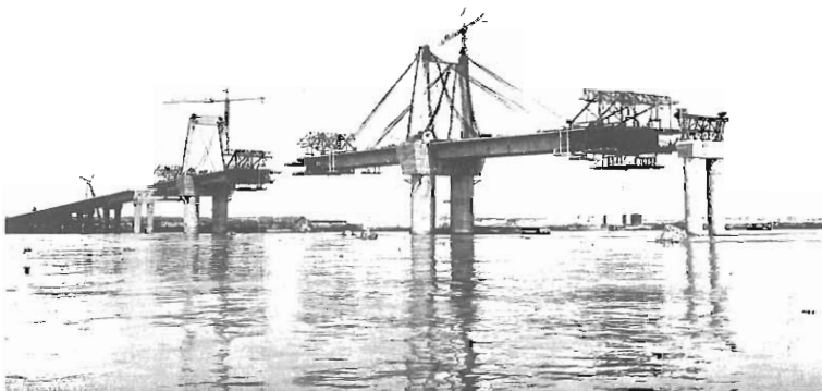
Fig. 3.13 Puente sobre el río Magdalena en Barranquilla, Colombia. Otro aspecto de la construcción.
