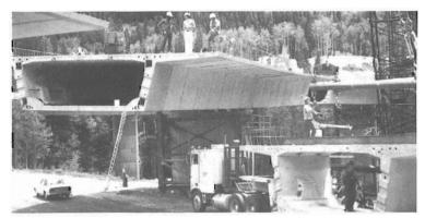
Fig. 5.3 Construcción de un puente con dovelas prefabricadas de 200 tons.
