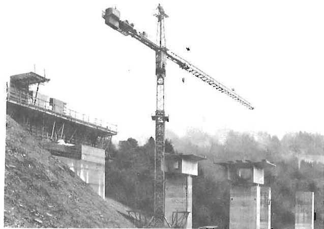
Fig. 12.3 Construcción del puente de Donnergraben.
