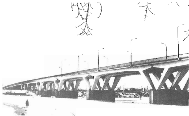
Fig. 7.3 Puente sobre el Sura en Penza. Vista general.
