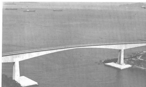
Fig. 2.10 Puente de Hiroshima 236 m. Construido por el sistema Dywidag.
