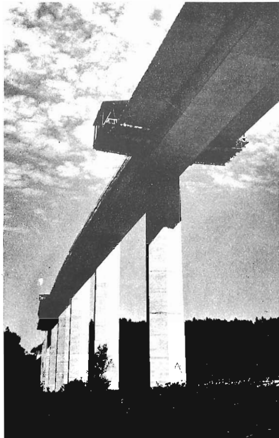
Fig. 9.3 El viaducto Saane durante construcción
