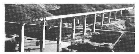
Fig. 17.8 Viaducto de los Elefantes. Construcción mediante "empujamiento".
