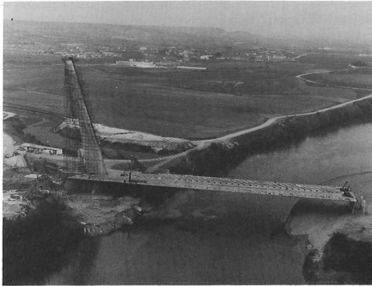
Fig. 18.1 El puente del Ebro durante la construcción.
