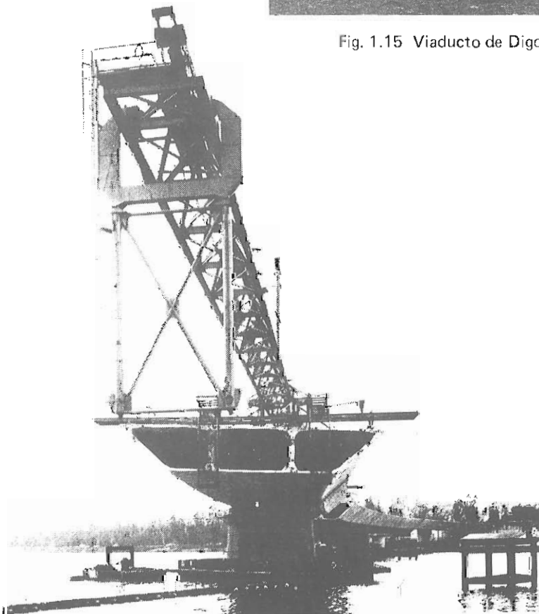
Fig. 1.16 Puente de Genevilliers. Colocación de una dovela.
