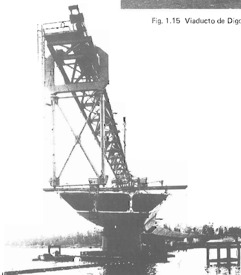
Fig. 1.16 Puente de Genevilliers. Colocación de una dovela.
