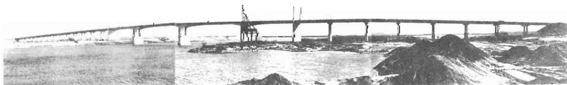
Fig. 7.1 Puente sobre el Oka en Ryazan. Vista general.
