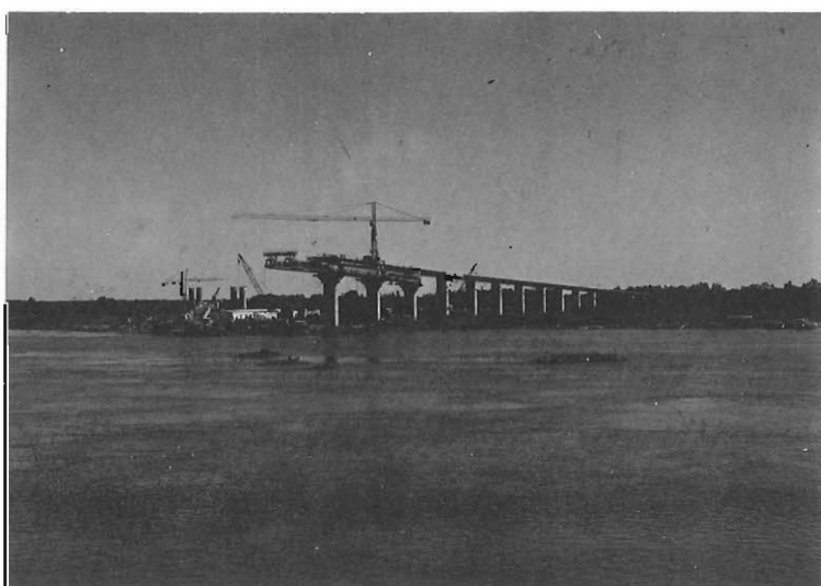
Fig. 18.15 Puente de Paraguay. Construcción de un viaducto de acceso.
