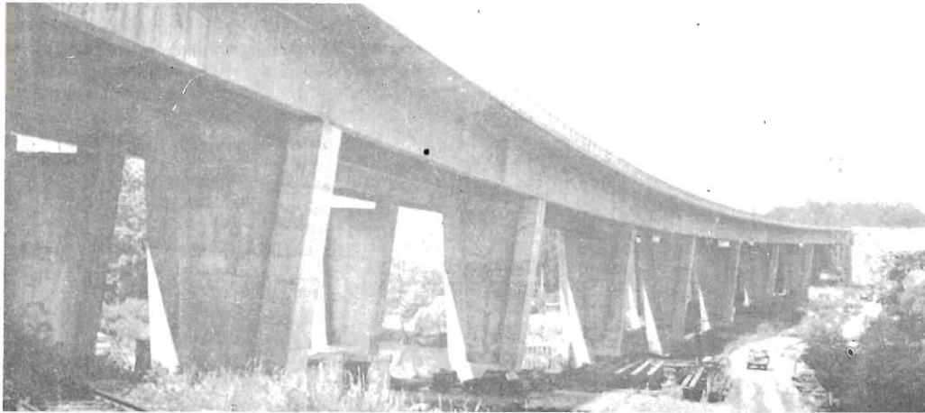
Fig. 10.4 Vista general del puente sobre el río Szava.
