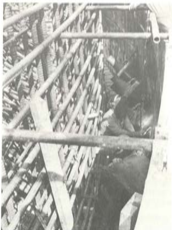
Fot. 42.— Colocación de los cajetines de los anclajes de la cúpula, sujetos al encofrado trepante.
