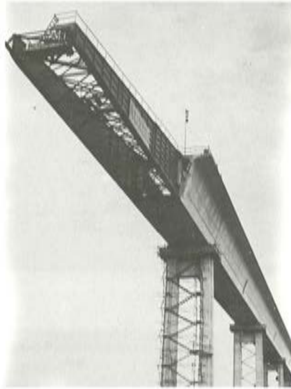
Fig. 3.— Acueducto de Alcanadre, Pico de lanzamiento.
