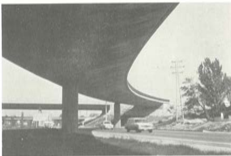
Fig. 23. Vista inferior del puente II, terminado.
