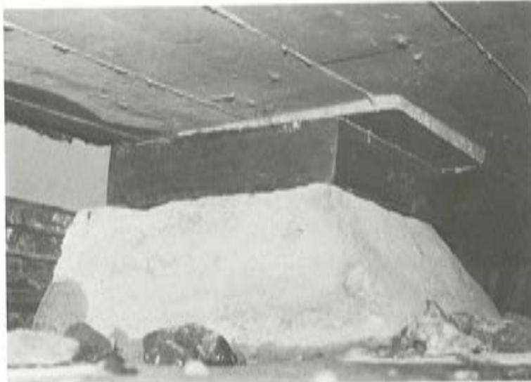
*Fig. 1. El tablero ha deslizado sobre el apoyo al estar recubierto de aceite desengrasante.*
