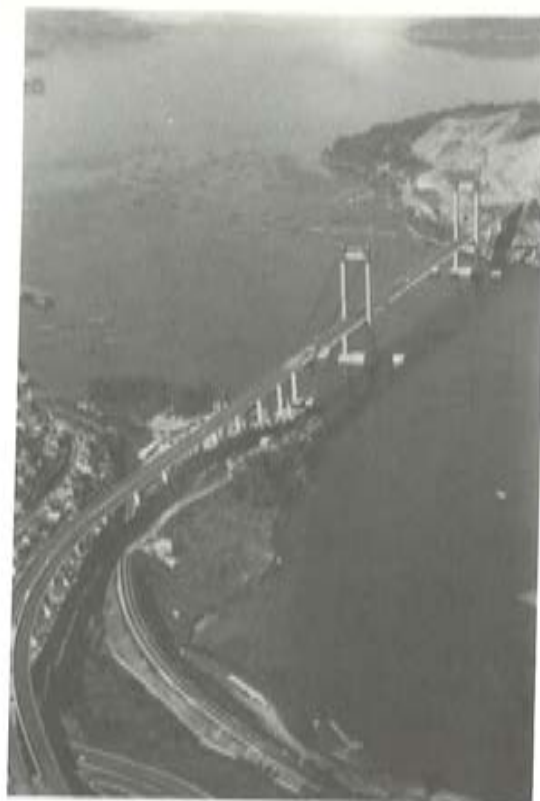
Fig. g). Vista de conjunto del puente principal y accesos.
