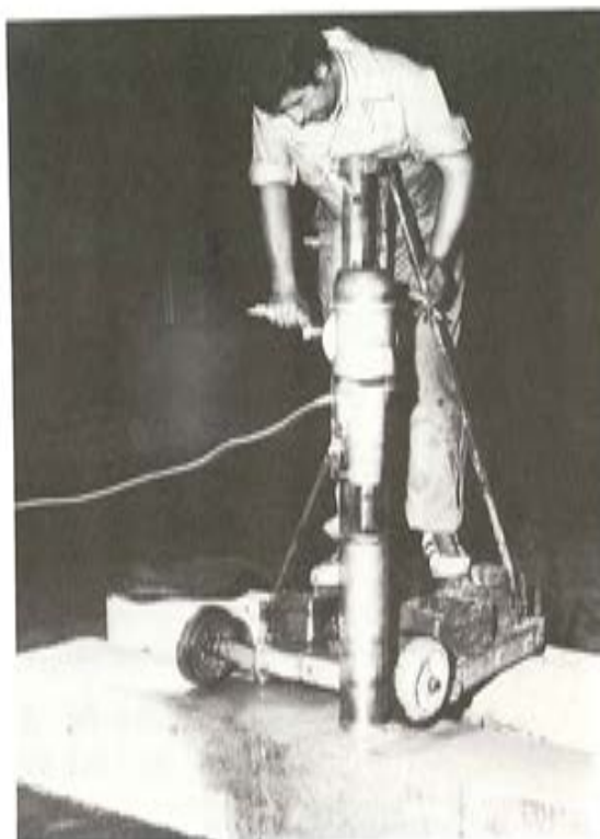
Fig. 6. Extracción del testigo
