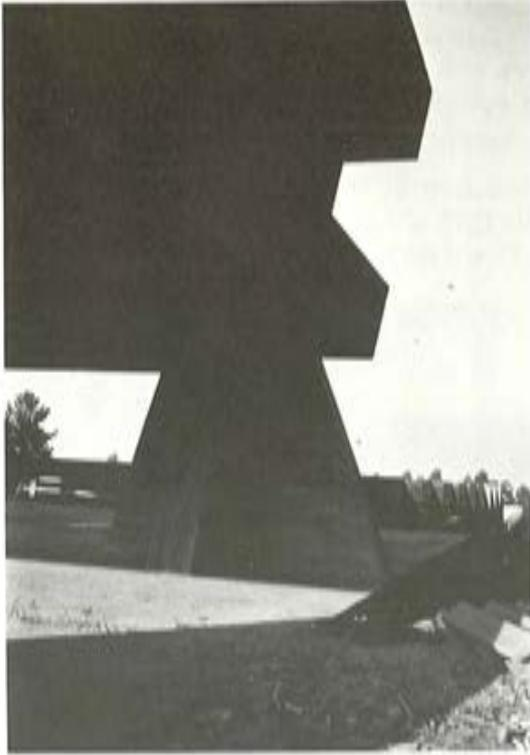
*Fig. C. Arranque de pilar de esquina.*
