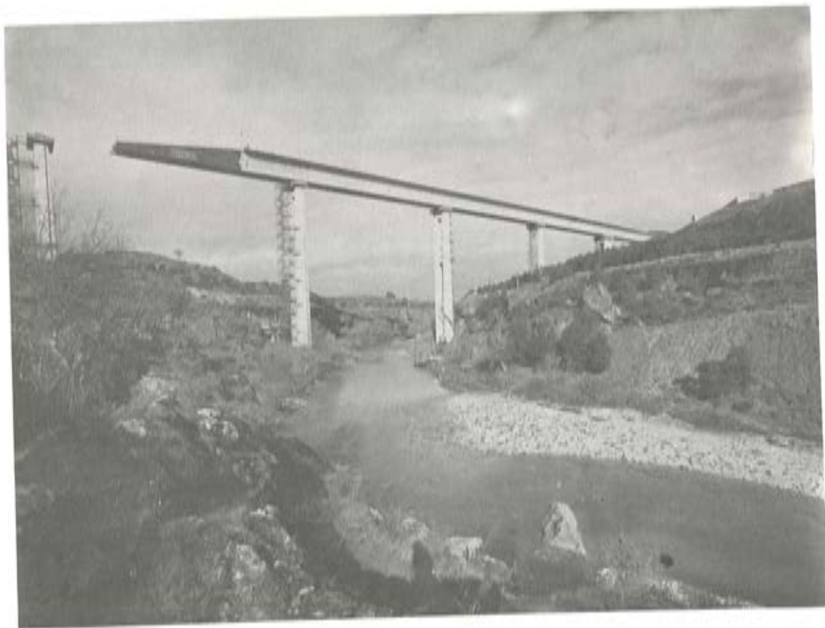
Fig. 2.— Proceso de lanzamiento.
