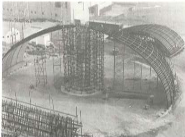
Fot. 26.— Ejecución del premontaje inicial
