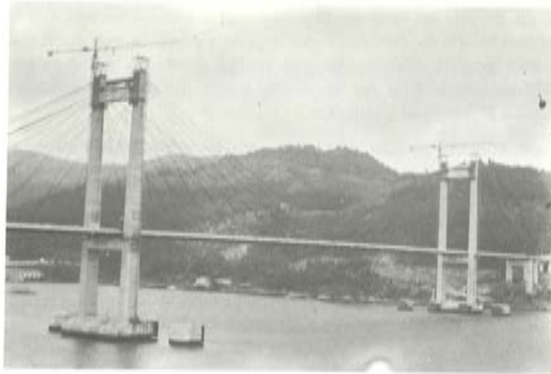
Fig. a).— Vista general del puente.
