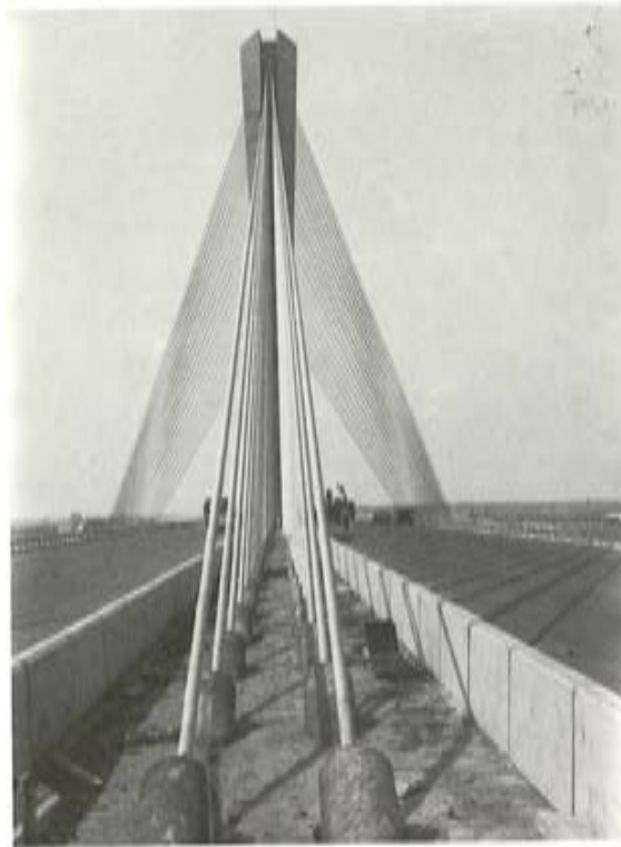
Fig. 10.— Vista de los cables desde el dintel.
