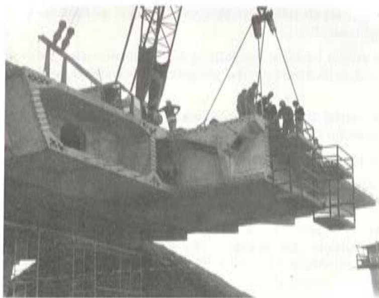
Fig. 6.— Colocación de una dovela. Puede verse el anclaje de los cables en el dintel, la triple célula del cajón y las barras Dywidag en los nudos del cajón.
