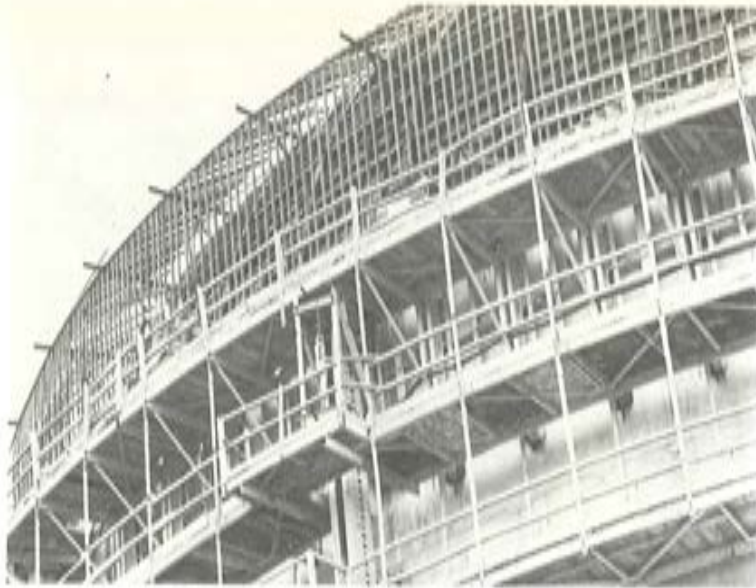
Fot. 36.— Armadura vertical de la viga anillo por debajo de los cajetines.
