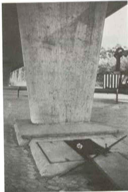
Fig. 8. Inspección de apoyos situados en la zona inferior de las pilas de un puente.
