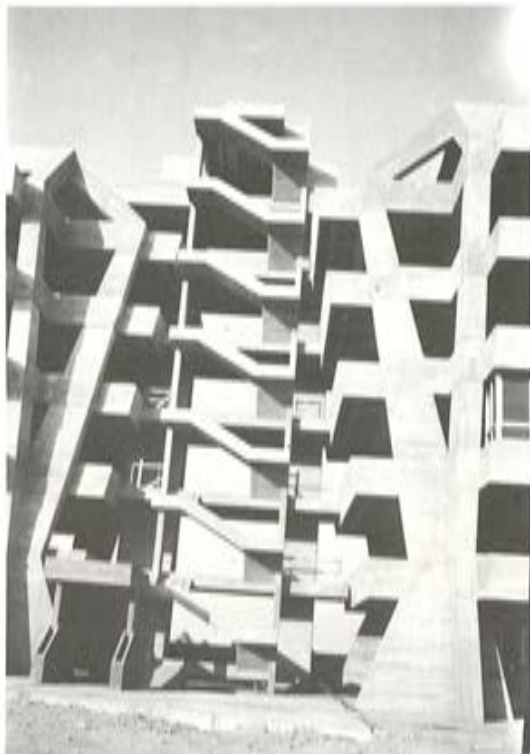
Fig. A. Escalera del edificio.
