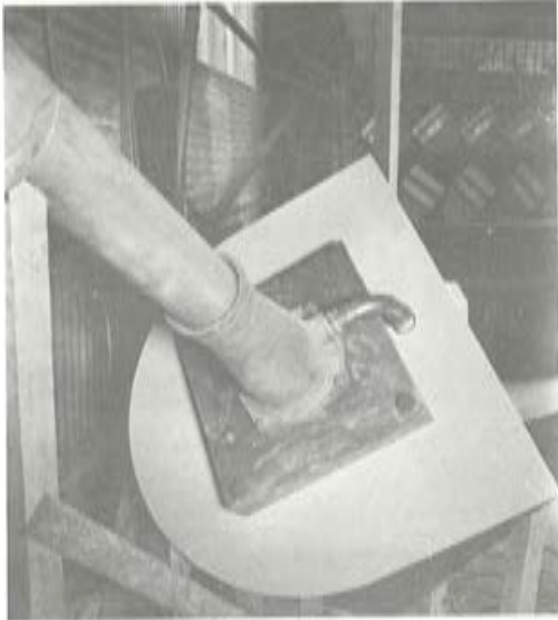
Fot. 16.— Vista del trasdós del cajetín con la placa de apoyo, trompeta y codo de inyección.
