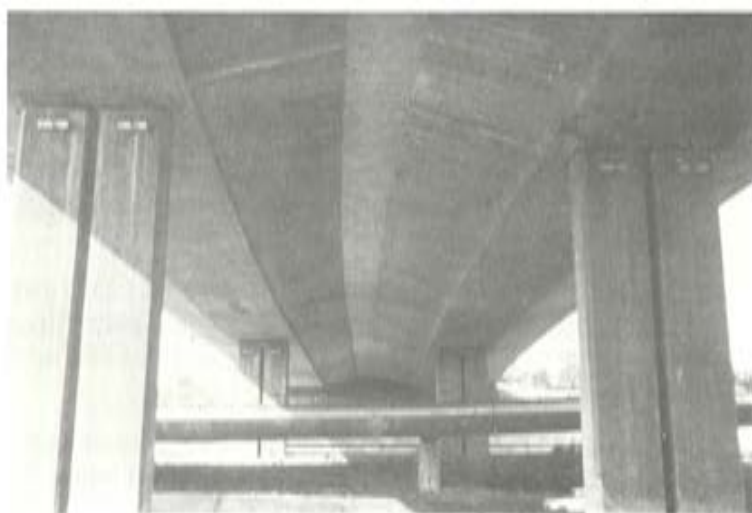
Fig. 11.— Vista inferior del puente terminado.
