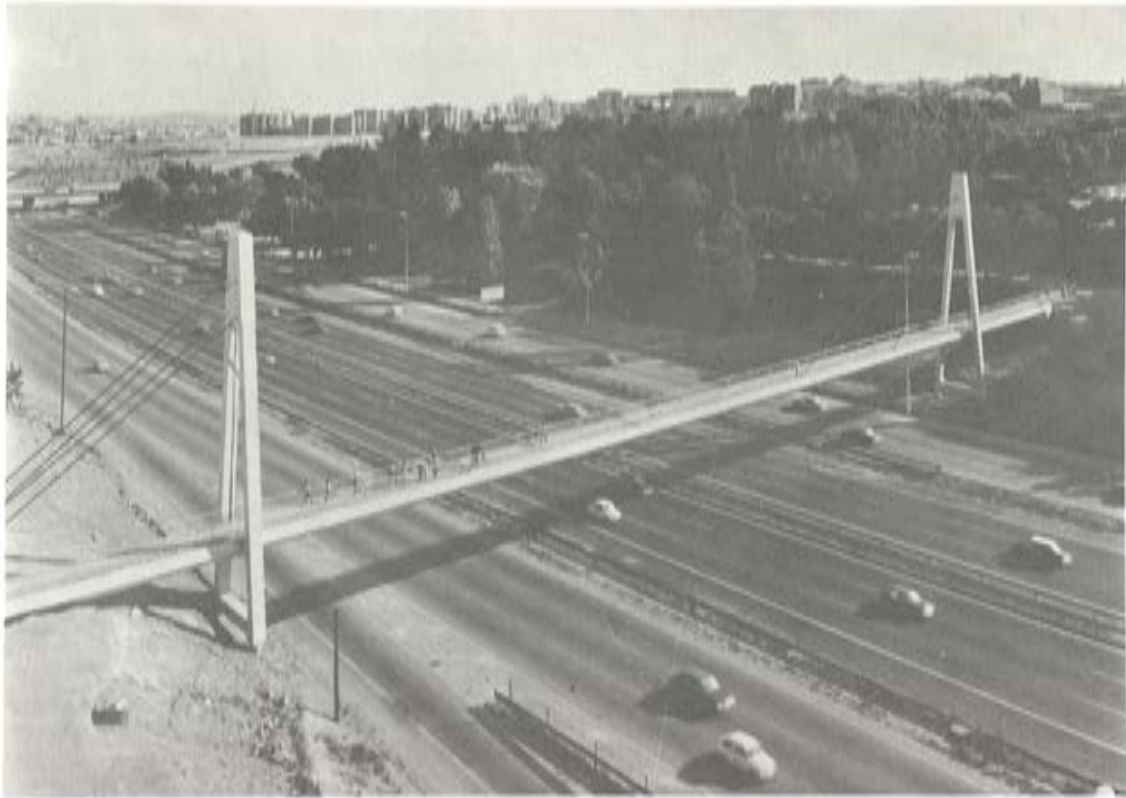
Pasarela colgada en Avenida de la Paz. (Madrid).
