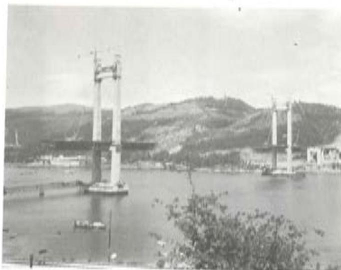
*Fig. i). Construcción por avances de tablero.*
