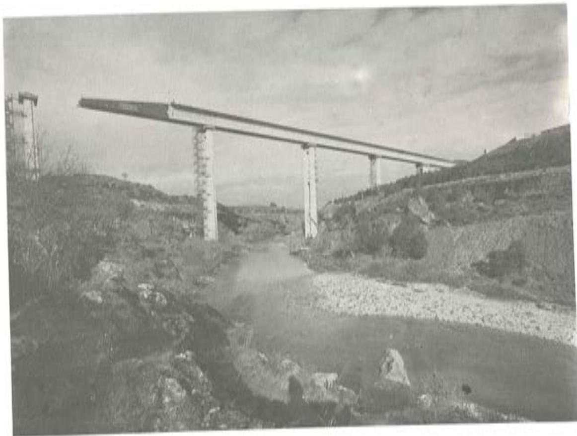
*Fig. 2.— Proceso de lanzamiento.*
