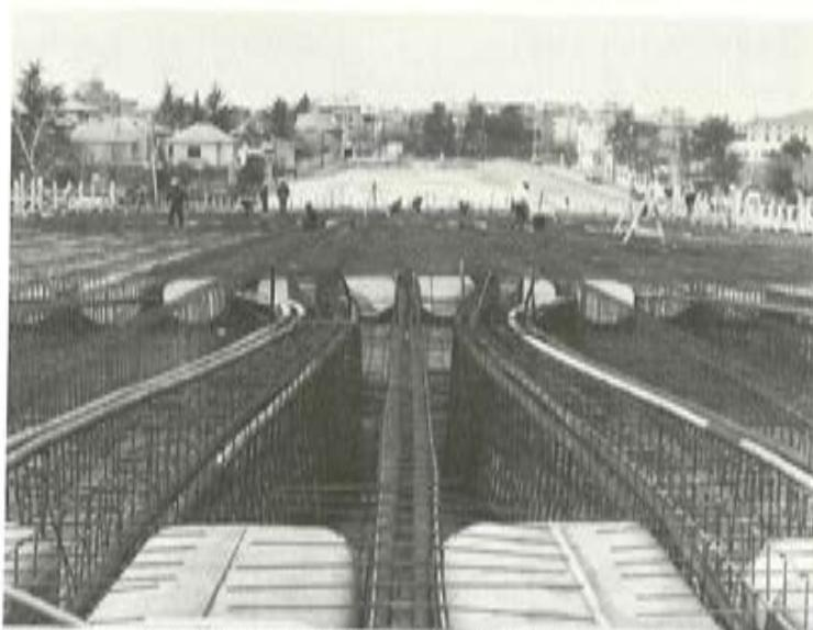
*Fig. 7.— Paso superior del Sagrado Corazón, Detalle de aligeramientos y ferralla.*
