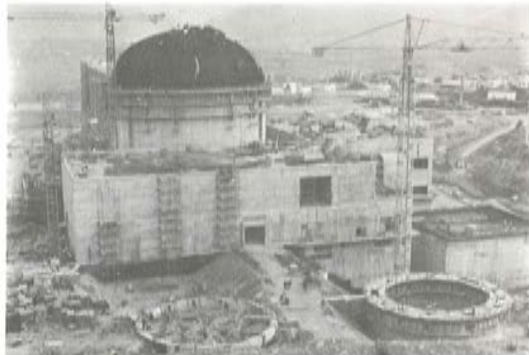
Fot. 29. – Colocación de gajos en forma compensada.
