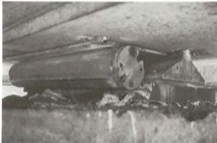
*Fig. 3. Rodillos desplazados fuera de su placa de rodamiento debido a producirse simultáneamente una dilatación máxima y asentamiento del terreno. Se hubiese podido evitar si se hubiese aplicado el Coeficiente de Seguridad Geométrico en las dimensiones de la placa de rodamiento.*
