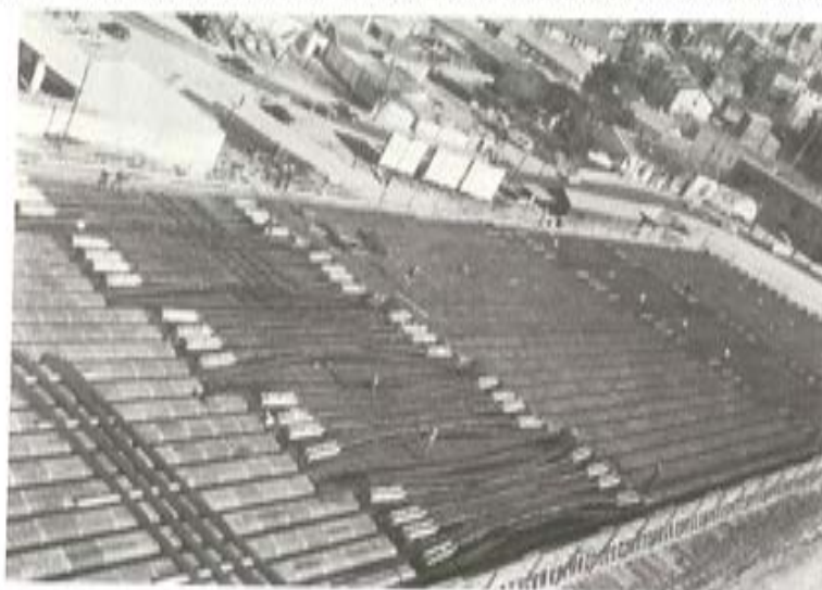
Fig. 8. - Paso superior de Ramón y Cajal, Vista aérea en construcción.
