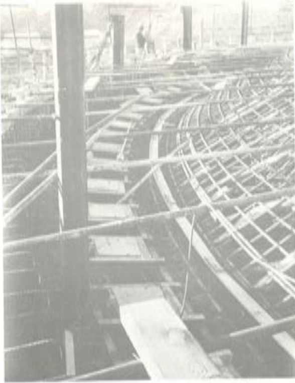
Fot. 44.— Colocación de las placas de apoyo de los anclajes en el paramento superior de la viga anillo,
