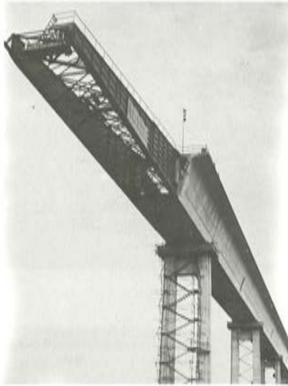
Fig. 3.— Acueducto de Alcanadre, Pico de lanzamiento.
