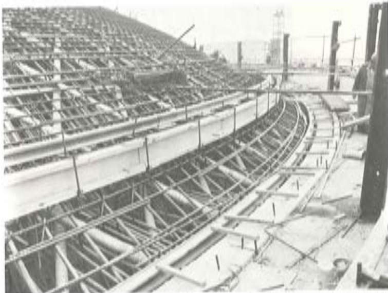
Fot. 46.— El hormigonado de la viga anillo terminado. Todas las vainas de la cúpula ya están terminadas y también la casi totalidad de la armadura superior.
