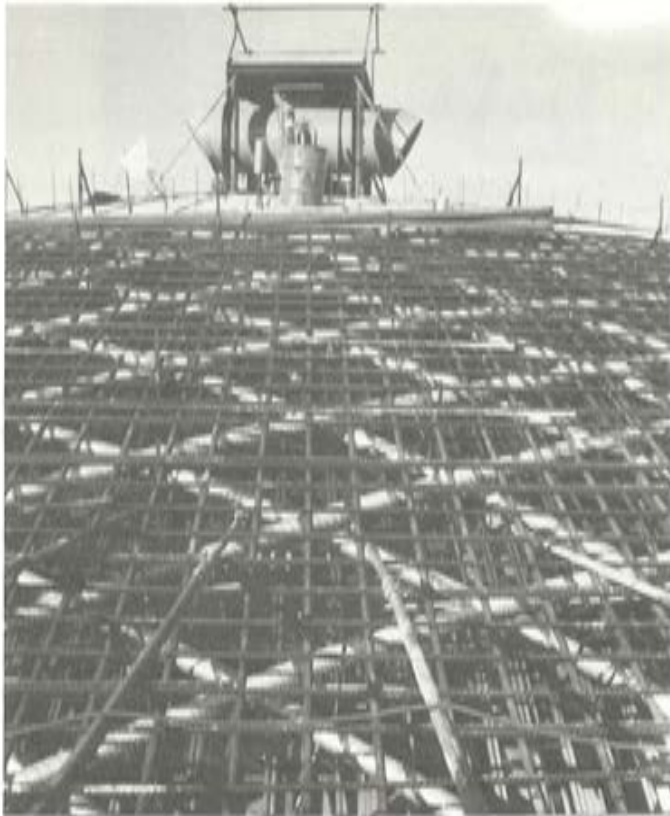
Fot. 50.— Vainas y armadura superior colocadas. Faltan los estribos.
