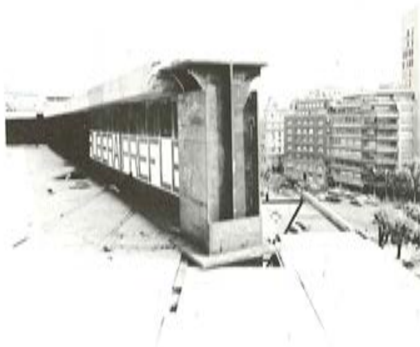
Fig. 5. Viga en su posición definitiva.
