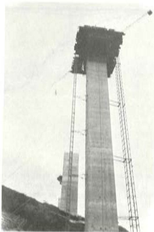
c) Viaducto de Las Lamas - Construcción de las pilas.
