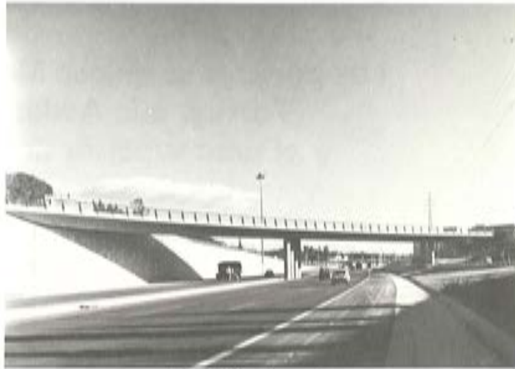
Foto 2. Alzado puente sur.
