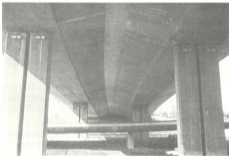
Fig. 11.— Vista inferior del puente terminado.
