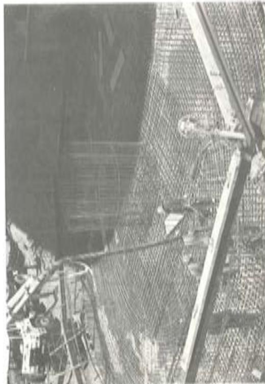
Fig. 5.—Armaduras de la cimentación.
