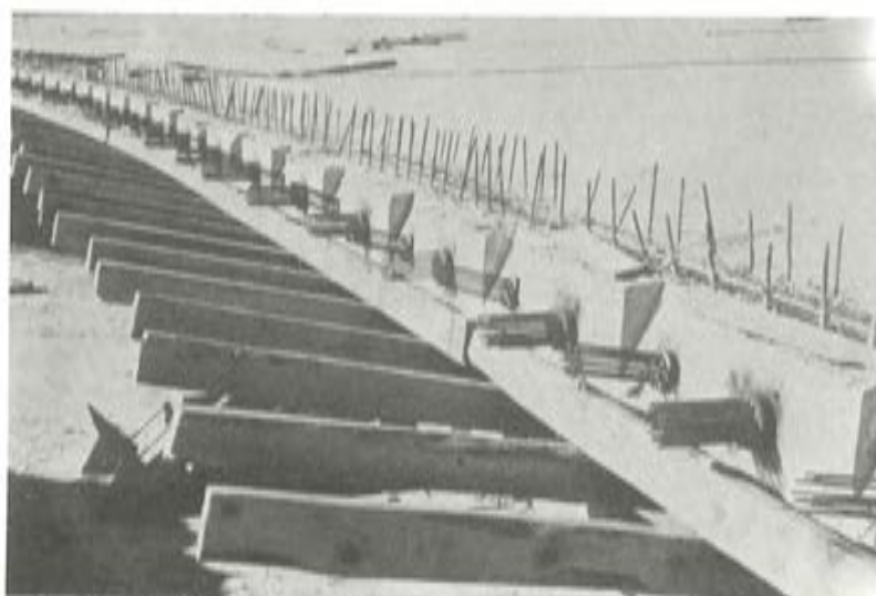
Fig. 22. Puesto I. Vista de anclajes del pretensado transversal en vanos extremos. Los horizontales corresponden a tendones del forjado superior, los más inclinados pertenecen a los tendones del pretensado del contorno inferior de la sección. (Tabiques inclinados y fondo).
