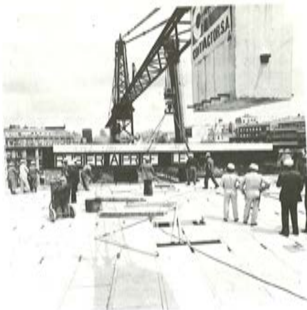
Fig. 4. Ubicación de una de las vigas en cubierta.
