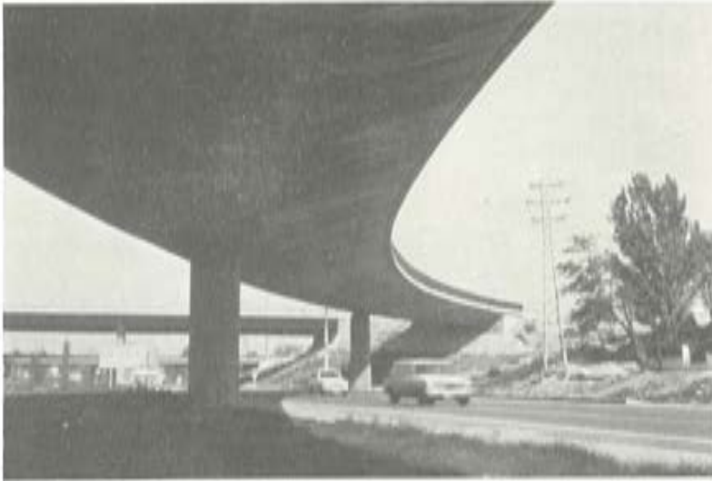
Fig. 23. Vista inferior del puente II, terminado.
