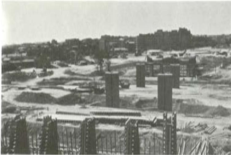
Fig. 9.— Alzado de pilas y estribos durante construcción
