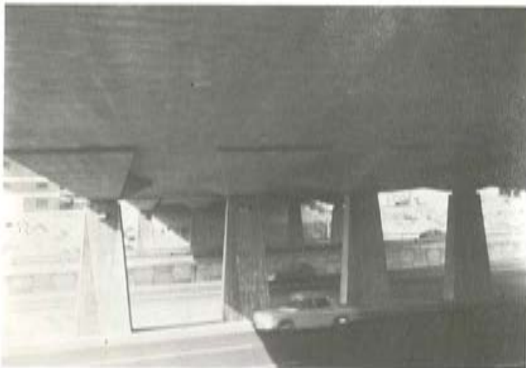
Fig. 12.— Paso superior de Ramón y Cajal. Vista inferior de la obra terminada.
