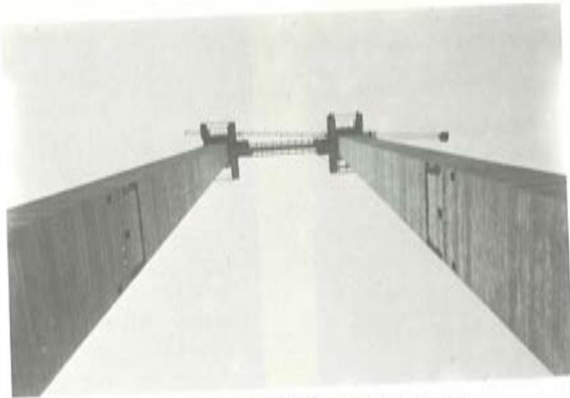
Fig. c).— Deslizamiento de las pilas principales.
