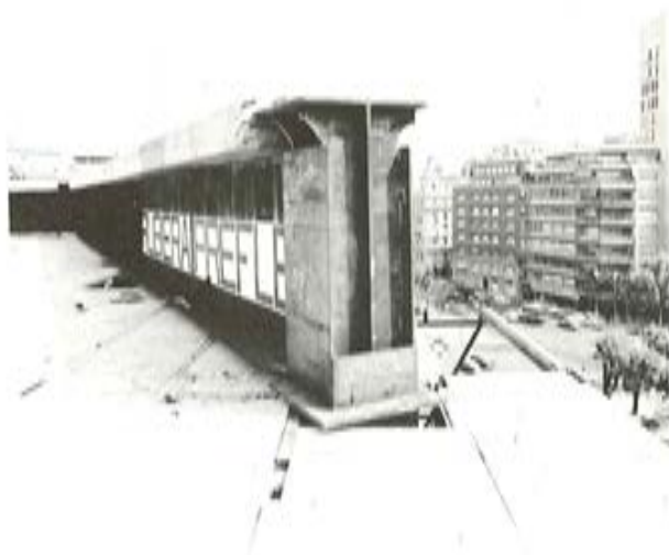
Fig. 5. Viga en su posición definitiva.
