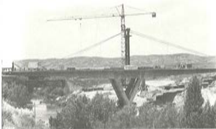
Fig. 4. - Vista durante la construcción.
