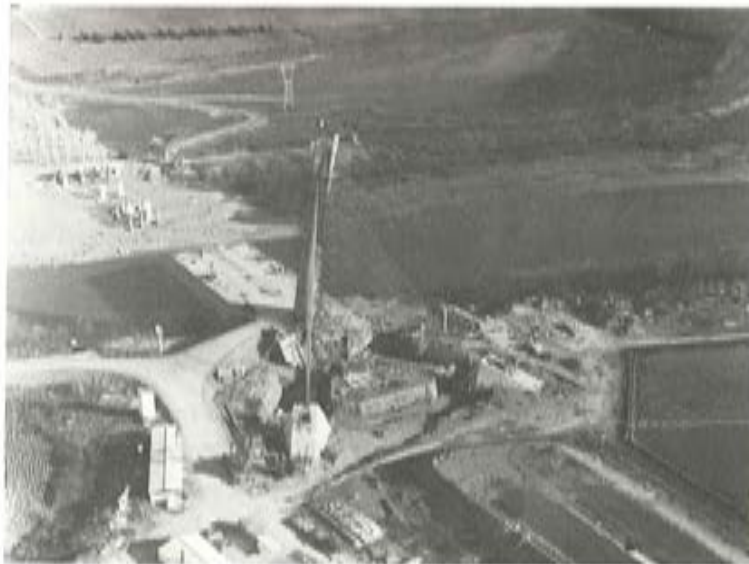
Fig. 4.— Vista aérea general durante construcción. Puede verse la disposición de los contrapesos y las vigas de enlace.
