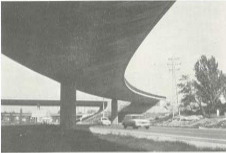
Fig. 23. Vista inferior del puente II, terminado.
