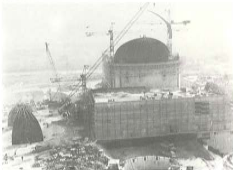
Fot. 28.— Operación de la grúa "Manitowok" izando un gajo.
