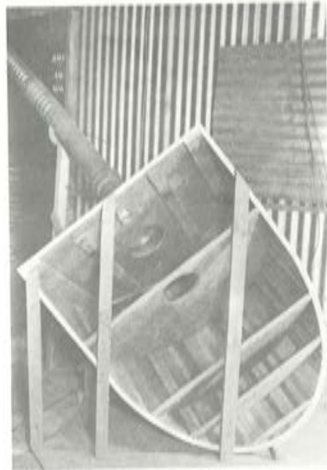
Fot. 17.— Vista del cajetín por la cara tangente a la viga anillo.
