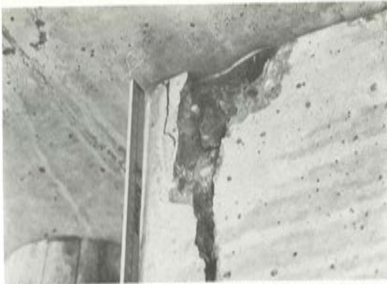
*Fig. 7. Grieta producida en el borde de un estribo al emplear apoyos de espesor demasiado pequeño, por lo que entraron en contacto directamente elementos de la estructura sin que el apoyo llegase a funcionar.*
