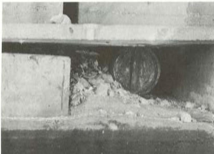
*Fig. 9. Apoyo de rodillo inutilizado por la suciedad que ha dejado pasar una junta de dilatación permeable.*
