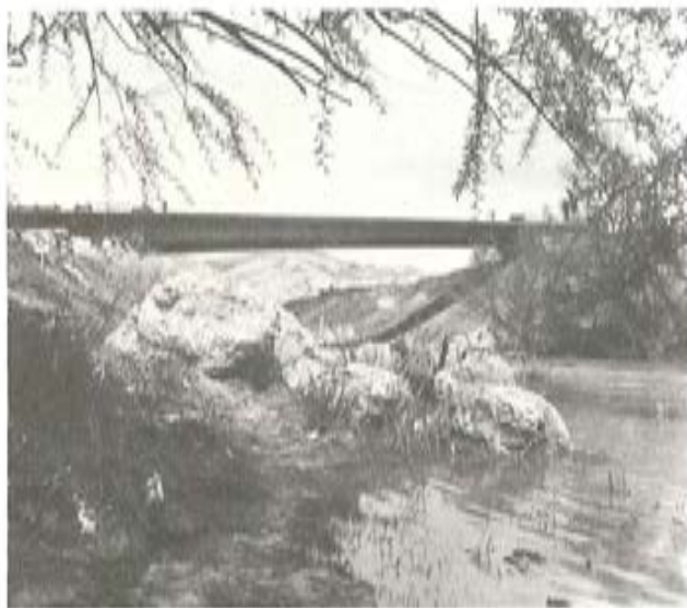
Fig. 3. - Aspecto del puente.
