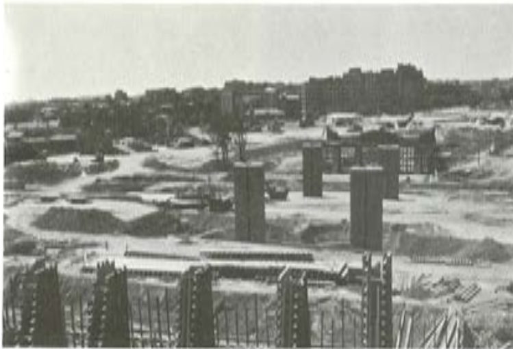
Fig. 9.— Alzado de pilas y estribos durante construcción
