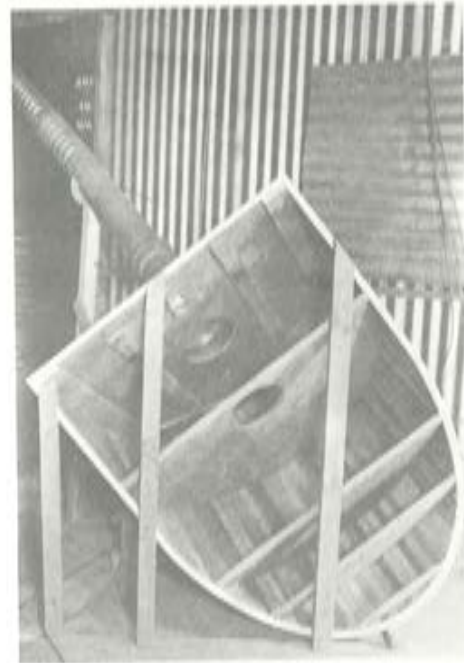
Fot. 17.— Vista del cajetín por la cara tangente a la viga anillo.
