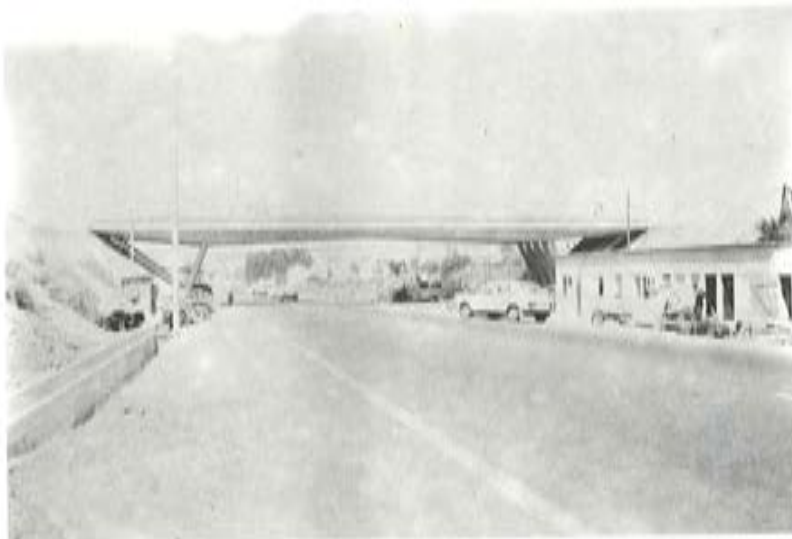
Fig. a).— Puente de Caranza. Vista General.
