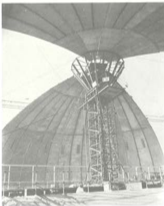
Fot. 27.— Detalle del soporte central definitivo.
