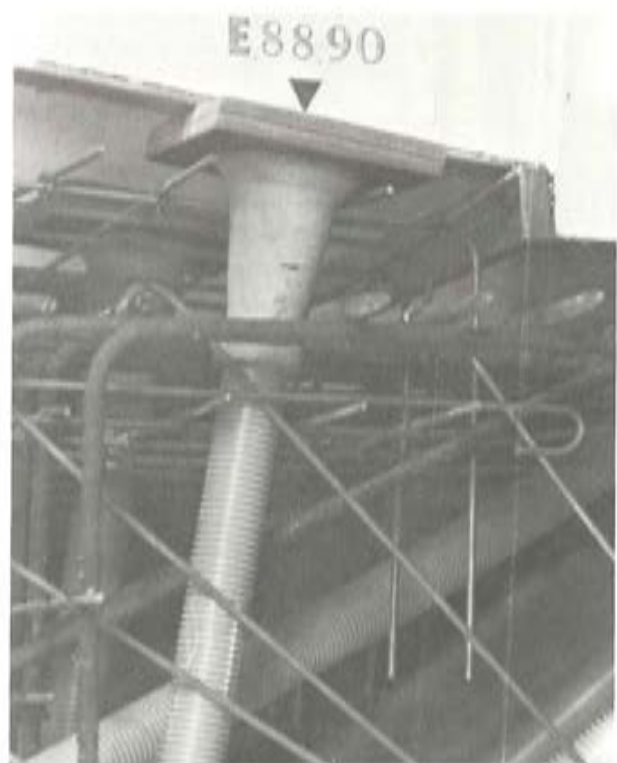
Fot. 15.— Detalle del anclaje superior de los tendones verticales.
