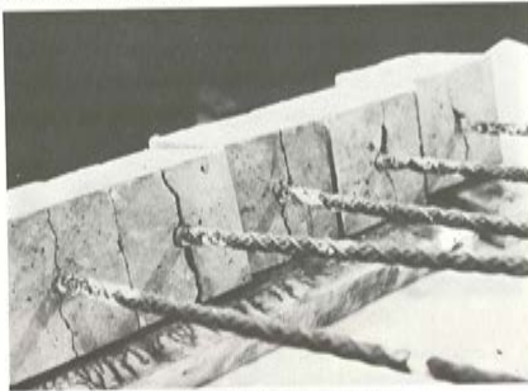
Fig. 3 Rotura de "splitting" del hormigón.
