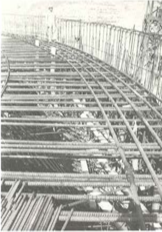
Fot. 39.— Armadura plana superior de la viga anillo, por debajo de los anclajes superiores verticales.
