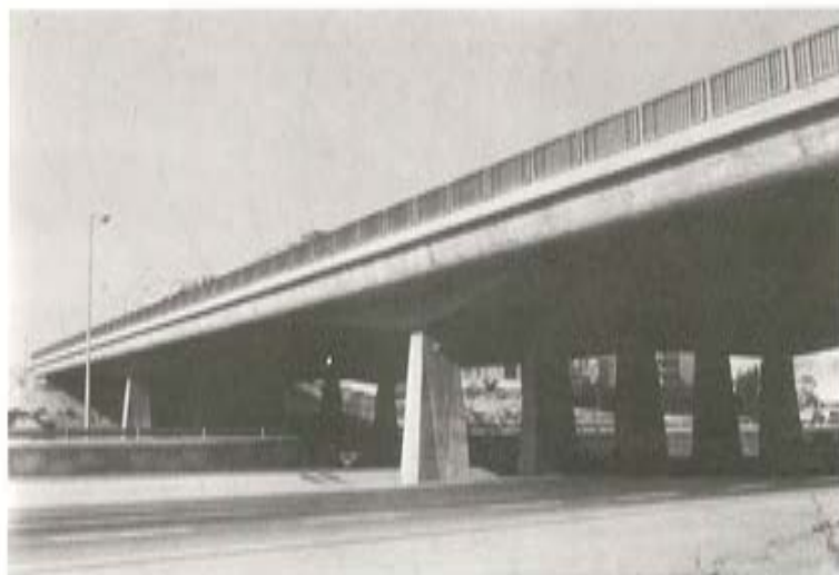
Fig. 13.— Paso superior de Ramón y Cajal. Alzado del Puente terminado.
