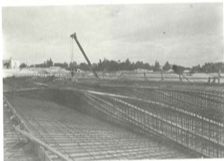
Fig. 7. - Detalle de montaje del pretensado longitudinal.
