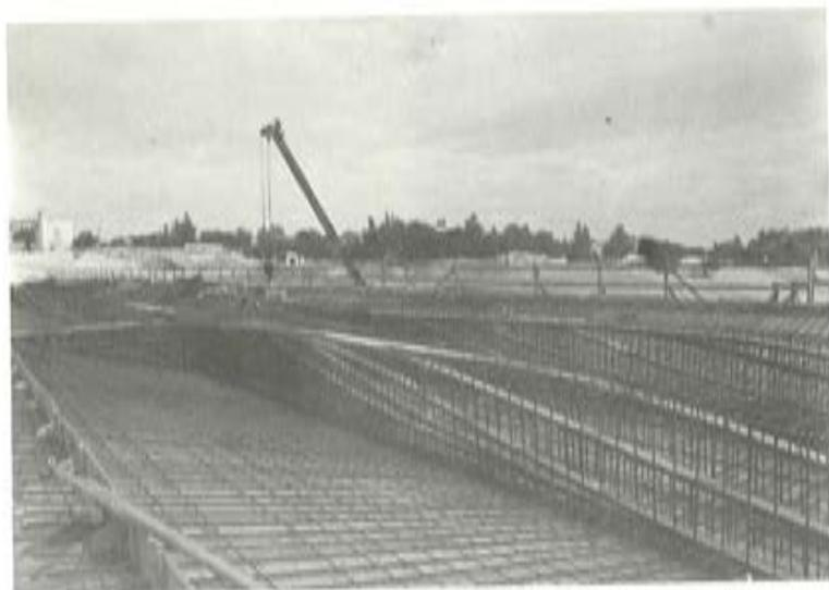
*Fig. 7. - Detalle de montaje del pretensado longitudinal.*
