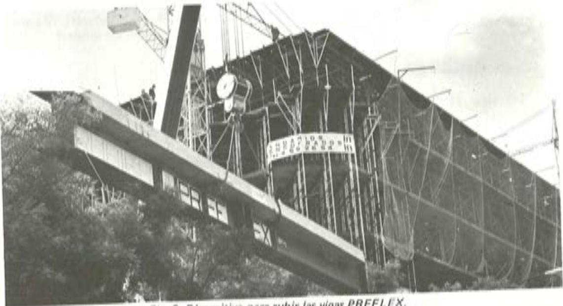
*Fig. 2. Dispositivo para subir las vigas PREFLEX.*
