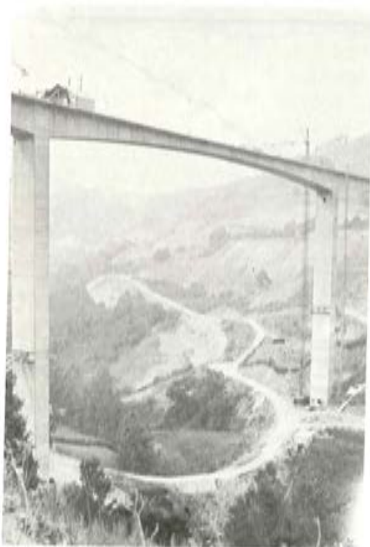
b) Viaducto de Ruitelán - Vano central.
