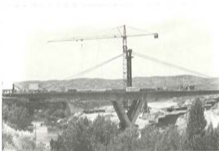
Fig. 4. - Vista durante la construcción.
