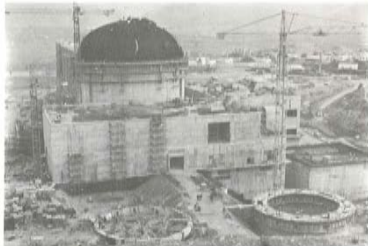
Fot. 29. – Colocación de gajos en forma compensada.
