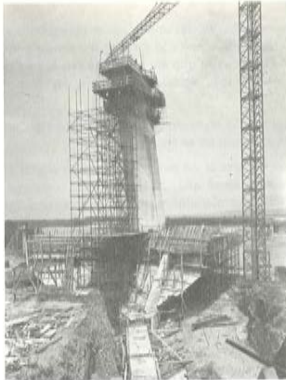
Fig. 5.— La torre durante construcción y una viga de enlace con la zapata. Puede verse la disposición de la junta de gatos planos.
