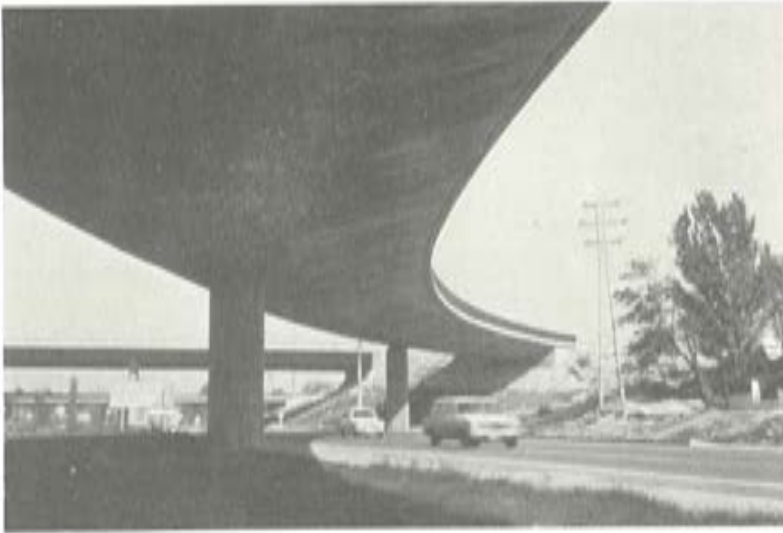
Fig. 23. Vista inferior del puente II, terminado.
