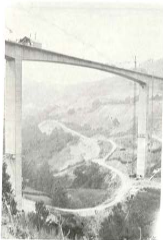
b) Viaducto de Ruitelán - Vano central.
