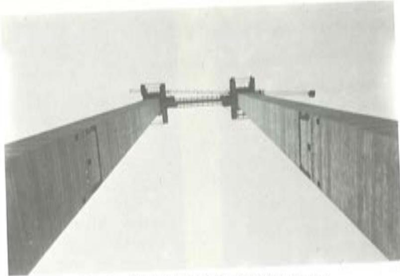
*Fig. c).— Deslizamiento de las pilas principales.*
