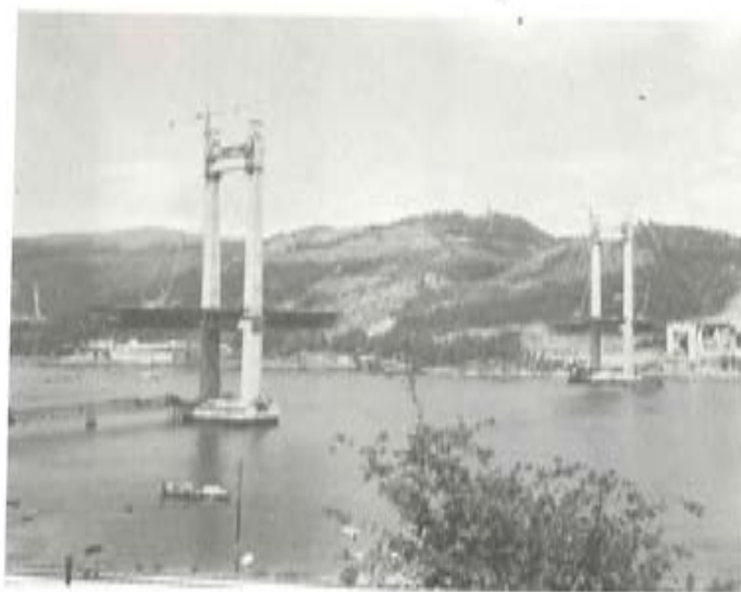
Fig. i). Construcción por avances de tablero.
