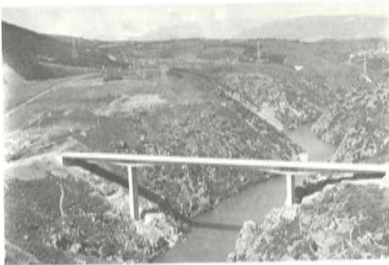
e) Viaducto de la Fuente del Azufre - Vista de conjunto,
