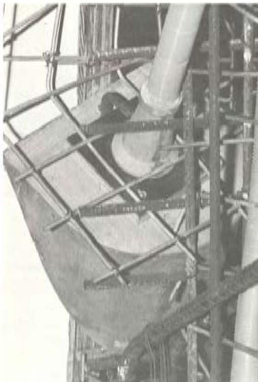
*Fot. 14.— Detalle del trasdós de un cajetín y su refuerzo.*
