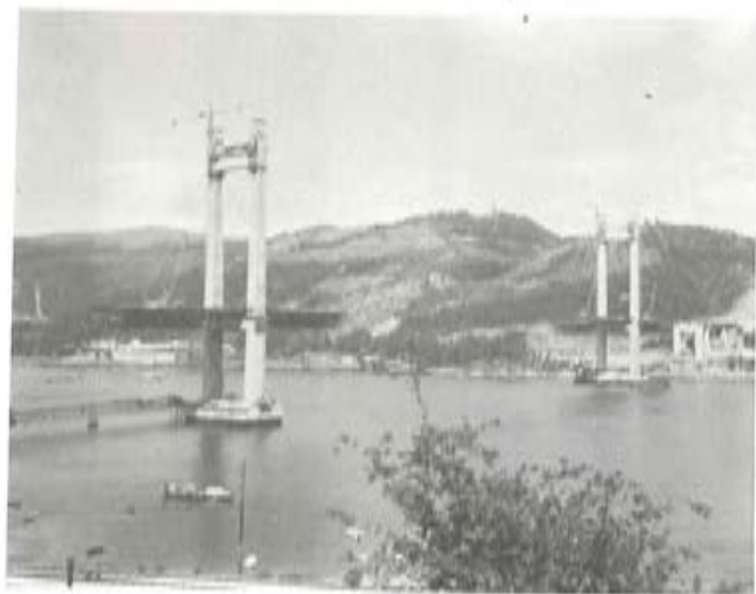
Fig. i). Construcción por avances de tablero.
