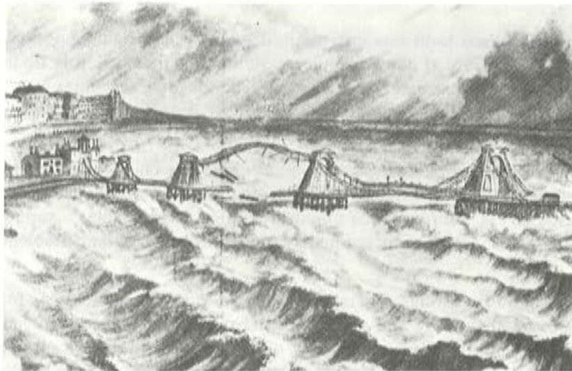
Fig. 2. El hundimiento del puente de Brighton.
