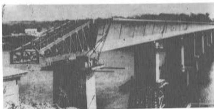
Fig. 11. Puente sobre el Caroní. Venezuela.
