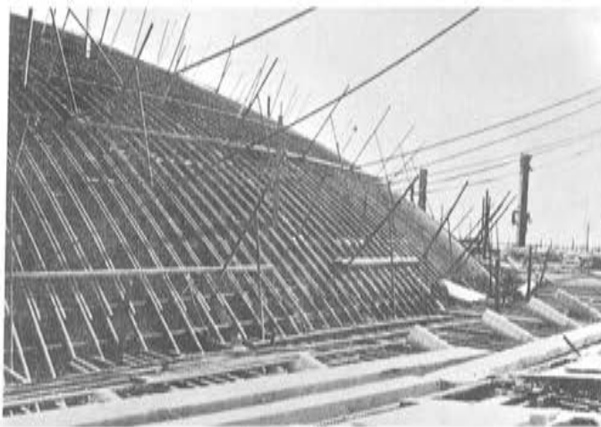
Fot. 17. Los cajetines para los anclajes de los tendones de la cúpula.
