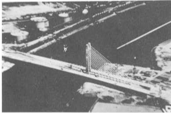
Figura 6.— Puente de HOECHST.
