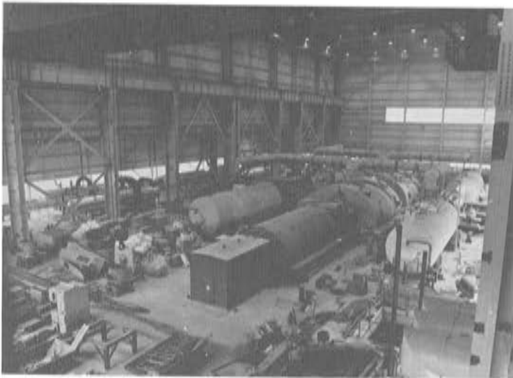
Fot. 29. La turbina y Generador de Electricidad (En montaje).
