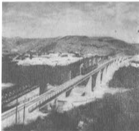
Fig. 1. Puente de Andarax.
