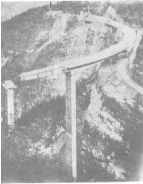
Fig. 5. Viaducto de Val Restel. Construcción.
