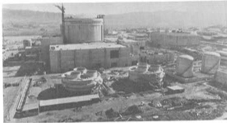
Fot. 26. El edificio de contención terminado de hormigonar.
