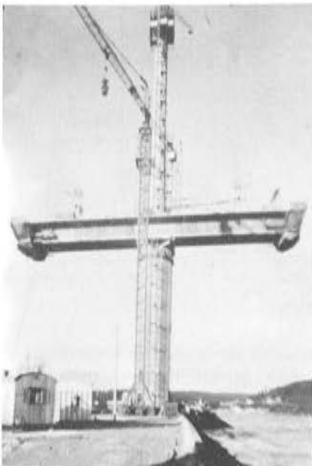
Figura 23.— Puente de BROTONNE. Construcci n por voladizos sucesivos.
