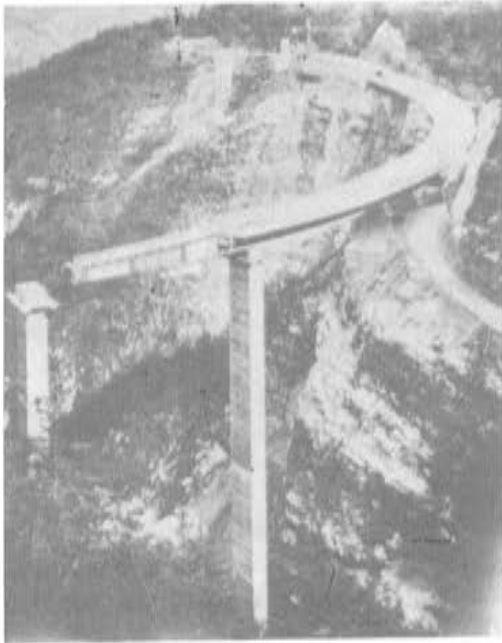
Fig. 5. Viaducto de Val Restel. Construcción.
