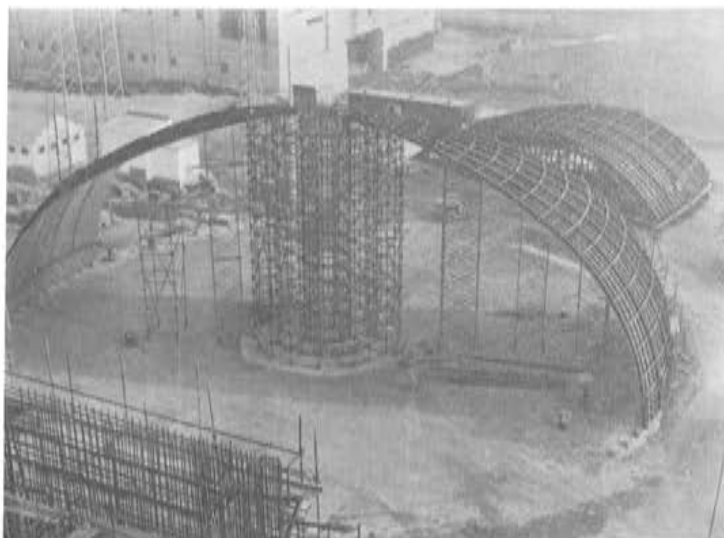
Fot. 10. El premontaje de ajuste de la cúpula metálica.
