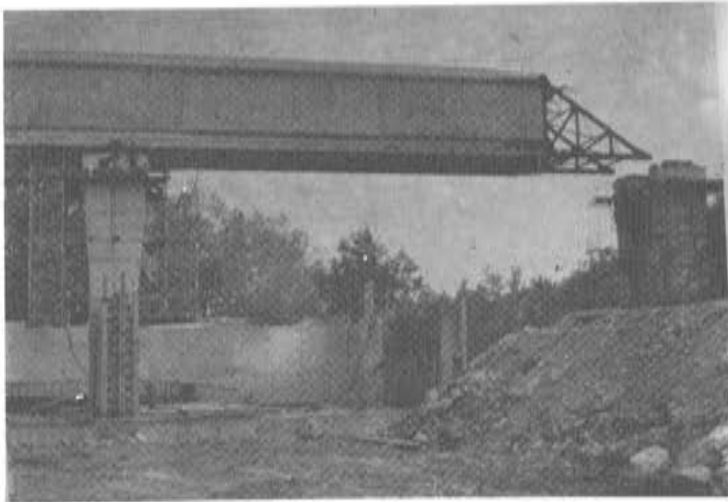
Fig. 10. Acueducto de Abeou. Construcción.
