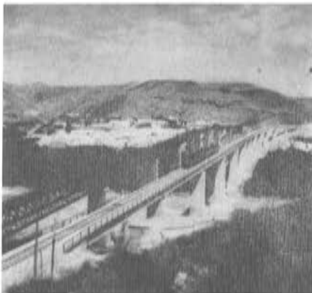
Fig. 1. Puente de Andarax.
