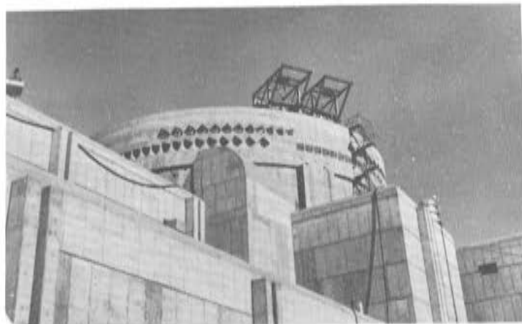
Fot. 27. Detalle de las estructuras de hormigón de los edificios.
