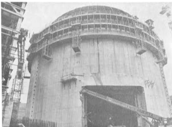
Fot. 12. La abertura provisional para la entrada del equipo pesado.
