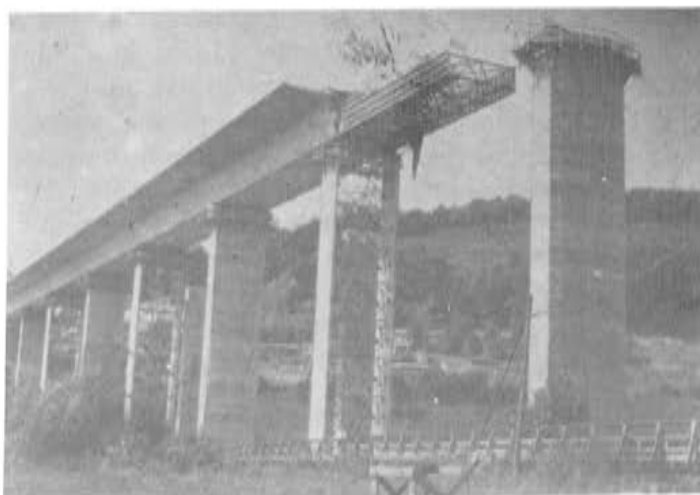
Fig. 18. Puente sobre el Tauber. Pescante.
