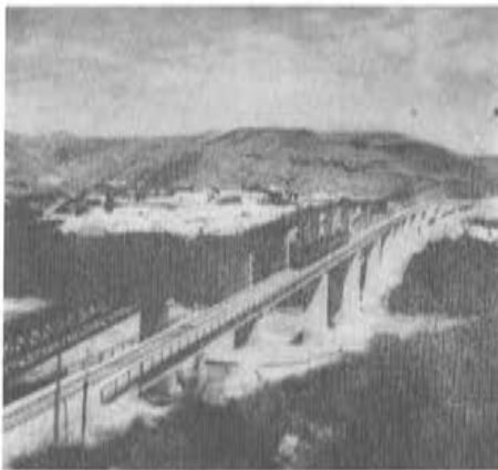
Fig. 1. Puente de Andarax.
