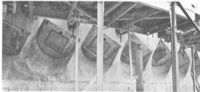
Fot. 17. Los cajetines para los anclajes de los tendones de la cúpula.
