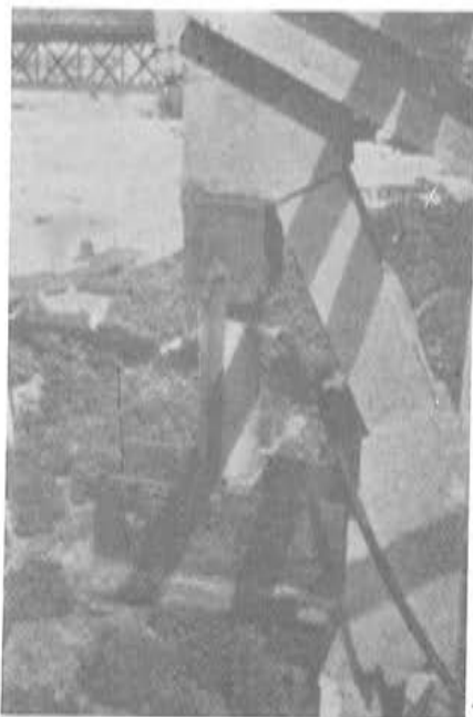
Fig. 13. Puente de Andarax. Muelles y gatos en extremo de pescante.
