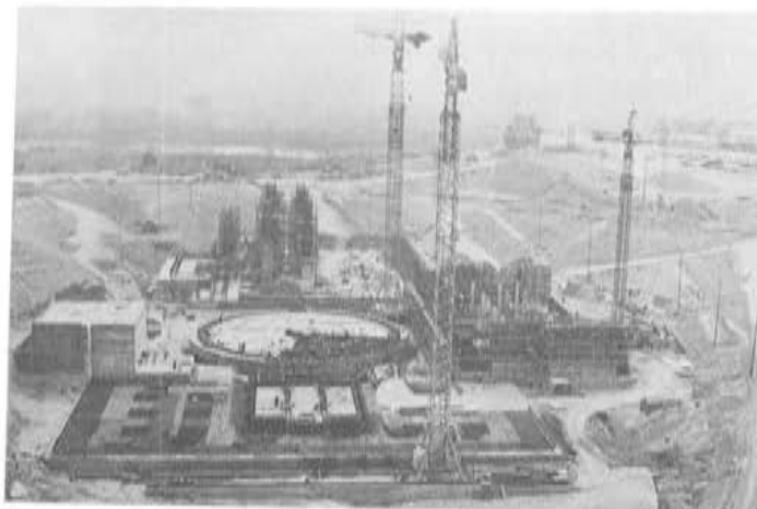
Fot. 4. Vista general del grupo I- se está terminando el hormigonado de la base del edificio de contención del reactor.
