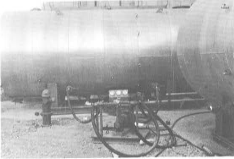
Fot. 25. La bomba de inyección y los instrumentos de control de presión y temperatura.
