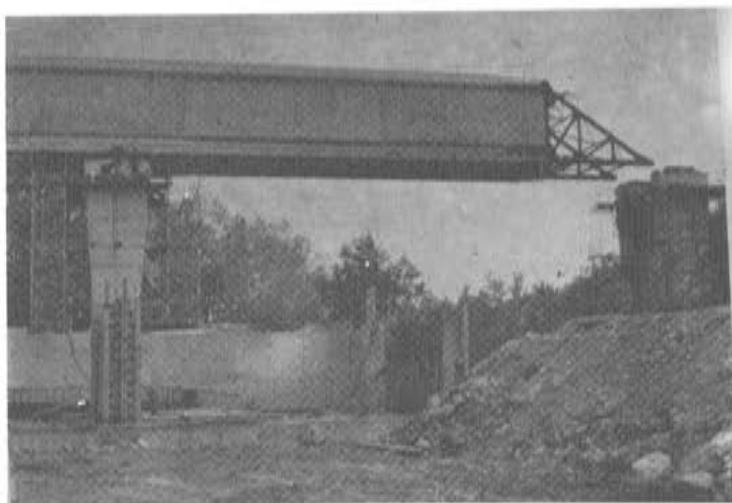
Fig. 10. Acueducto de Abeou. Construcción.
