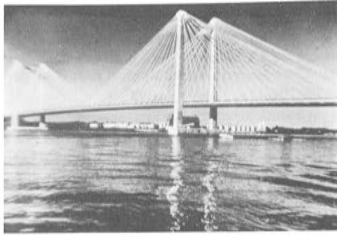
Figura 9.— Puente de PASCO—KENNEWICK.
