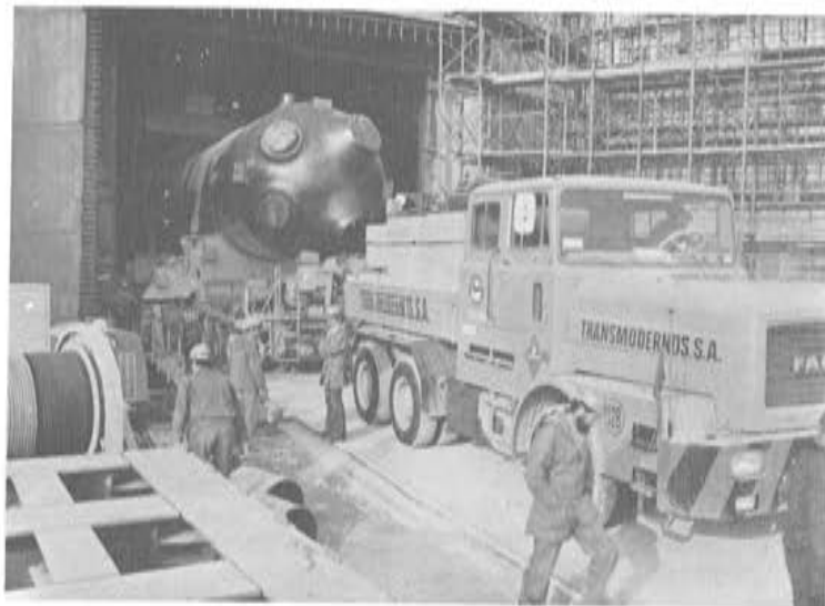
Fot. 30. Entrada dentro del edificio de contención del generador de vapor.
