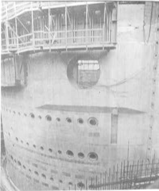
Fot. 7. Vista del muro, terminado, en la parte de la entrada del personal.
