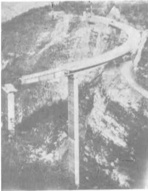
Fig. 5. Viaducto de Val Restel. Construcción.
