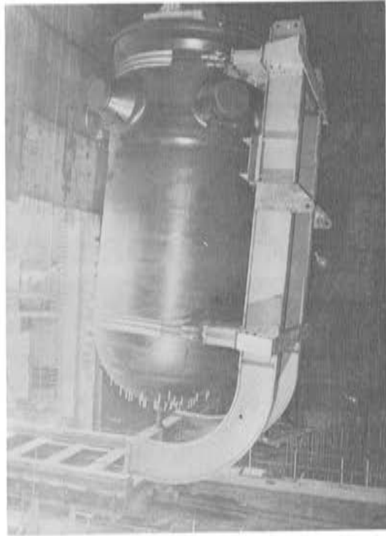
Fot. 31. Izado del reactor nuclear, por la grua polar, para ser colocado, en su ubicación final.
