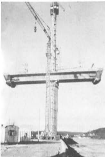
Figura 23.— Puente de BROTONNE. Construcci n por voladizos sucesivos.
