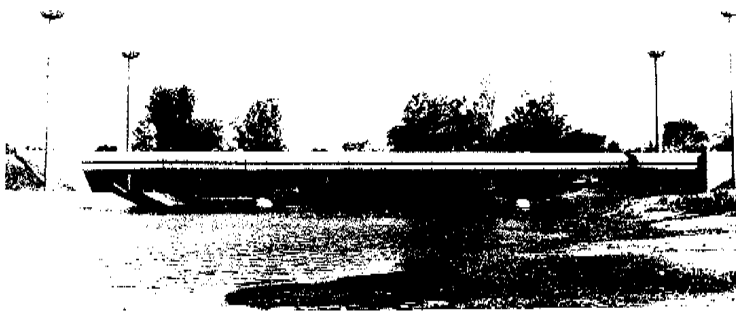
Fig. 1. Vista lateral del puente desde aguas arriba.
