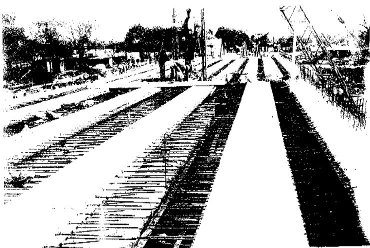
Fig. 10. Vigas del primer tramo en su posición definitiva (al fondo), antes del homigonado de la losa superior. Vigas del segundo tramo en posición de tesado y antes de ser baja bajadas a su posición definitiva.
