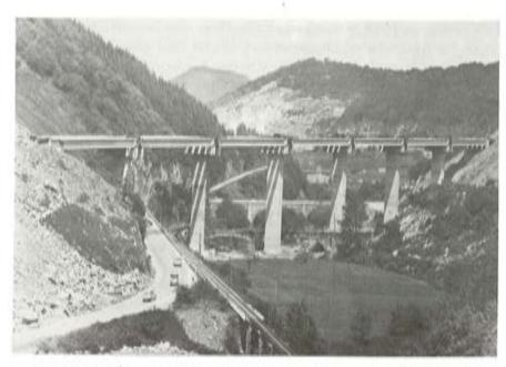
Gran Viaducto de Subiberri. 345 m de longitud. Altura de pilas hasta 46 m.
