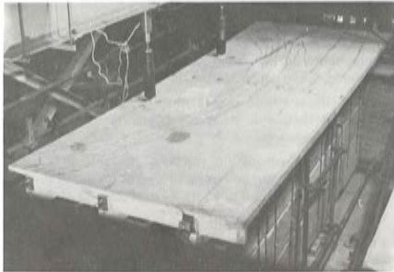
Fig. 3.14. Fisuración del tablero en las proximidades de la rotura.
