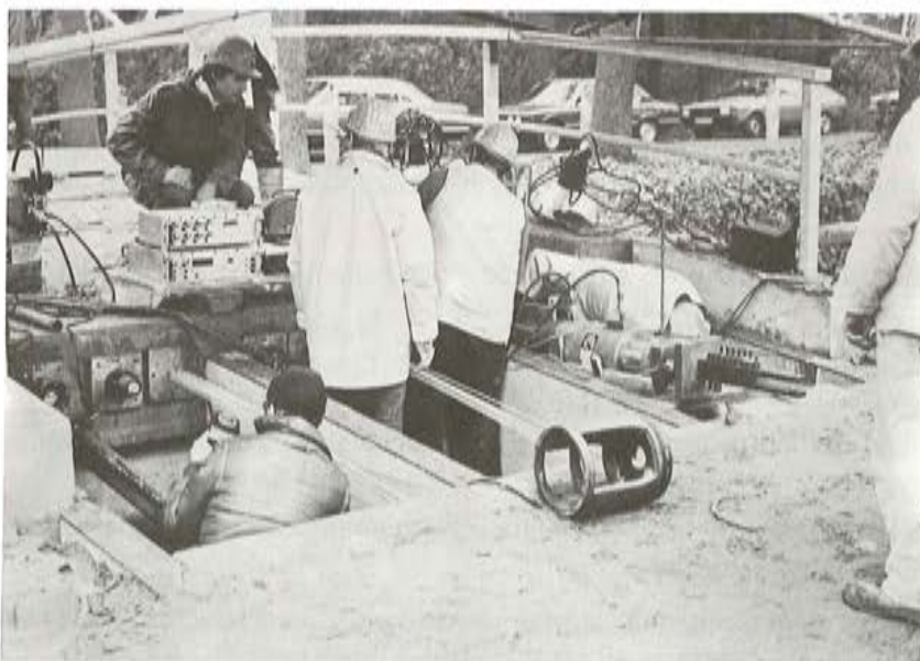
Fig. 2. Diversos aspectos de las operaciones de tesado durante la construcción del puente de Düsseldorf.
