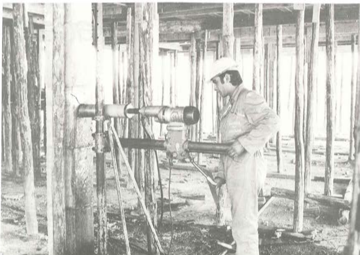
Extracción de probetas testigo de hormigón
