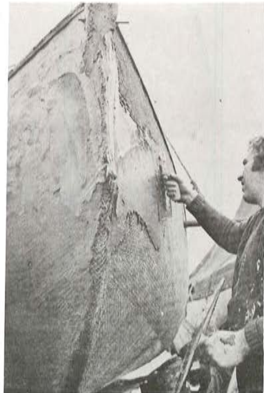
Fig. 15 y 16: Trabajos de reparación de un bote mediante ferrocemento.
