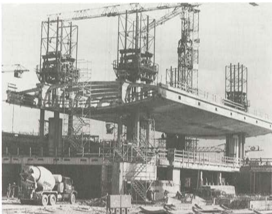
Figura 5.— Elevación del primer cajón de la cubierta del módulo de tráfico B. Puede observarse la magnitud de la luz entre pilares. (Foto Aéroport de París).
