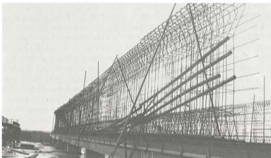
Figura 24.— Armadura de una de las vigas principales de los cajones.
