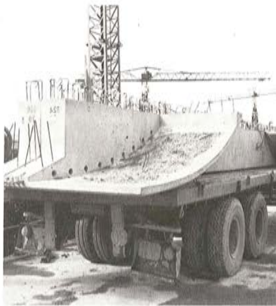
Figura 32. — Transporte de uno de los conjuntos, lámina de encofrado-viga, prefabricados por la empresa E.P.I., y utilizados en la construcción del viaducto central.
