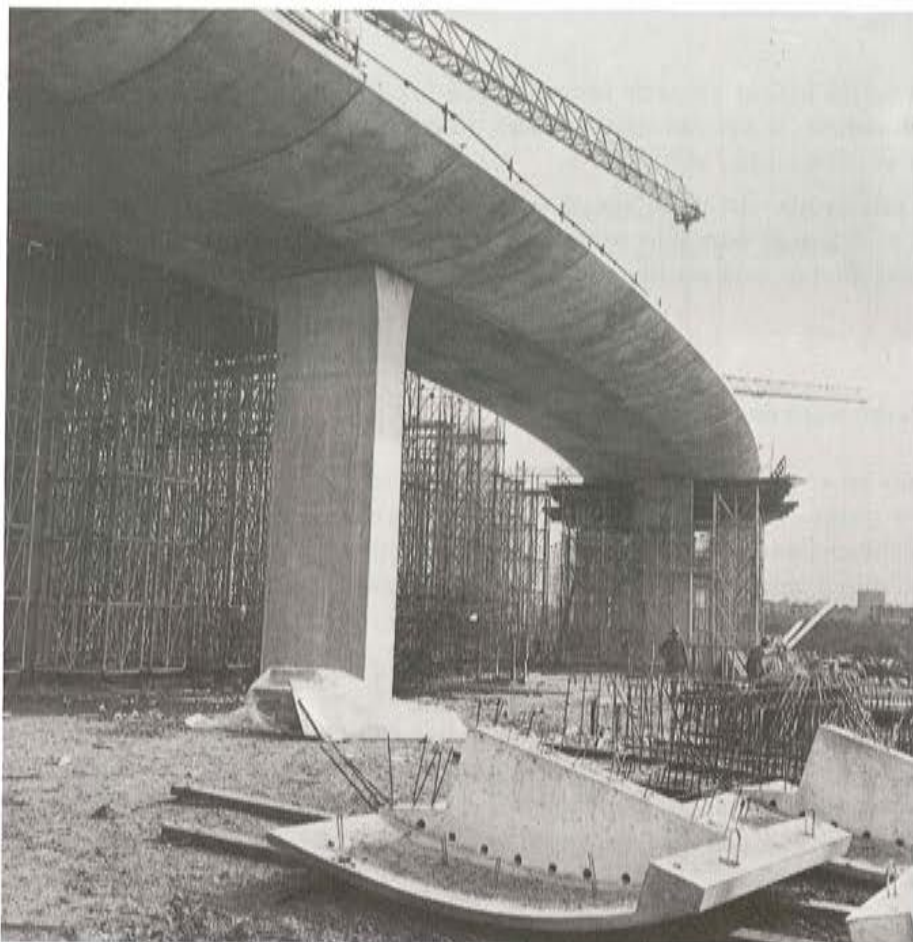
Figura 31. — Una de las piezas prefabricadas utilizadas en la construcción de los viaductos.
