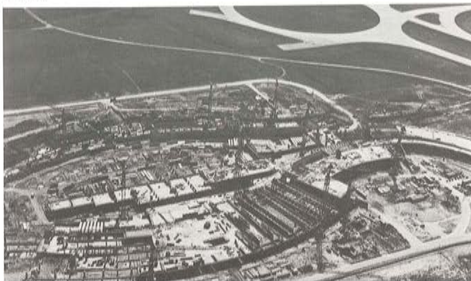
Figura 20.—Vista del conjunto de las obras durante su construcción. (Foto Aéroport de París).
