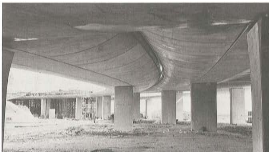
Figura 13.— El viaducto central.
