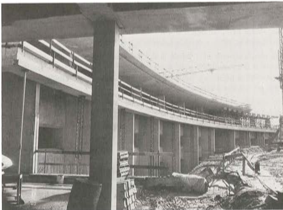
Figura 10.— Módulo de entrada. Vista desde el lado de las pistas.
