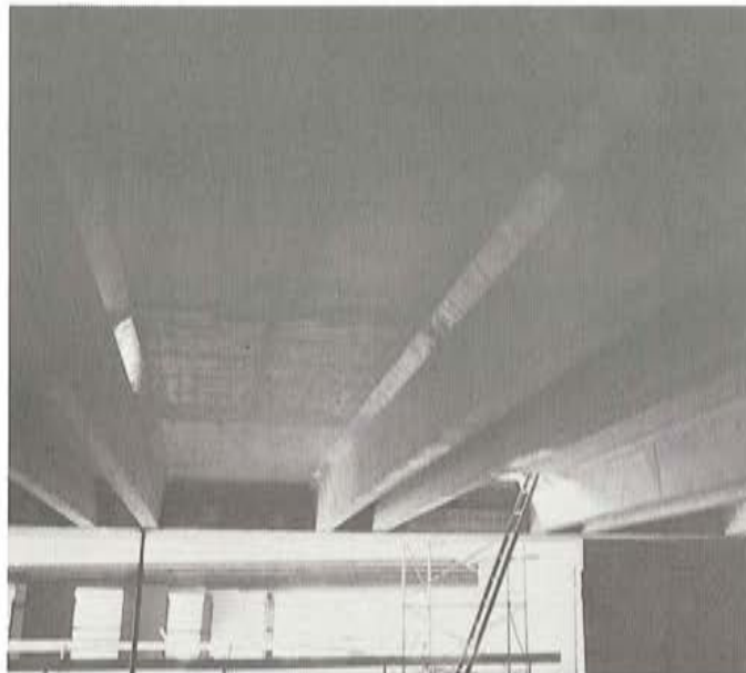
Figura 19.— Piezas prefabricadas, de sección en U, utilizadas en los forjados de los parques de estacionamiento.
