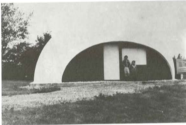
Fig. 27: Vivienda unifamiliar en ferrocemento terminada (Lachance y Picard).
