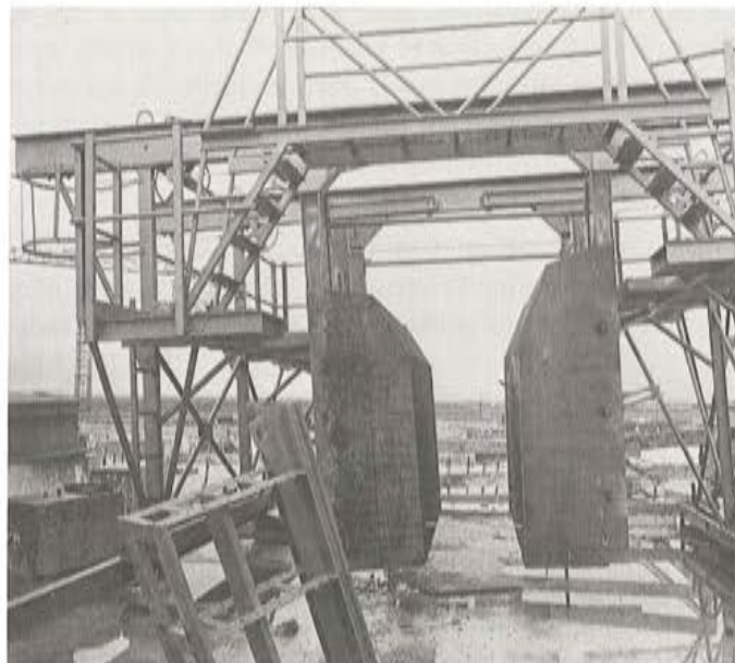
Figura 25.— Molde utilizado para la construcción de las vigas principales de los cajones.
