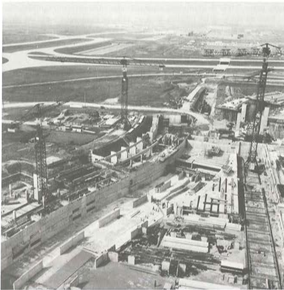
Figura 33.— Vista general de las obras del parque de estacionamiento de vehículos y del módulo A.
