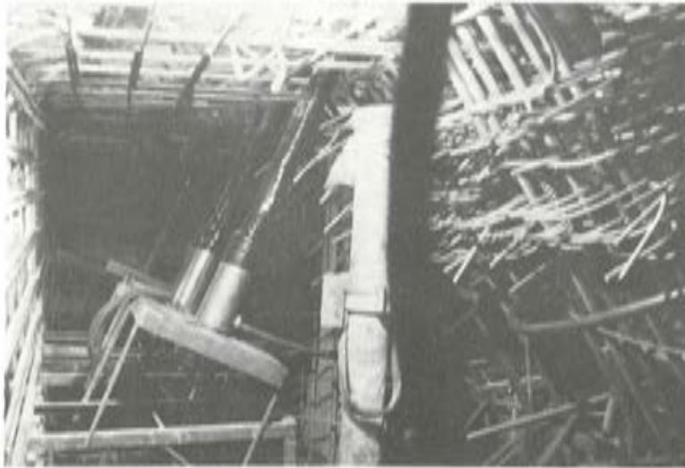
FOTO 2 bis. —Galería inferior, donde se pueden ver los anclajes ciegos.
