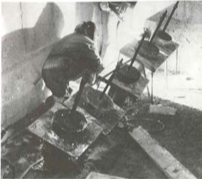
FOTO 4. —Colocación de cinco anclajes activos de 250 tn, en la cara superior de un encepado.
