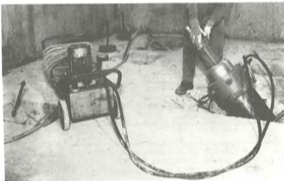
FOTO 5.—Tzado de uno de los tendones de 250 tn de potencia.
