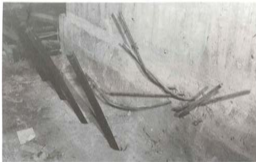
FOTO 3. —Cuatro mazos de alambres de \phi 7, una vez enfilados y antes de colocar los anclajes activos.
