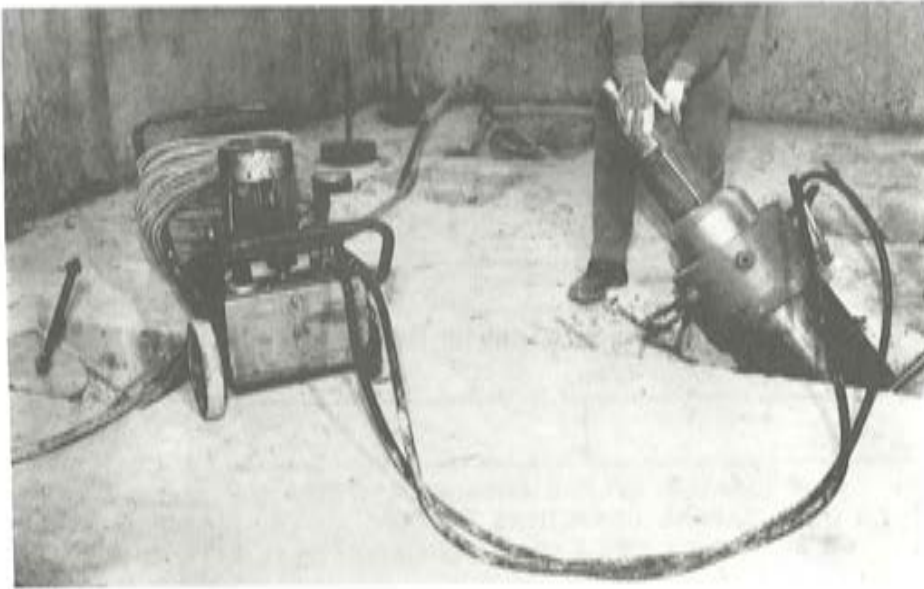
FOTO 5.—Tesado de uno de los tendones de 250 tn de potencia.
