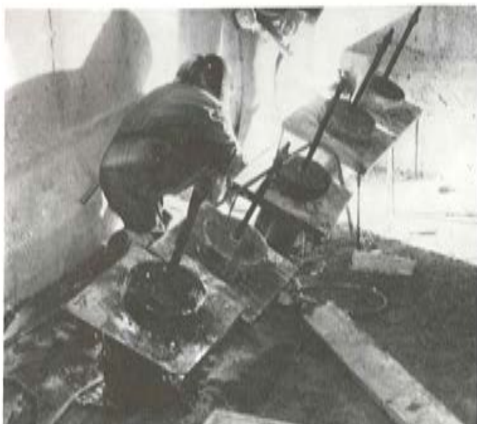
FOTO 3. —Cuatro mazos de alambres de \phi 7, una vez enfilados y antes de colocar los anclajes activos.
