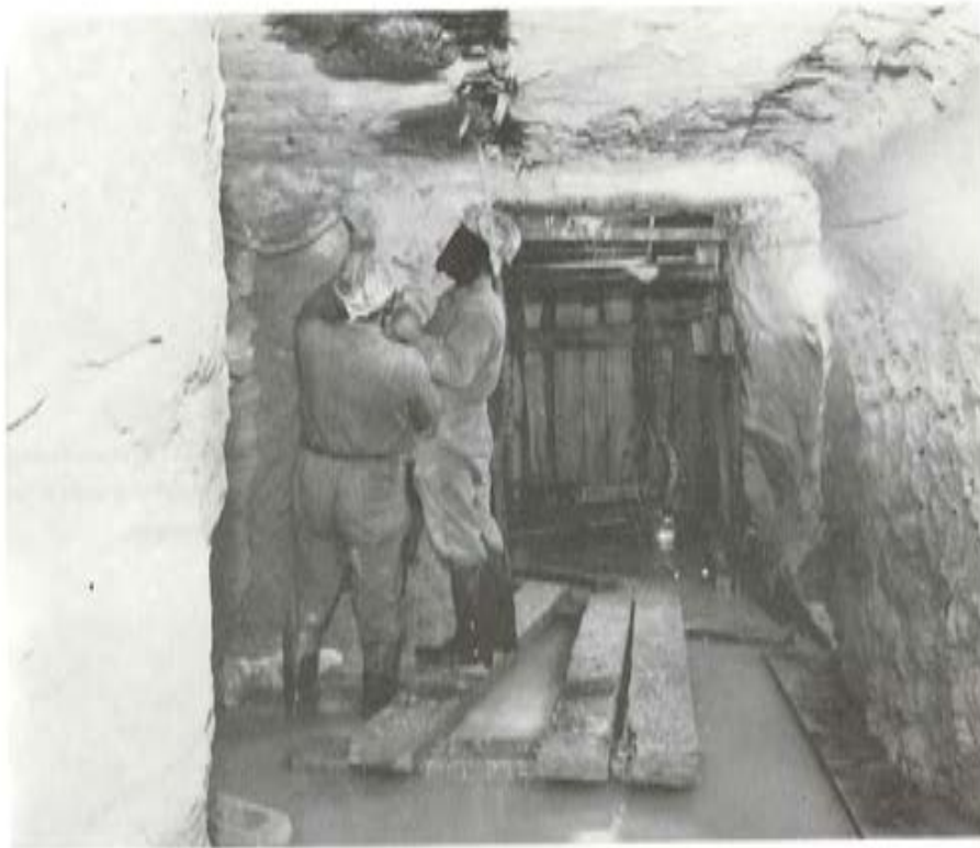
FOTO 1.—Galería inferior típica, con pilotes de 2 m de diámetro.
