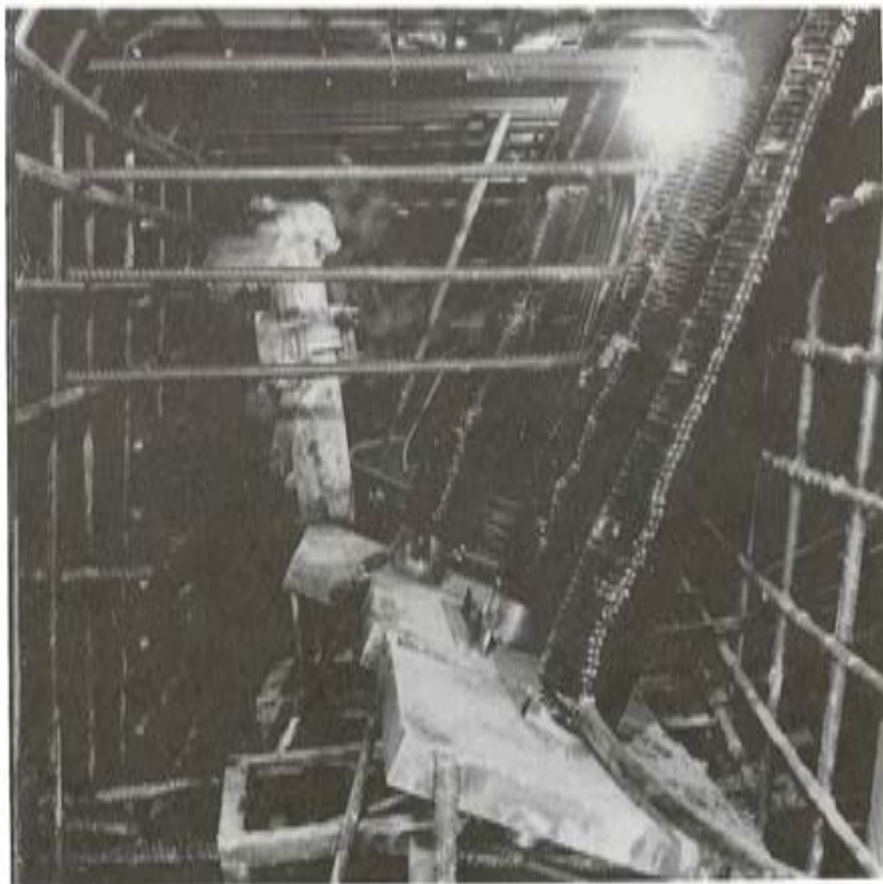
FOTO 2.—Galería inferior, donde se pueden ver los anclajes ciegos.
