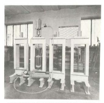
Fig. 5. Batería de bastidores para ensayo de cordones.
