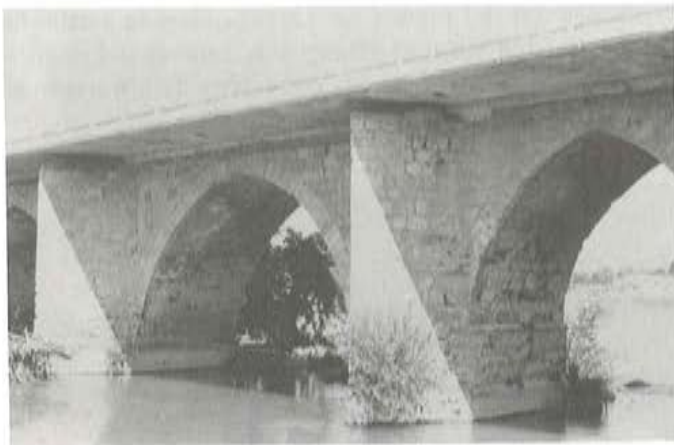
Fig. 8-a. Aspecto del puente de Miranda ensanchado.
