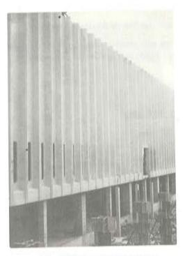
Fig. 40. Paneles de cerramiento.
