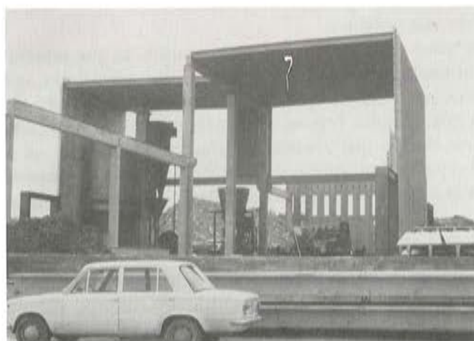
Fig. 8. Vista general de la estructura, en construcción.
