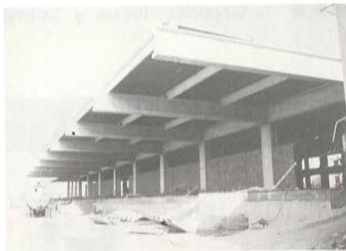
Fig. 58. Vista de las vigas en voladizo.
