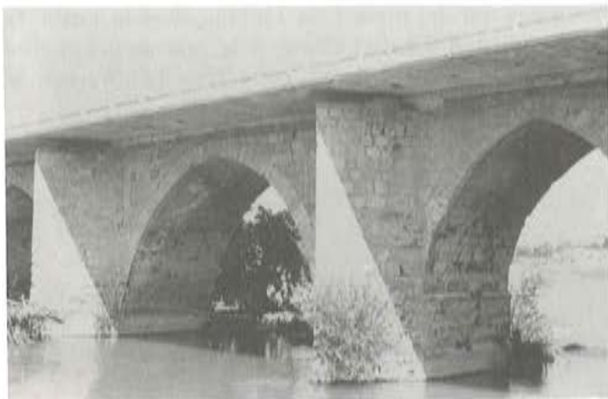
Fig. 8-a. Aspecto del puente de Miranda ensanchado.
