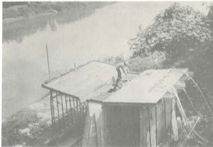
Fig. 13. Pila y pantalla de estabilidad provisional
