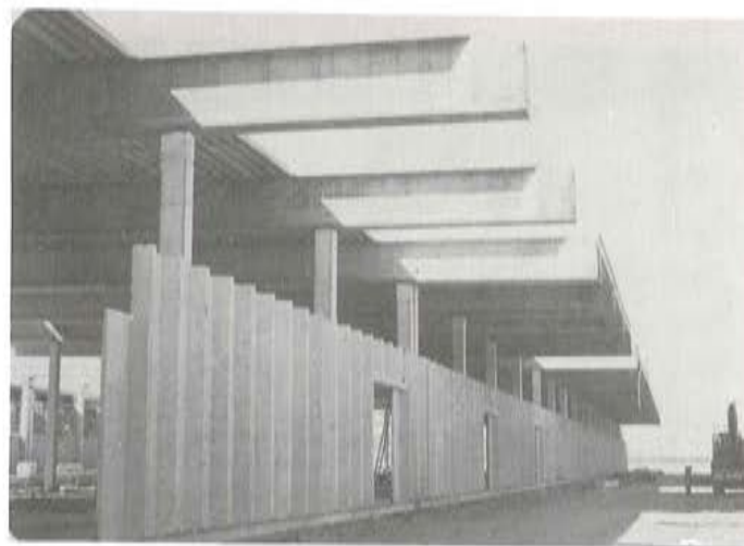
Fig. 39. Fachada con vigas en voladizo, en construcción.
