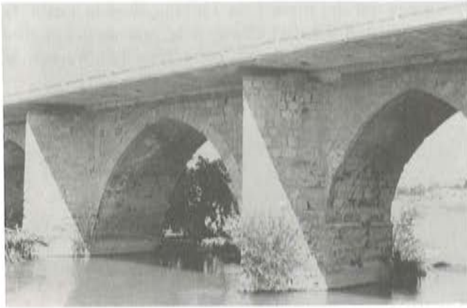
Fig. 8-a. Aspecto del puente de Miranda ensanchado.
