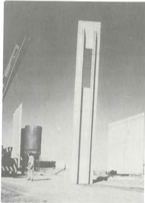
Fig. 9. Pieza de cerramiento durante su montaje.
