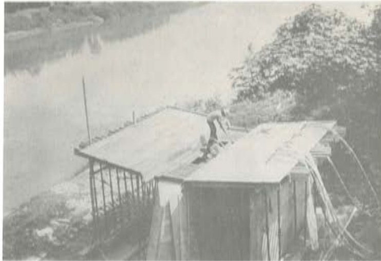
Fig. 13. Pila y pantalla de estabilidad provisional
