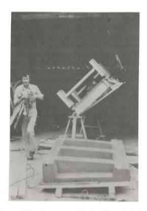
Fig. 4. Desmoldeo de las aceras
