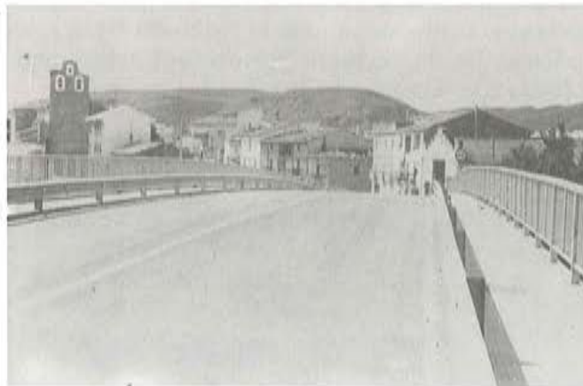
Fig. 11. Nueva plataforma del puente de Berbinzana.
