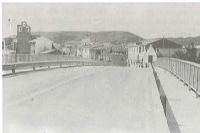
Fig. 11. Nueva plataforma del puente de Berbinzana.
