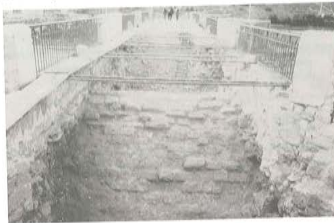
Fig. 2. Puente de Miranda vaciado.
