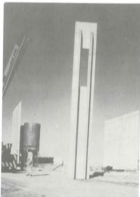
Fig. 9. Pieza de cerramiento durante su montaje.
