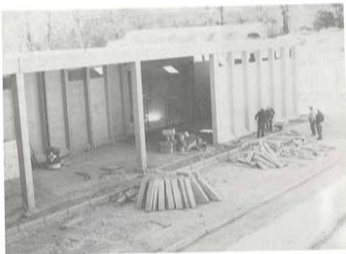
Fig. 18. Porche del Gimnasio.
