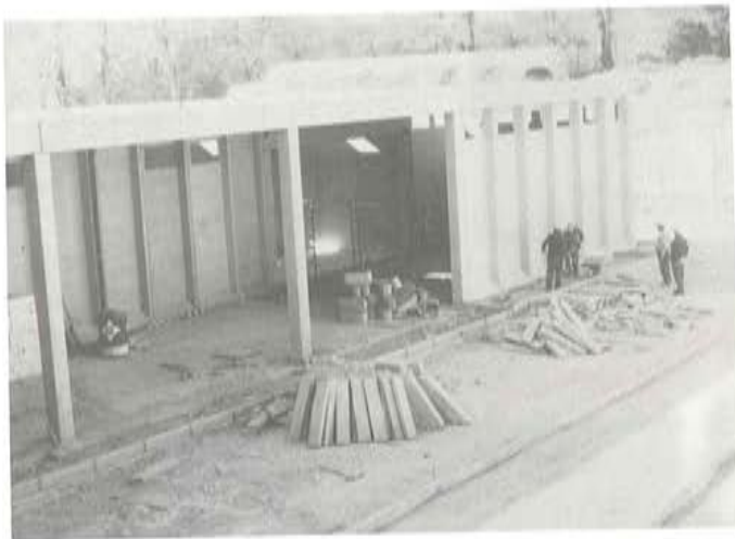
Fig. 18. Porche del Gimnasio.
