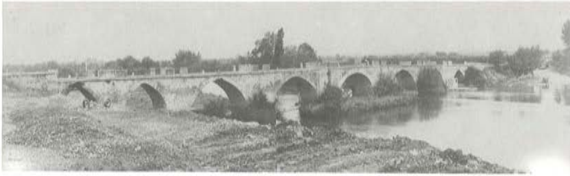
Fig. 1-c. Puente de Miranda de Arga. Estado antiguo.
