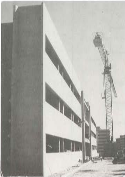
Fig. 15. Fachada principal, en construcción.
