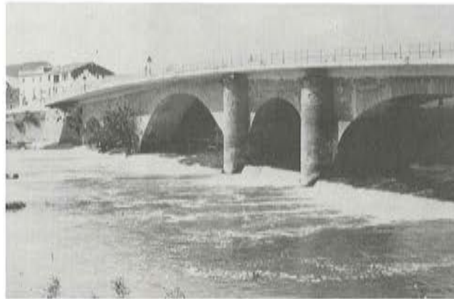
Fig. 10. Puente de Berbinzana, terminado.
