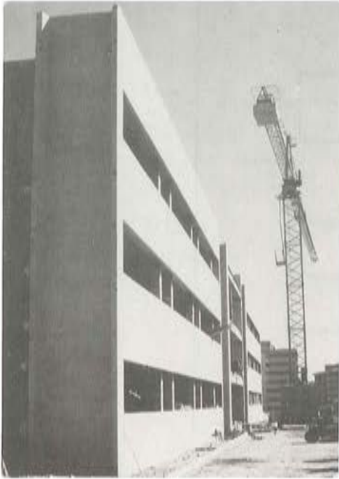
Fig. 15. Fachada principal, en construcción.
