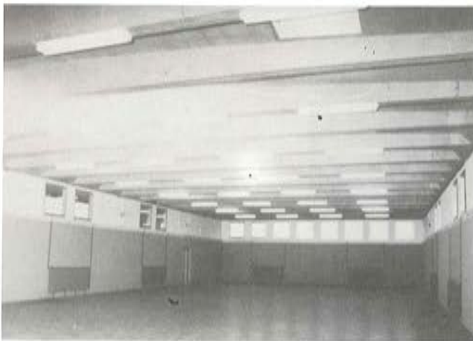
Fig. 23. Vista del interior del Edificio de Gimnasio.
