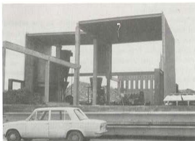
Fig. 8. Vista general de la estructura, en construcción.
