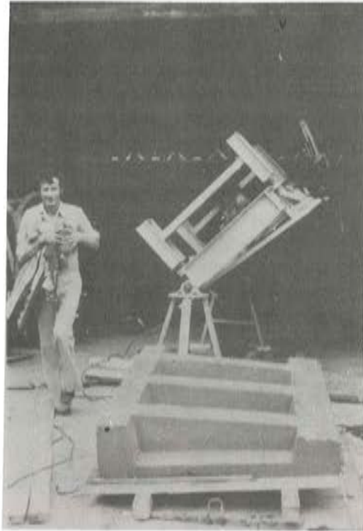
Fig. 4. Desmoldeo de las aceras
