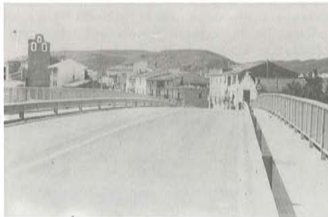
Fig. 11. Nueva plataforma del puente de Berbinzana.
