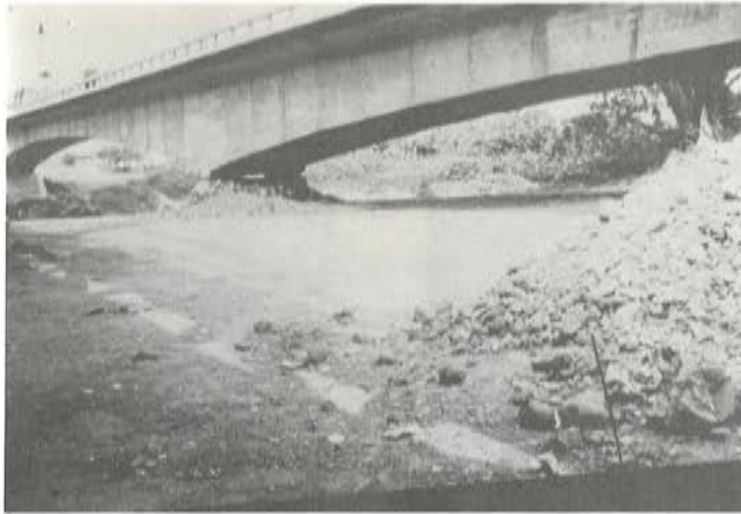
Fig. 19. Vista del puente terminado
