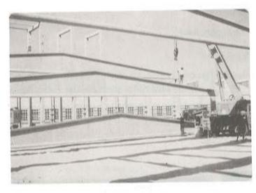
Fig. 53, Montaje de las vigas peraltadas.
