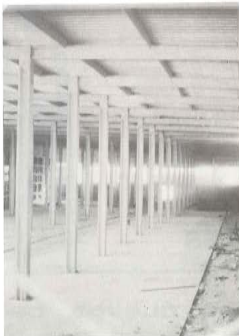
Fig. 59. Vista de la zona interior.
