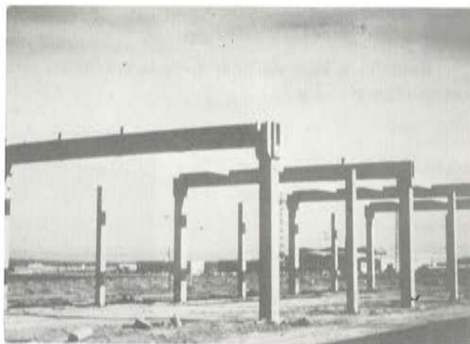
Fig. 55. La nave durante el montaje.
