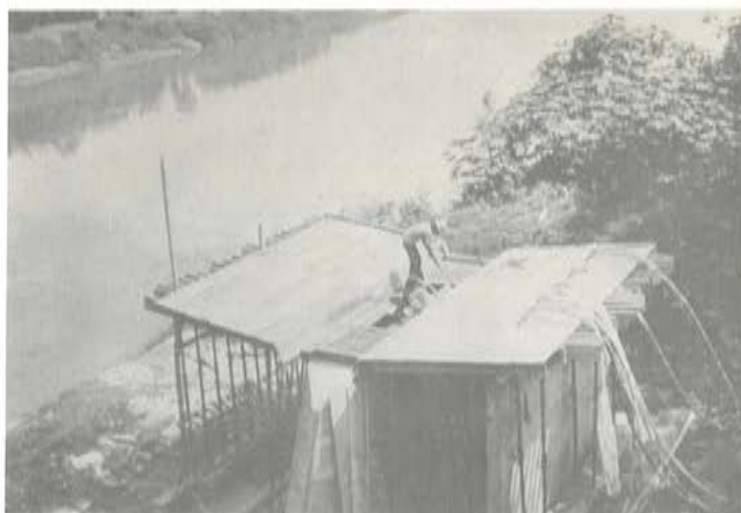
Fig. 13. Pila y pantalla de estabilidad provisional
