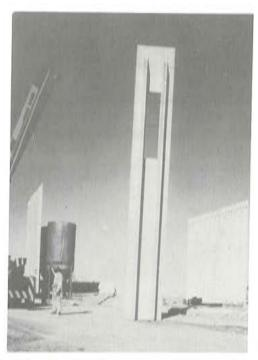
Fig. 9. Pieza de cerramiento durante su montaje.
