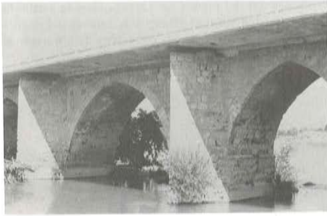
Fig. 8-a. Aspecto del puente de Miranda ensanchado.
