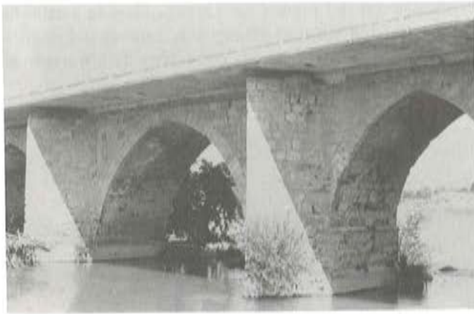
Fig. 8-a. Aspecto del puente de Miranda ensanchado.
