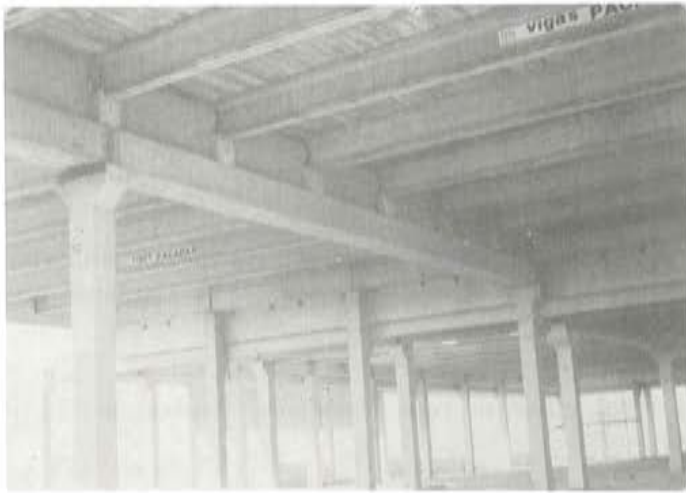
Fig. 28. Interior zona de Almacenes, en construcción.
