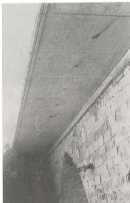
Fig. 8-b. Detalle del puente de Miranda.
