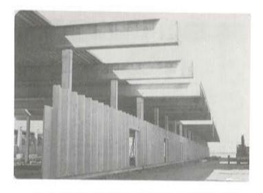
Fig. 39. Fachada con vigas en voladizo, en construcción.
