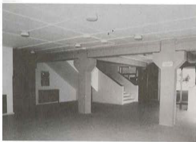
Fig. 22. Vista del interior del Edificio de Aulas.
