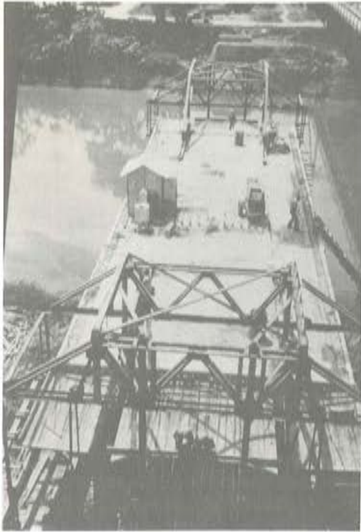
Fig. 15. Avanzando en voladizo
