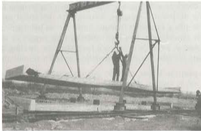
Fig. 6. Almacenamiento de placas prefabricadas
