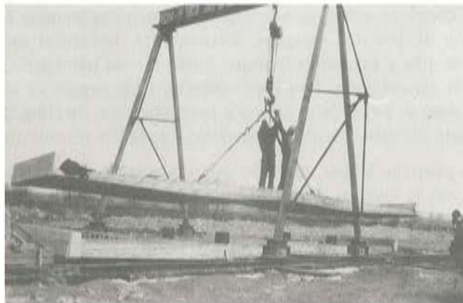
Fig. 6. Almacenamiento de placas prefabricadas
