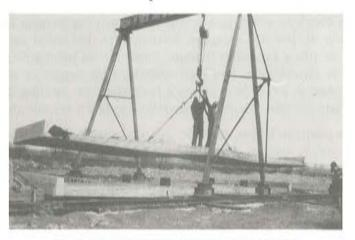
Fig. 6. Almacenamiento de placas prefabricadas
