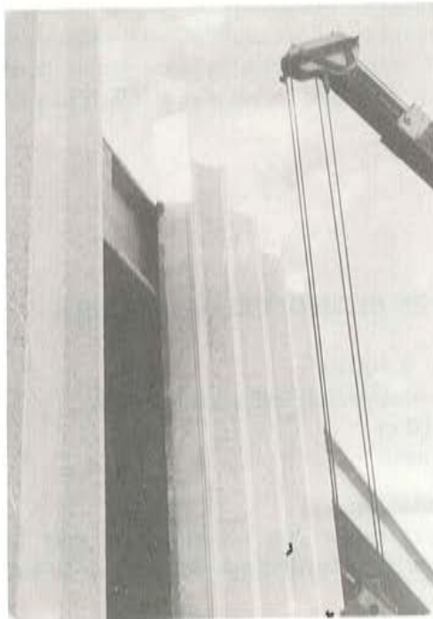
Fig. 42. Montaje de un panel.
