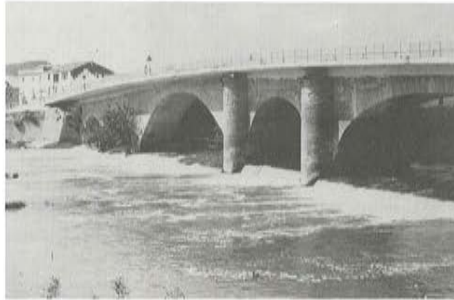
Fig. 10. Puente de Berbinzana, terminado.
