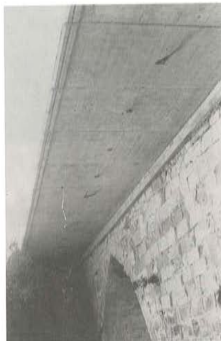
Fig. 8-b. Detalle del puente de Miranda.
