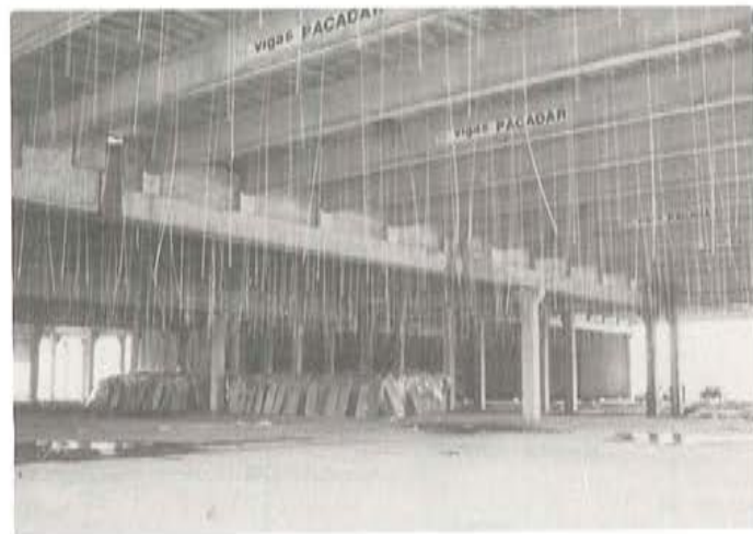
Fig. 29. Vista general interior de la estructura del Edificio de Producción y Almacenes, en construcción.
