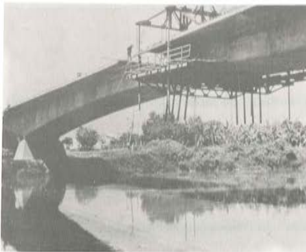
Fig. 17. Avance del carro para el hormigonado de la dovela de clave
