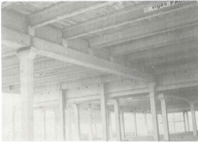
Fig. 28. Interior zona de Almacenes, en construcción.
