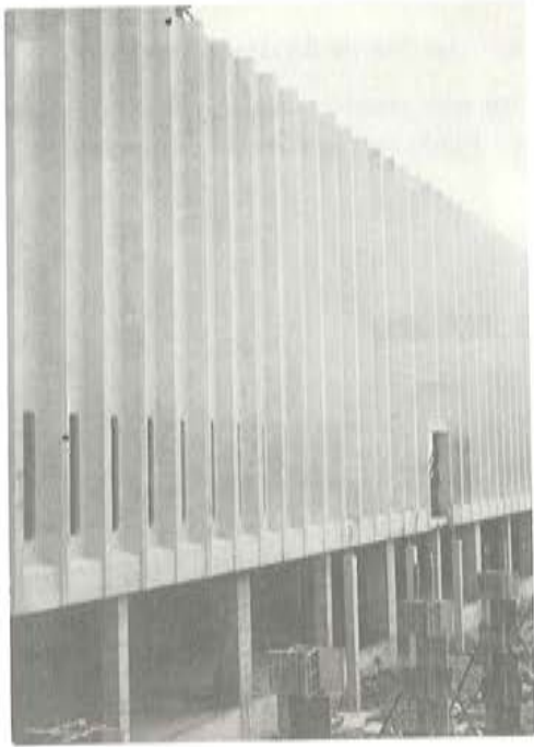
Fig. 40. Paneles de cerramiento.
