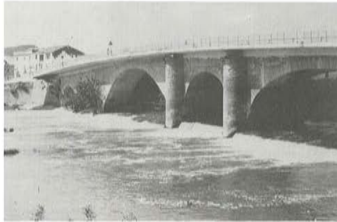
Fig. 10. Puente de Berbinzana, terminado.
