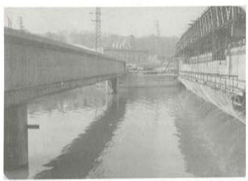
Fig. 10. Viga aguas arriba. Viga aguas abajo antes de descimbrar
