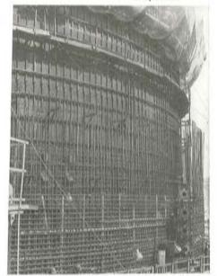
Fotografía 8: Detalle de construcción del muro del Edificio de Contención. Puede verse la chapa de revestimiento interna, las placas de anclaje en un contrafuerte y las vainas de los tendones y armaduras.
