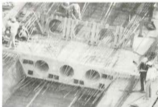
Fig. 5. Junta entre fases de construcción.
