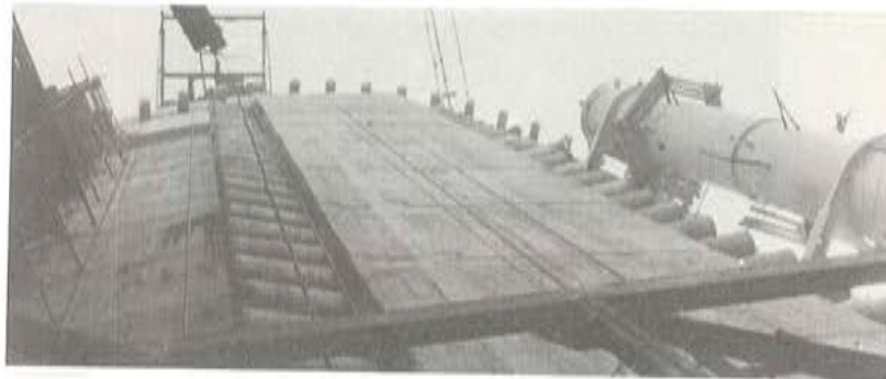
Fotografía 18. Pórtico fijo en un contrafuerte.
