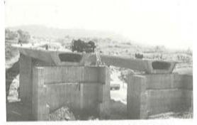
Foto 1. Viaducto de Río Mayor. Vista de los estribos durante la construcción.
