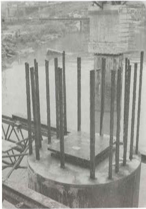
Fig. 6. Detalle apoyo en pilas.
