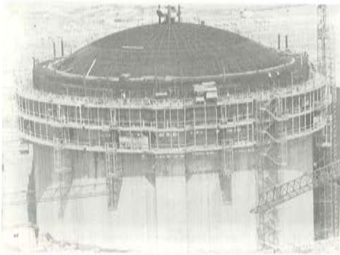
Fotografía 19: Edificio de Contención-Armadura viga anillo y capa inferior de la cúpula.
