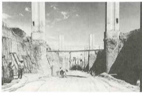
Fig. 6. Pilas y cimentaciones en la zona del metro.
