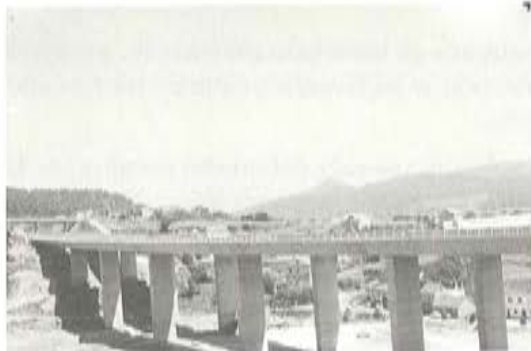
Foto 3. Viaducto de Río Mayor. Vista de la estructura terminada.
