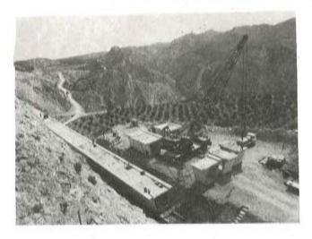
Fig. 3. Descarga y colocación de dovelas.
