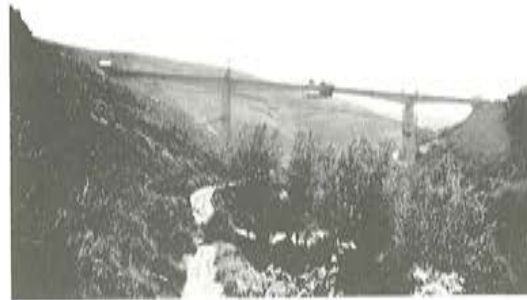
Foto 7. Viaducto de las Lamas. Construcción de la dovela de cierre del tablero.
