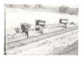
Fig. 7. Colocación de traviesas en obra mediante pórticos
