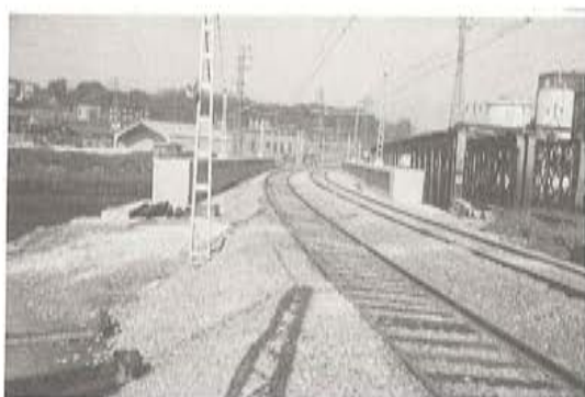
Fig. 14. Tendido de vía
