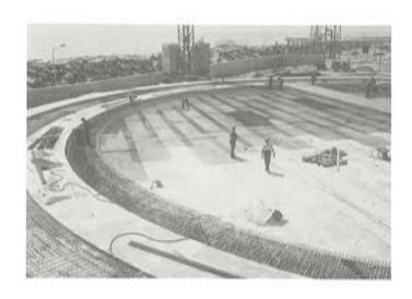
Esta cimentación lleva incorporada un sistema de calefacción eléctrica, a fin de evitar el progresivo enfriamiento del terreno.
