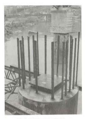
Fig. 6. Detalle apoyo en pilas.
