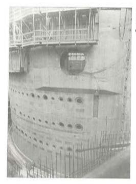
Fotografía 9: Muro del Edificio de Contención en la zona de Entrada de Personal. A la derecha el contrafuerte con las placas de apoyo de los anclajes de tendones.
