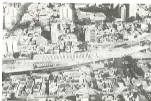
Fig. 16. Vista aérea de la pérgola durante la construcción.
