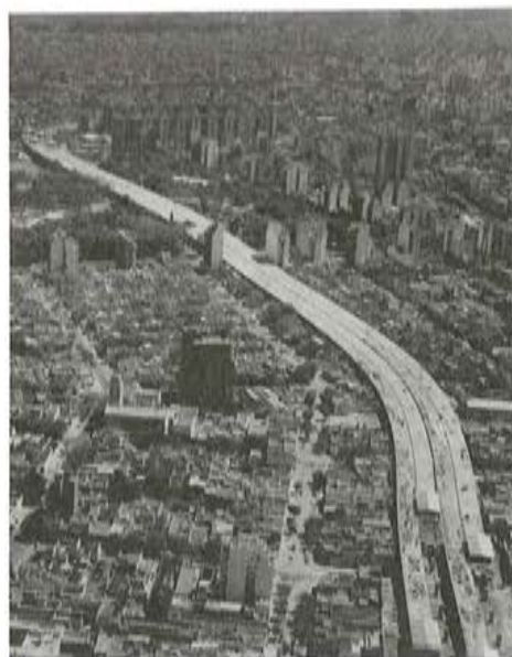
Fig. 1. Vista de una zona de la autopista durante su construcción.
