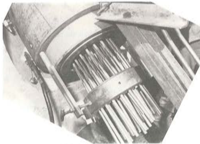
Fotografía 29. Colocación del anclaje del gato.
