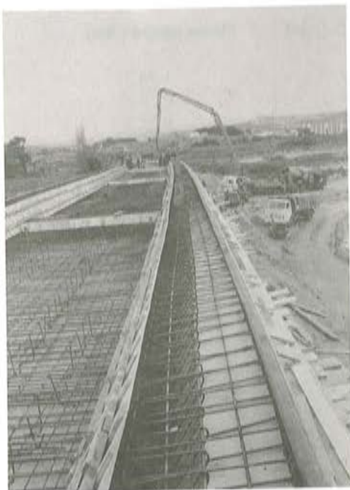
Fig. 8. Hormigonado del tablero.
