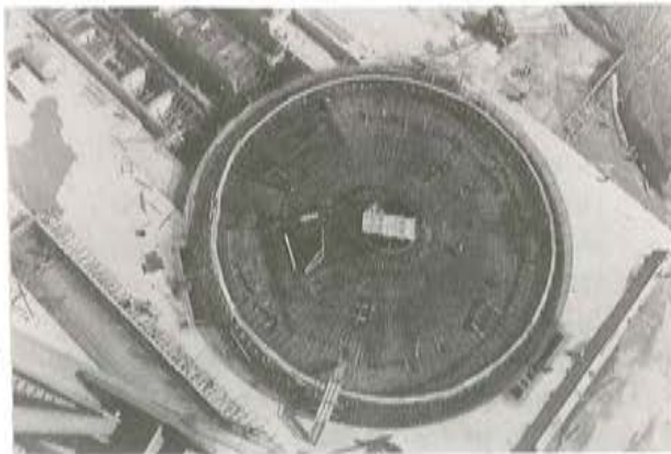
Fotografía 2: Armadura Inferior de la Base del Edificio de Contención. Vista aérea.
