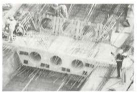
Fig. 5. Junta entre fases de construcción.
