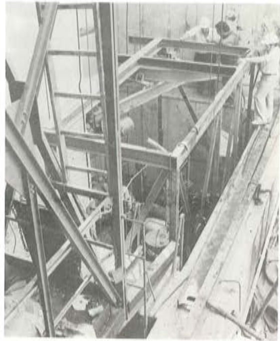
Fotografía 17. Plataforma operando dentro de un pozo al lado del contrafuerte.
