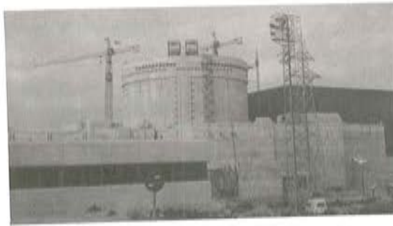
Fotografía 14. Pórticos móviles sobre la viga anillo del contenedor.
