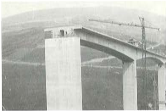
Foto 4. Viaducto de Ruitelán. Pila de unión entre puente principal y tramos de acceso, durante la construcción.
