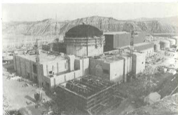
Fotografía 15: La chapa de revestimiento de la cúpula completamente montada.
