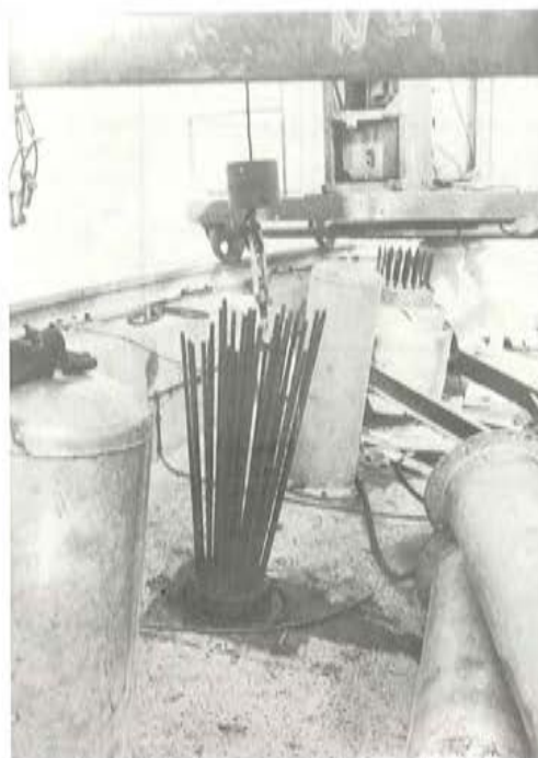
Fotografía 31. Tendones verticales en distintas fases.
