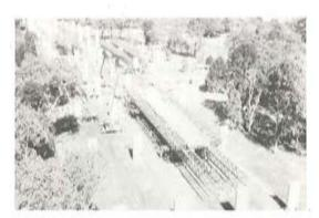
Fig. 10. Montaje de las cimbras autoportantes.
