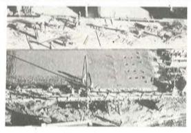
Fig. 9. Hormigonado de un tablero con los cajetines de enhebrado del pretensado de la fase siguiente.
