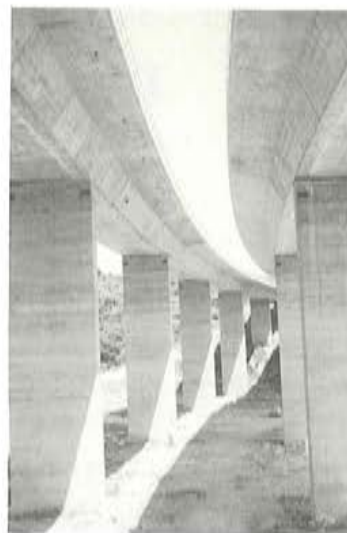
Foto 2. Viaducto de Río Mayor. Vista inferior de la estructura.
