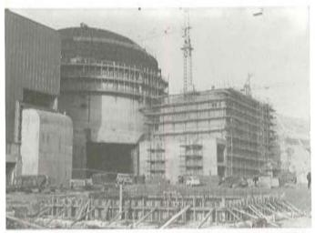
Fotografía 16: Entradas Equipos del Edificio de Contención.
