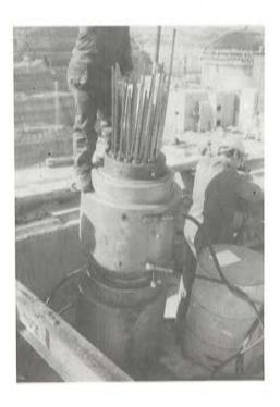
Fotografía 33. Tensando un tendón vertical.
