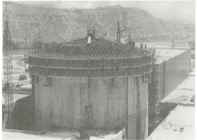
Fotografía 20: Ed. Contención—Inicio colocación vainas de los tendones inferiores de la Cúpula.
