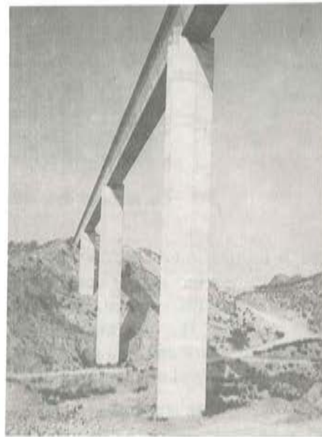
Fig. 5. Vista parcial del acueducto terminado
