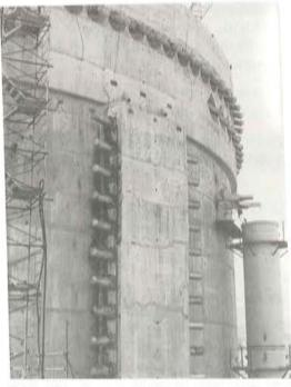
Fotografía 3. Vista de un contrafuerte al llegar a la viga anillo.
