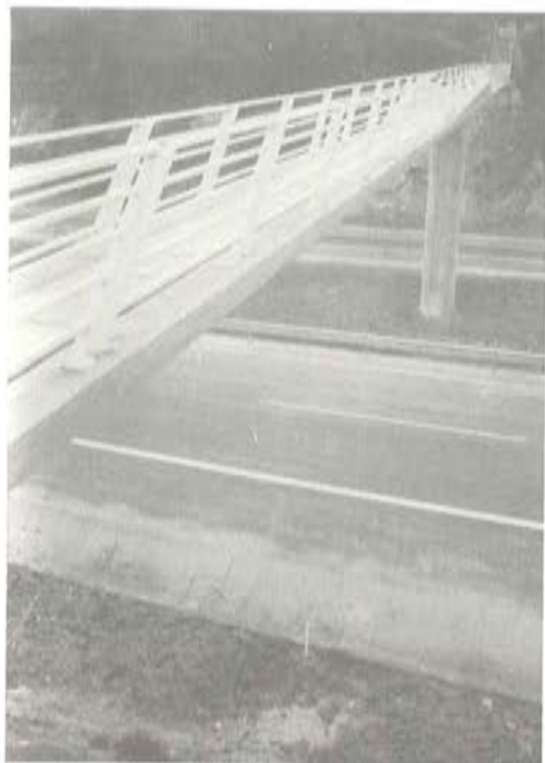
Foto 1. Paso de riego
