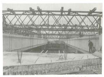
Fig. 11. Primera fase de hormigonado de la losa
