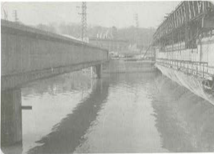
Fig. 10. Viga aguas arriba, Viga aguas abajo antes de descimbrar
