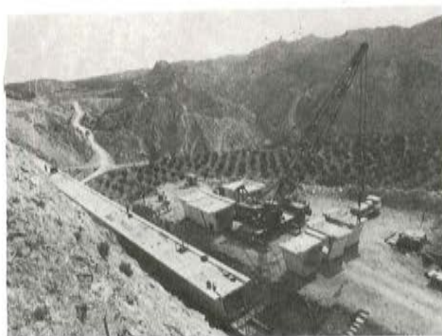
Fig. 3. Descarga y colocación de dovelas.
