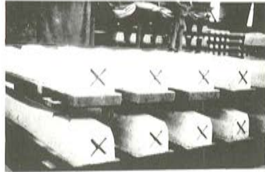
Fig. 4. Acopio de traviesas curadas que van a entrar en fase de tesado.
