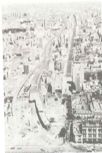
Fig. 14. Distribuidor de Ingeniero Huergo.
