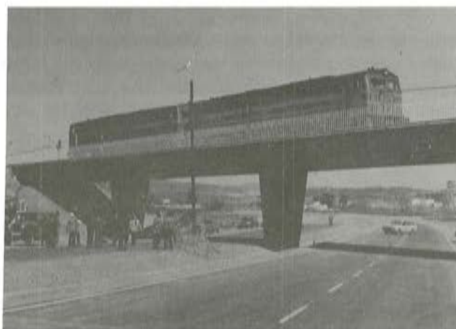
Fig. 10. Prueba de carga.
