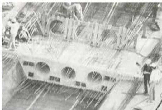
Fig. 5. Junta entre fases de construcción.
