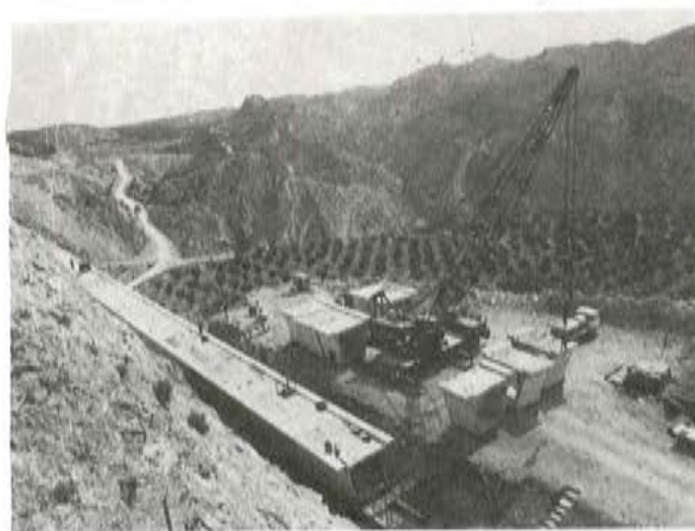
Fig. 3. Descarga y colocación de dovelas.
