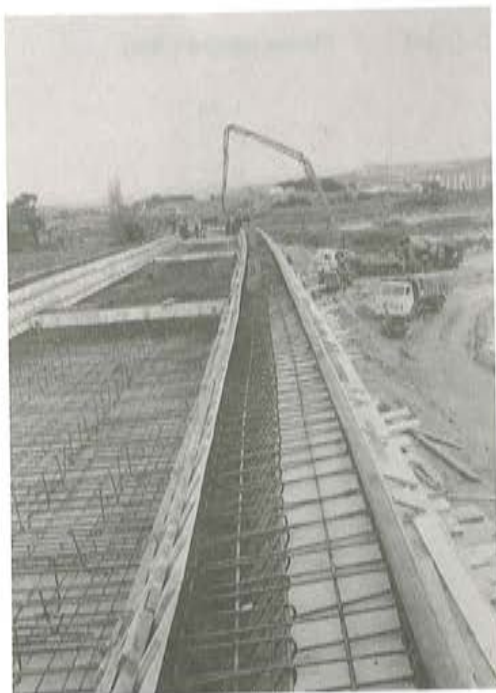
Fig. 8. Hormigonado del tablero.
