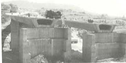
Foto 1. Viaducto de Río Mayor. Vista de los estribos durante la construcción.
