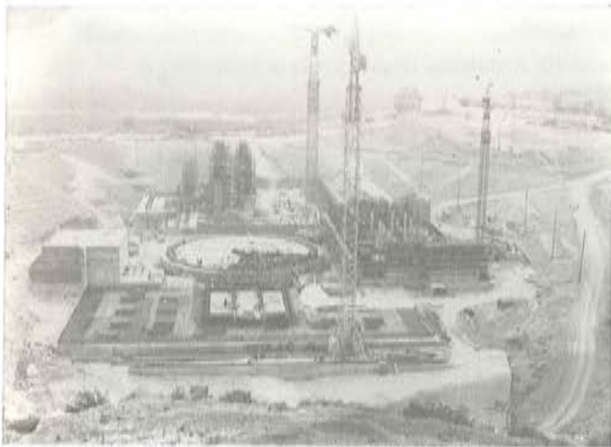
Fotografía 6: Fase de construcción Edificios Principales: Grupo I.
