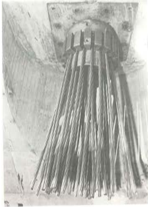
Fotografía 28. Araña de presión colocada.
