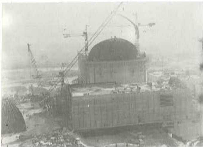
Fotografía 14: Montaje de la chapa de revestimiento de la Cúpula del Edificio de Contención. Izamiento de un gajo.
