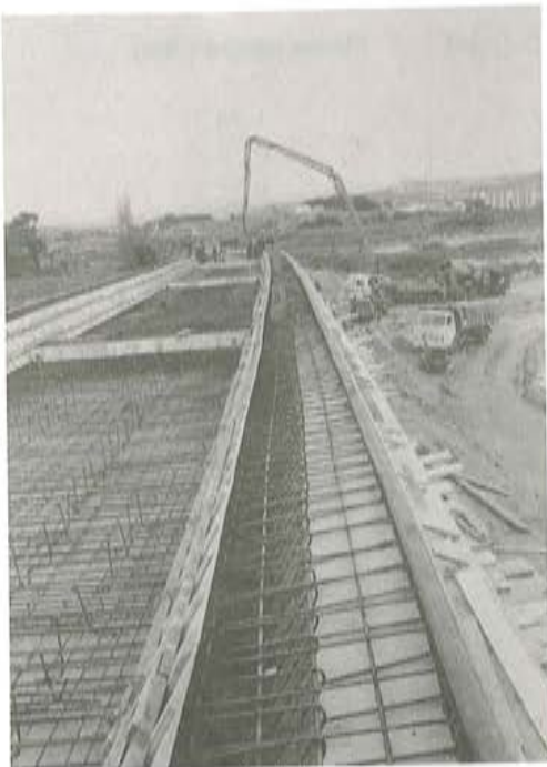
Fig. 8. Hormigonado del tablero.
