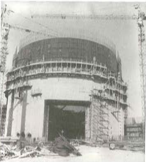
Fotografía 11: Hueco que se deja en el muro de contención para la entrada de equipos.
