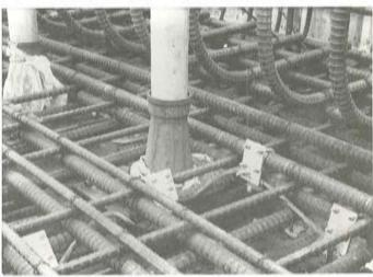
Fotografía 5: Detalle de la fotografía anterior — Trmpetas de los tendones y puesta a tierra de las armaduras,
