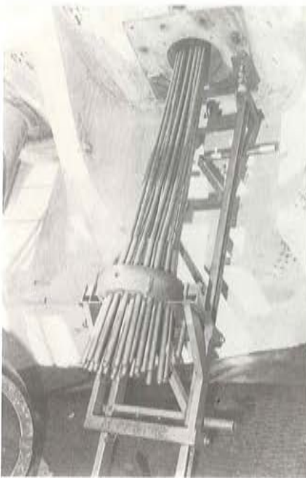
Fotografía 26. Colocación de un bloque anclaje en un tendón de la cúpula.
