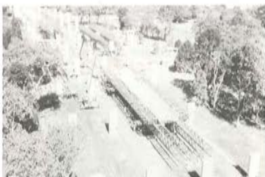
Fig. 10. Montaje de las cimbras autoportantes.
