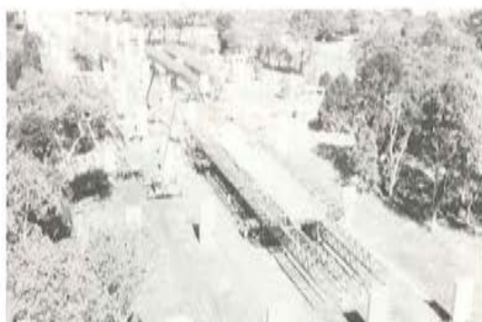
Fig. 10. Montaje de las cimbras autoportantes.
