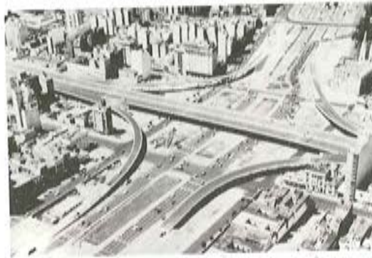
Fig. 13. Distribuidor de 9 de Julio, 1.ª Fase.
