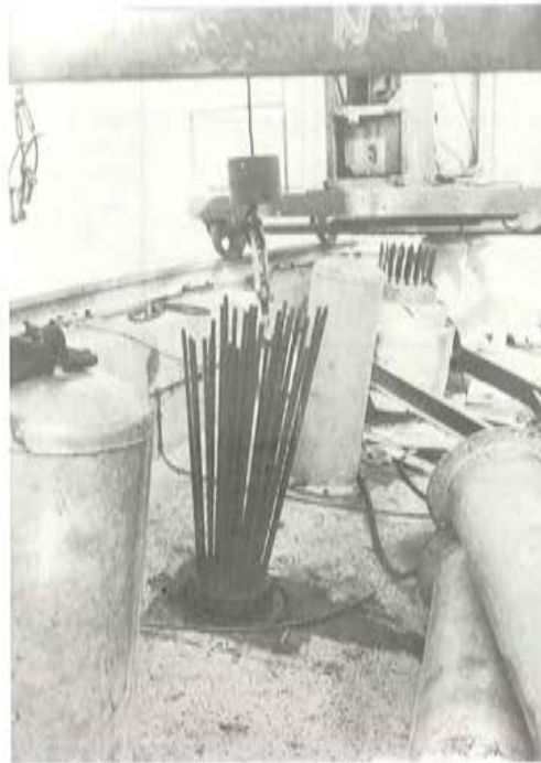
Fotografía 31. Tendones verticales en distintas fases.
