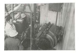
Fotografía 24. Tensando un tendón horizontal.
