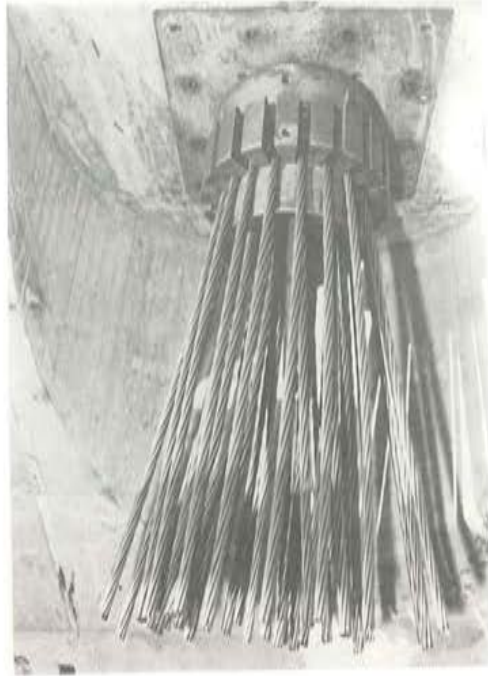
Fotografía 28. Araña de presión colocada.
