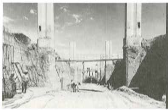
Fig. 6. Pilas y cimentaciones en la zona del metro.
