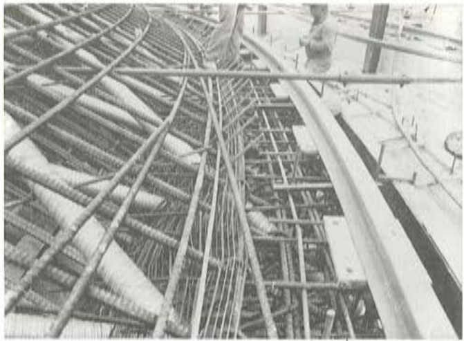
Fotografía 24: Cúpula Ed. Contención—Encofrado de una junta de hormigonado, con metal desplegado.
