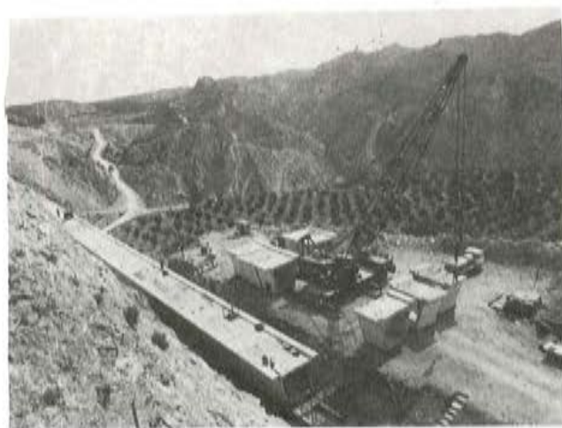
Fig. 3. Descarga y colocación de dovelas.
