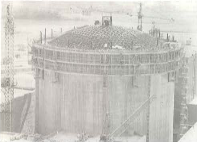
Fotografía 21: Edificio Contención—Vainas de los tendones de la cúpula terminadas.
