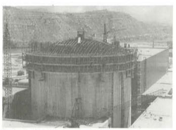
Fotógrafía 20: Ed. Contención—Inicio colocación vainas de los tendones inferiores de la Cúpula.
