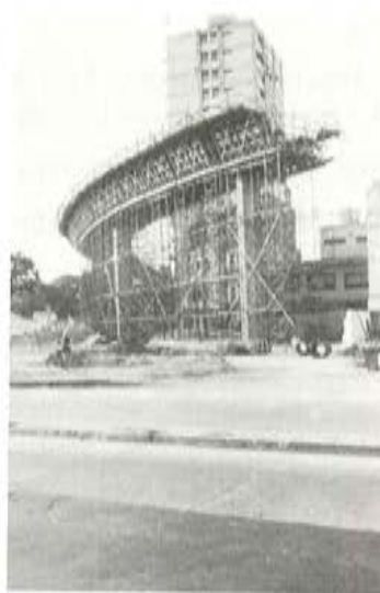
a) construcción sobre cimbre
