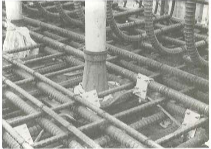
Fotografía 5: Detalle de la fotografía anterior – Trmpetas de los tendones y puesta a tierra de las armaduras.
