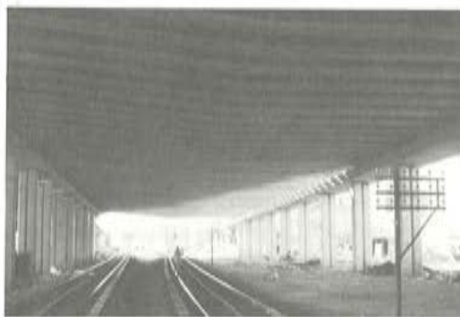
Fig. 17. Vista inferior de la pérgola.
