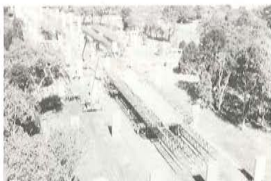
Fig. 10. Montaje de las cimbras autoportantes.
