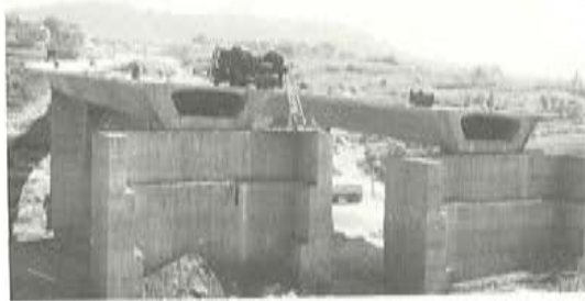
Foto 1. Viaducto de Río Mayor. Vista de los estribos durante la construcción.
