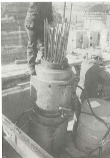
Fotografía 33. Tensando un tendón vertical.
