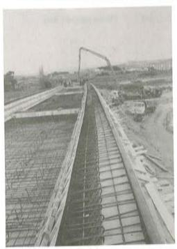
Fig. 8. Hormigonado del tablero.
