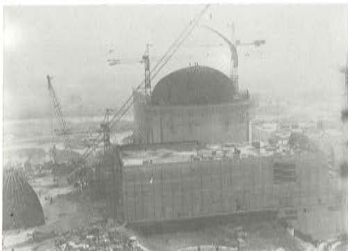
Fotografía 14: Montaje de la chapa de revestimiento de la Cúpula del Edificio de Contención. Izamiento de un gajo.
