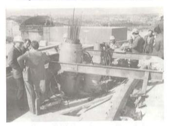
Fotografía 32. Tensando un tendón vertical.
