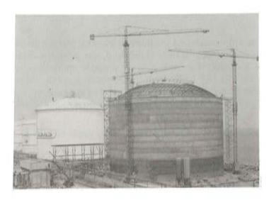
Para su construcción se ha presurizado el tanque a una presión admisible para la chapa de la cúpula, evitando que el peso del hormigón fresco fuese soportado por la estructura metálica.
