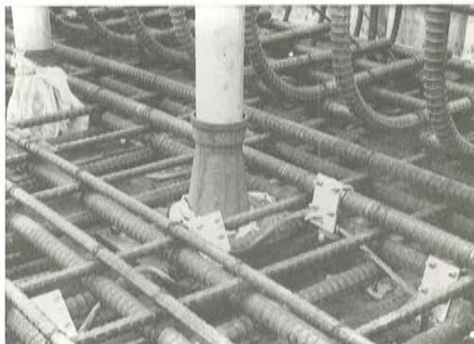
Fotografía 5: Detalle de la fotografía anterior — Trmptetas de los tendones y puesta a tierra de las armaduras.
