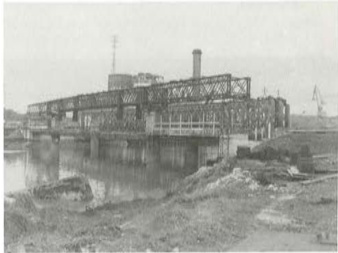
Fig. 7. Viga aguas arriba. Cimbra, encofrado talón en vanos laterales.
