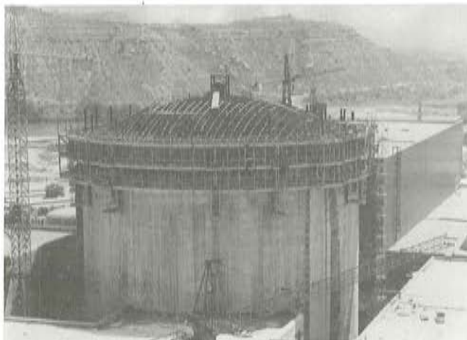
Fotografía 20: Ed. Contención—Inicio colocación vainas de los tendones inferiores de la Cúpula.
