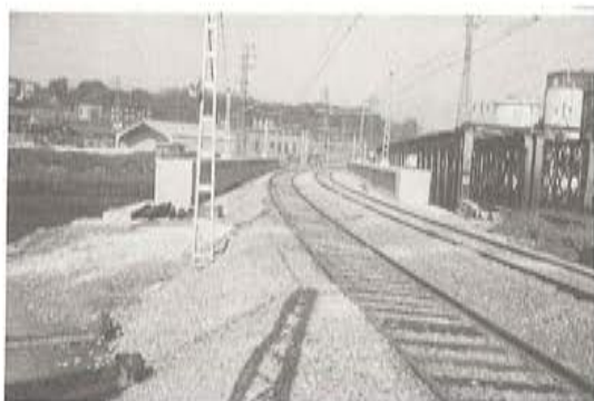
Fig. 14. Tendido de vía
