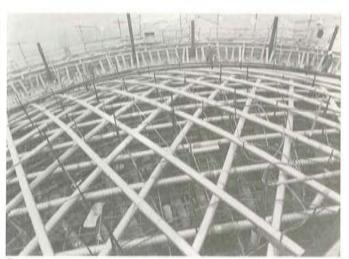
Fotografía 22: Detalle de las vainas de las tres capas de tensones de la cúpula.
