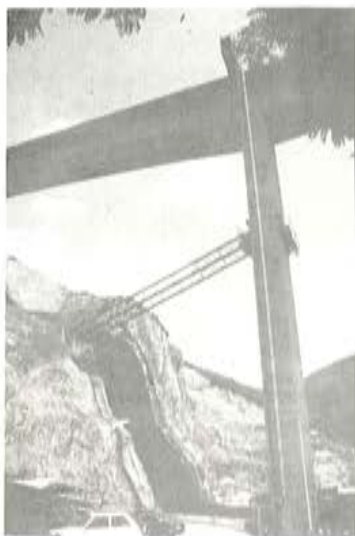
Foto 6. Viaducto de las Lamas. Apuntalamiento provisional de una pila durante la construcción.
