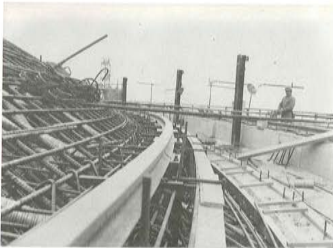
Fotografía 23: Cúpula Ed. Contención—Detalle colocación del riel para la soldadura de póticos móviles.
