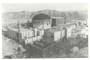
Fotografía 15: La chapa de revestimiento de la cúpula completamente montada.
