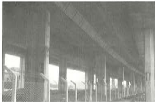
Fig. 4. Vista inferior del viaducto.
