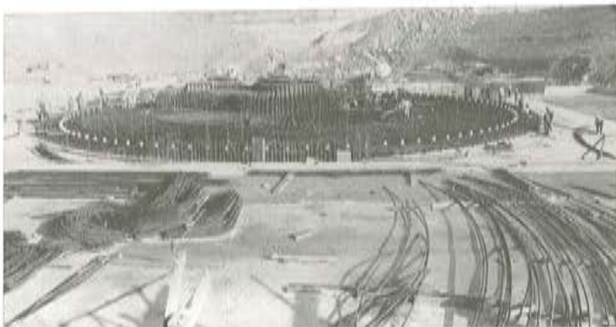
Fotografía 3: Armadura Inferior de la Base del Edificio de Contención. Vista de Perfil.
