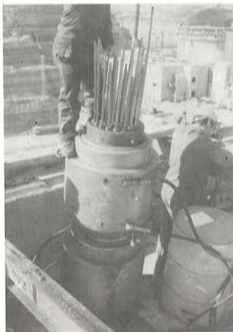
Fotografía 33. Tensando un tendón vertical.
