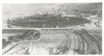
Fotografía 3: Armadura Inferior de la Base del Edificio de Contención. Vista de Perfil.
