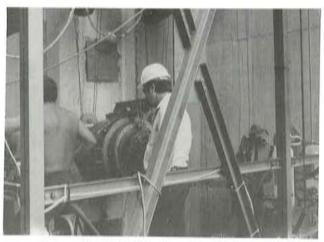
Fotografía 25. Tensando un tendón horizontal.
