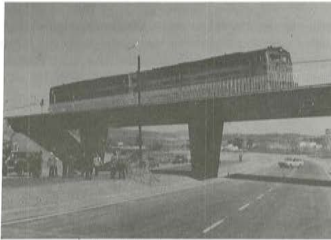
Fig. 10. Prueba de carga.
