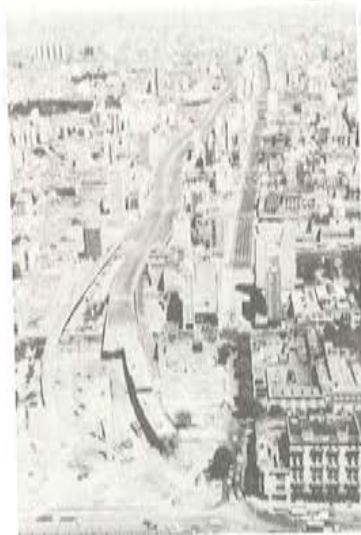
Fig. 14. Distribuidor de Ingeniero Huergo.
