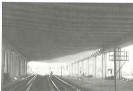
Fig. 17. Vista inferior de la pérgola.
