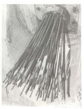
Fotografía 27. Inicio colocación de las cuñas de anclaje.
