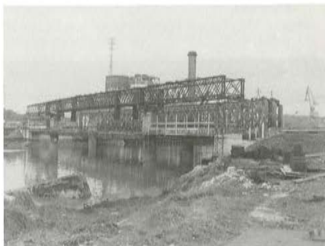
Fig. 7. Viga aguas arriba. Cimbra, encofrado talón en vanos laterales.
