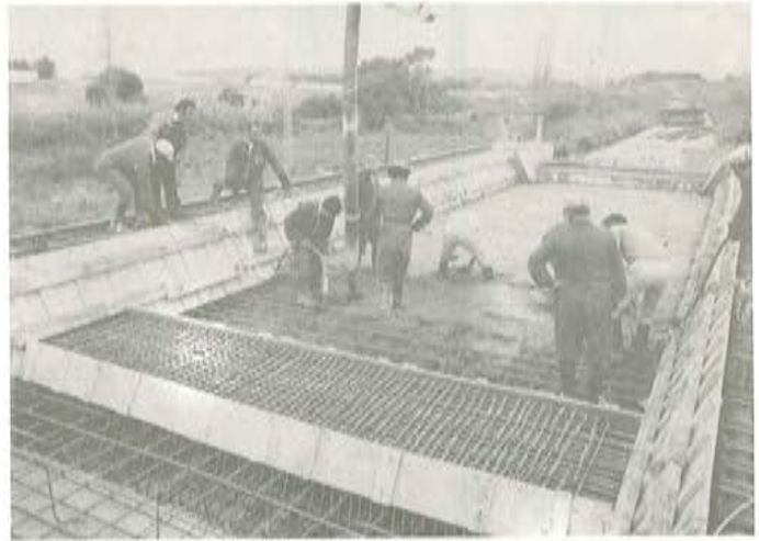
Fig. 7. Riostra sobre pilas.
