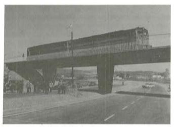
Fig. 10. Prueba de carga.
