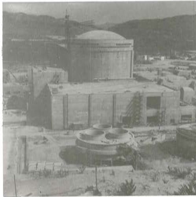
Fotografía 2. Edificio de Contención detrás del Edificio Auxiliar.
