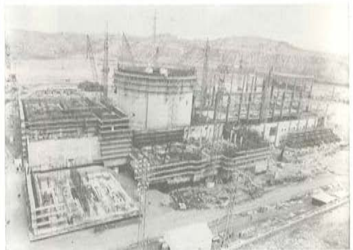
Fotografía 7: Fase de construcción Edificios Principales Grupo II.
