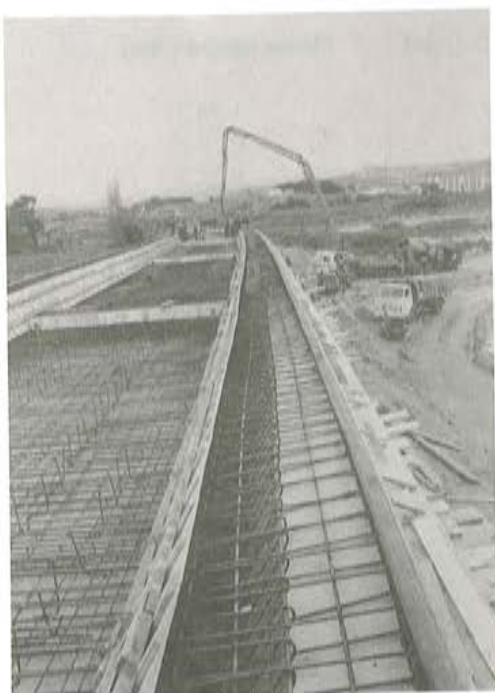
Fig. 8. Hormigonado del tablero.
