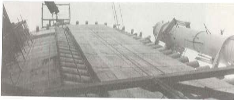
Fotografía 18. Pórtico fijo en un contrafuerte.
