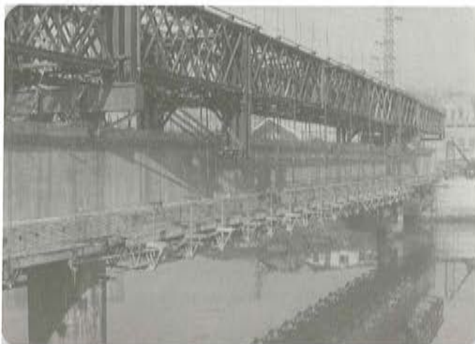
Fig. 8. Viga aguas arriba, antes de desencofrar el fondo.
