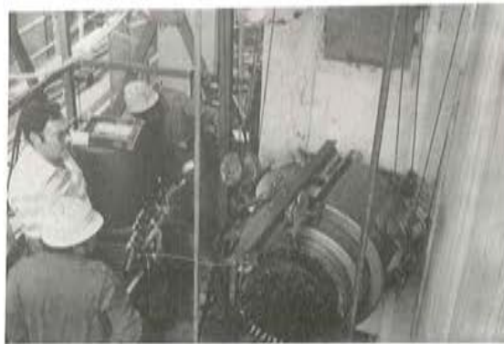
Fotografía 24. Tensando un tendón horizontal.
