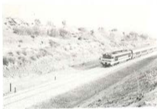
Fig. 9. Tramo en servicio.
