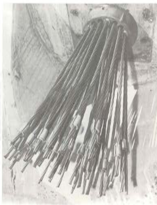
Fotografía 27. Inicio colocación de las cuñas de anclaje.
