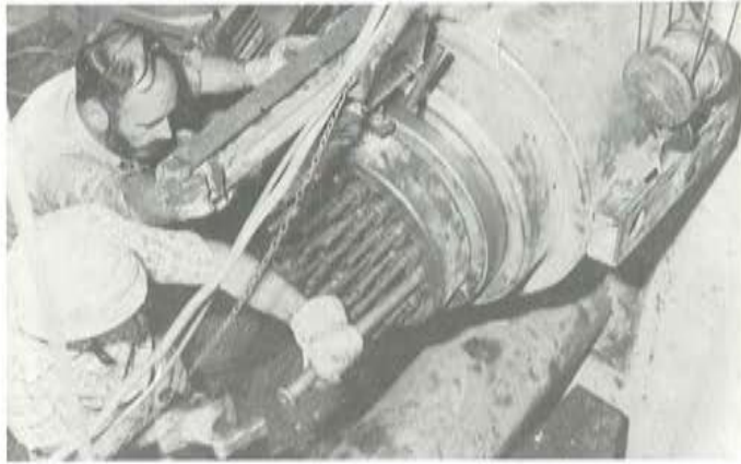
Fotografía 22. Apretando las cuñas de anclaje en el gato.
