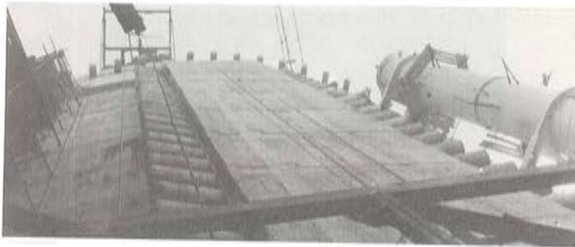
Fotografía 18. Pórtico fijo en un contrafuerte.
