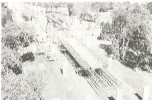
Fig. 10. Montaje de las cimbras autoportantes.
