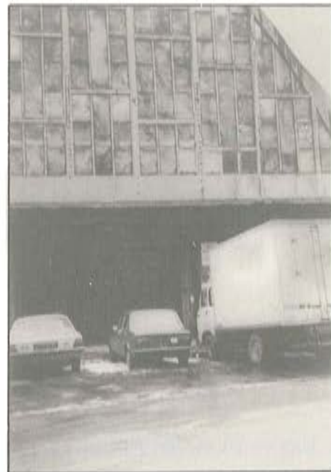
Fotografía 2. Aspecto de uno de los hastiales de la gran nave central, con sus lucernarios realizados con numerosos y finos maineles de hormigón armado.
