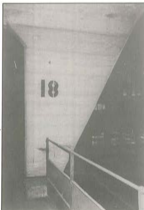
Fotografía 3. Pilar de sección variable y alzado triangular. Se puede apreciar la colocación de una red para impedir que los fragmentos del recubrimiento del hormigón que se desprenden puedan dañar a las personas que transitan por su interior.
