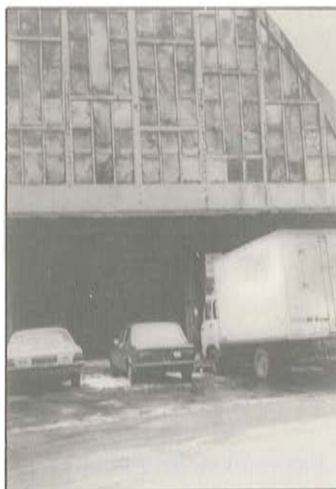
Fotografía 2. Aspecto de uno de los hastiales de la gran nave central, con sus lucernarios realizados con numerosos y finos maineles de hormigón armado.
