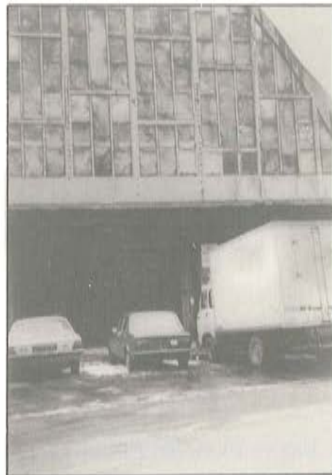
Fotografía 2. Aspecto de uno de los hastiales de la gran nave central, con sus lucernarios realizados con numerosos y finos maineles de hormigón armado.
