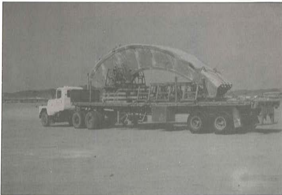
Foto 3. Transporte a obra de los moldes
