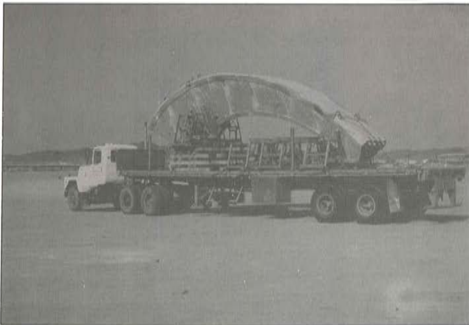
Foto 3. Transporte a obra de los moldes
