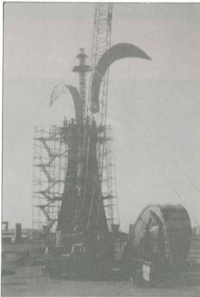
Foto 7. Sujeción, con cables, del andamiaje auxiliar.
