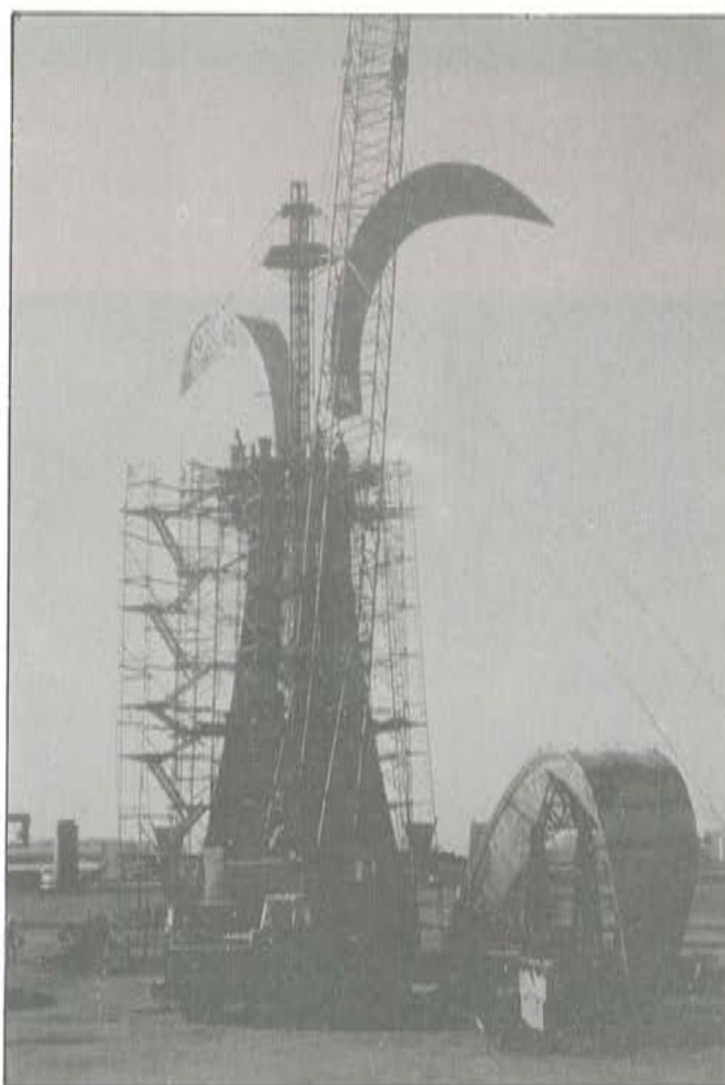
Foto 7. Sujeción, con cables, del andamiaje auxiliar.
