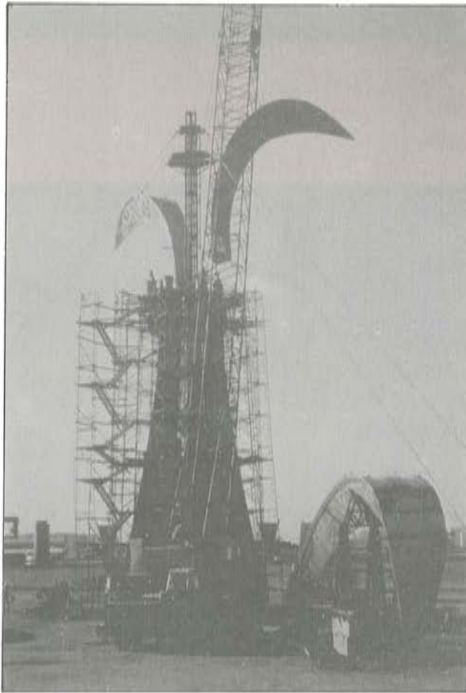
Foto 7. Sujeción, con cables, del andamiaje auxiliar.
