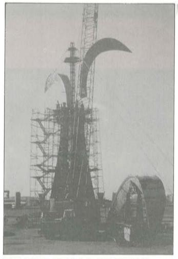
Foto 7. Sujeción, con cables, del andamiaje auxiliar.
