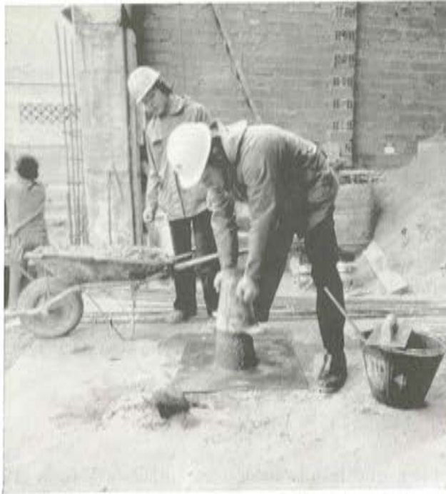
Fig. 1. Toma de muestras y determinación de la temperatura del hormigón fresco.
