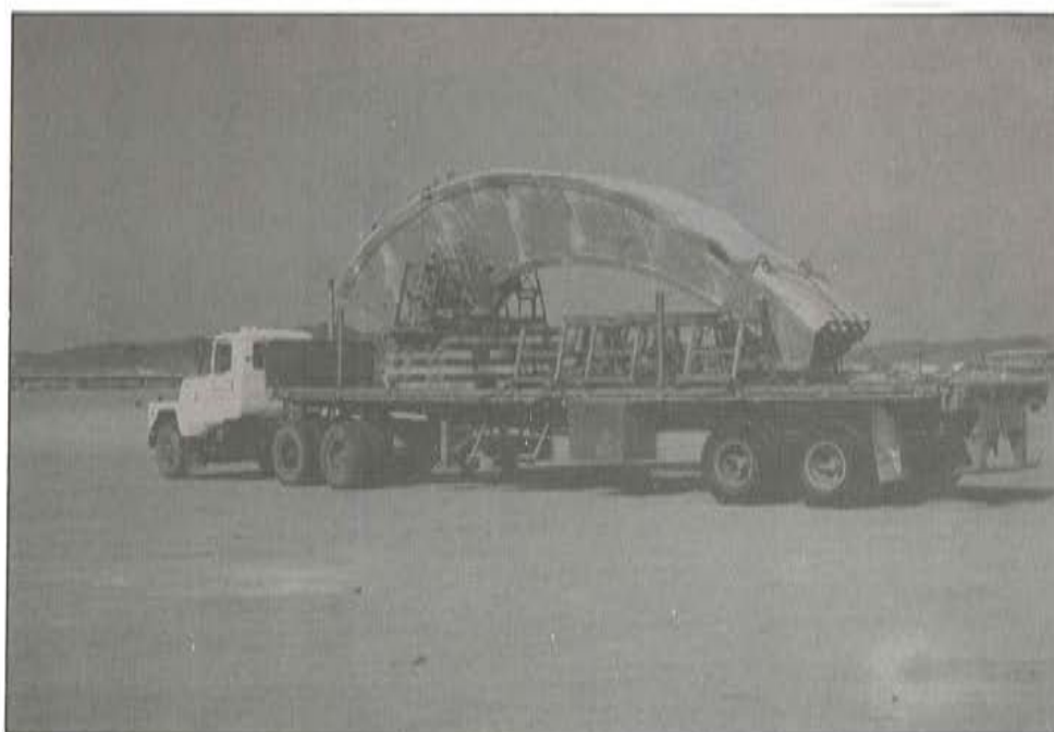
Foto 3. Transporte a obra de los moldes
