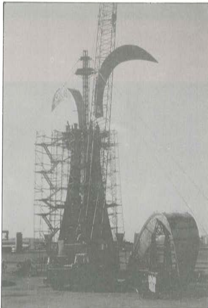
Foto 7. Sujeción, con cables, del andamiaje auxiliar.
