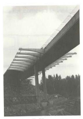
Fig. 3.5. La viga cajón se hormigona en primera fase. Las costillas prefabricadas se colocan por medio de una pequeña grúa móvil que se mueve sobre la viga cajón. Entre ellas se disponen placas prefabricadas, se hormigona la losa superior y se completa el pretensado transversal del tablero.
