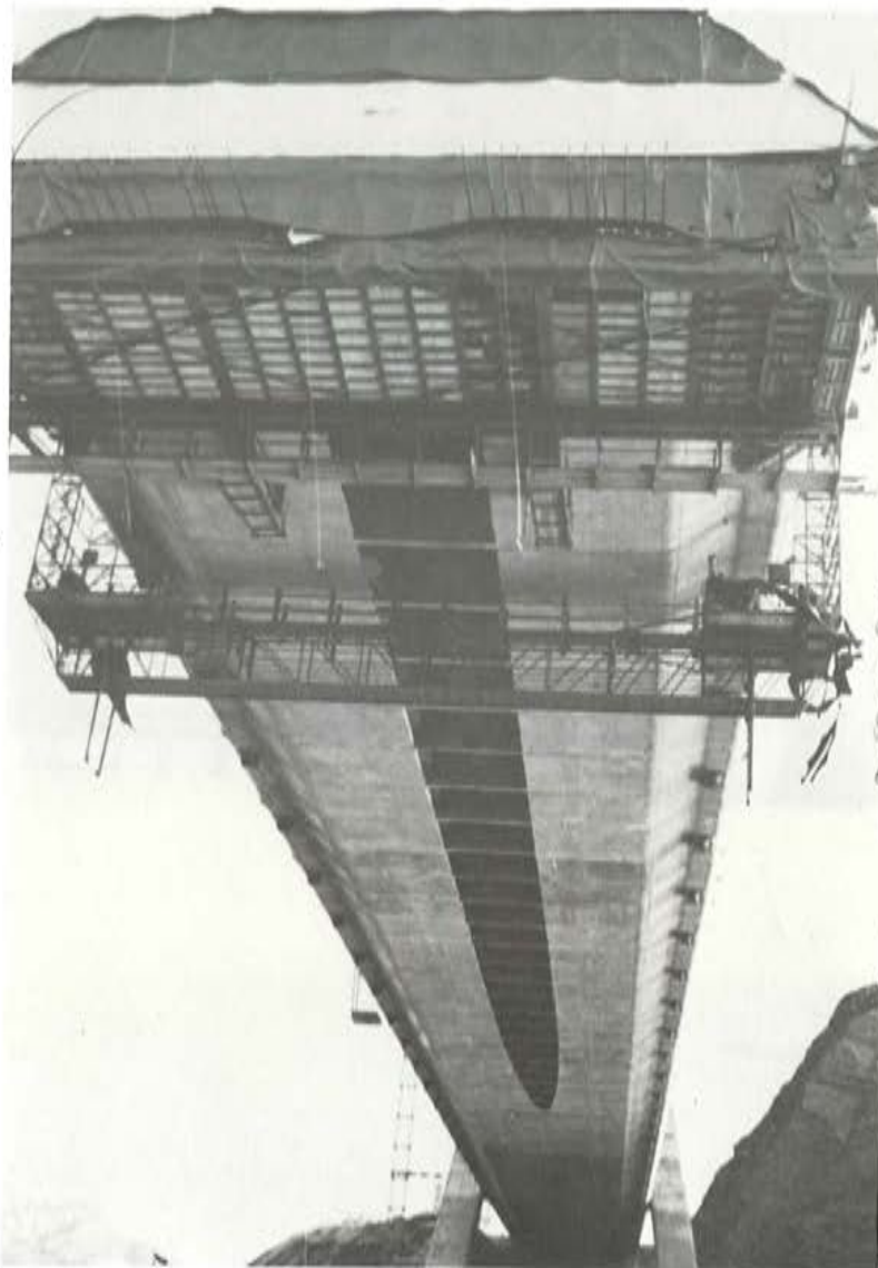
Fig. 2.22. Vista inferior del tablero durante la construcción en avance en voladizo. Junto al carro principal cerrado, se ve un pequeño carro de acompañamiento, donde se alojaban los gatos de puesta en carga total de los tirantes y servía para repasar el tablero en su parte inferior.
