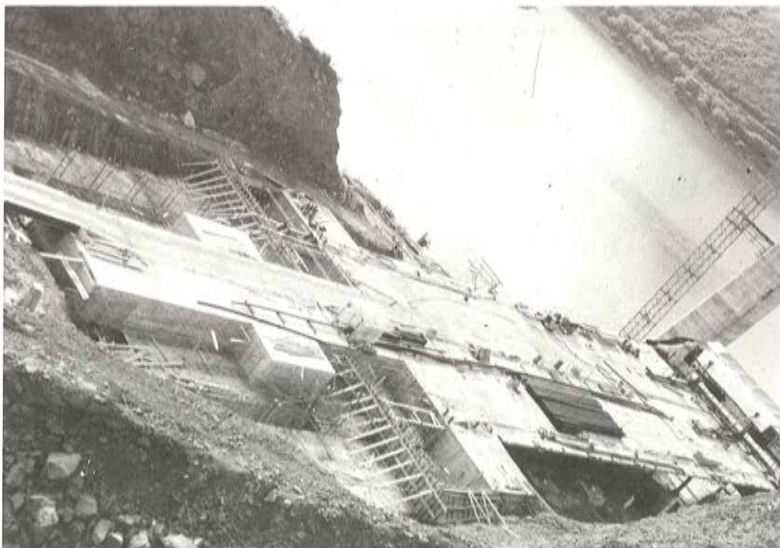
Fig. 2.13. Construcción del contrapeso.
