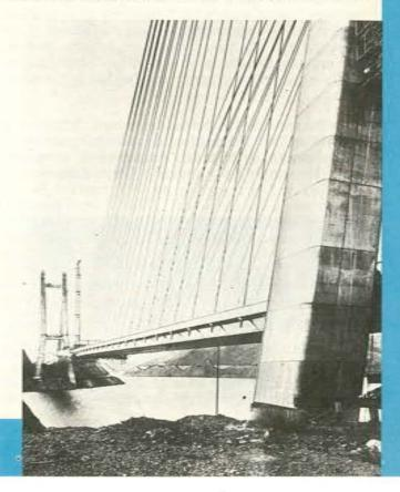
ferentes maneras de realizar la fundación de las pilas. La de la margen derecha, descansa sobre una zapata corrida de 44,00 m de largo, 15,00 m de ancho y una altura variable entre 10,00 m y 19,00 m, mientras que la de la margen izquierda presenta zapatas independientes para cada uno de los fustes de 10,00 m x 15,00 m y 6,00 m de altura.
