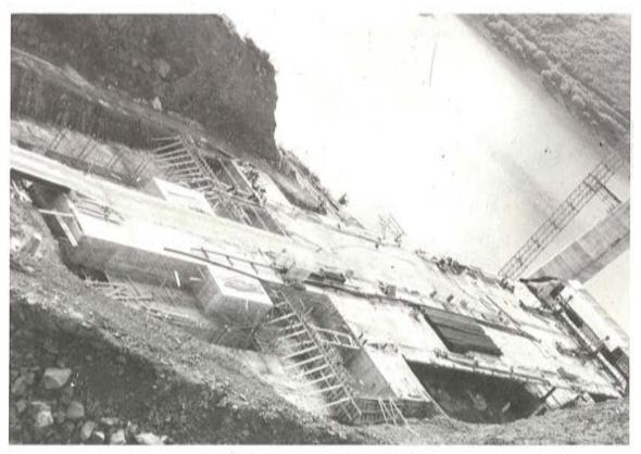
Fig. 2.13. Construcción del contrapeso.
