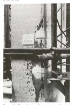
Foto 5. Esta fotografía corresponde al aspecto exterior que tenían algunos pilares de la mencionada obra y en los que todavía no se había quitado el enlucido. Se pueden observar las grietas exteriores debidas a la expansión de la armadura.
