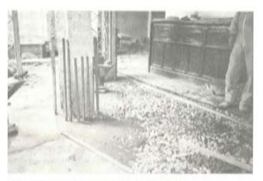
Foto 11. En la presente fotografía se aprecia una vista superior de un nudo con la armadura de continuidad sobresaliendo adosada al pilar superior que posteriormente también se reforzará. Además se puede observar el mortero de la inyección aflorando en la superficie de la grava.
