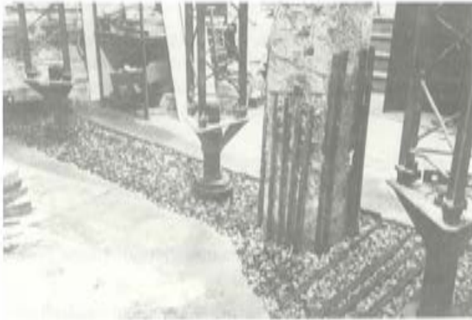
Foto 10. En la presente fotografía se puede ver una vista superior de un nudo con la armadura de continuidad del tubo sobresaliendo adosada al pilar superior que posteriormente también se reforzará. Al mismo tiempo se puede ver en la fotografía una viga rellena de grava que está preparada para ser inyectada con hormigón Prepakt.
