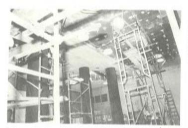
Foto 6. En esta fotografía se pueden ver tres pilares reforzados mediante un zunchado cilíndrico, También se pueden ver unas vigas anchas que, junto con los pilares constituyen un agfuerzo integral de la estructura.
