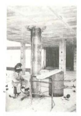
Foto 8, En esta fotografía se puede apreciar un pilar reforzado mediante un zunchado cilíndrico en una estructura normal de edificación constituida a base de forjados bidireccionales.
