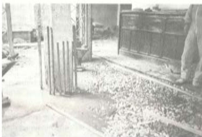
Foto 11. En la presente fotografía se aprecia una vista superior de un nudo con la armadura de continuidad sobresaliendo adosada al pilar superior que posteriormente también se reforzará. Además se puede observar el mortero de la inyección aflorando en la superficie de la grava.
