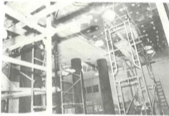
Foto 6. En esta fotografía se pueden ver tres pilares reforzados mediante un zunchado cilíndrico. También se pueden ver unas vigas anchas que, junto con los pilares constituyen un refuerzo integral de la estructura.
