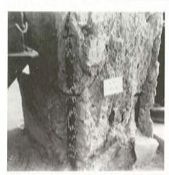
Foto 2. En esta fotografía se aprecia el estado de degradación tan avanzado en que se encontraba el hormigón de un pilar, juntamente con la corrosión total de las armaduras.
