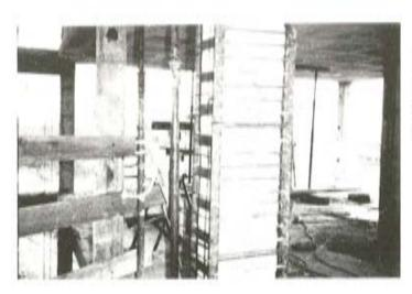
Foto 16. En la presente fotografía se puede ver un zunchado paralepipédico de un pilar en el que el empresillado metálico se ha sustituido en dos de sus caras por redondos de acero laminado para disminuir al máximo el espesor del recrecido en las mismas.
