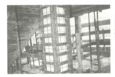
Foto 14. En esta fotografía se puede ver el empresillado metálico correspondiente a un zunchado paralepipédico de un pilar, que posteriormente quedó embebido en un recrecido de hormigón Prepakt de 5 cm de espesor total.
