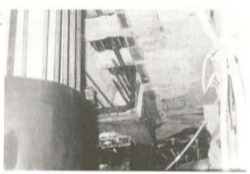
Foto 9. En la presente fotografía se puede ver una vista inferior de un nudo con la armadura de continuidad del tubo a través del mismo.
