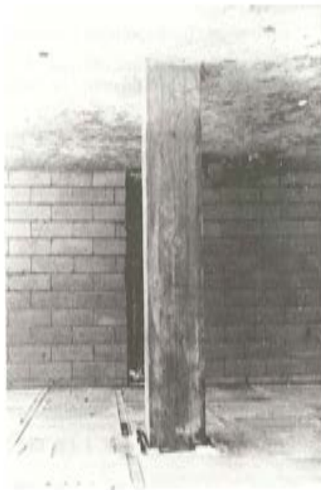
Foto 15. Esta fotografía muestra un pilar reforzado con un zunchado paralelepípedo, como el indicado en la fotografía anterior, una vez que se terminó de ejecutar el refuerzo,
