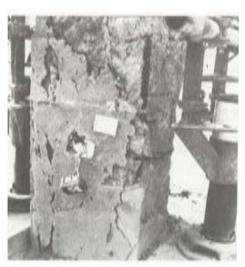
Foto 4. En esta fotografía, además de una fuerte degradación del hormigón junto con una corrosión muy avanzada de las armaduras, se peude observar un enfoscaso superficial del pilar sin fines estructurales.
