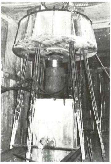
Prueba de carga de un pilote.
