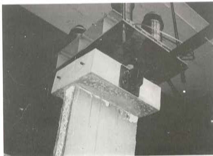
Fig. 5. Aspecto de la biela metálica dispuesta para garantizar la intraslacionalidad horizontal de la cabeza superior del panel.
