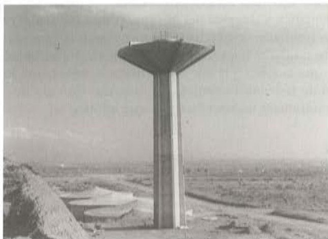
Polígono Industrial de Lorca, Depósito de agua. SAPRELORCA.
