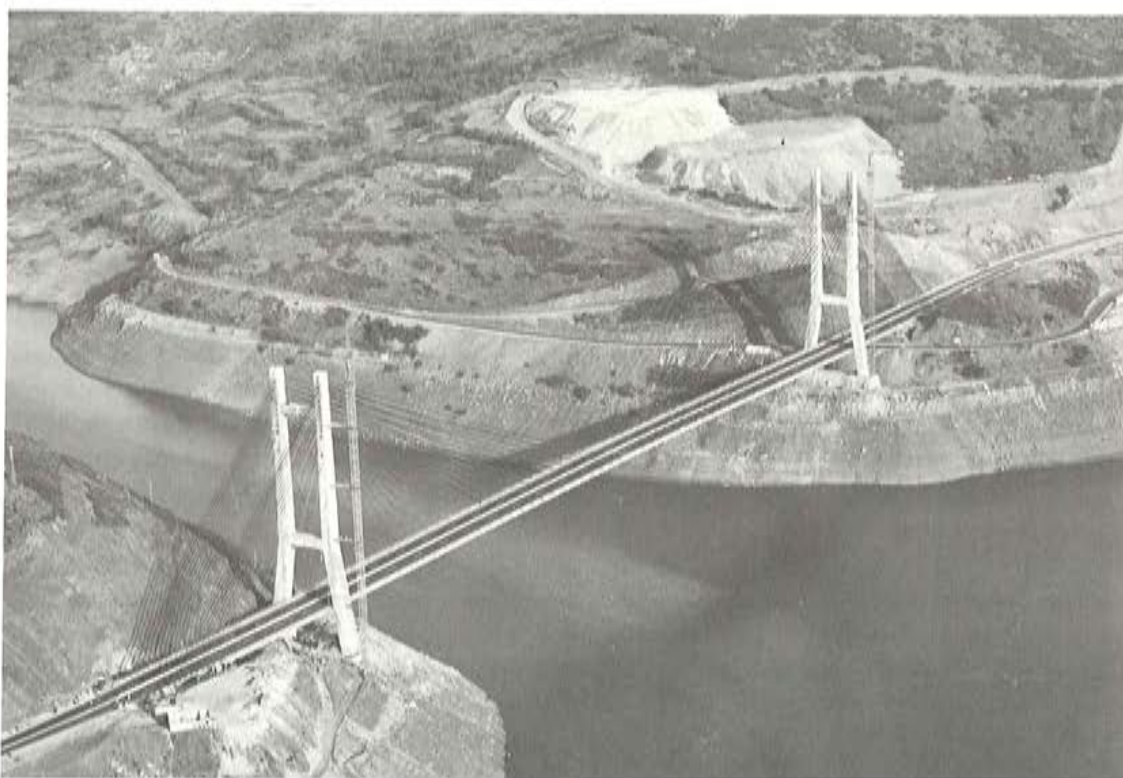
Puente Ingeniero Carlos Fernández Casado sobre el Embalse Barrios de Luna.
