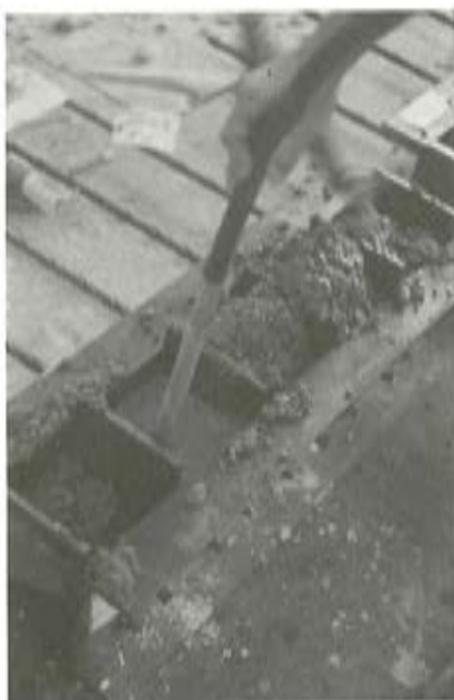
Foto 4. Vertido y compactación del hormigón.
