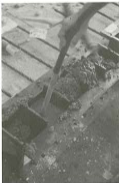
Foto 4. Vertido y compactación del hormigón.
