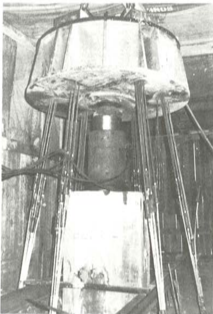
Prueba de carga de un pilote.
