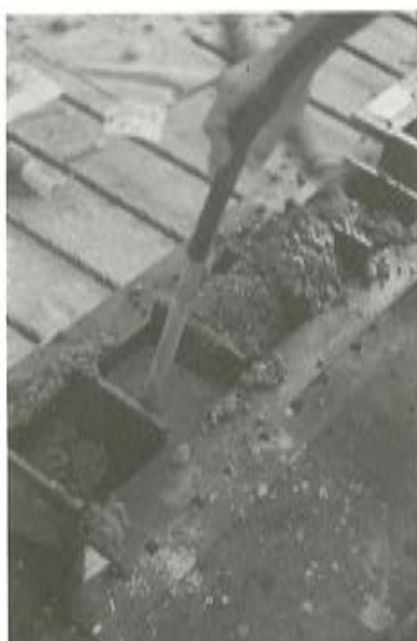
Foto 4. Vertido y compactación del hormigón.
