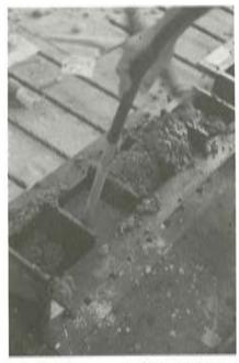
Foto 4. Vertido y compactación del hormigón.
