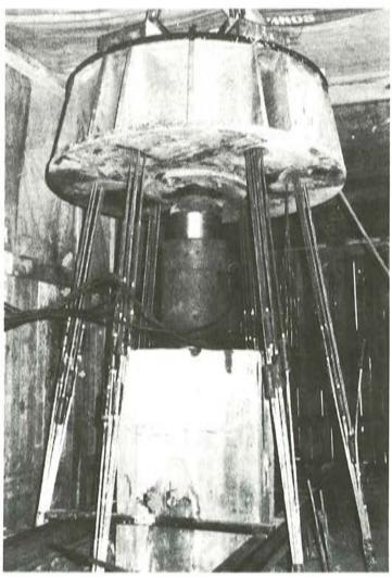
Prueba de carga de un pilote.
