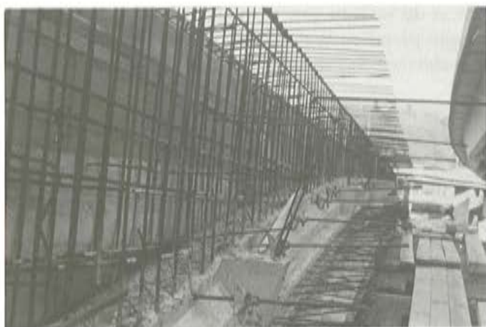
Fig. 13. Arco de borde en proceso de llenado.
