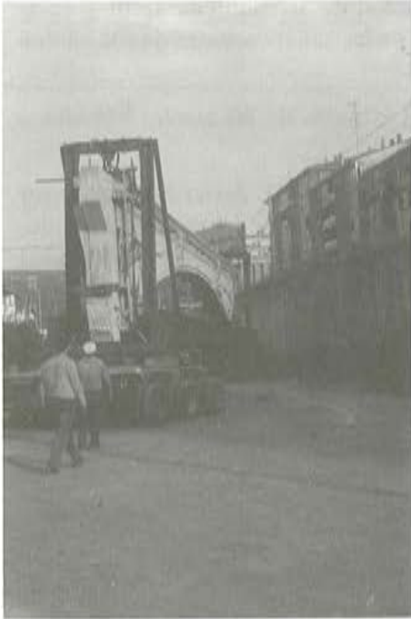
Fig. 14. Vista del transporte de un arco-tímpano.
