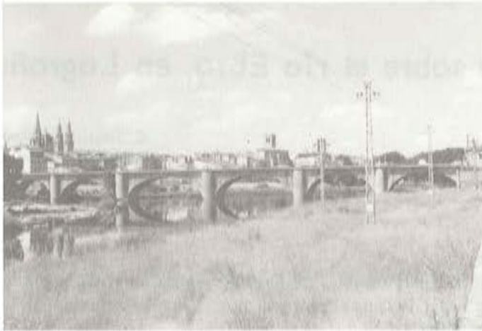
Fig. 1. Puente de piedra.
