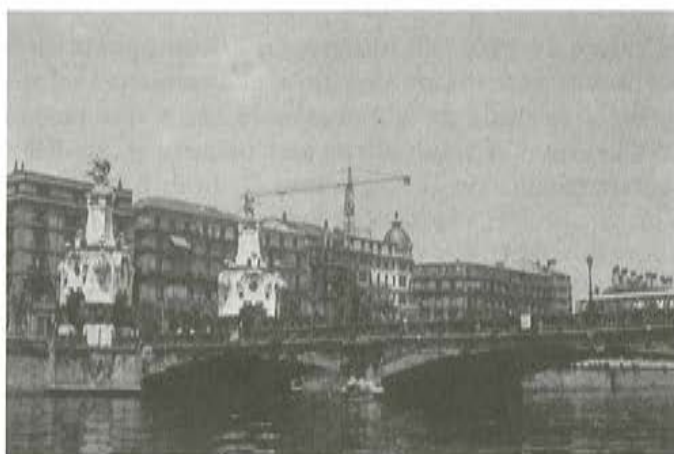
Fig. 2. Aspecto del Puente en 1982.
