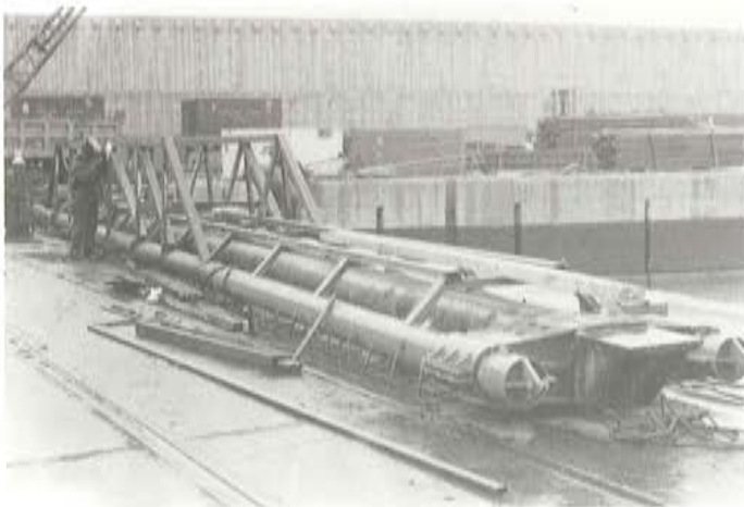
Fig. 9. Trépano para rebajar la cota del fondo de la dársena.
