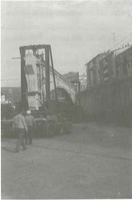
Fig. 14. Vista del transporte de un arco-tímpano.
