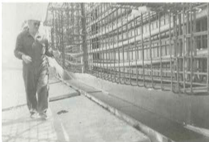
Fig. 4. Ferralla del tablero en el momento de su introducción dentro del molde metálico.
