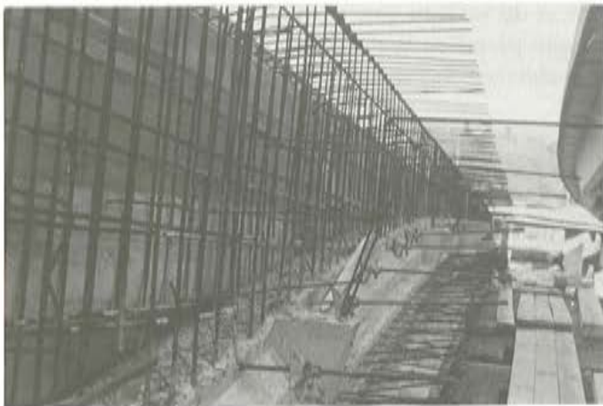
Fig. 13. Arco de borde en proceso de llenado.
