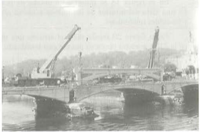
Fig. 15. Montaje de un arco-tímpano.
