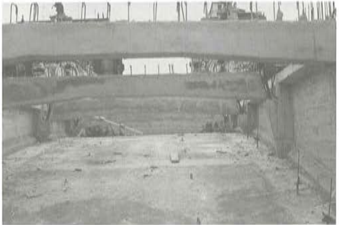
Fig. 17. Nervios transversales de tablero superior.
