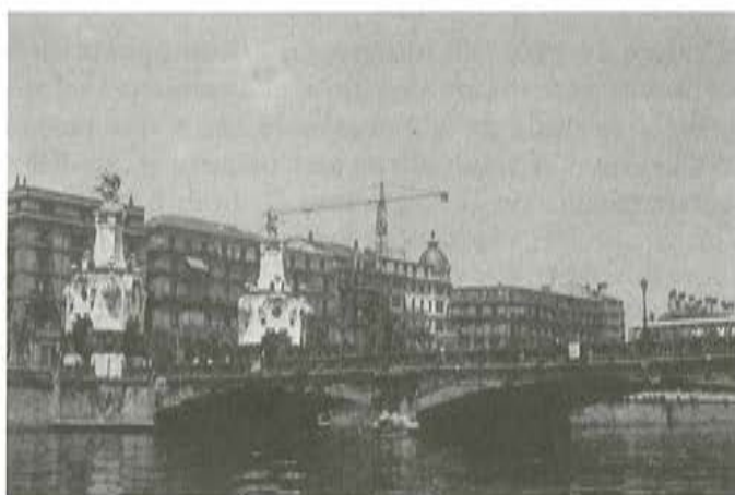
Fig. 2. Aspecto del Puente en 1982.
