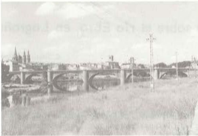
Fig. 1. Puente de piedra.
