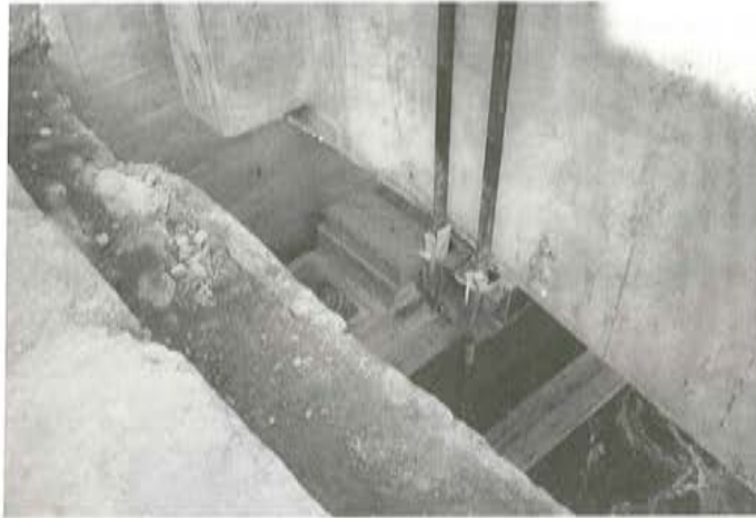
Fig. 8. Detalle del sistema de izado del tablero.
