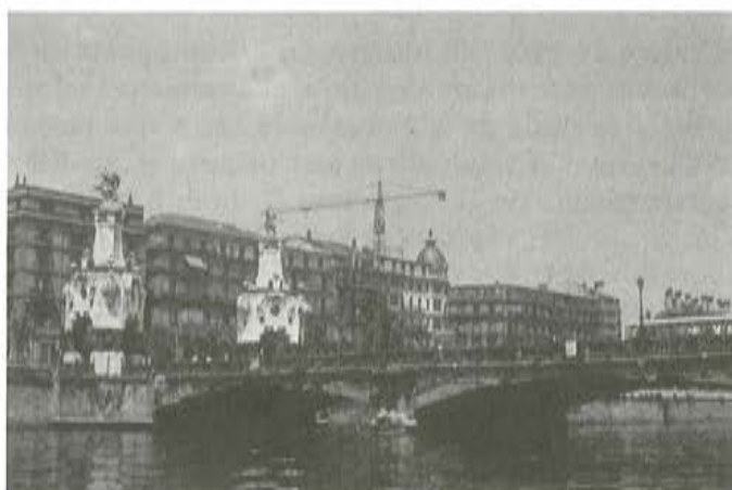
Fig. 2. Aspecto del Puente en 1982.
