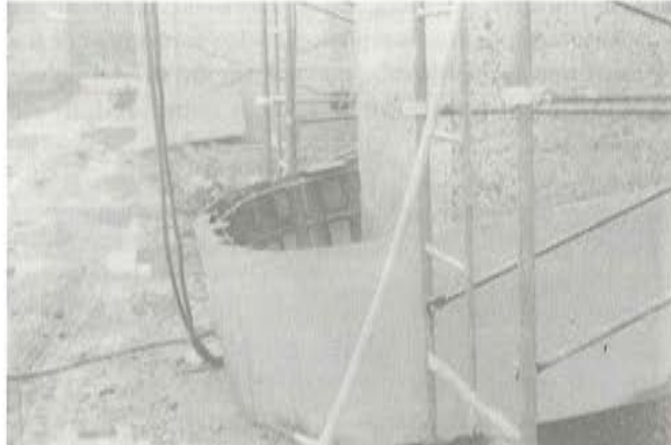
Foto 7. Exterior de una semivirola de refuerzo de una de las pilas del tramo de acceso.
