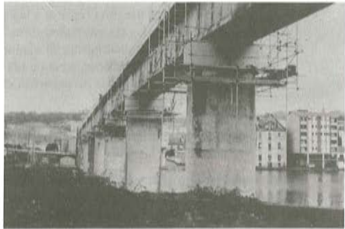
Foto 17. Castilletes de andamios tubulares en las pilas sobre la rfa.
