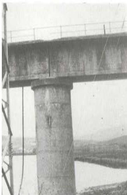
Foto 1. Se aprecia la fisuración típica en una de las pilas del tramo principal sobre la ría. Asimismo se pueden observar las manchas que la cal libre, disuelta por el agua de lluvia, ha dejado en los paramentos del tablero y en las fisuras de la pila. Otro detalle que se aprecia en la fotografía son los clásicos montones de grava existentes en el plano superior de las pilas, montones que se han formado al caer el balasto a través de la junta de dilatación entre vigas y por los extremos de los voladizos. Finalmente se puede observar el mal estado en que se encontraba la barandilla.
