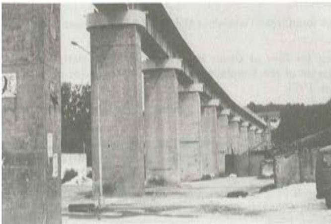
Foto 20. Perspectiva del tramo de acceso, una vez finalizada la reparación.
