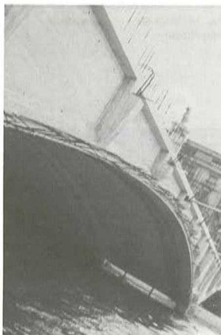
Fig. 20. Vista del intradós de los nuevos tableros.
