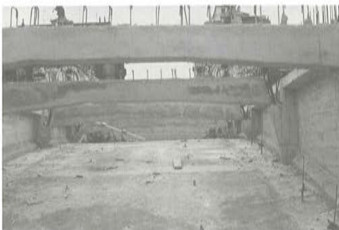
Fig. 17. Nervios transversales de tablero superior.
