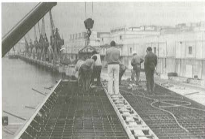
Fig. 5. Hormigonado del tablero.
