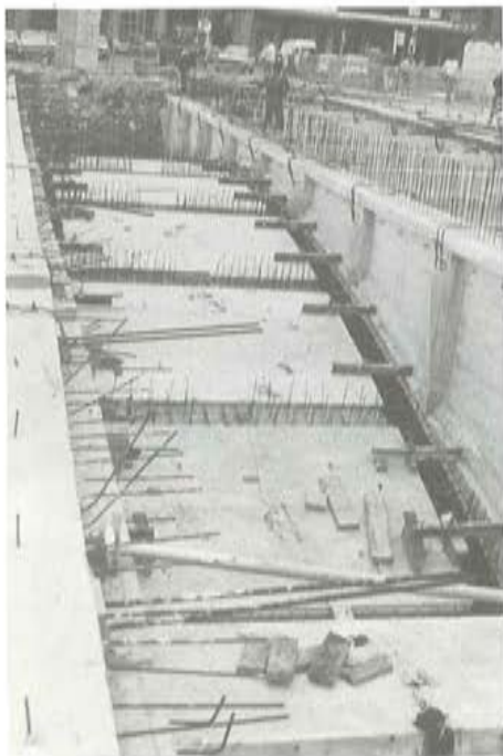
Fig. 16. Placas interiores curvas colocadas entre arcos adyacentes.
