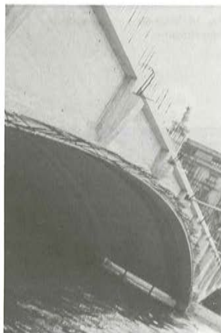
Fig. 20. Vista del intradós de los nuevos tableros.
