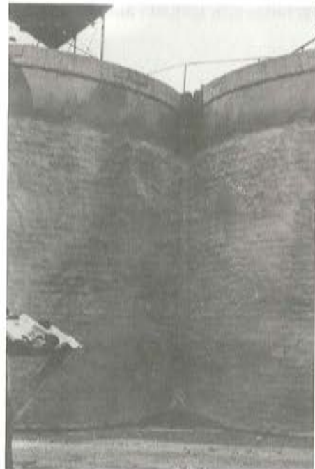
Foto 5. Aspecto que ofrece el punto de tangencia de dos silos después de reparados.
