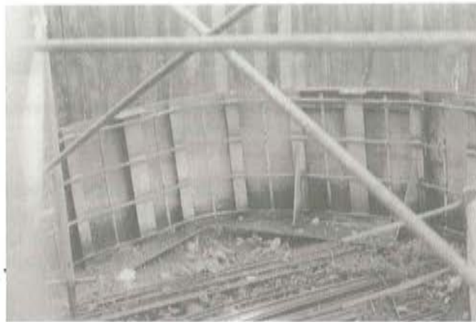
Foto 8. Interior de una semivirola de refuerzo de una de las pilas del tramo de acceso.
