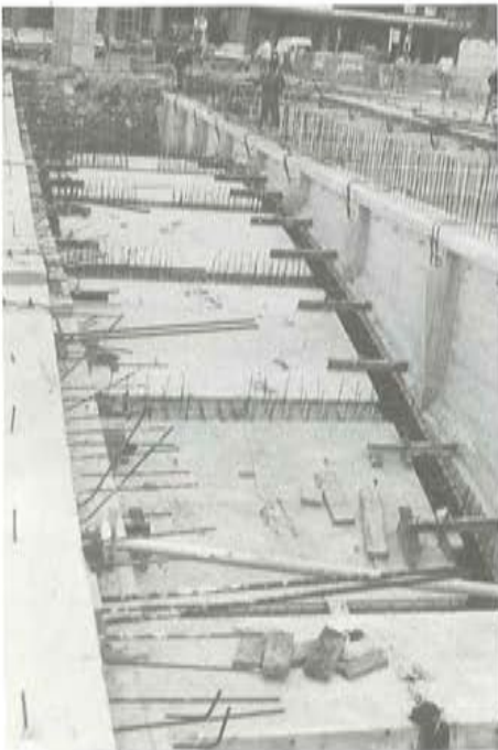
Fig. 16. Placas interiores curvas colocadas entre arcos adyacentes.
