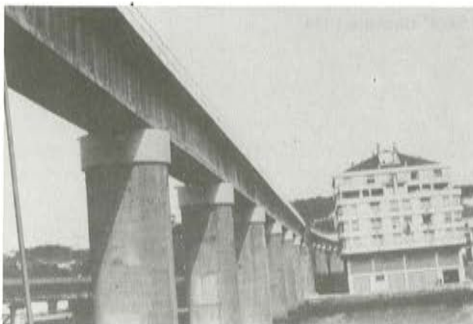
Foto 21. Perspectiva del tramo principal sobre la ría, una vez finalizada la reparación.
