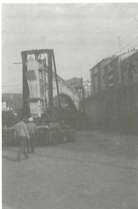
Fig. 14. Vista del transporte de un arco-tímpano.
