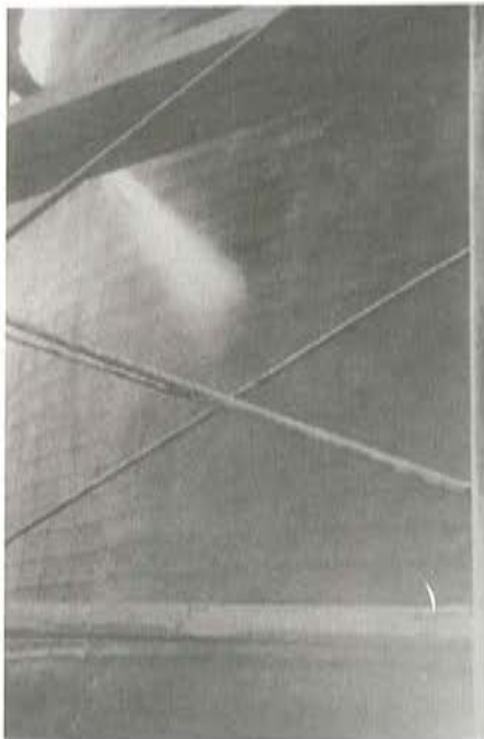
Foto 4. Proceso de proyección del mortero de la segunda capa o definitiva.
