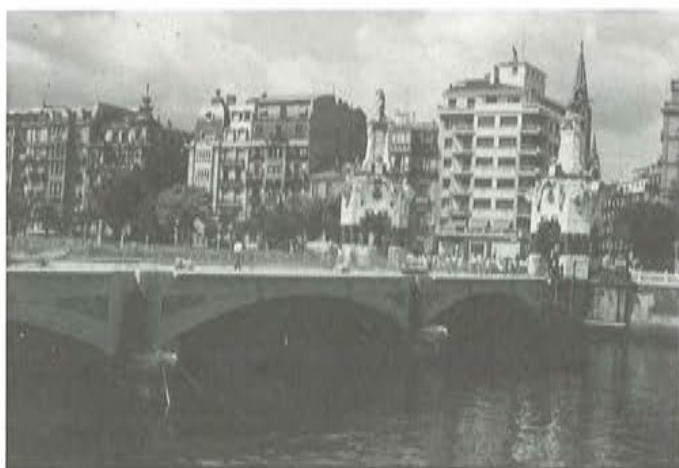
Fig. 21. Aspecto del nuevo puente casi acabado.
