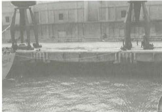
Fig. 11. Aspecto del muelle ampliado.
