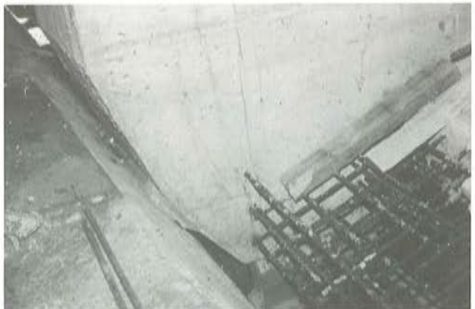
Fig. 18. Detalle de articulación de arranque de arco.
