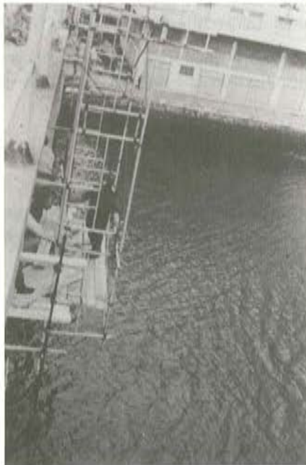
Foto 18. Uno de los castilletes de andamio tubular en una pila sobre la rfa.
