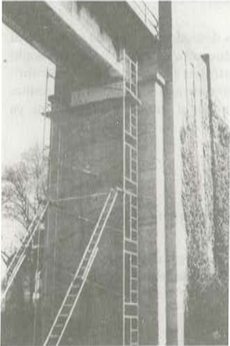
Foto 13. Estructura metálica, macizada con hormigón inyectado, del estribo lado Gijón.
