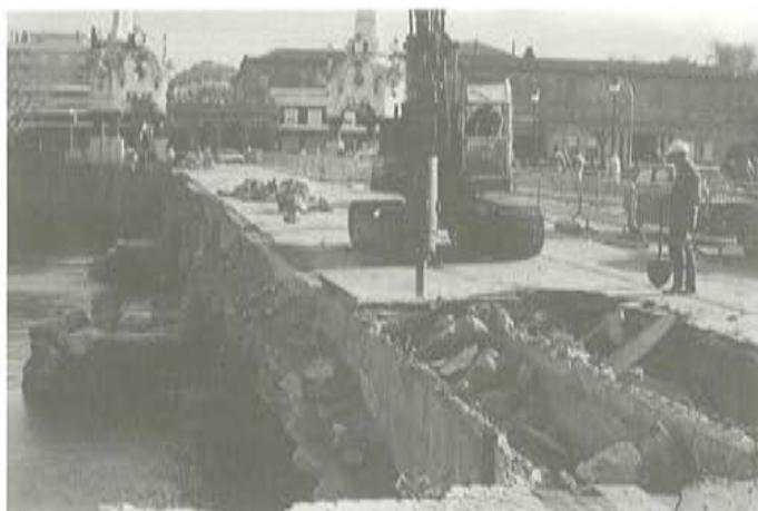
Fig. 11. Demolición de las viejas bóvedas.
