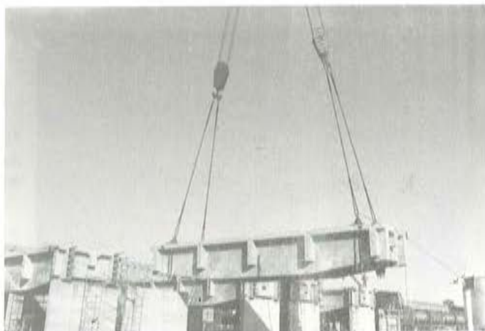
Fig. 7. Izado del tablero con la cabria.
