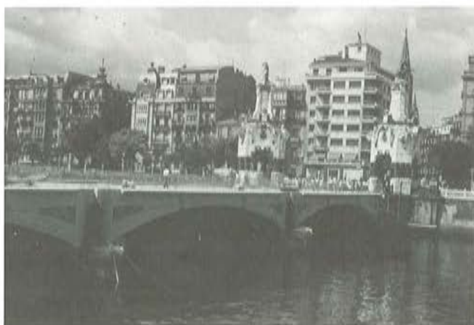
Fig. 21. Aspecto del nuevo puente casi acabado.
