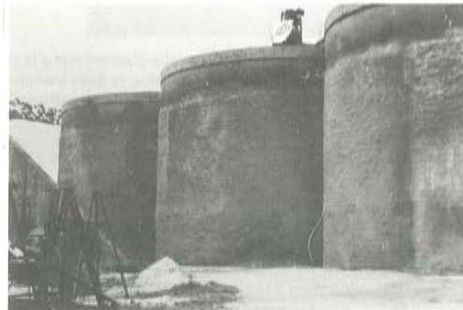
Foto 6. Aspecto general que ofrecen los silos, una vez terminada su reparación.
