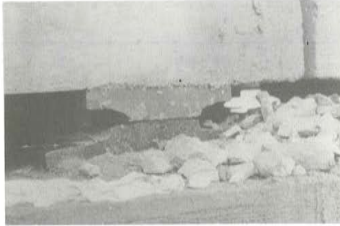
Foto 4. Uno de los apoyos metálicos del tablero, junto con los clásicos montones de balasto existentes en el plano superior de las pilas, como se comentó al describir la fotografía número 1.
