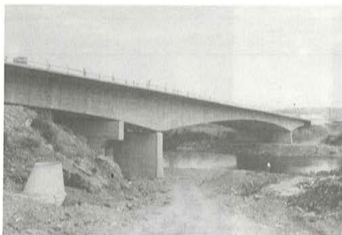
Fig. 8. Vista del puente con el apoyo provisional.
