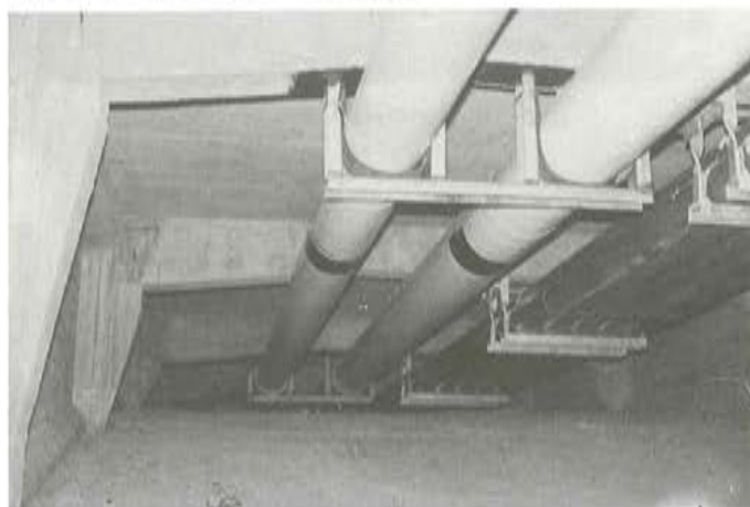
Fig. 19. Vista del interior del tablero con servicios.
