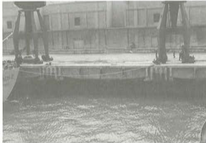
Fig. 11. Aspecto del muelle ampliado.
