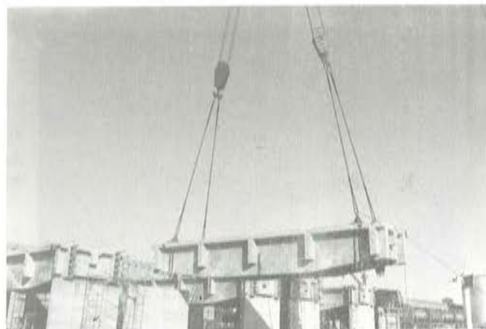
Fig. 7. Izado del tablero con la cabria.
