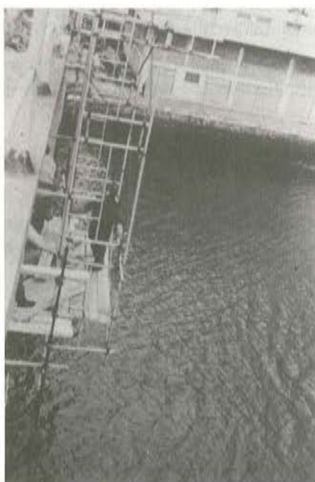
Foto 18. Uno de los castilletes de andamio tubular en una pila sobre la rfa.
