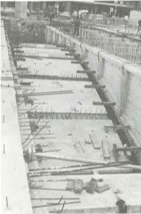
Fig. 16. Placas interiores curvas colocadas entre arcos adyacentes.
