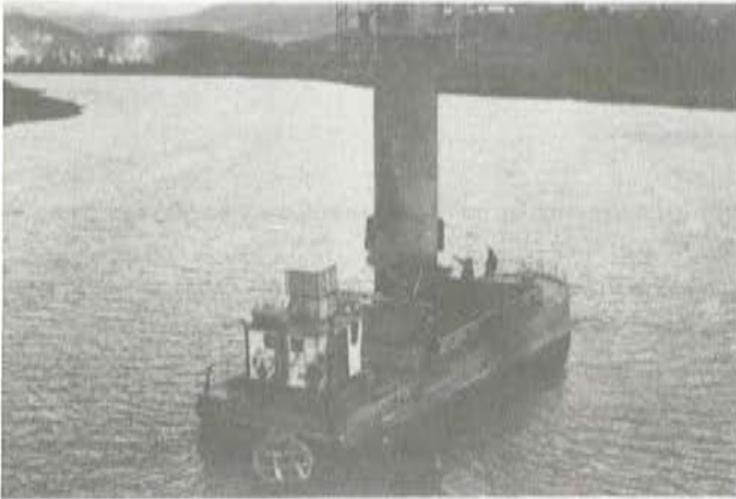
Foto 19. Transporte e izado de una de las virolas en una pila sobre la ría.
