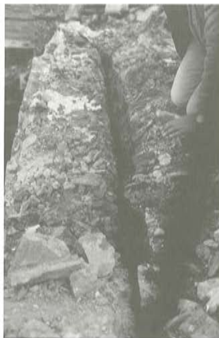
Fig. 12. Detalle de grietas existentes en las viejas bóvedas.
