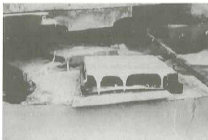
Foto 12. Sustitución de apoyos consistente en introducir el nuevo apoyo de neopreno zunchado a modo de sandwich en el apoyo existente y pegarlo mediante resina epoxi.
