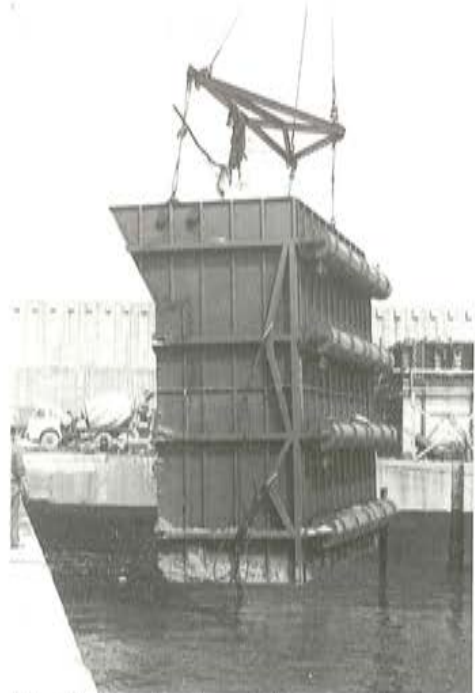
Fig. 10. Encofrado metálico para el hormigonado de las pilas.
