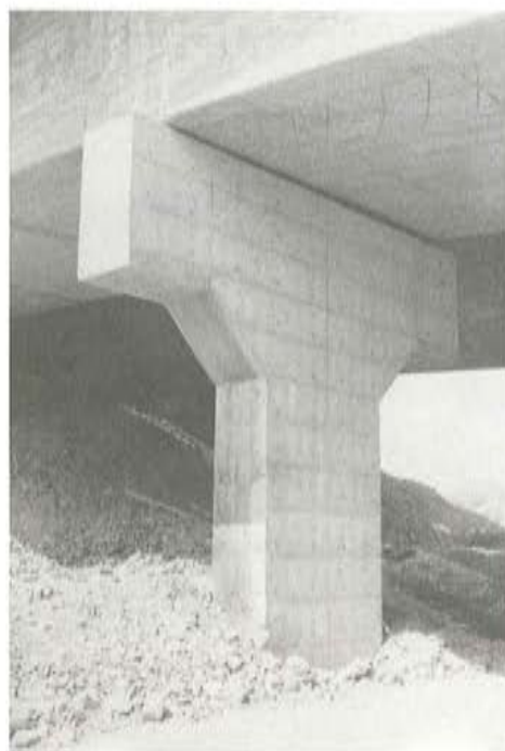
Fig. 6. Apoyo provisional.
