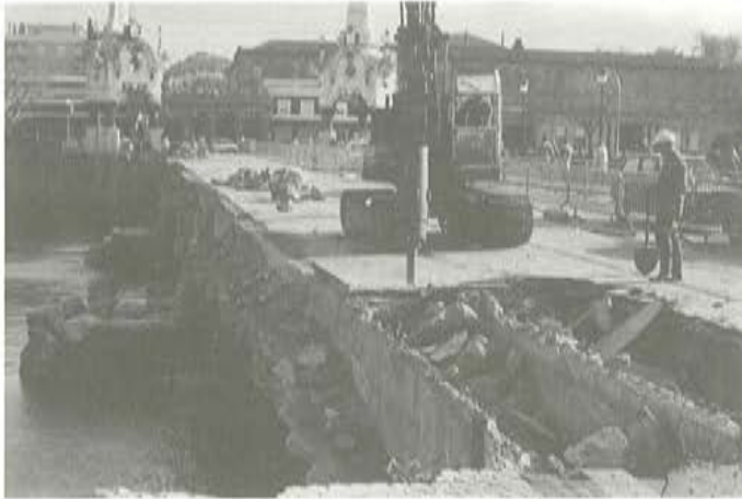
Fig. 11. Demolición de las viejas bóvedas.
