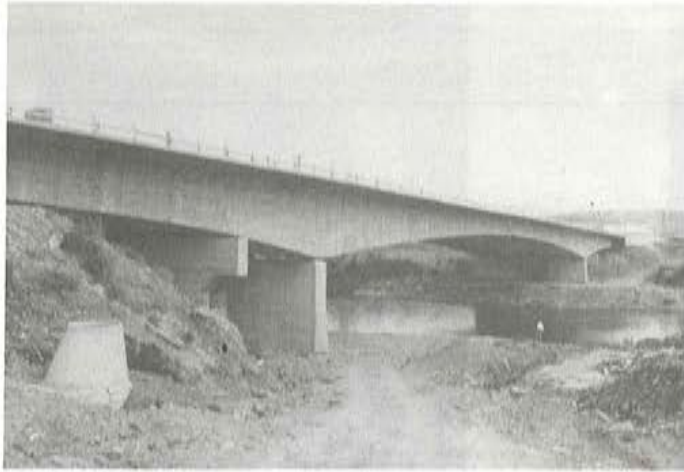
Fig. 8. Vista del puente con el apoyo provisional.
