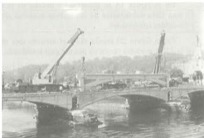
Fig. 15. Montaje de un arco-tímpano.
