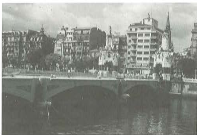
Fig. 21. Aspecto del nuevo puente casi acabado.
