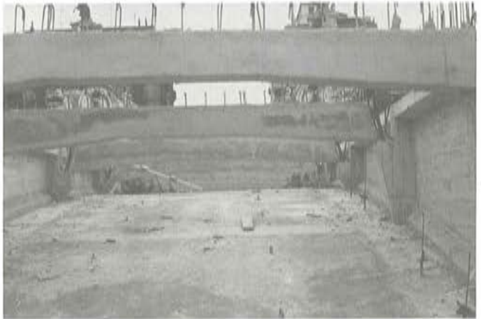
Fig. 17. Nervios transversales de tablero superior.
