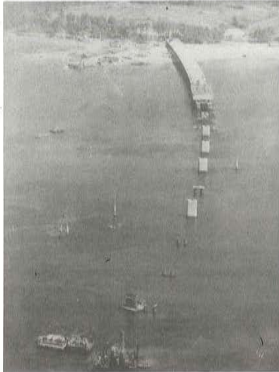
Fig. 2. Foto aérea del conjunto.
