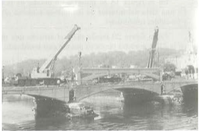
Fig. 15. Montaje de un arco-tímpano.
