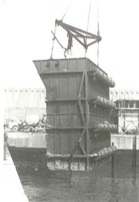
Fig. 10. Encofrado metálico para el hormigonado de las pilas.
