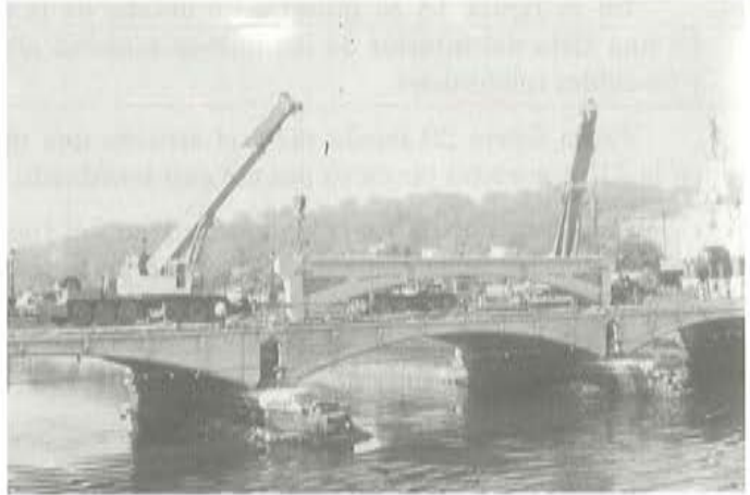
Fig. 15. Montaje de un arco-tímpano.
