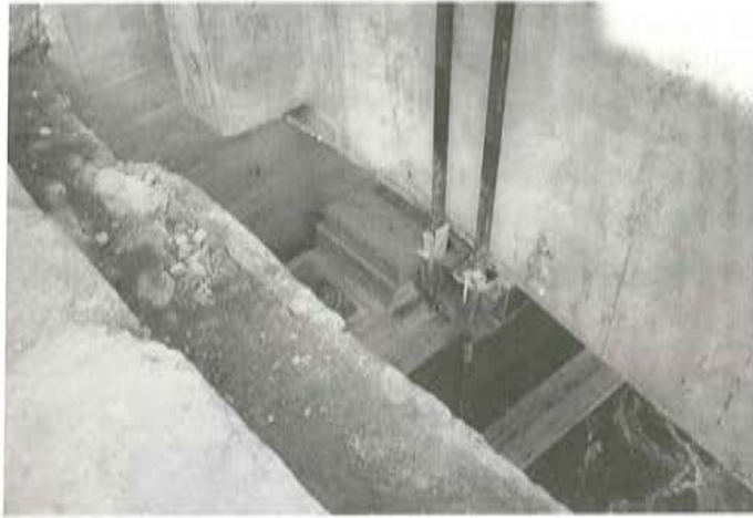
Fig. 8. Detalle del sistema de izado del tablero.
