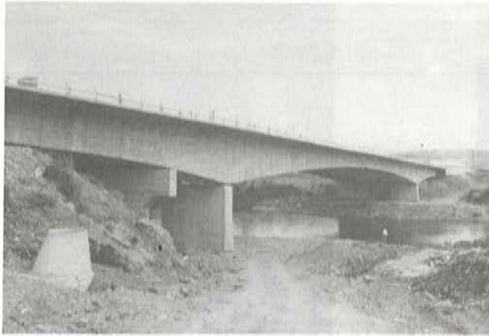
Fig. 8. Vista del puente con el apoyo provisional.
