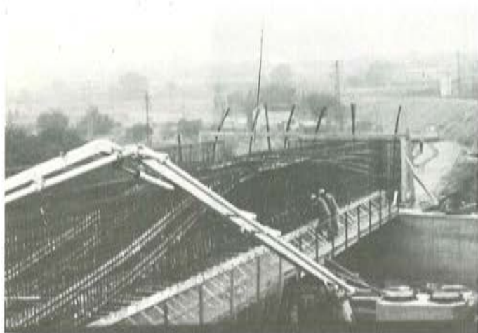
Fig. 30. Cables de pretensado longitudinal y hormigonado.
