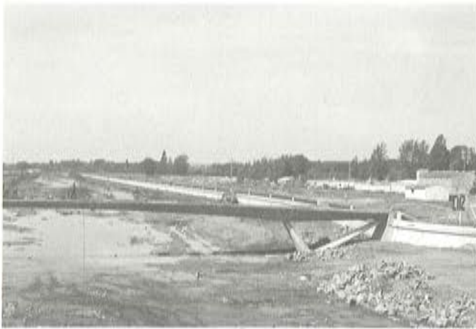
Fig. 9. Pasarela descimbrada. Detalle del elemento en V.
