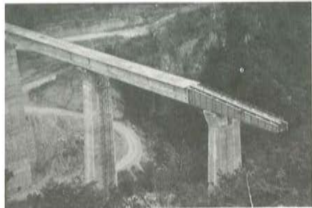
Fig. 19. Puente de Atoyac, durante el lanzamiento.
