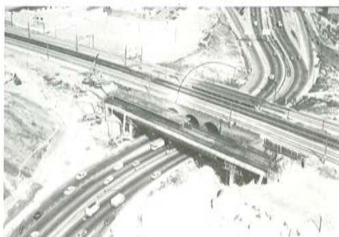
Fig. 31. Hormigonado del primer tablero.
