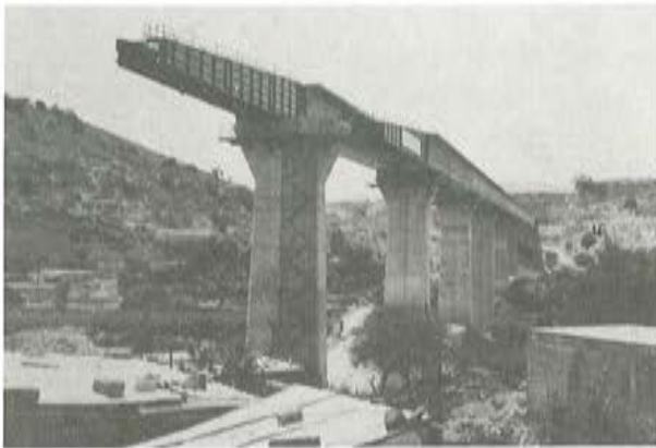
Fig. 18. Lanzamiento de los cajones del puente de Tula.
