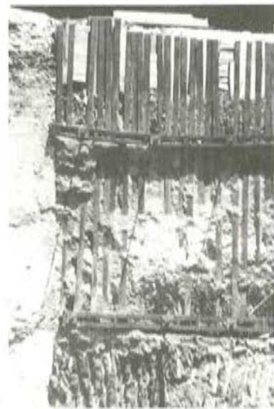
Fig. 26. Pantalla de carriles pretensados contra el terraplén.
