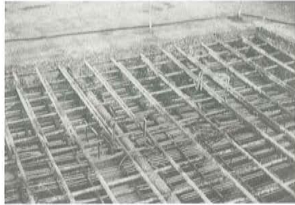
Foto 12. Detalle de junta de hormigonado y del encofrado para el hormigón de 2ª fase.
