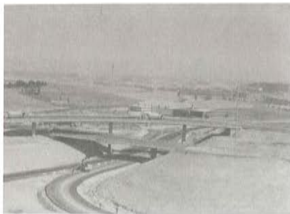
Foto 1. Vista del cruce a tres niveles.
