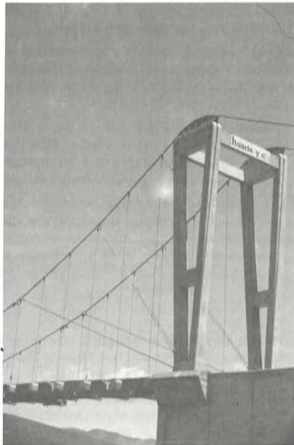
Fig. 13. Torre y tirantes.
