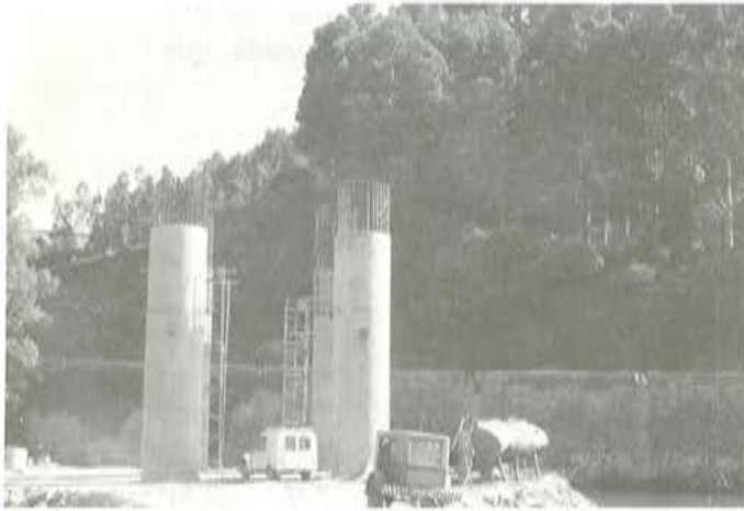
Fig. 13. Pilas pilote. Apoyo cimbra.
