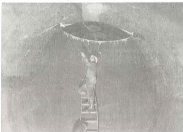
Tubería achicada para inspección y limpieza.
