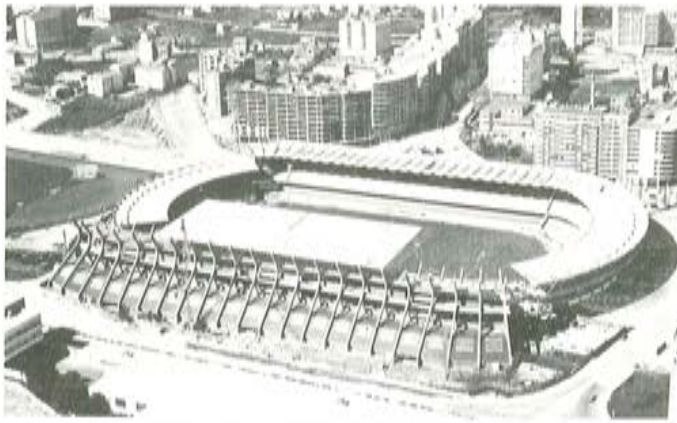
Fig. 1.1. Vista general del estadio con la nueva tribuna en construcción, en primer término.
