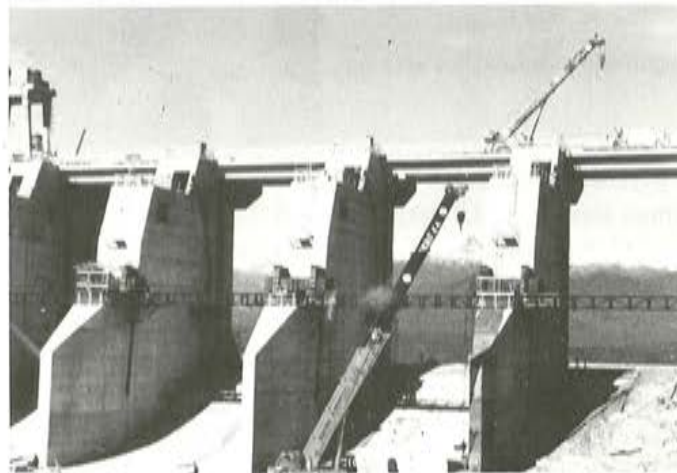
Fig. 6.2. Vista de los anclajes construidos.
