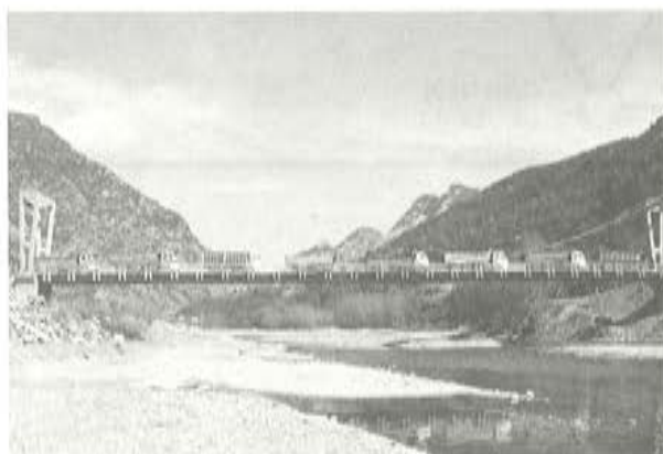
Fig. 17. Pruebas de carga.
