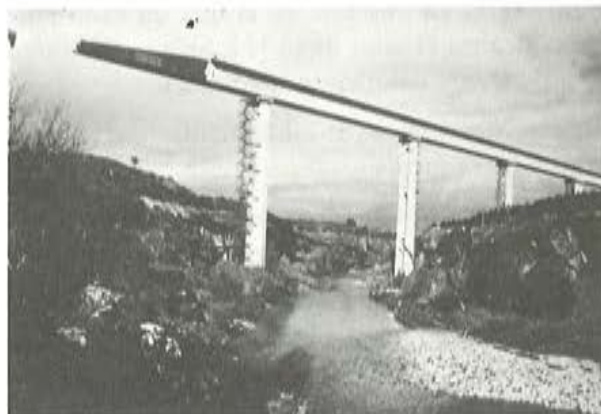
Fig. 1. Acueducto del Alcanadre, durante el lanzamiento. Luz = 60 m (J. Manterola y Leonardo Fernández Troyano).
