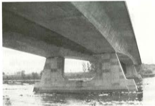
Fig. 5. Vista lateral del puente terminado.
