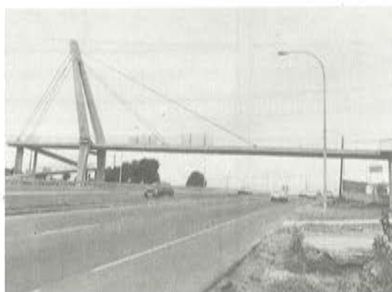
Foto 1, Pasarela de Alfonso Molina, La Coruña.
