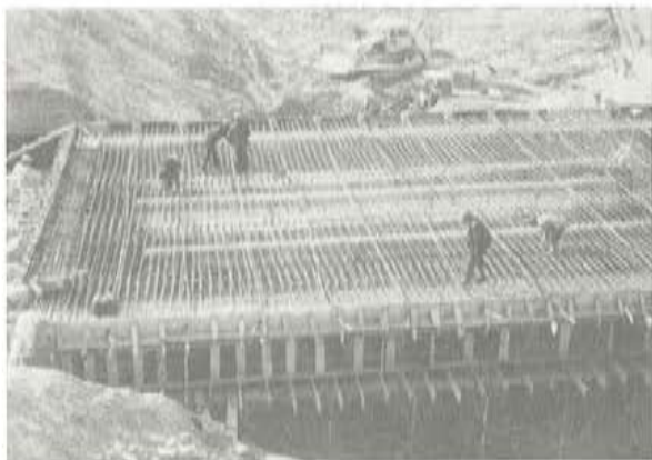
Foto 9. Montaje de ferralla del puente 2.
