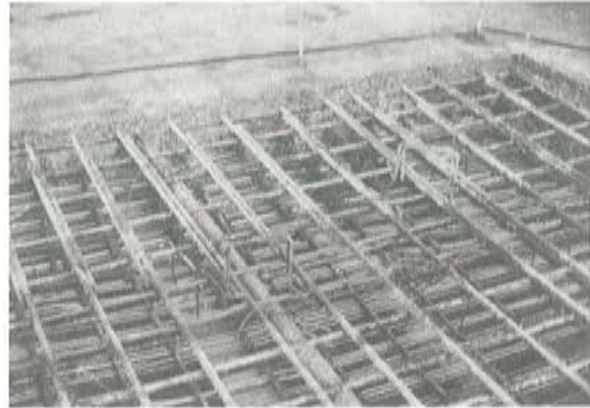
Foto 12. Detalle de junta de hormigonado y del encofrado para el hormigón de 2ª fase.
