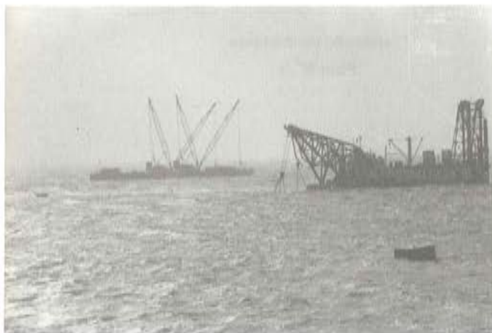
Dragado de la zanja. Foto N° 6
