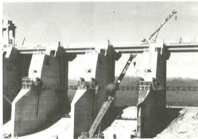
Fig. 6.2. Vista de los anclajes construidos.
