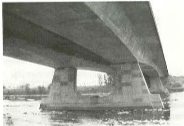
Fig. 5. Vista lateral del puente terminado.
