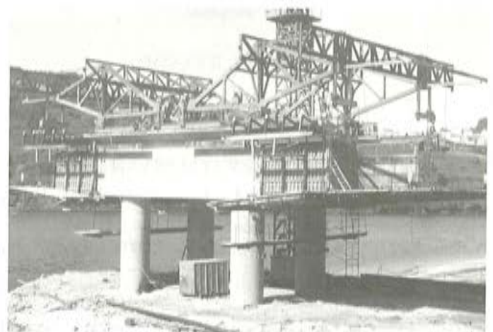
Fig. 16. Carros montados para iniciar el avance.
