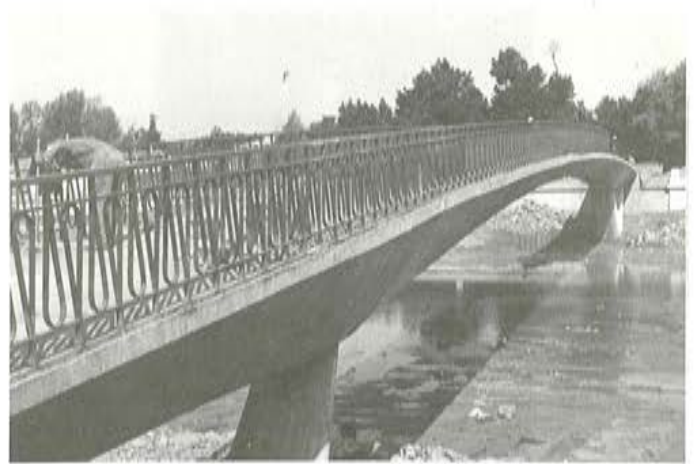
Fig. 10. Vista longitudinal y detalle de barandilla.
