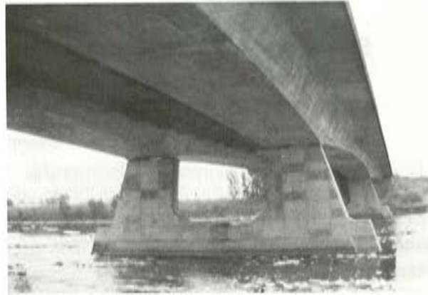
Fig. 5. Vista lateral del puente terminado.
