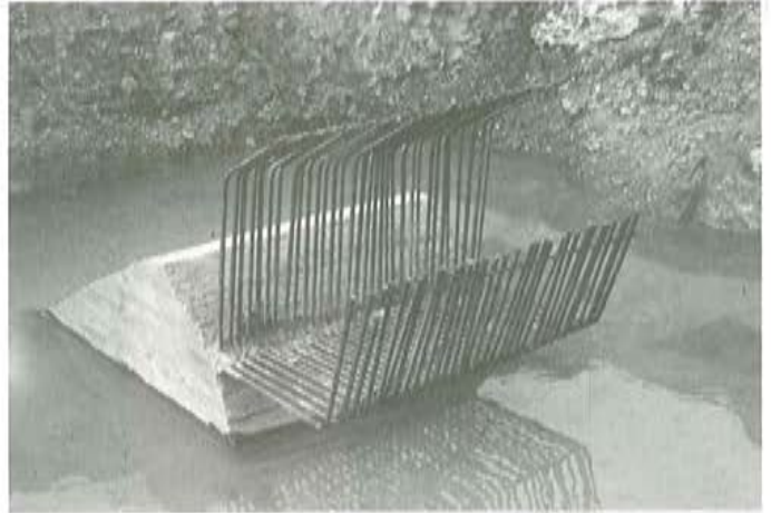
Fig. 2. Rótula arranque pila. Vista frontal.
