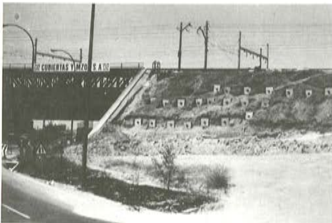
Fig. 27. Detalle de los anclajes posteriores de la pantalla de carriles.
