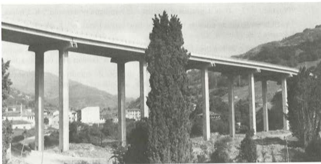
Viaducto de Huerna.
