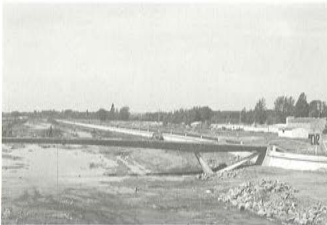
Fig. 9. Pasarela descimbrada. Detalle del elemento en V.
