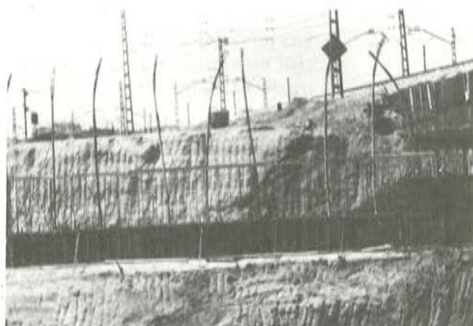
Fig. 28. Estribo lado Madrid. Cables de anclaje del tablero.
