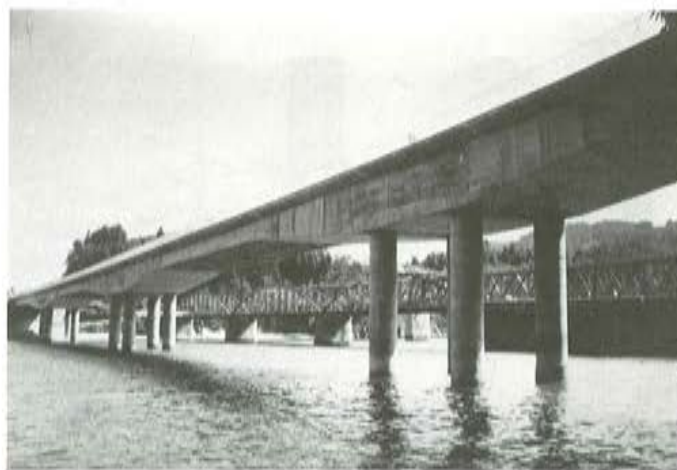
Fig. 22. Vista de la estructura terminada.
