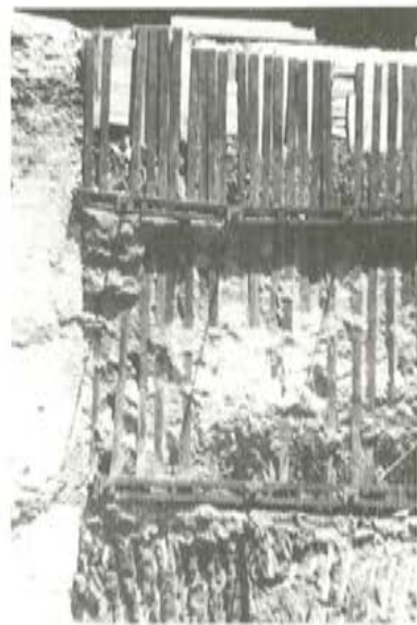
Fig. 26. Pantalla de carriles pretensados contra el terraplén.
