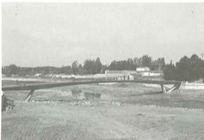
Fig. 11. Vista general con montaje barandilla.
