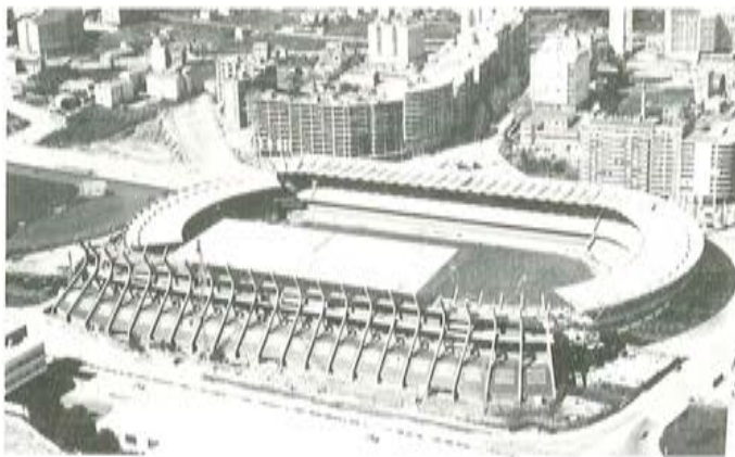
Fig. 1.1. Vista general del estadio con la nueva tribuna en construcción, en primer término.
