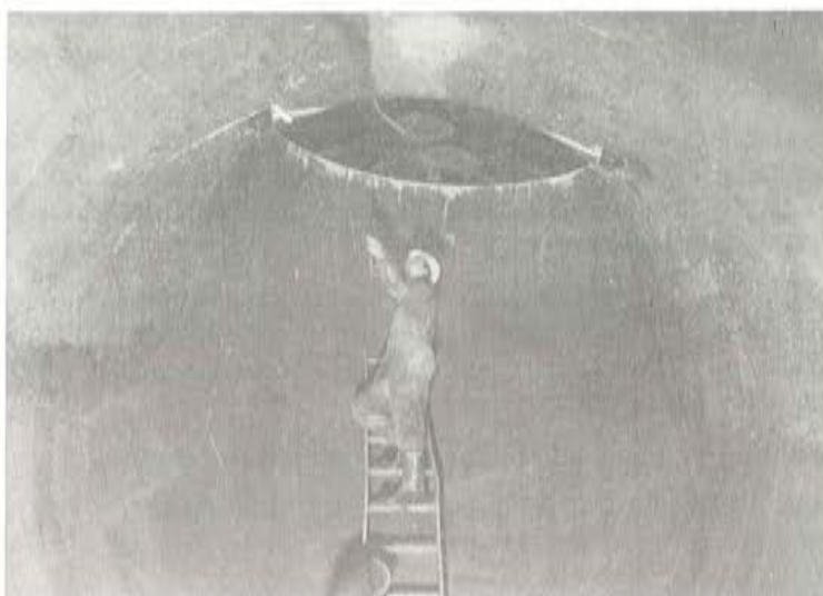
Tubería achicada para inspección y limpieza.
