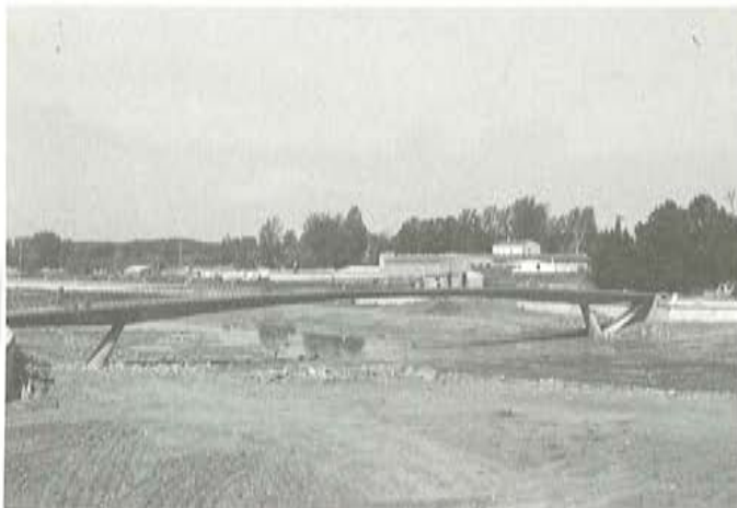
Fig. 11. Vista general con montaje barandilla.
