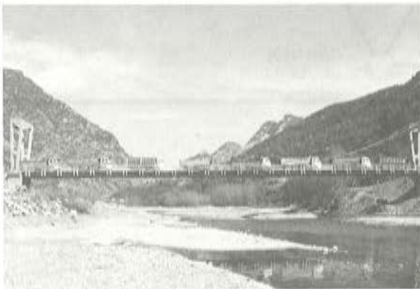
Fig. 17. Pruebas de carga.
