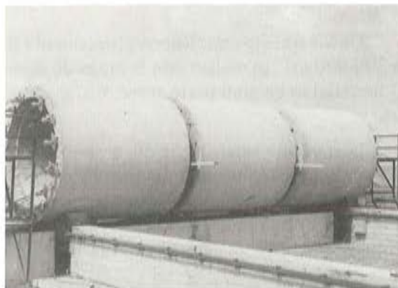
Pretensado de módulos.
