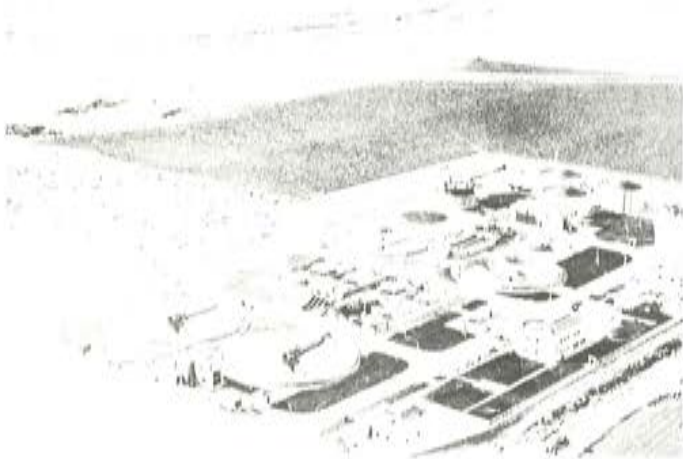
Fig. 3.1. Vista general de la Planta.
