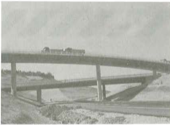
Foto 13. Vista de los puentes 2 y 3 terminados, en la que se aprecia una fase de la prueba de carga.
