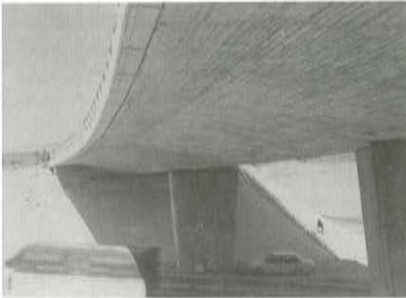
Foto 2. Vista del tablero del puente 1.
