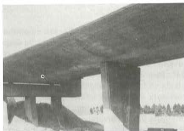
Foto 4. Detalle de pilas y estribos del puente 1.
