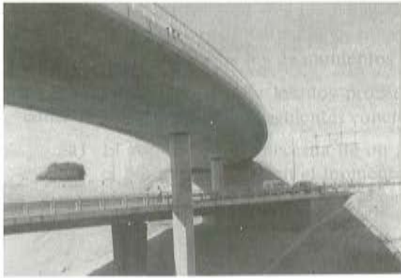
Foto 5. Detalle de pilas de puentes 2 y 3.
