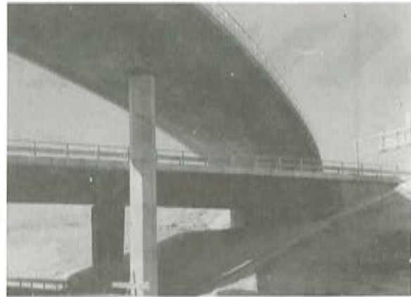
Foto 14. Aspecto de los puentes 2 y 3. Estribos lado Madrid.
