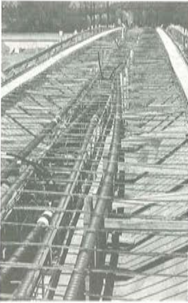
Fig. 7. Vista del tablero con los paramentos laterales hormigonados (anclajes pasivos).
