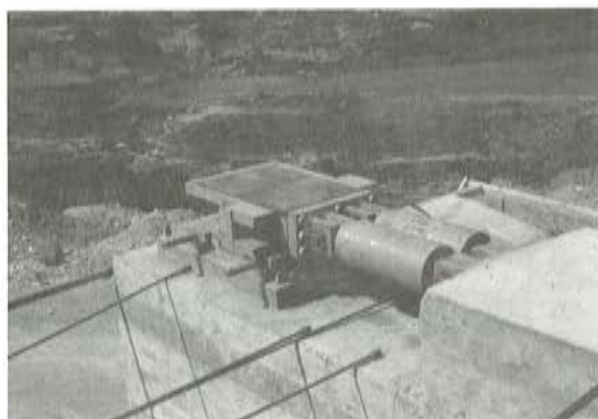
Fig. 10. Gatos de empuje situados bajo el estribo en el Acueducto del Alcanadre. El gato delantero es vertical y levanta el cajero. Los gatos de empuje son horizontales y deslizan el gato delantero y el acueducto, a la vez. Cuando desciende el gato delantero, el acueducto se apoya en el tacón de hormigón del estribo, y los gatos horizontales pueden recuperarse.
