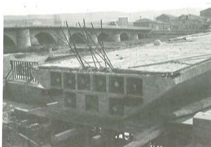
Fig. 8. Borde de anclajes. Tubos para conducciones.
