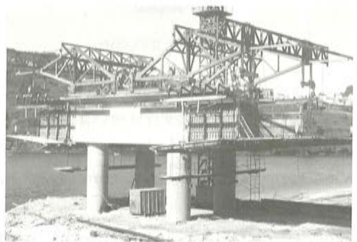
Fig. 16. Carros montados para iniciar el avance.
