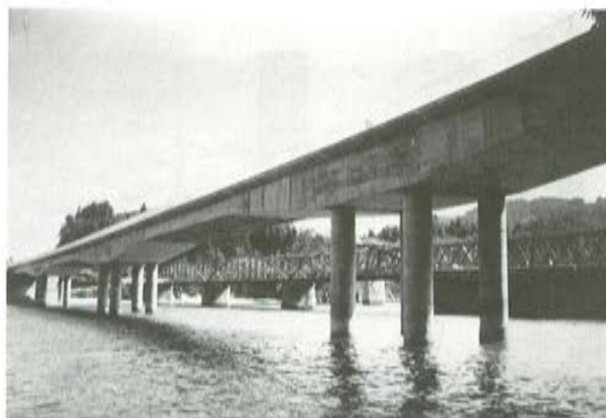
Fig. 22. Vista de la estructura terminada.
