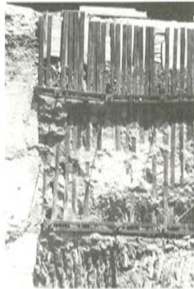
Fig. 26. Pantalla de carriles pretensados contra el terraplén.
