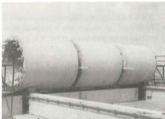
Pretensado de módulos.
