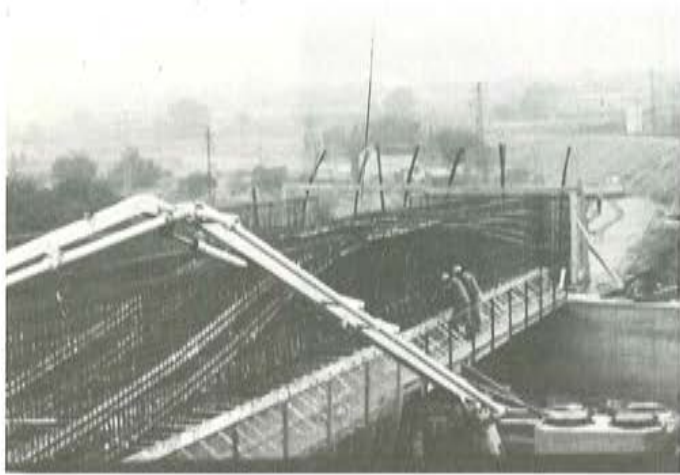
Fig. 30. Cables de pretensado longitudinal y hormigonado.
