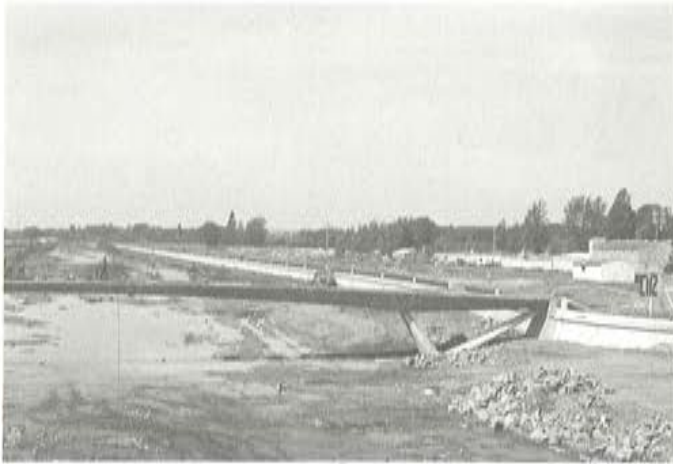
Fig. 9. Pasarela descimbrada. Detalle del elemento en V.
