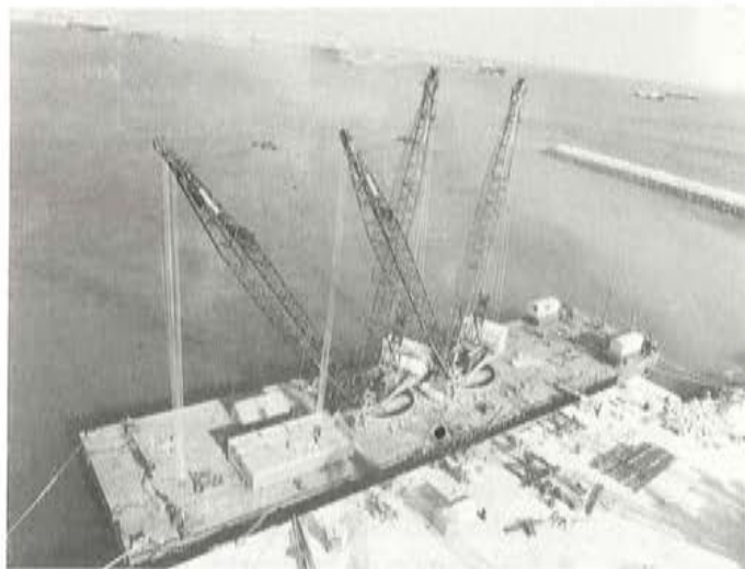
Equipo de montaje. Dracaza XIII con 2 Manitowoc 4.100 para montaje. Foto N° 7
