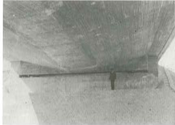
Foto 6. Vista del esquema de apoyo en estribos del puente 3.
