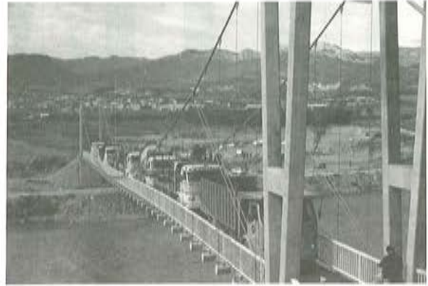
1 y 2-Prueba de carga del puente de Peramola
