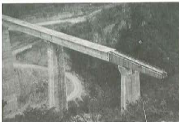
Fig. 19. Puente de Atoyac, durante el lanzamiento.
