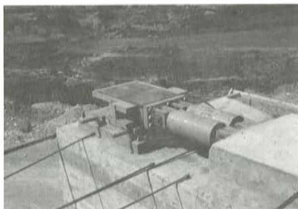
Fig. 10. Gatos de empuje situados bajo el estribo en el Acueducto del Alcanadre. El gato delantero es vertical y levanta el cajero. Los gatos de empuje son horizontales y deslizan el gato delantero y el acueducto, a la vez. Cuando descende el gato delantero, el acueducto se apoya en el tacón de hormigón del estribo, y los gatos horizontales pueden recuperarse.
