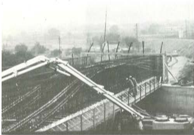
Fig. 30. Cables de pretensado longitudinal y hormigonado.
