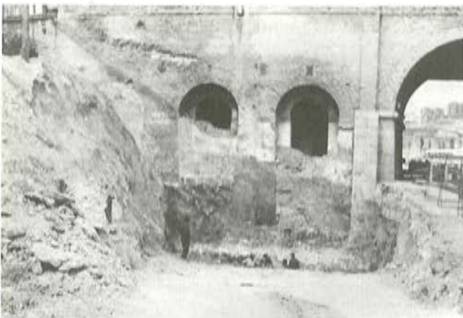
Fig. 25. Excavación para cimientos: Detalle de los rellenos.
