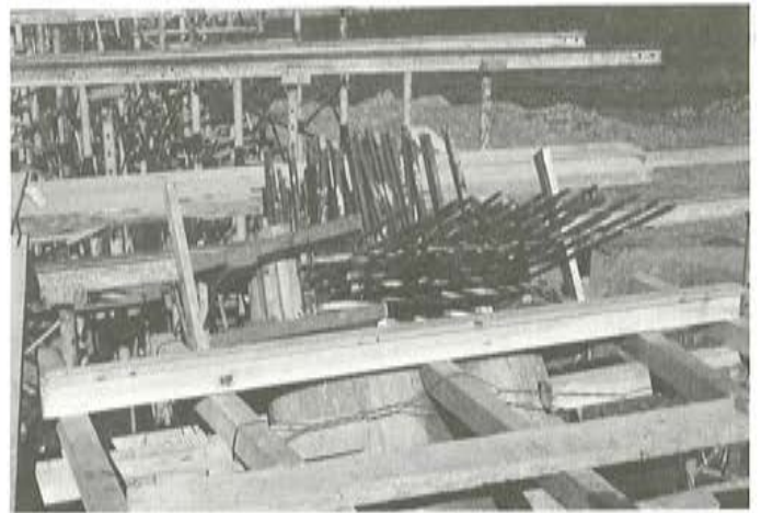
Fig. 4. Detalle rótula en cabeza de pila.
