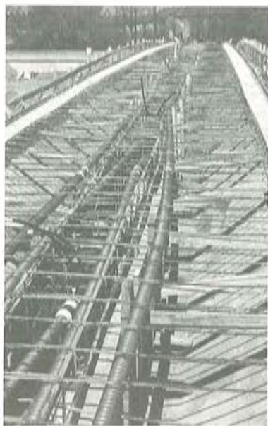
Fig. 7. Vista del tablero con los paramentos laterales hormigonados (anclajes pasivos).
