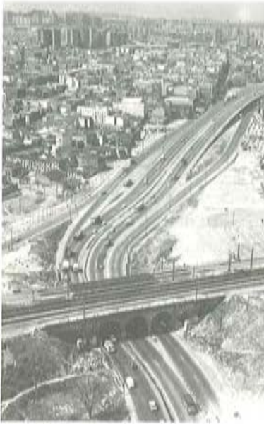
Fig. 23. Puente de los Tres Ojos. Vista superior; 6 vías. Ladrillo + metálico.
