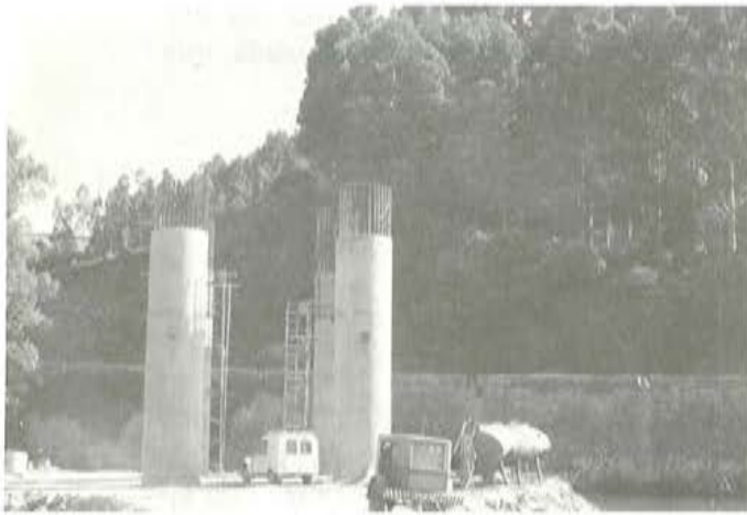
Fig. 13. Pilas pilote. Apoyo cimbra.
