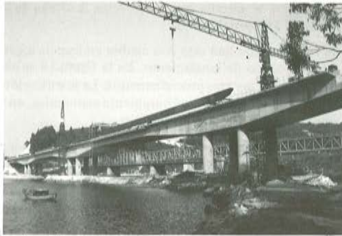
Fig. 19. Vista de lanzamiento de V.P. Hormigonado tramo central.
