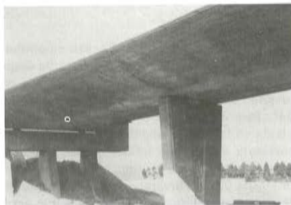
Foto 4. Detalle de pilas y estribos del puente 1.
