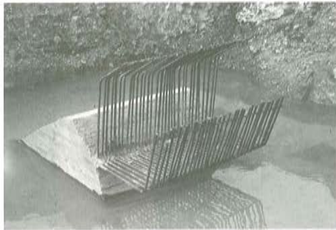
Fig. 2. Rótula arranque pila. Vista frontal.
