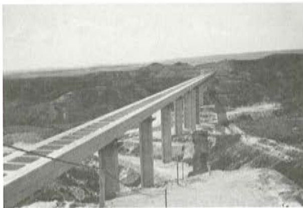
Fig. 15. Acueducto en una fase avanzada del lanzamiento: a) vista exterior; b) vista interior.
