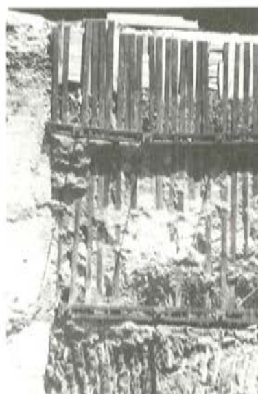
Fig. 26. Pantalla de carriles pretensados contra el terraplén.
