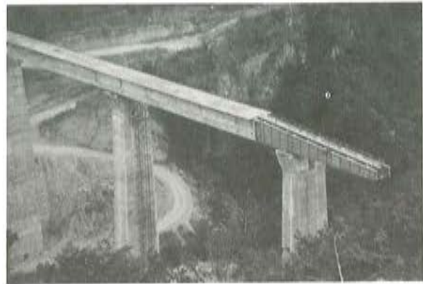
Fig. 19. Puente de Atoyac, durante el lanzamiento.
