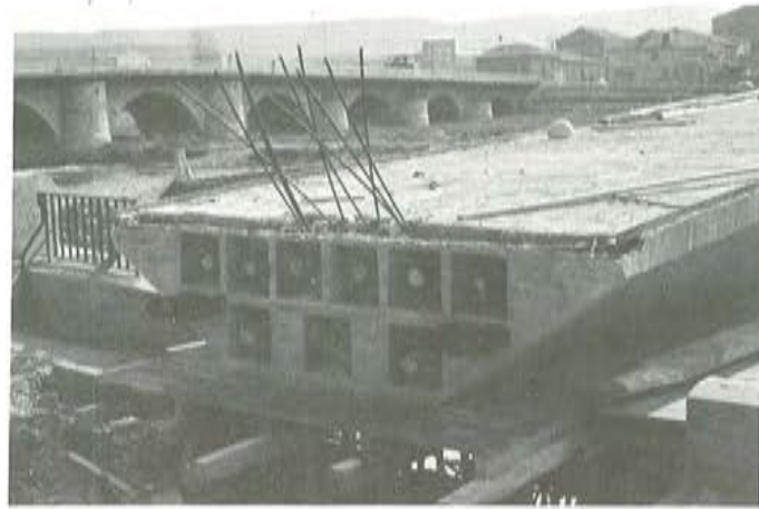
Fig. 8. Borde de anclajes. Tubos para conducciones.
