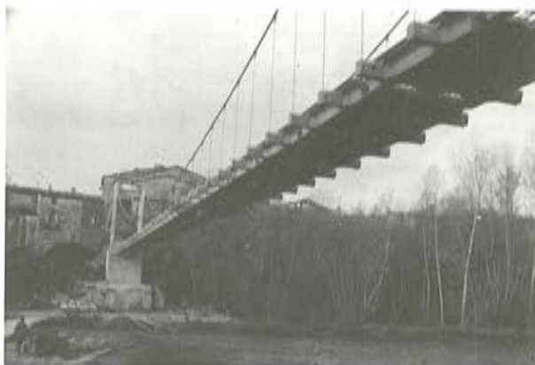
1-Puente de Basella antes del hormigonado de juntas
