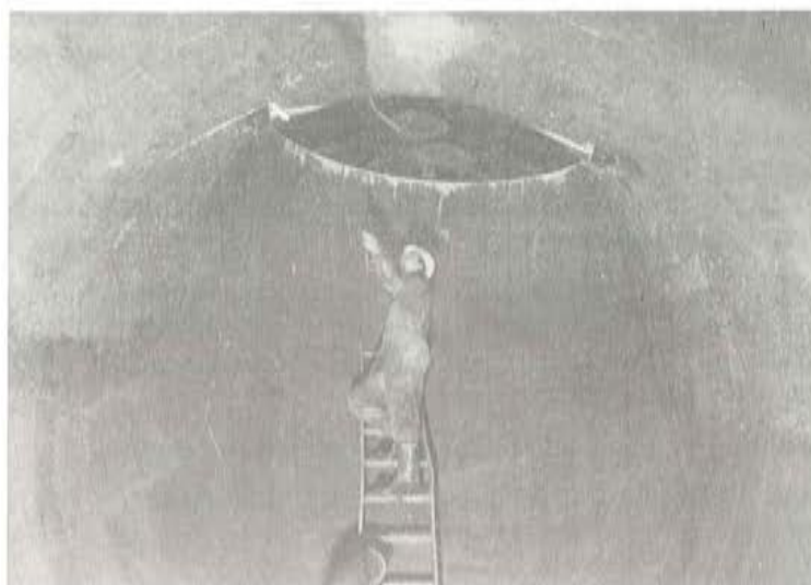
Tubería achicada para inspección y limpieza.
