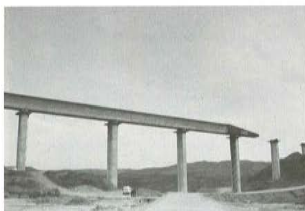
Fig. 12. Acueducto de los Monegros, en fase de lanzamiento.
