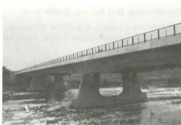
Fig. 1. c) Vista del puente terminado.
