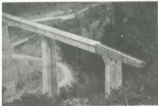
Fig. 19. Puente de Atoyac, durante el lanzamiento.
