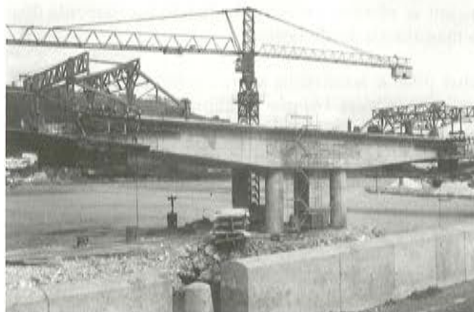
Fig. 17. Carros en posición final para hormigonado dovela última.
