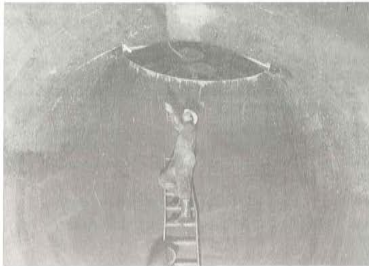
Tubería achicada para inspección y limpieza.
