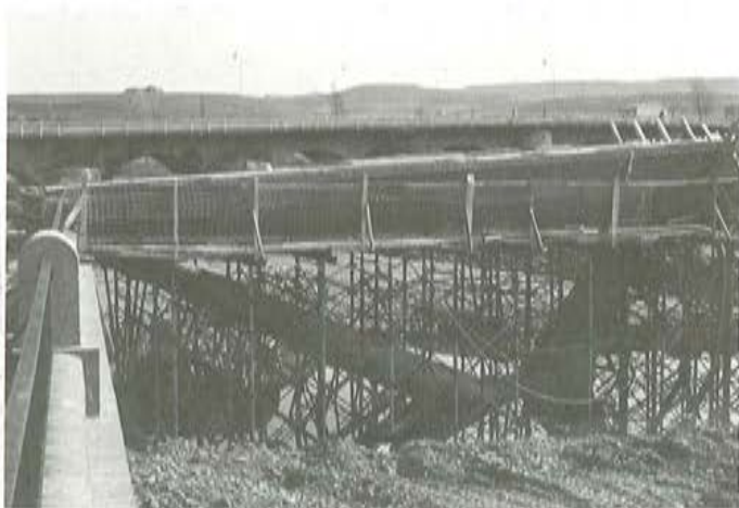
Fig. 5. Elemento triangular hormigonado (1ª fase).
