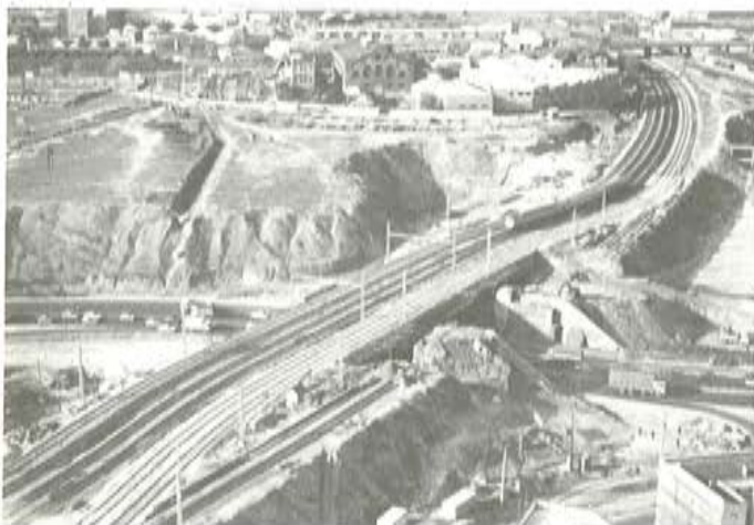
Fig. 34. Traslado de las v'as de Barcelona y demolición estribos puente metálico.
