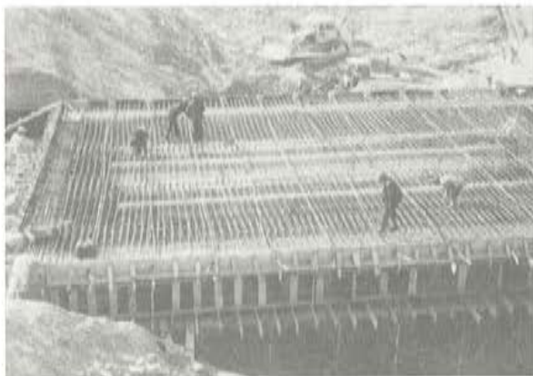
Foto 9. Montaje de ferralla del puente 2.
