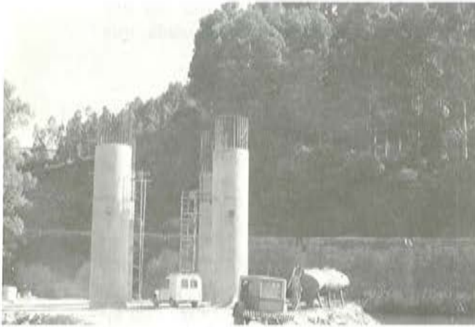
Fig. 13. Pilas pilote. Apoyo cimbra.
