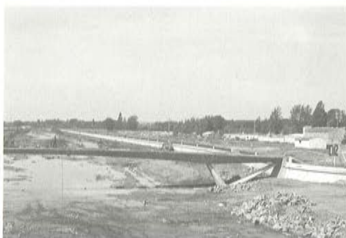
Fig. 9. Pasarela descimbrada. Detalle del elemento en V.
