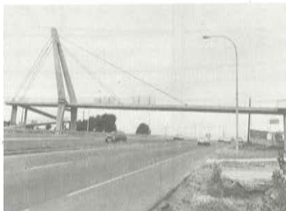
Foto 1, Pasarela de Alfonso Molina, La Coruña.
