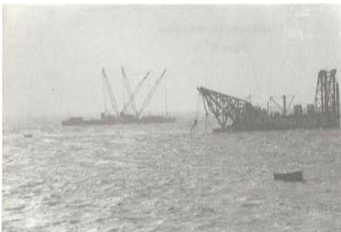
Dragado de la zanja. Foto N° 6
