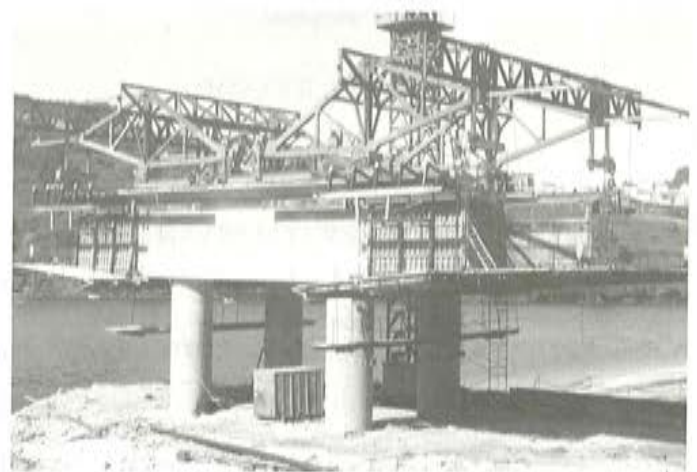
Fig. 16. Carros montados para iniciar el avance.
