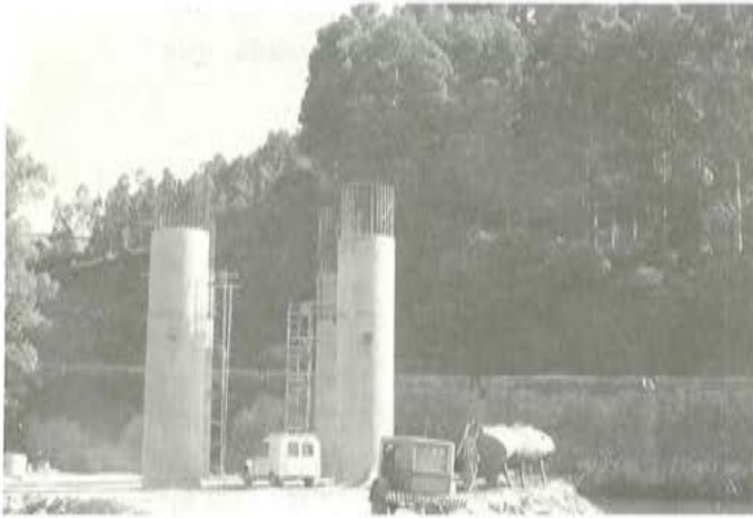
Fig. 13. Pilas pilote. Apoyo cimbra.
