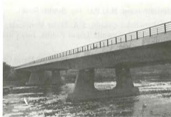
Fig. 1. c) Vista del puente terminado.
