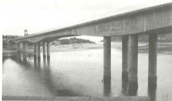
Fig. 21. Vista estructura acabada. Se han retirado las penínsulas.
