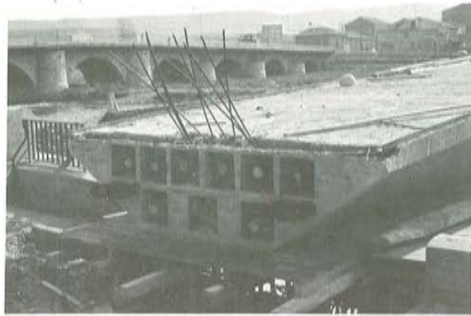
Fig. 8. Borde de anclajes. Tubos para conducciones.
