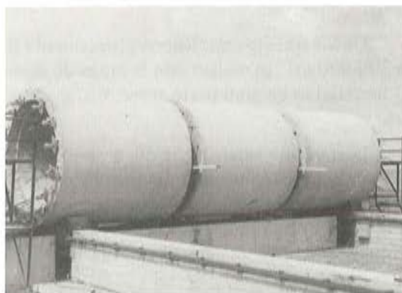
Pretensado de módulos.
