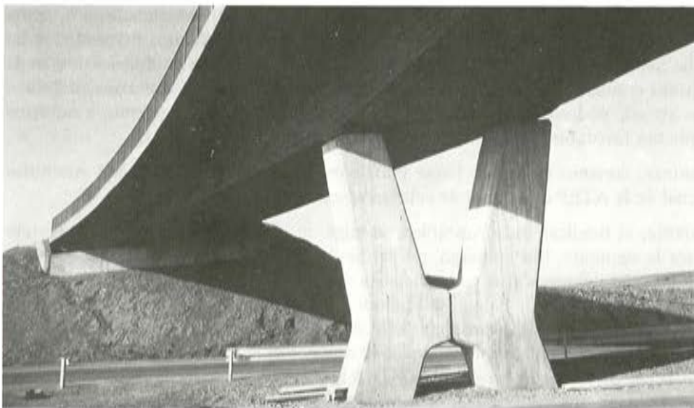
Puente de Montejos
