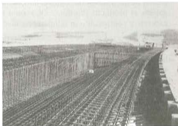
Foto 8. Detalle de ferralla del puente 3.
