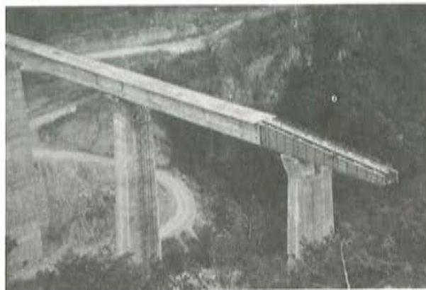
Fig. 19. Puente de Atoyac, durante el lanzamiento.
