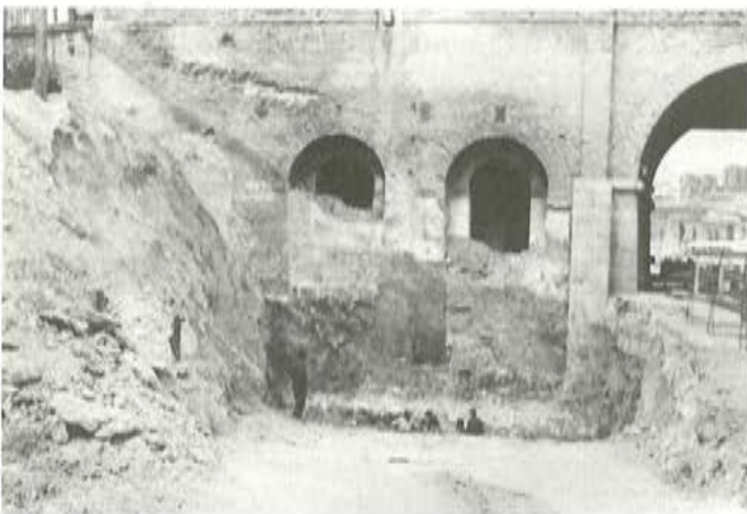
Fig. 25. Excavación para cimientos: Detalle de los rellenos.
