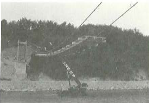
Fig. 15. 1. La grúa montando una dovella.
