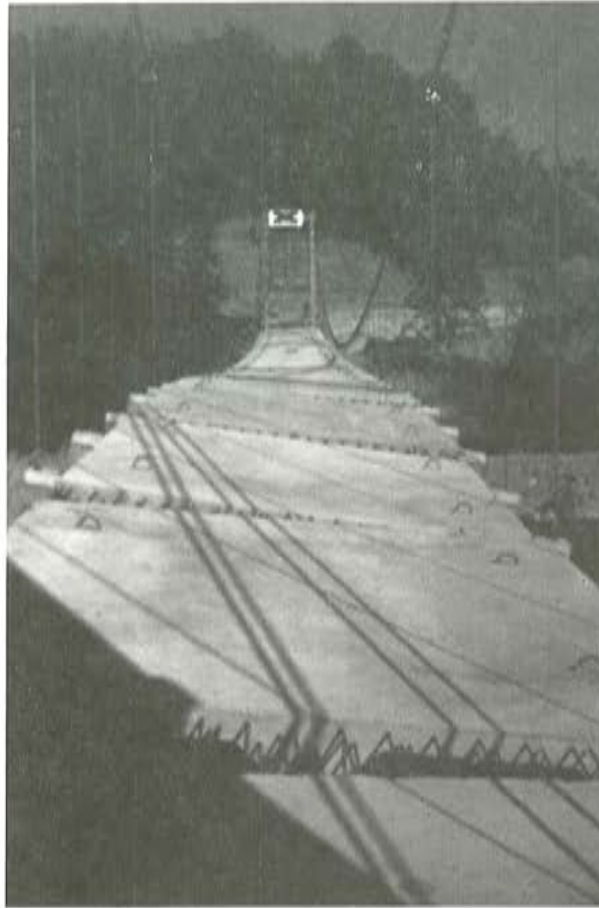
Fig. 16. Colocación de tirantes. Deformación del tablero al colocar el tirante de uno de los cables.
