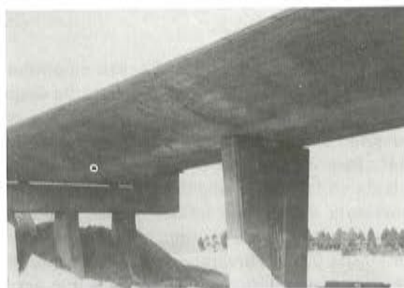
Foto 4. Detalle de pilas y estribos del puente 1.
