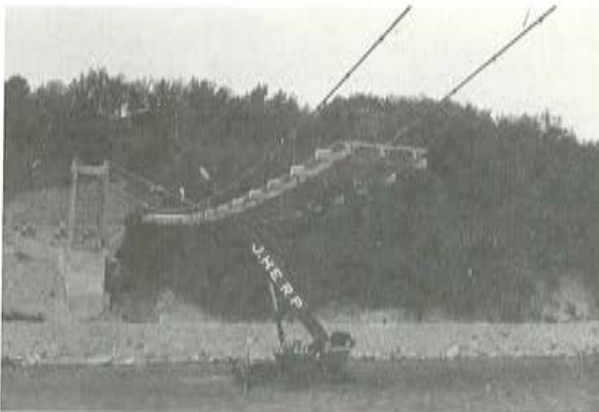
Fig. 15. 1. La grúa montando una dovela.
