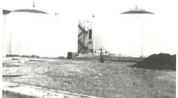
Fig. 3.2. Digestores recubiertos.
