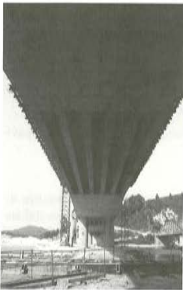
Fig. 20. Vista inferior del tablero.
