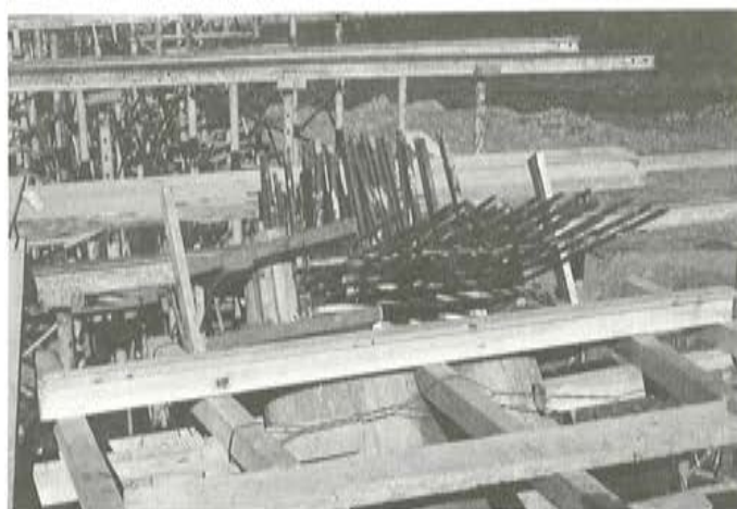
Fig. 4. Detalle rótula en cabeza de pila.
