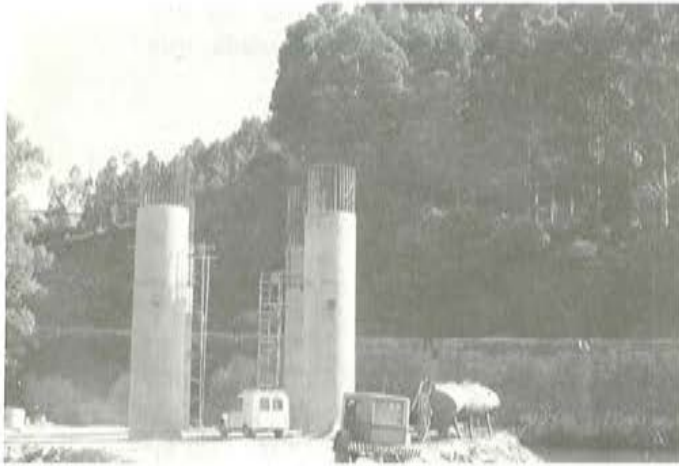
Fig. 13. Pilas pilote. Apoyo cimbra.
