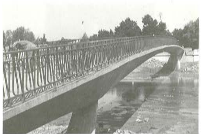
Fig. 10. Vista longitudinal y detalle de barandilla.
