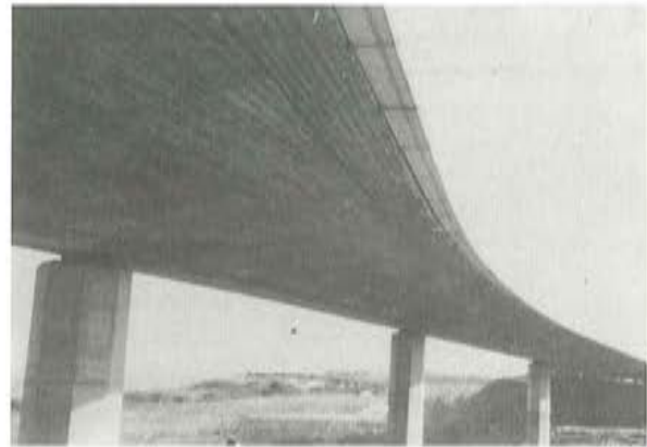
Foto 3. Vista del tablero del puente 3.
