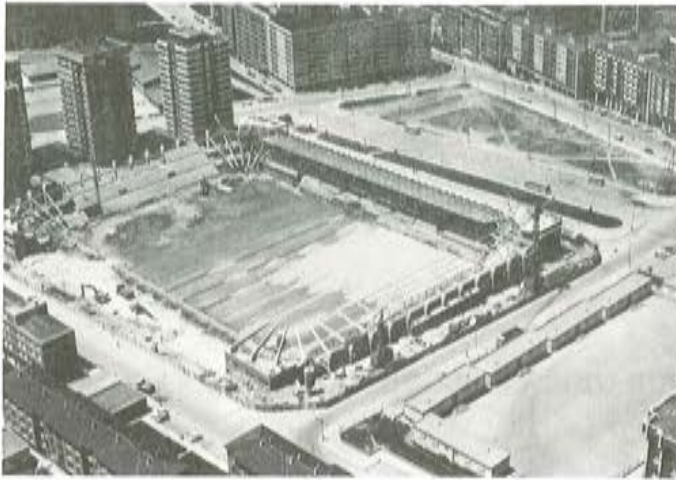
Fig. 2.1. Vista general del Estadio en construcción.
