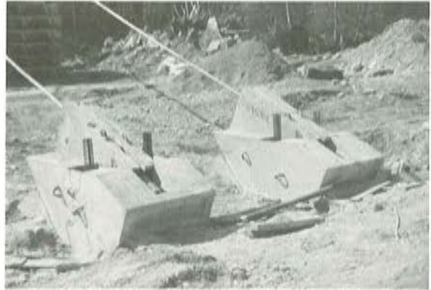
2-Los bloques con los cables y los anclajes pretensados colocados
