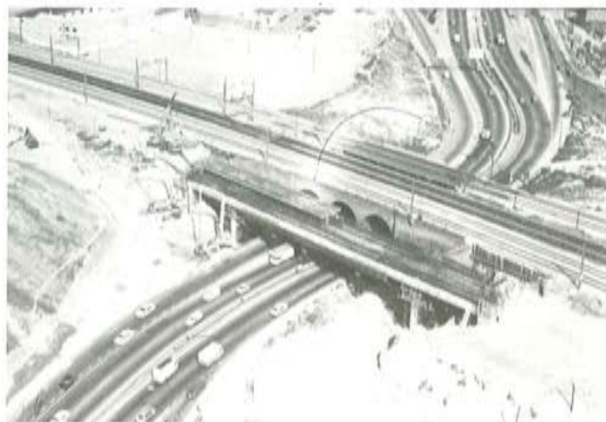
Fig. 31. Hormigonado del primer tablero.
