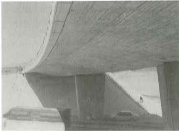
Foto 2. Vista del tablero del puente 1.
