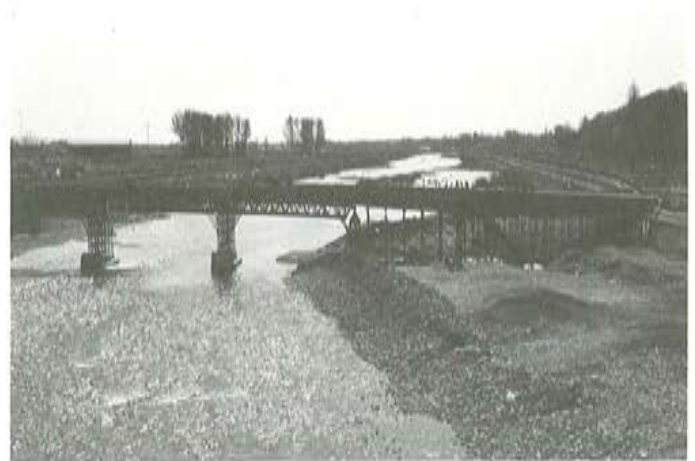
Fig. 6. Cimbra y encofrado del vano central.
