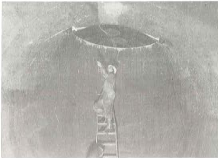
Tubería achicada para inspección y limpieza.
