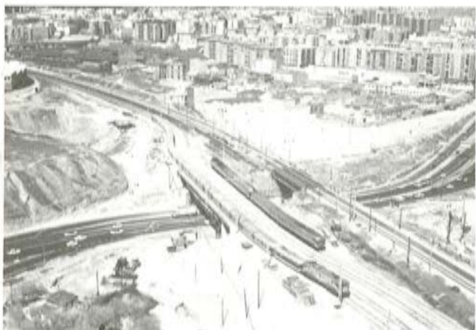
Fig. 32. Traslado de las vías de Andalucía y depósito. Huevo del puente de ladrillo.
