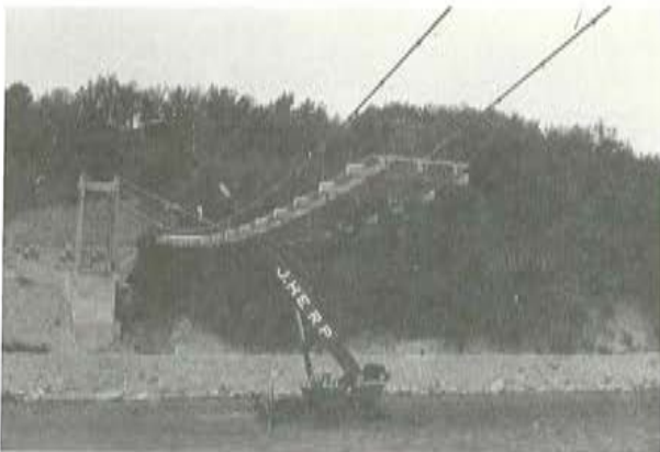
Fig. 15. 1. La grúa montando una dovela.
