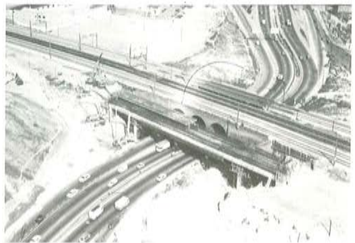
Fig. 31. Hormigonado del primer tablero.
