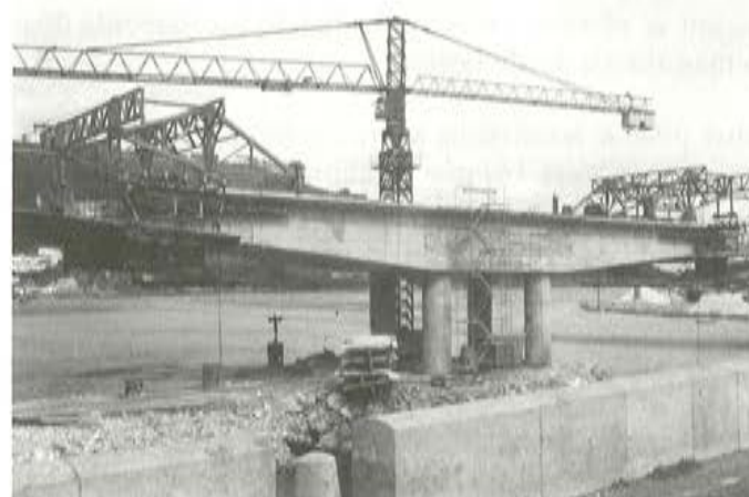
Fig. 17. Carros en posición final para hormigondo dovela última.
