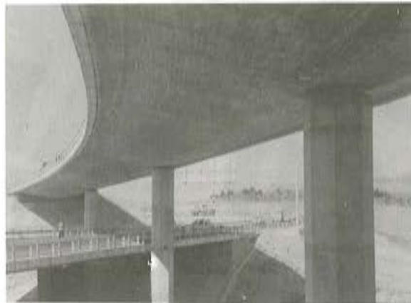
Foto 15. Aspecto de los puentes 2 y 3. Estribos lado Irún.
