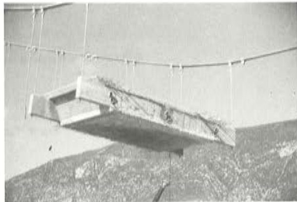
2-Puente de Figols
