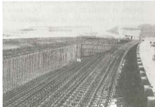
Foto 8. Detalle de ferralla del puente 3.
