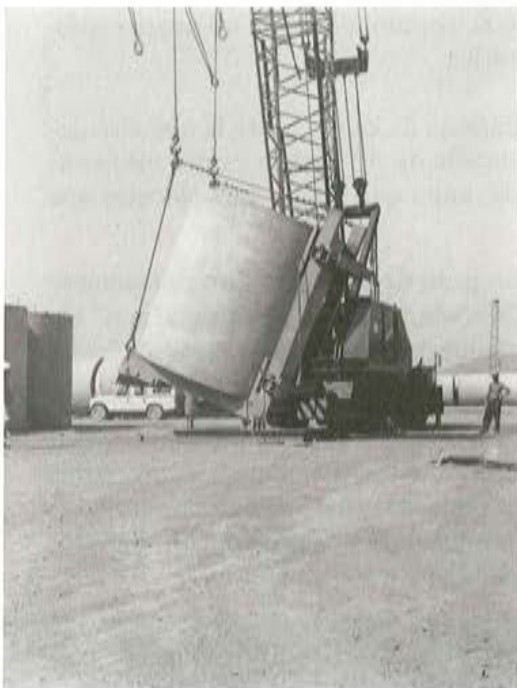
Volteo de módulos para la formación de tubos.
