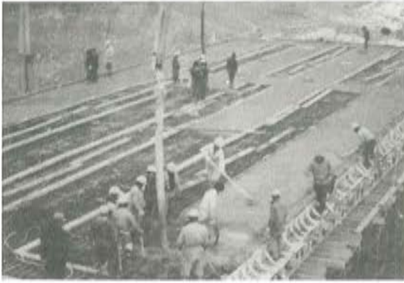
Foto 11. Primera fase de hormigonado del puente 2.
