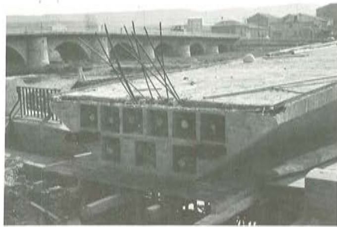
Fig. 8. Borde de anclajes. Tubos para conducciones.
