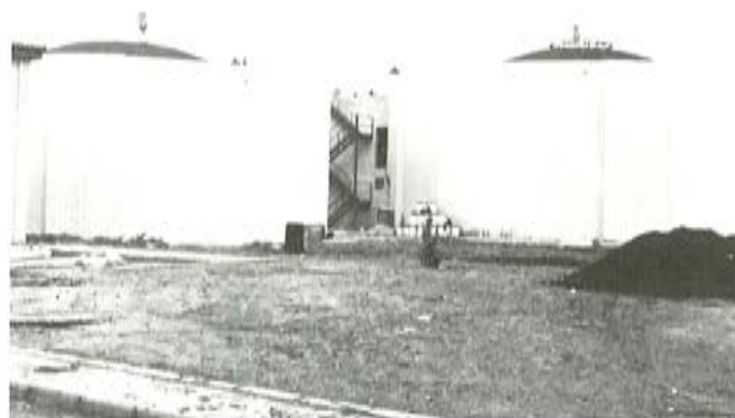
Fig. 3.2. Digestores recubiertos.
