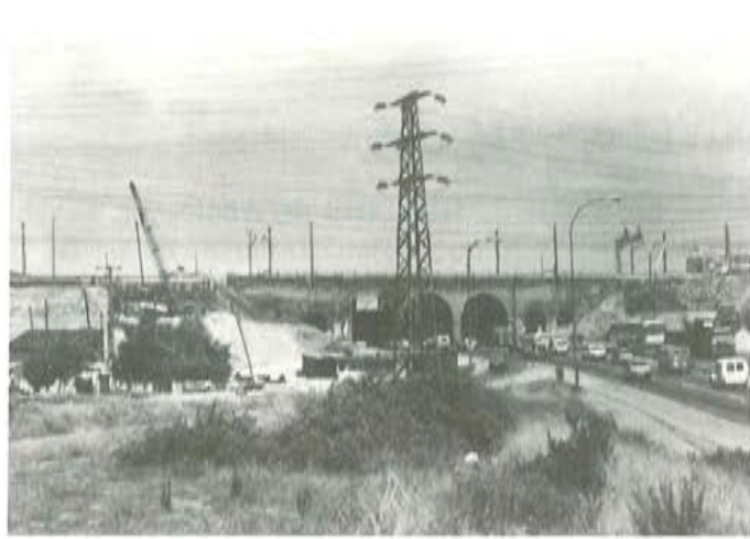
Fig. 24. Alzado antiguo puente de ladrillo.
