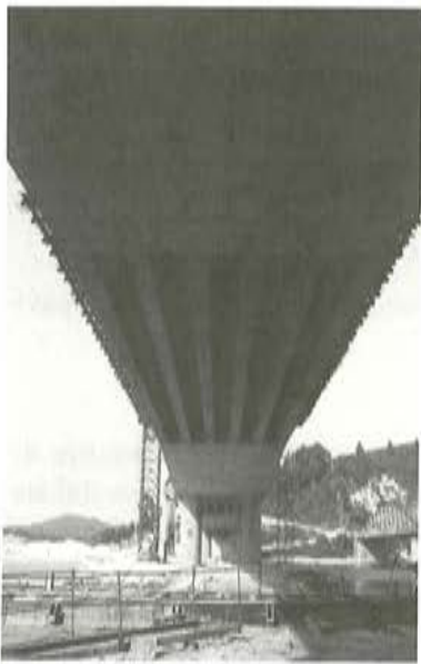
Fig. 20. Vista inferior del tablero.
