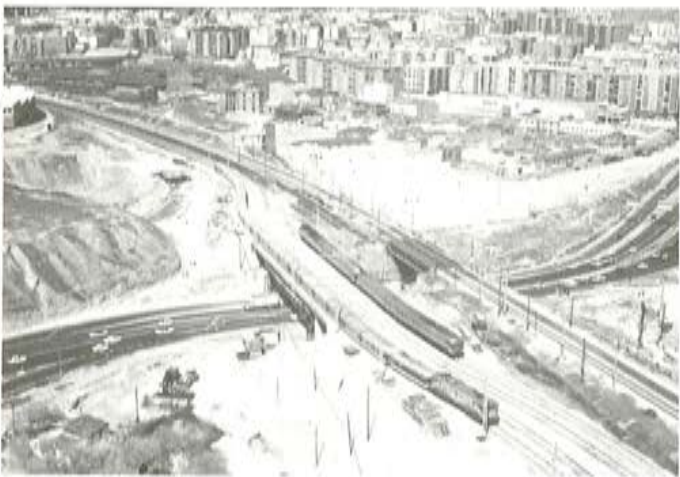
Fig. 32. Traslado de las v'as de Andalucía y depósito. Huevo del puente de ladrillo.
