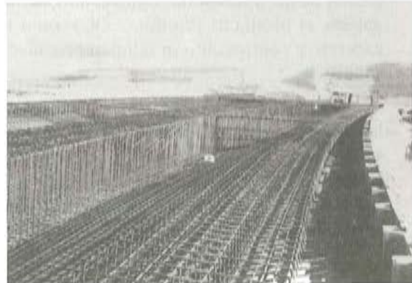
Foto 8. Detalle de ferralla del puente 3.
