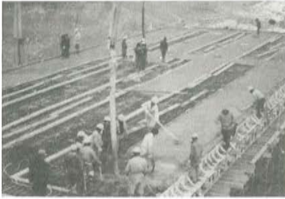
Foto 11. Primera fase de hormigonado del puente 2.
