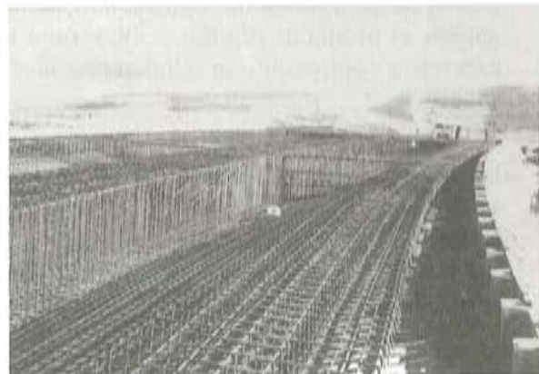
Foto 8. Detalle de ferralla del puente 3.
