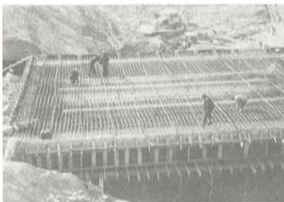
Foto 9. Montaje de ferralla del puente 2.
