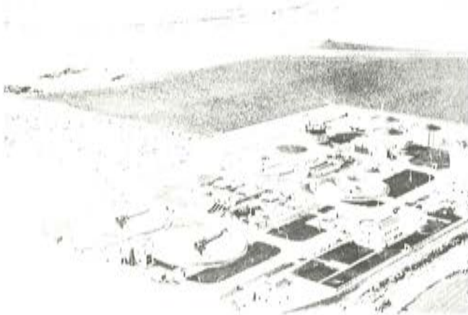
Fig. 3.1. Vista general de la Planta.
