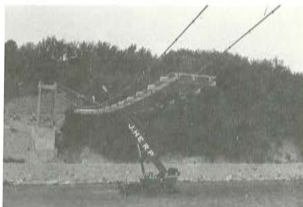
Fig. 15. 1. La grúa montando una dovela.
