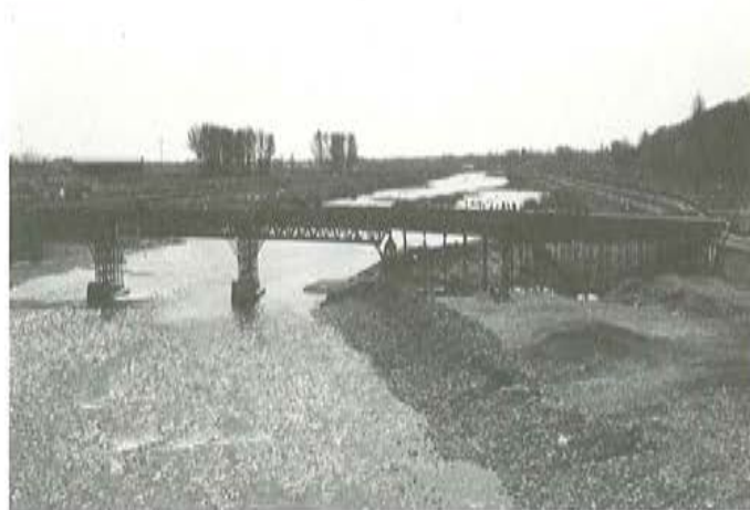
Fig. 6. Cimbra y encofrado del vano central.
