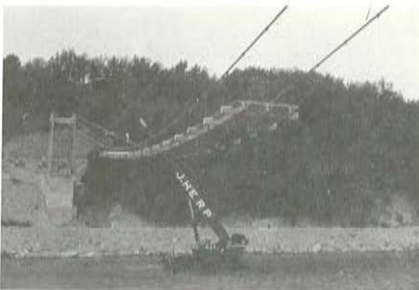
Fig. 15. 1. La grúa montando una dovela.
