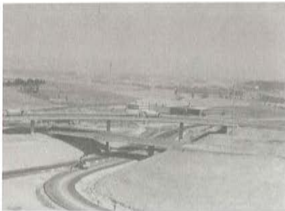
Foto 1. Vista del cruce a tres niveles.
