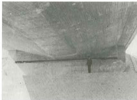
Foto 6. Vista del esquema de apoyo en estribos del puente 3.
