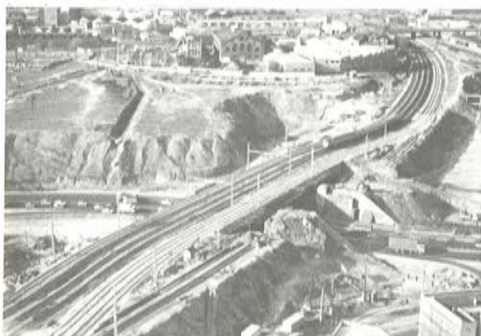
Fig. 34. Traslado de las vías de Barcelona y demolición estribos puente metálico.
