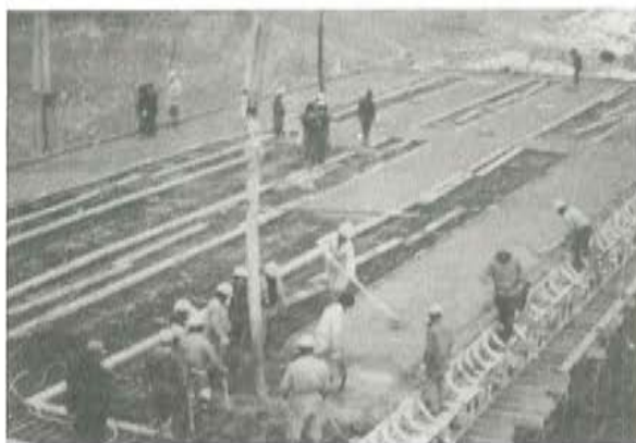
Foto 11. Primera fase de hormigonado del puente 2.
