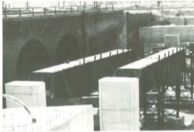
Fig. 29. Vista de las pilas y cimbra para el tablero.
