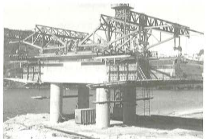
Fig. 16. Carros montados para iniciar el avance.
