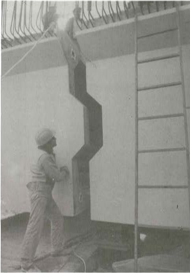
Detalle de la junta seca entre dovelas.
