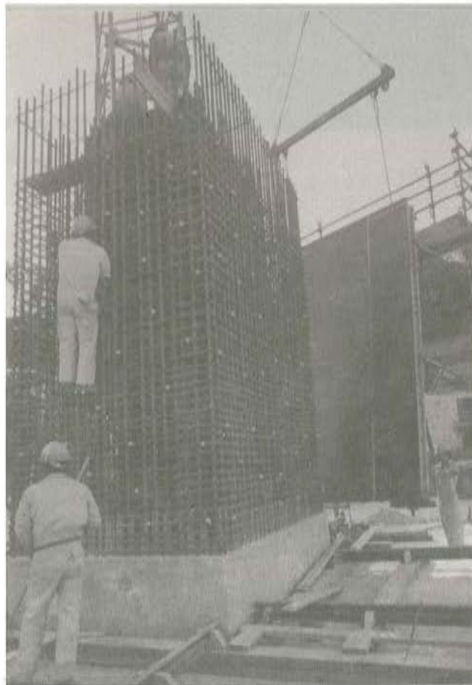
Ferralla de uno de los fustes de la pila.
