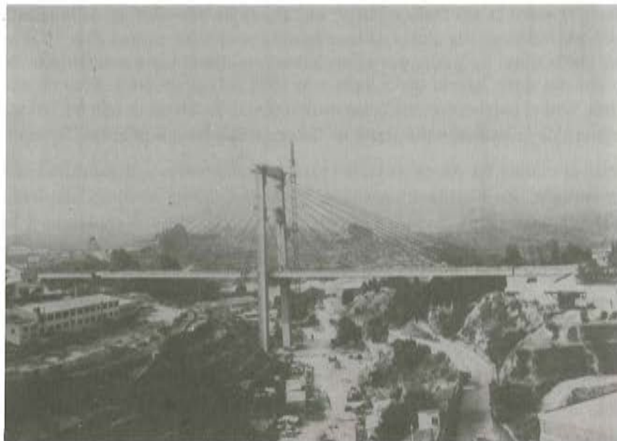
Panorámica general del puente poco antes del cierre.
