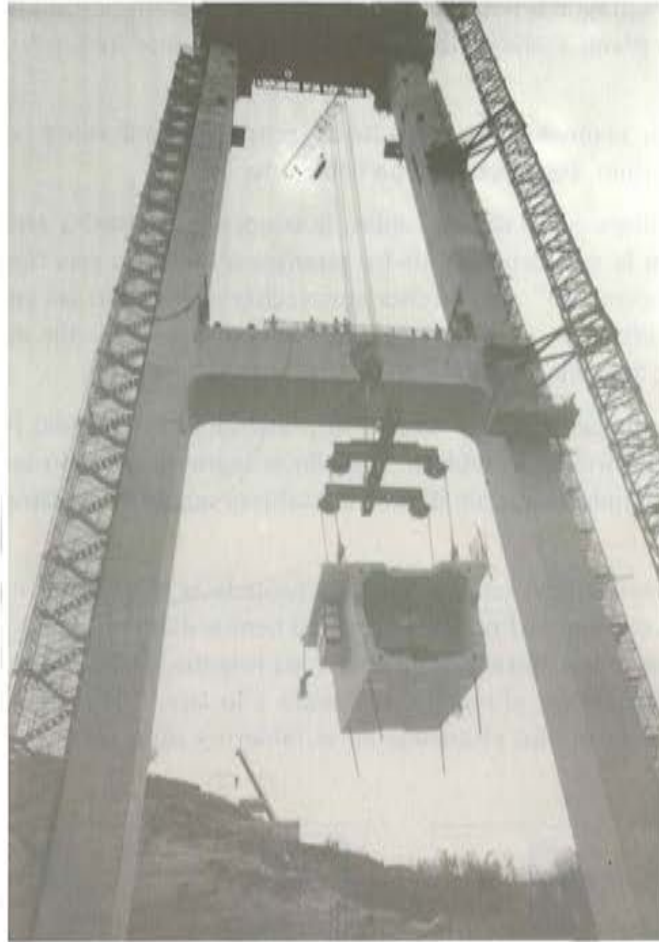
Operación de izado de la primera dovela.
