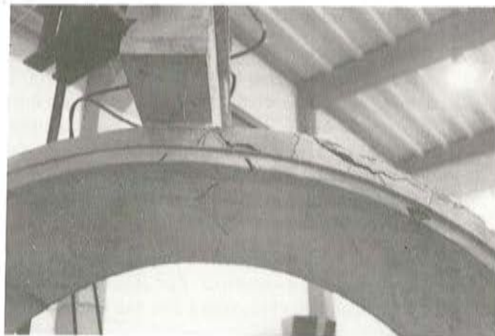
Fotos 5 y 6. Dos vistas del tubo en la situación de rotura.
