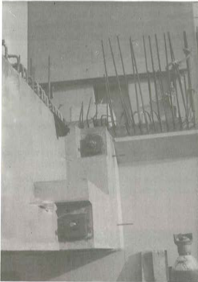
Unión entre viga riostra y viga cajón.
