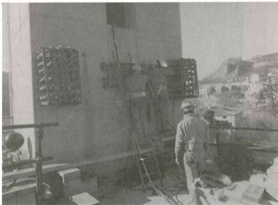
Detalle de los tacos de apoyo transversal entre pila y tablero.
