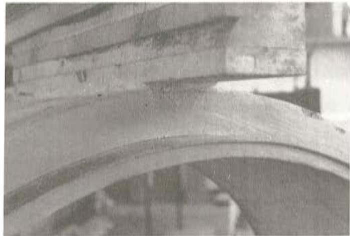
Foto 3. Bajo carga de 8.000 Kg/m, la chapa se desprende del hormigón exterior
