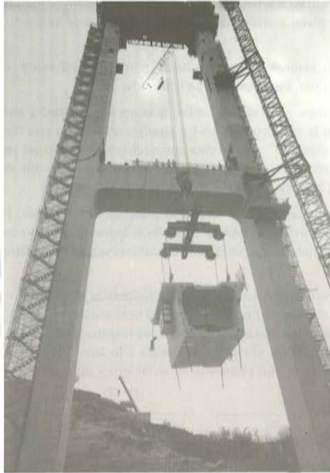
Operación de izado de la primera dovela.
