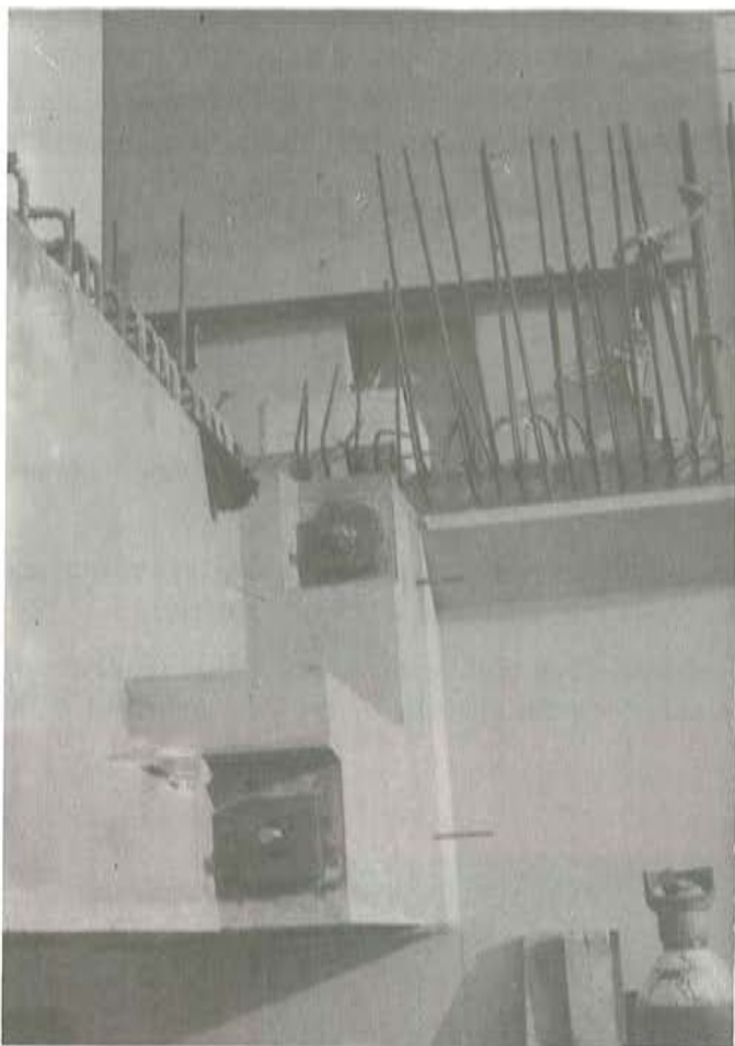
Unión entre viga riostra y viga cajón.
