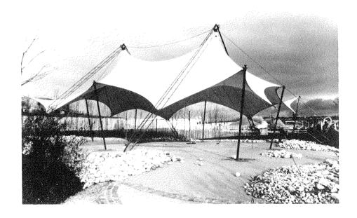
Los tres tamaños normalizados del tipo 003 cubren superficies aproximadas de  $60 \text{ m}^2$ ,  $90 \text{ m}^2$  y  $125 \text{ m}^2$ , suficientes para alojar un máximo de cien personas; mientras que el tipo 005, que cubre una superficie de  $208 \text{ m}^2$ , sirve para unas doscientas personas.
