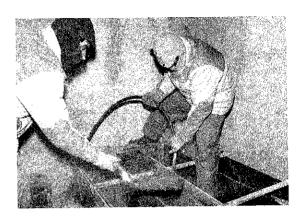
Foto 1. Hormigonado a bajas temperaturas.
