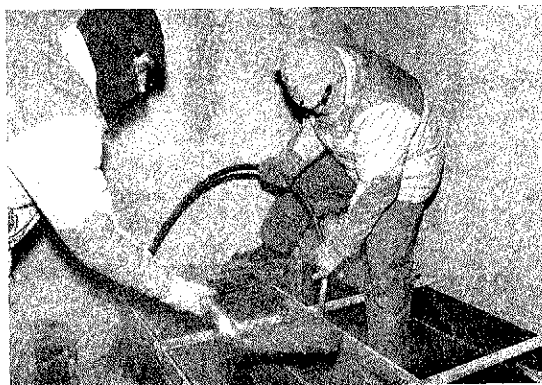
Foto 1. Hormigonado a bajas temperaturas.
