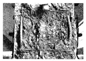
Foto 4. Detalle de la rotura de un pilar.
