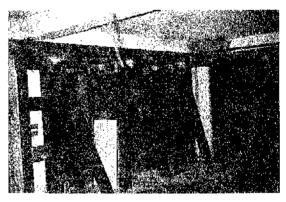
Fig. 2. Vigas de celosía metálica en la planta tercera.
