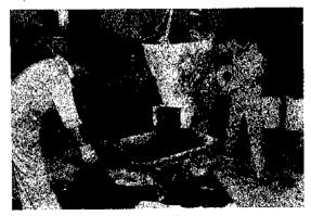
Foto 4, Descarga del hormigón.
