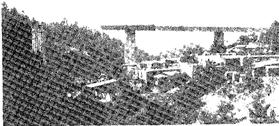
Fig. 8B. El viaducto, en una fase de las iniciales.
