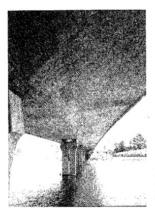
Fig. 4B. Es un puente de mucha esbeltez, poca variación de canto, cajón estrecho y vuelos laterales muy grandes.
