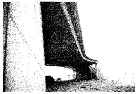
Fig. 50. Losa oblicua. La defensa rígida se ha realizado mediante una barandilla de hormigón, con sección rectangular de 0,40 x 0,25, unida a la imposta mediante elementos verticales, también de hormigón, separados 2 m.
