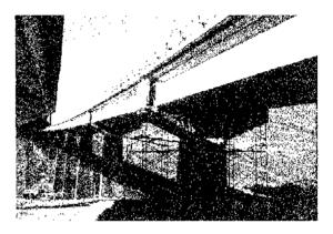
Paralelamente, se han realizado ensayos para determinar las características del hormigón extraído de las vigas, así como del acere activo y pasivo. Es más, incluso se ha determinado la tensión actual de las armaduras activas.
