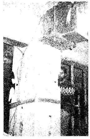
Fig. 12. Iniciación del corte del pilar basta descubrir sus armadures.
