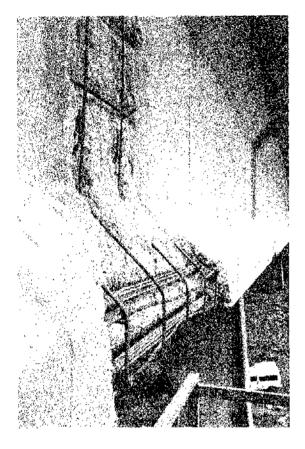
El objeto de descubrir las armaduras y del picado hasta hormigón sano, además de aumentar la adherencia del mortero, es el de evitar la formación de una pila galvánica, entre un hormigón fuertemente alcalino y un segundo carbonatado.
