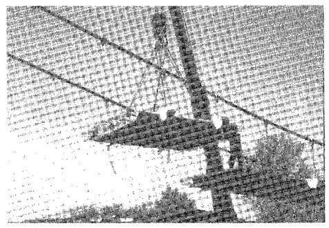
Fig. 11C. Montaje de una dovela del tablero,
