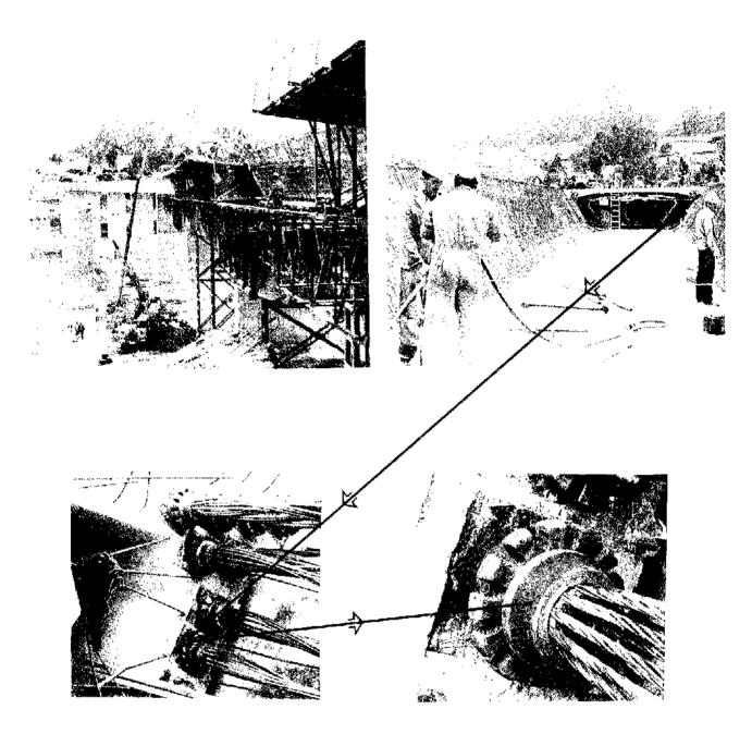
Foto 8. Localización de la rotura: Marca X.
