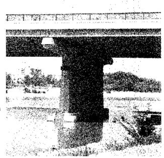
Fig. 7B. Entre las pilas del puente original y las ménsulas prefabricadas que se montaban sobre ellas, se ha colocado un collarín metálico de separación.
