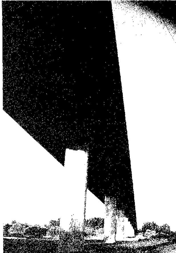
Fig. 2B. Todas las formas del puente, en este caso, son redondeadas. La pila tiene una sección bilobulada.
