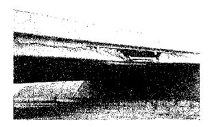
Realizado un detenido estudio, se comprobó que los daños se limitan a la citada viga y al intervalo de losa comprendido hasta la segunda viga, no observándose otros daños significativos en la estructura.
