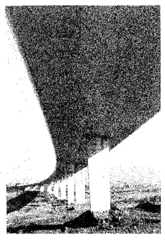
Fig. 3B. Este puento tiene una curvatura y una oblicuidad extraordinariamente fuertes.
