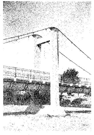
Fig. 11B. Vista de la torre. Bajo la losa se ve el canal semicircular del colector.
