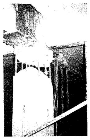
Fig. 15, Pilar totalmente cortado,
