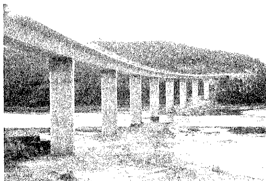
Puente del Tambre.
