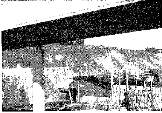
Fig. 27. Otro aspecto del tablero del puente 1.
