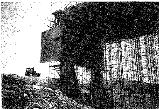
Fig. 23. Detalle del estribo izquierdo del puente 1.
