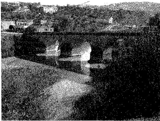
Fig. 45. Vista del puente existente.
