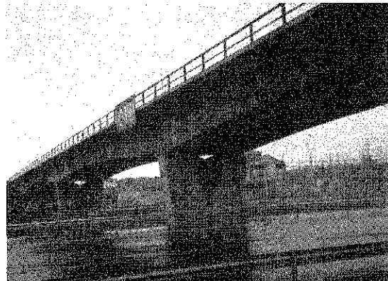
Fig. 16. Otro aspecto de la estructura terminada.
