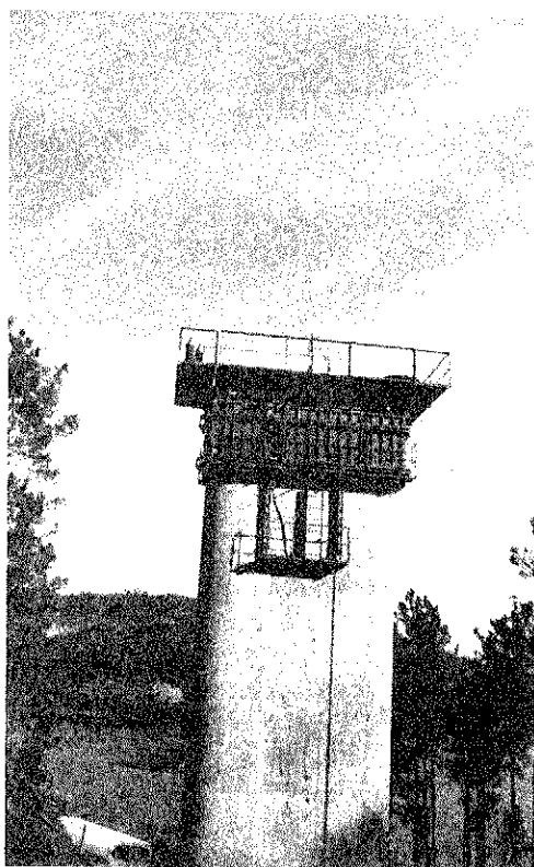
Puente del Tambre.
