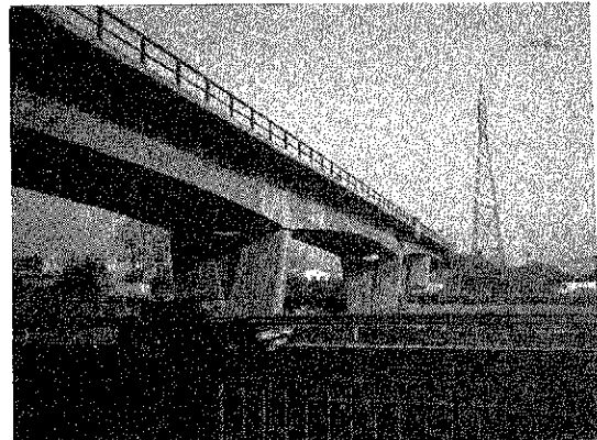
Fig. 15. Aspecto de la estructura terminada.
