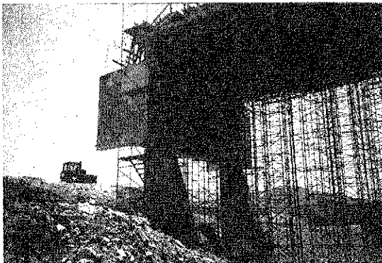
Fig. 23. Detalle del estribo izquierdo del puente 1.
