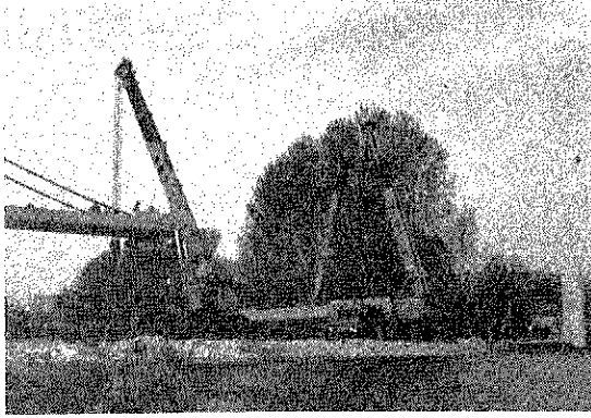
Montaje viga en vano atirantado.
