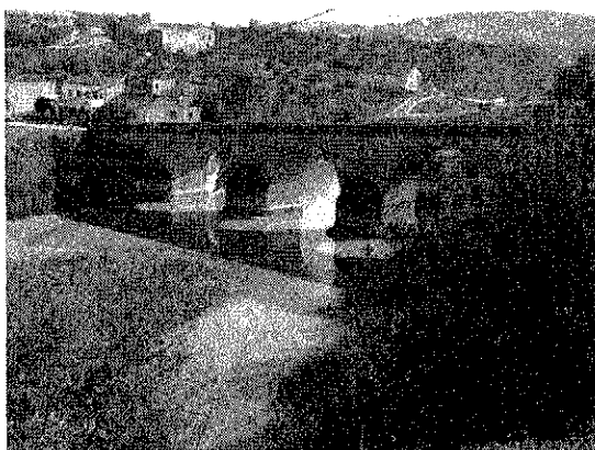
Fig. 45. Vista del puente existente.
