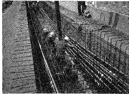
Fig. 8. 1.ª fase de hormigonado.
