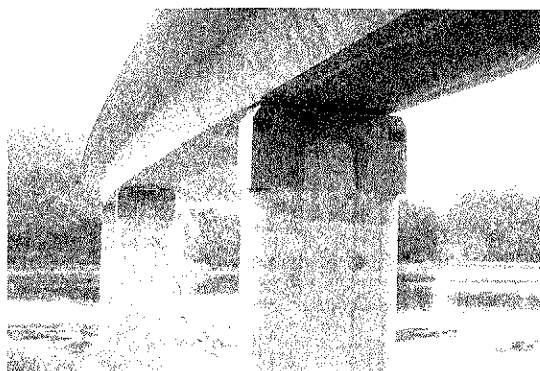
Puente del Tambre.
