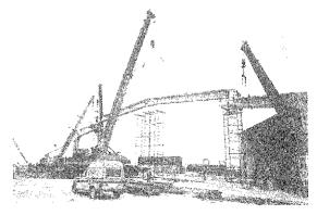
Fig. 6. Montaje del primer pórtico.
