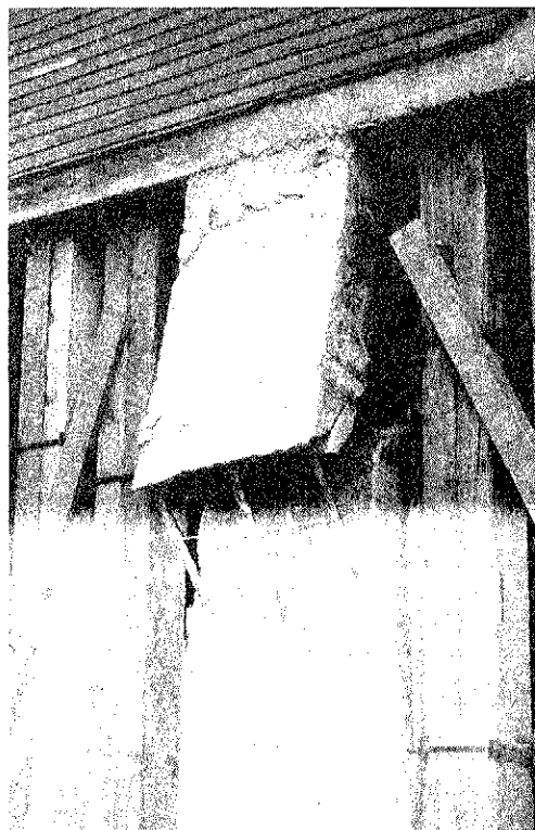
Foto 7. Daños en las armaduras de soportes.
