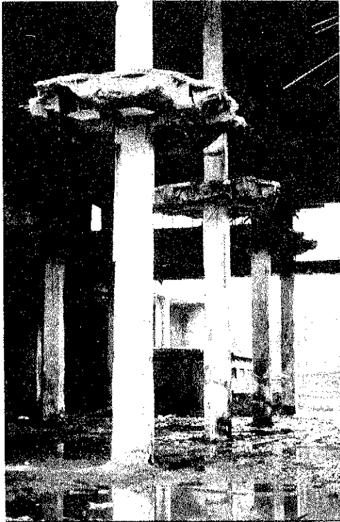
Foto 1. Vista general de un edificio industrial con los efectos del incendio.
